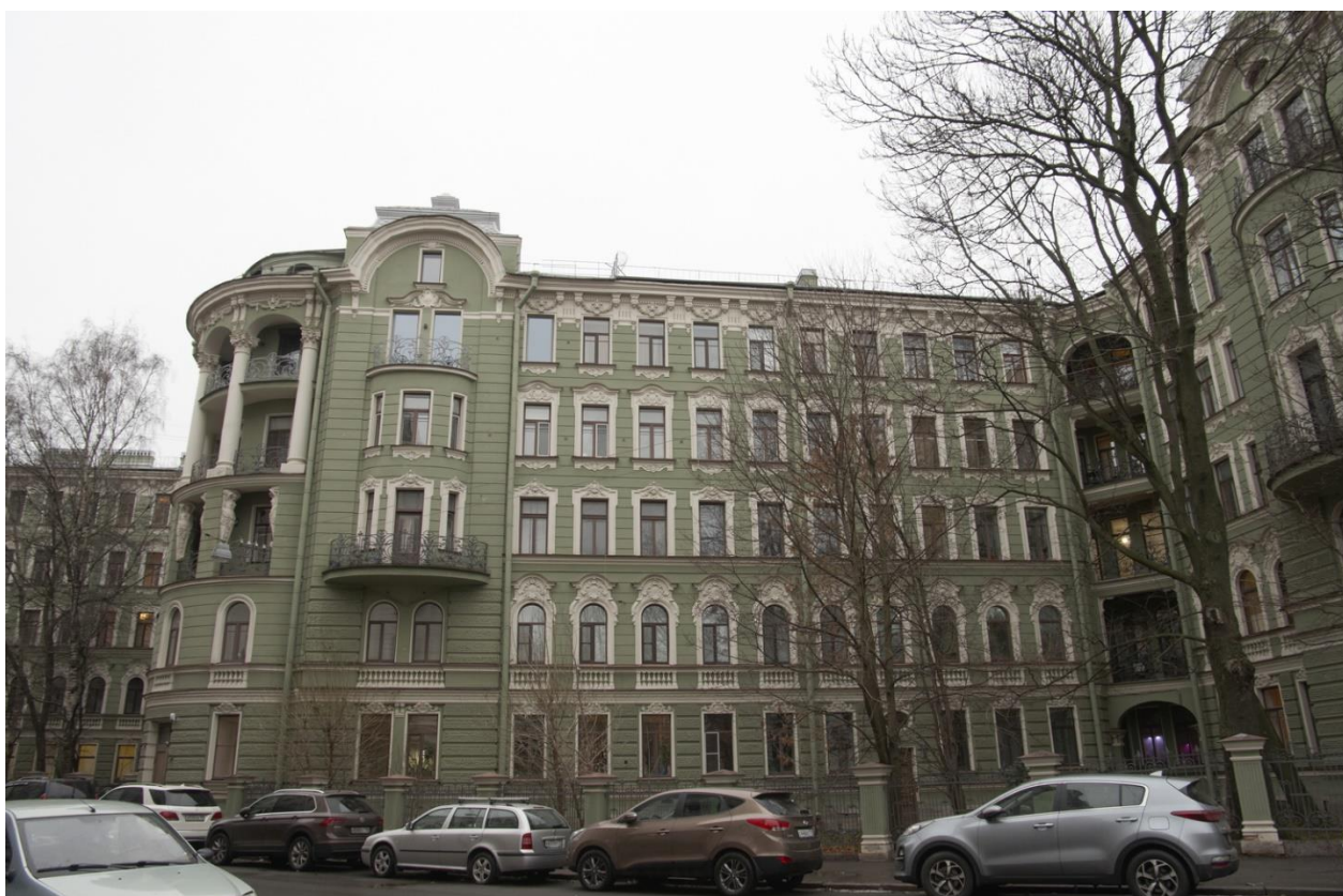
Фото 12. Фрагмент лицевого фасада по Пушкарскому переулку
