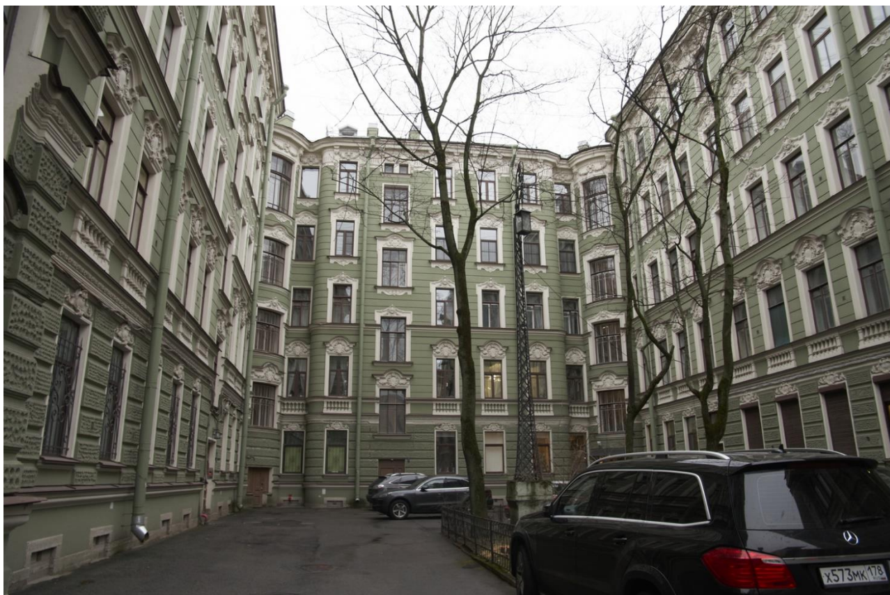
Фото 6. Общий вид двора-курдонера.
