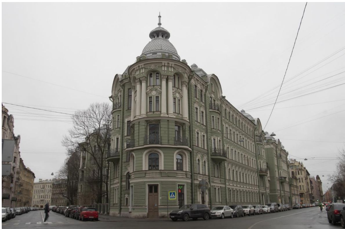
Фото 1. Лицевой фасад по ул. Ленина.
