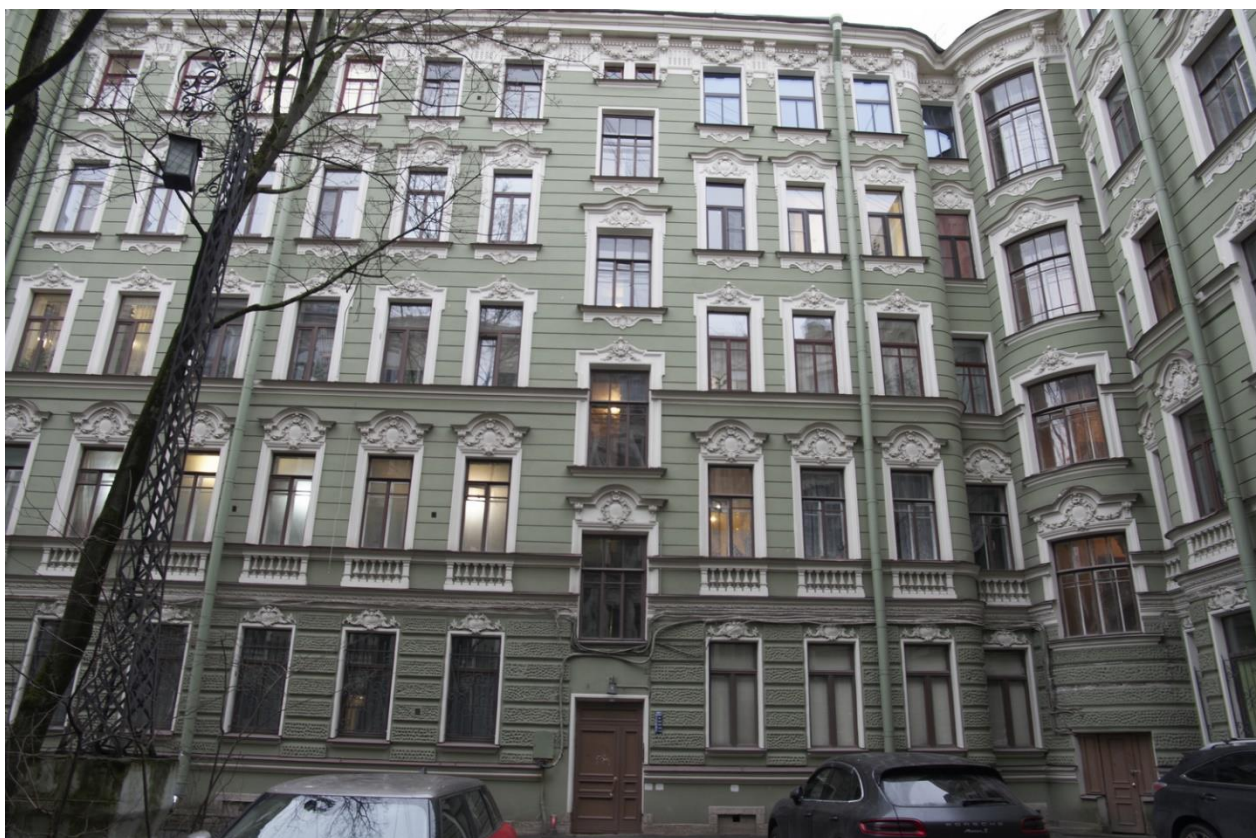
Фото 7. Фрагмент северо-западного и северо-восточного фасада двора-курдонера.
