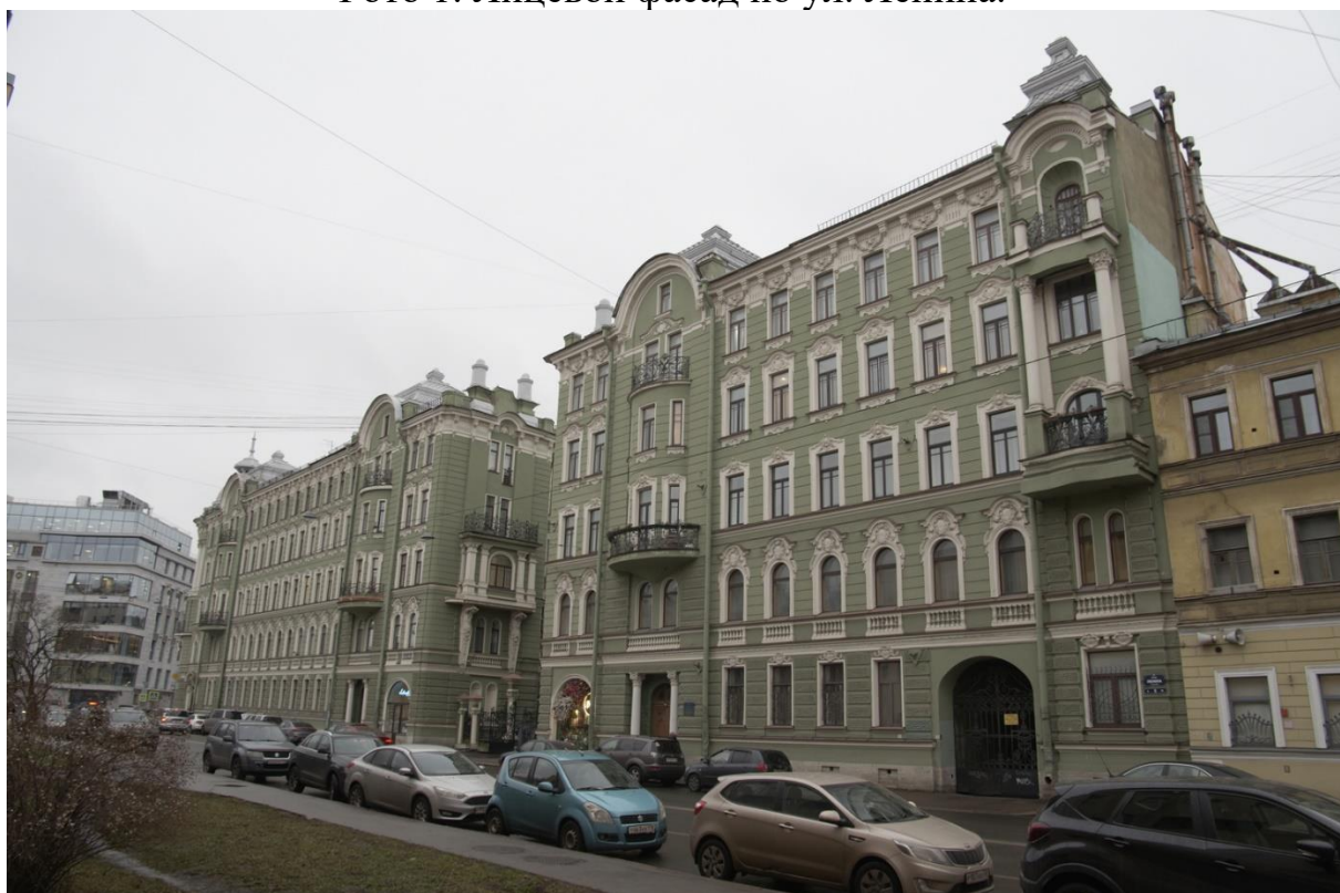
Фото 2. Лицевой фасад по ул. Ленина.
