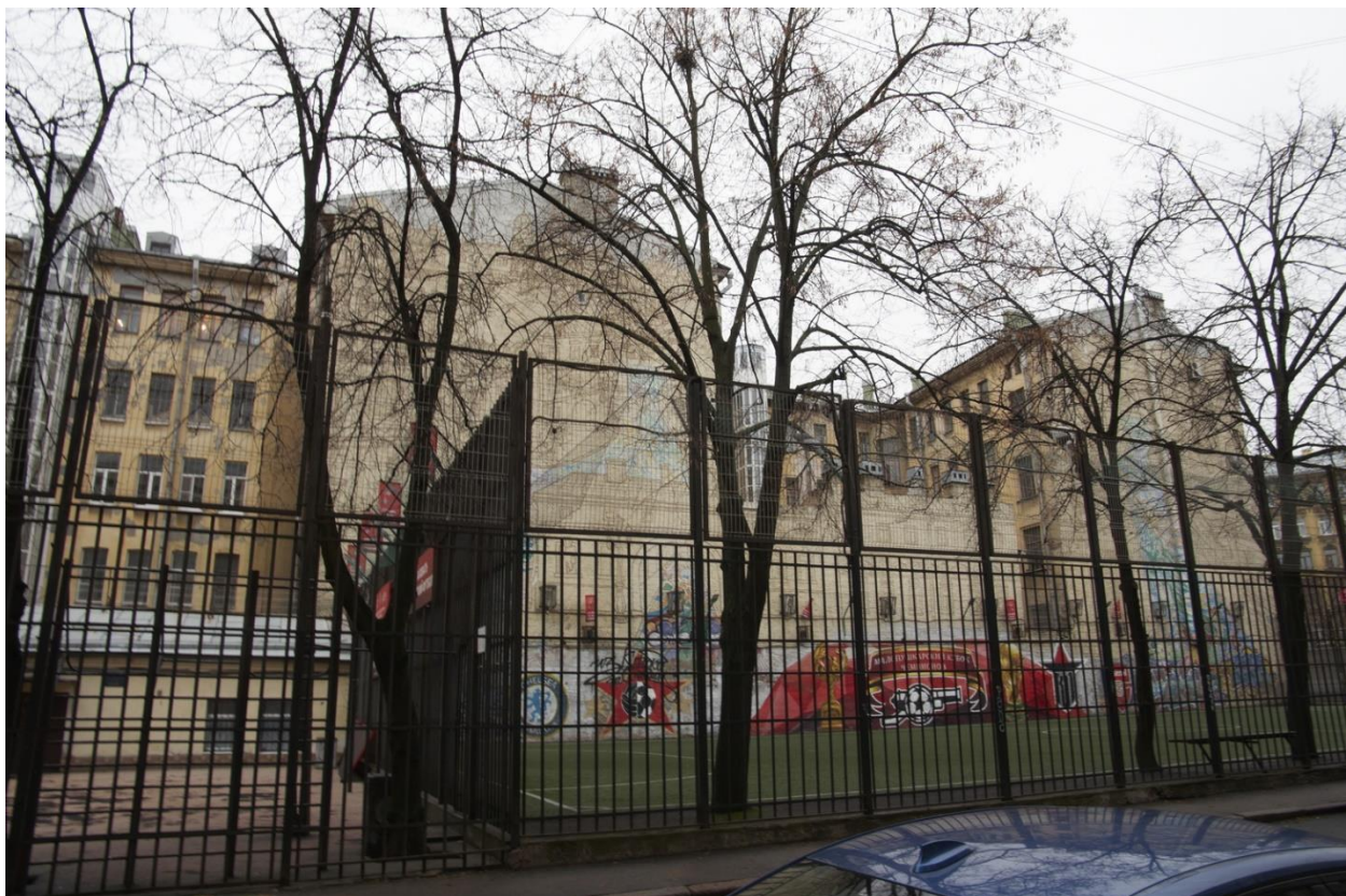
Фото 9. Дворовые фасады со стороны Малой Пушкарской улицы.
