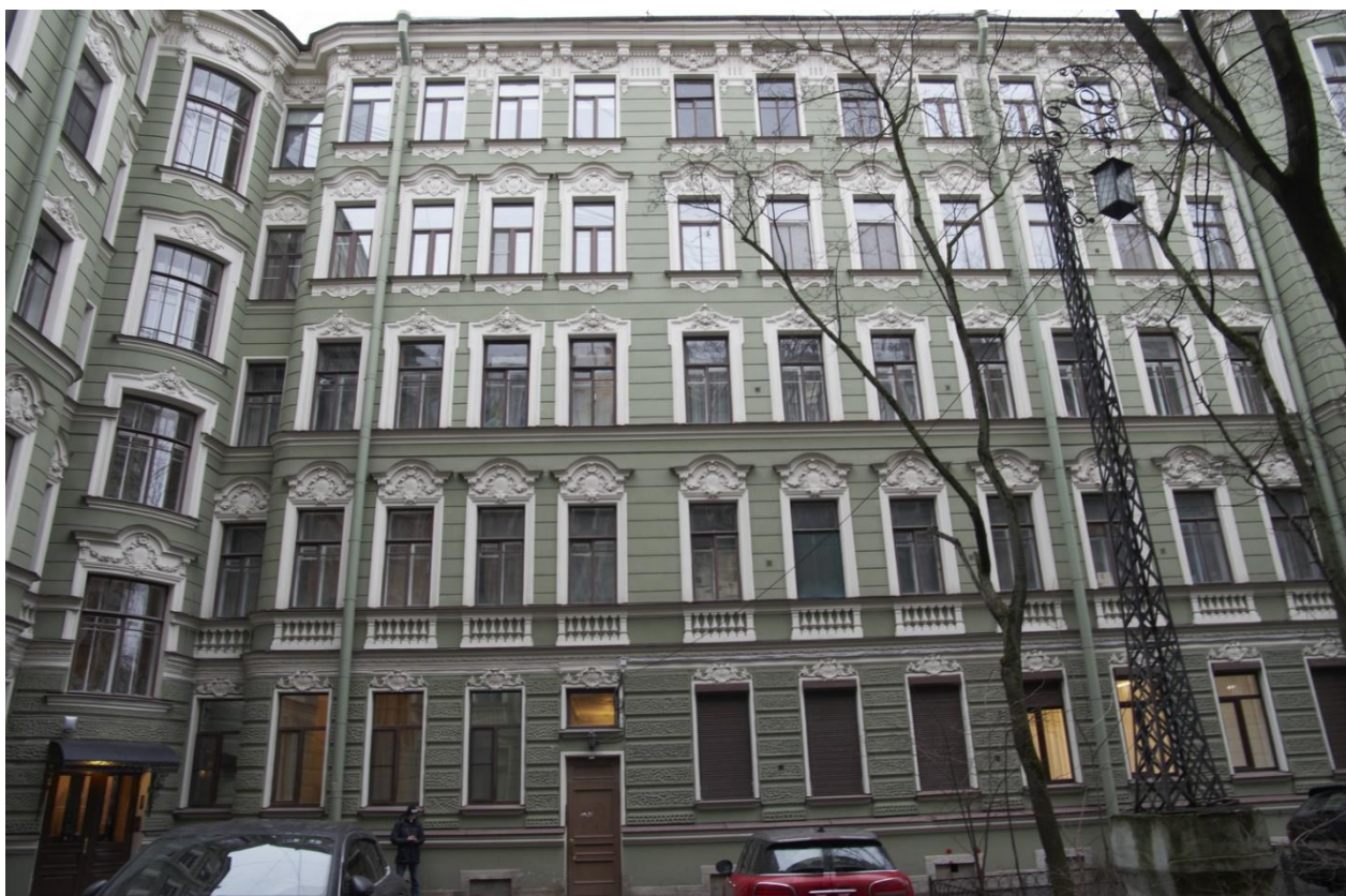
Фото 8. Фрагмент северо-восточного фасада двора с окнами квартиры № 34
