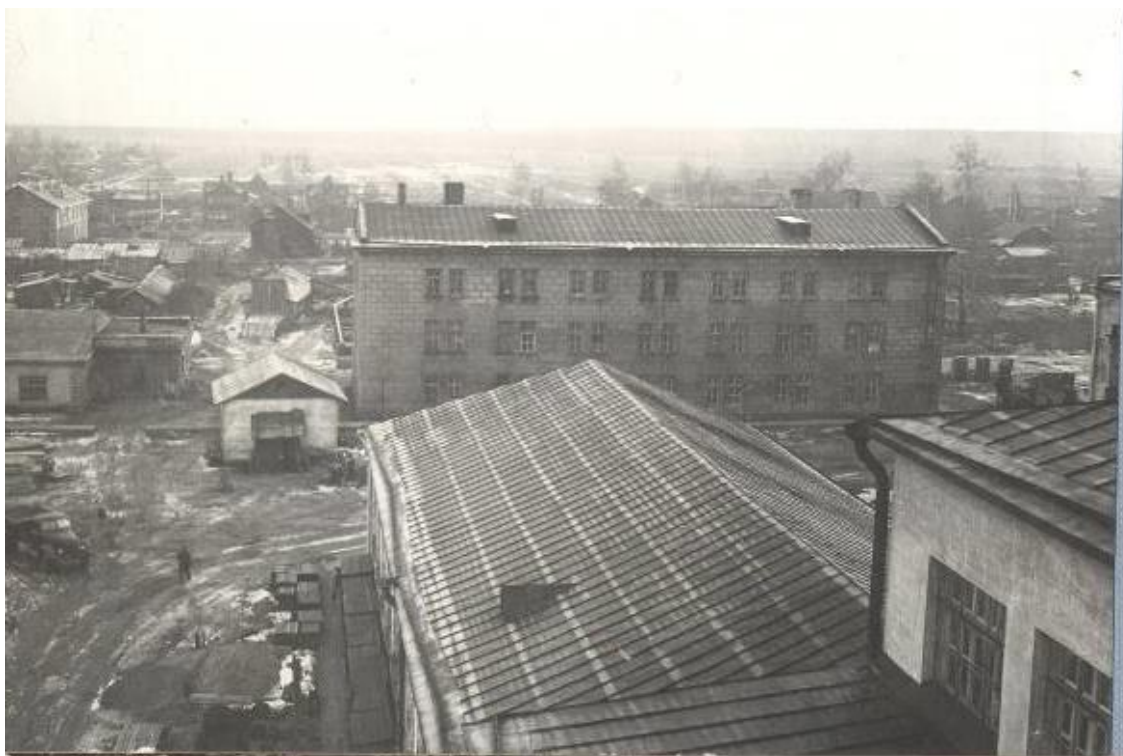
46. Вид лабораторного корпуса. Фото 1957 г. По материалам музея ОАО ВНИИГ им. Б.Е. Веденеева.
