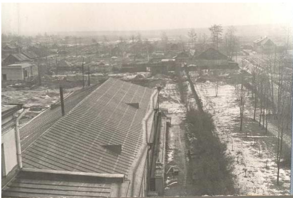
47. Вид лабораторного корпуса. Фото 1957 г. По материалам музея ОАО ВНИИГ им. Б.Е. Веденеева.
