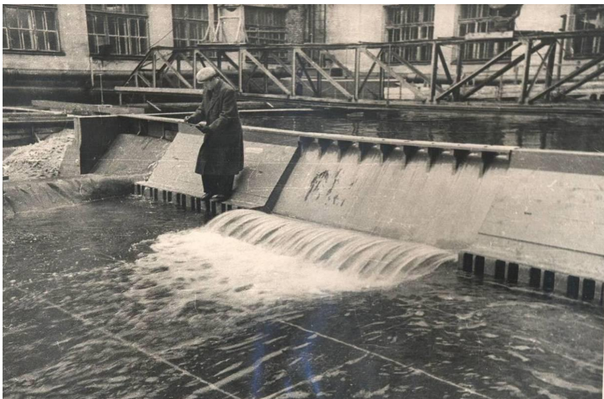
55. Проверка работы Братской ГЭС по модели. Фото 1954 г. материалам музея ОАО ВНИИГ им. Б.Е. Веденеева.
