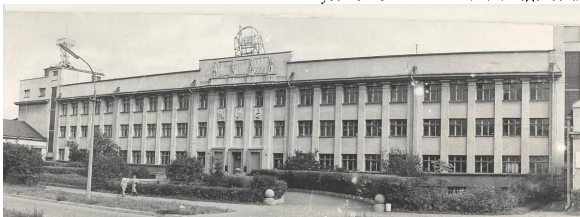
30. ВНИИГ им. Веденева. Лицевой корпус. Фото 1956-х.гг. По материалам музея ОАО ВНИИГ им. Б.Е. Веденева.
