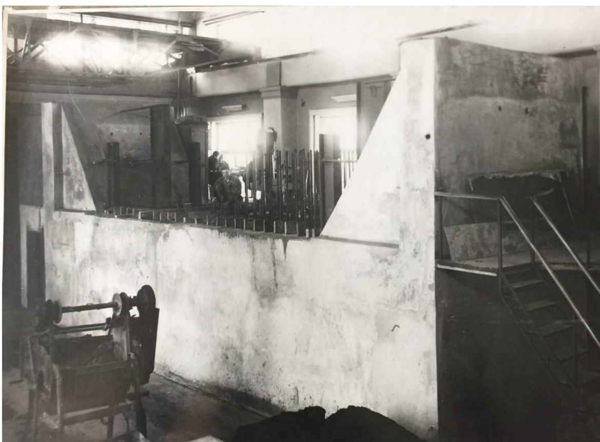
60. Стенд для испытания моделей плотин. 1950-е гг. По материалам музея ОАО ВНИИГ им. Б.Е. Веденеева
