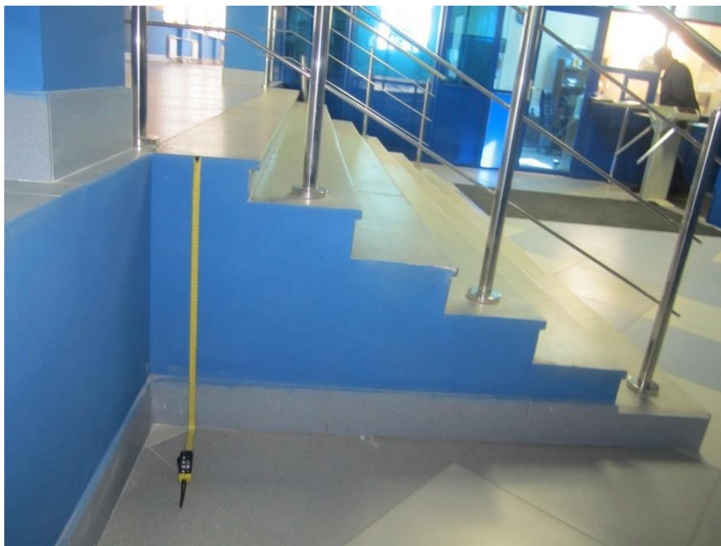
6. Гидротехнический институт им. Б.Е.Веденеева (лицевой корпус с примыкающими дворовыми флигелями). Лестница вестибюля. Штиглиц М.С. 10.02.2021 г.
