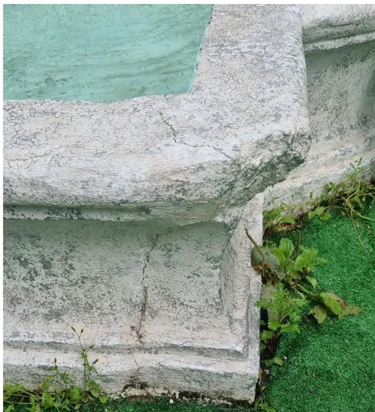
Фото 10. Сколы и выбоины бетона чаши фонтана, трещины в железобетоне чаши фонтана раскрытием до 1 мм, биопоражения, образование биодеструкторов.
