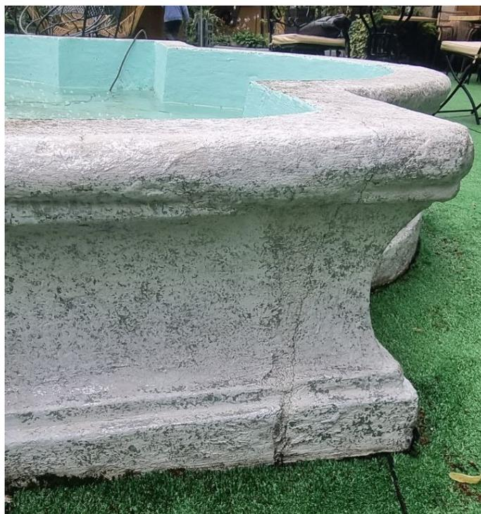
Фото 8. Трещины в железобетоне чаши фонтана раскрытием до 1 мм, биопоражения, образование биодеструкторов, наплывы бетона, раковины и каверны.
