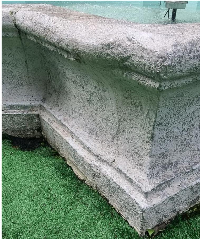
Фото 9. Наплывы бетона, раковины и каверны, биопоражения, образование биодеструкторов.
