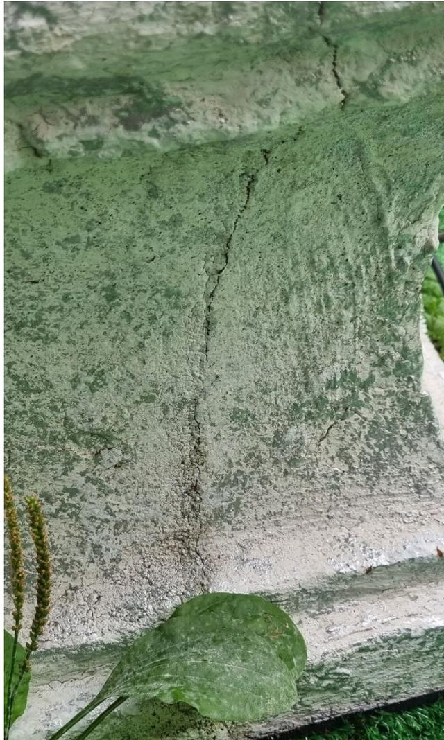
Фото 18. Трещины в железобетоне чаши фонтана раскрытием до 1 мм, биопоражения, образование биодеструкторов.
