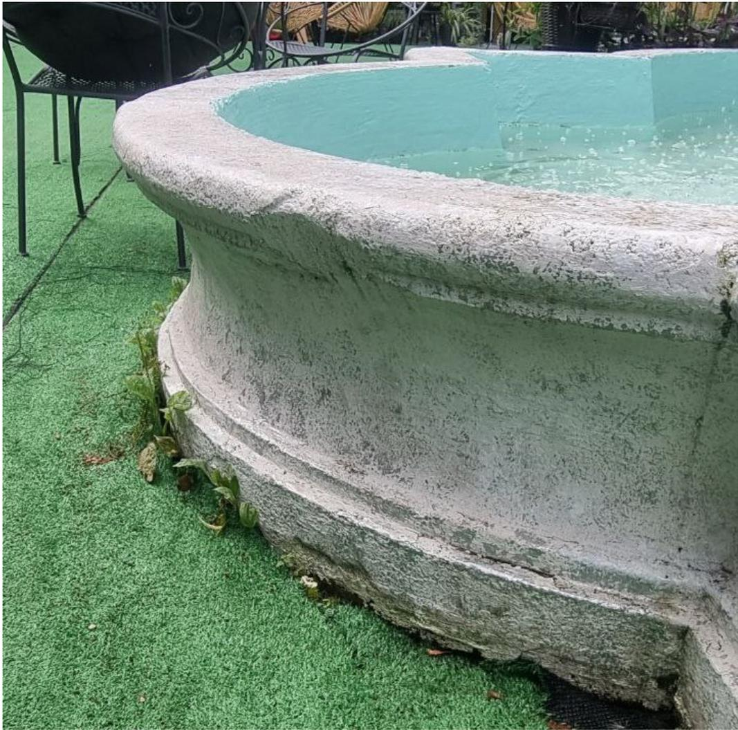
Фото 13. Биопоражения, образование биодеструкторов, наплывы бетона, раковины и каверны.
