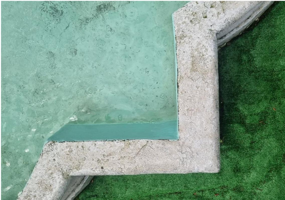
Фото 11. Наплывы бетона, раковины и каверны.
