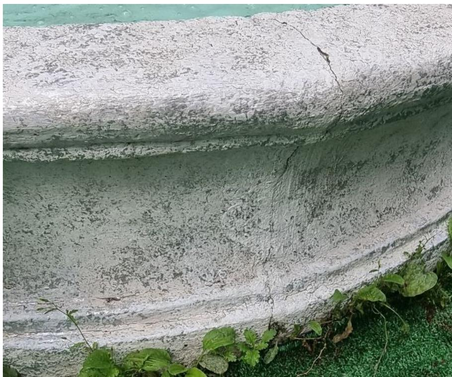
Фото 21. Трещины в железобетоне чаши фонтана раскрытием до 1 мм, биопоражения, образование биодеструкторов.
