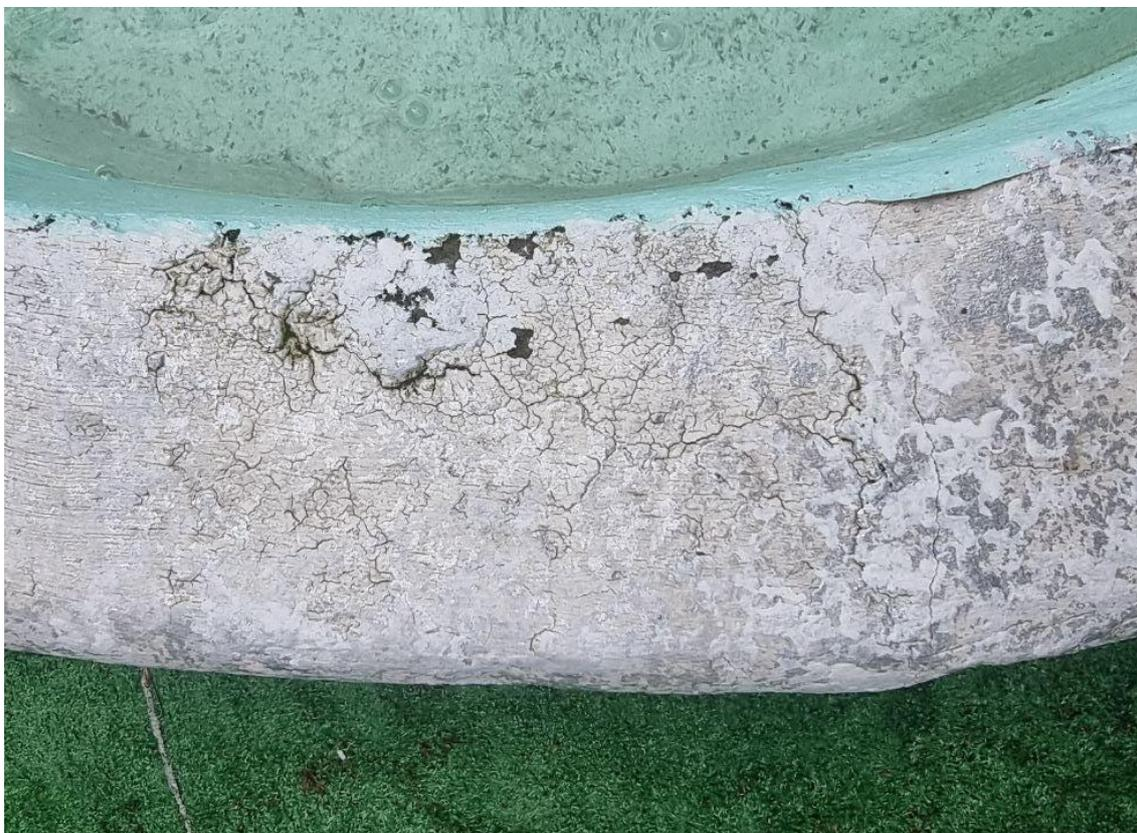
Фото 12. Наплывы бетона, раковины и каверны.
