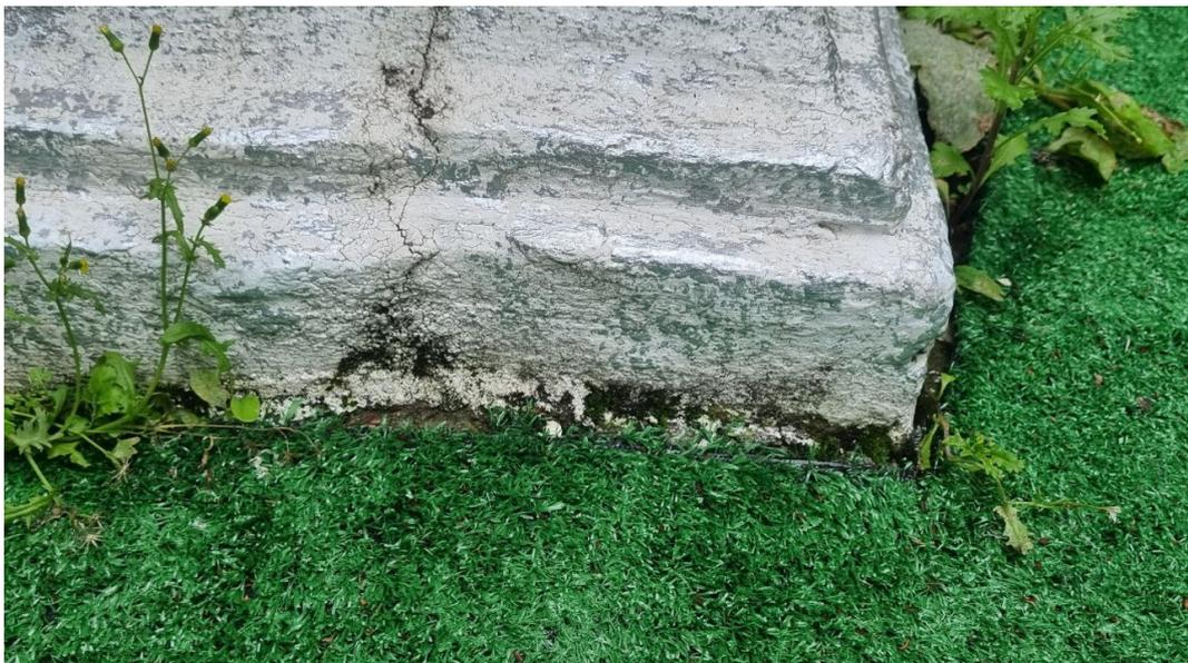
Фото 14. Наплывы бетона, раковины и каверны, трещины в железобетоне чаши фонтана раскрытием до 1 мм, биопоражения, образование биодеструкторов.
