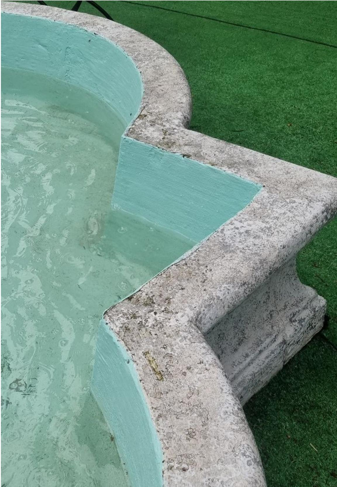
Фото 15. Наплывы бетона, раковины и каверны.
