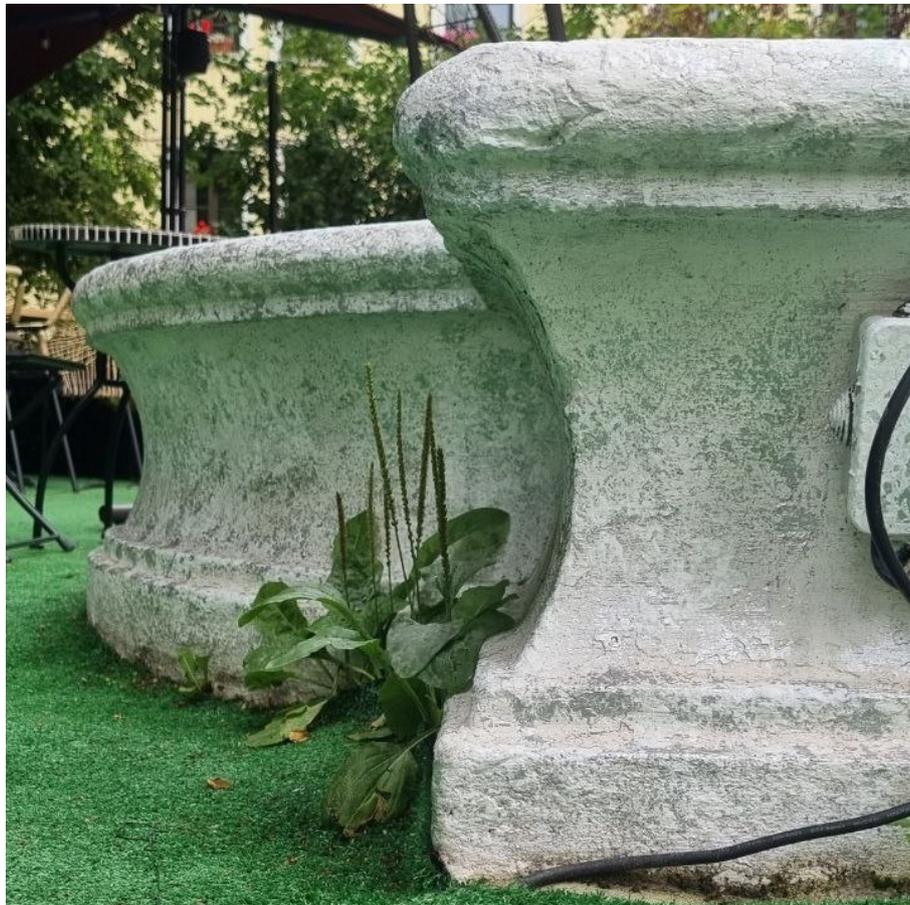
Фото 20. Сколы и выбоины бетона чаши фонтана, биопоражения, образование биодеструкторов.
