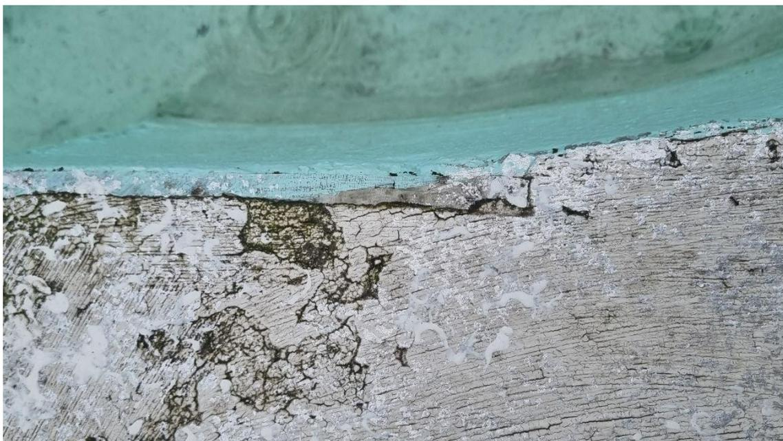
Фото 17. Наплывы бетона, раковины и каверны.
