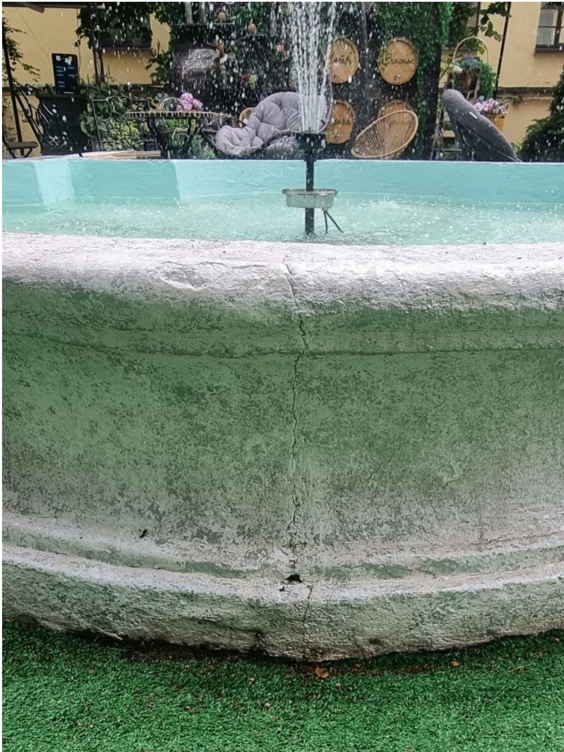
Фото 6. Сколы и выбоины бетона чаши фонтана, наплывы бетона, раковины и каверны, биопоражения, образование биодеструкторов, трещины в железобетоне чаши фонтана раскрытием до 1 мм.
