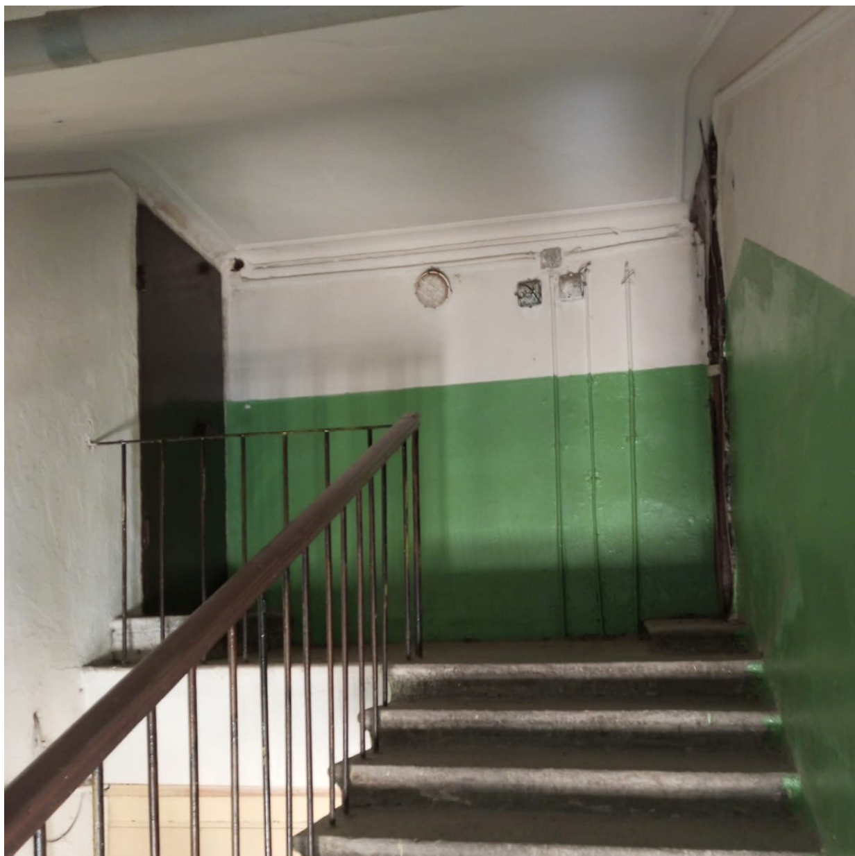
Рис. 14. Объект культурного наследия регионального значения «Дома кн. Л.Д.Вяземского» по адресу: Санкт-Петербург, ул. Галерная, д. 67, литера А Внутренние помещения квартиры № 14 Дата съемки: 17.06.2025
