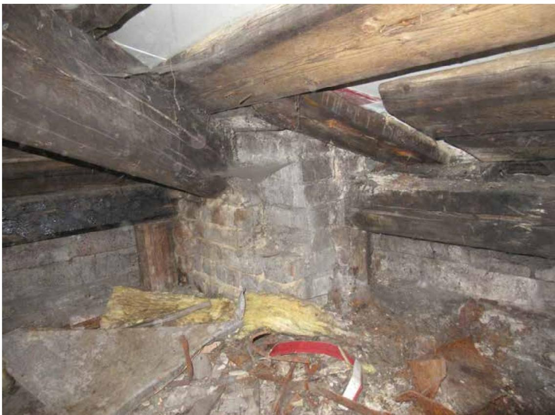
*Фото №28. Опирание стропильной ноги в осях П/3*
