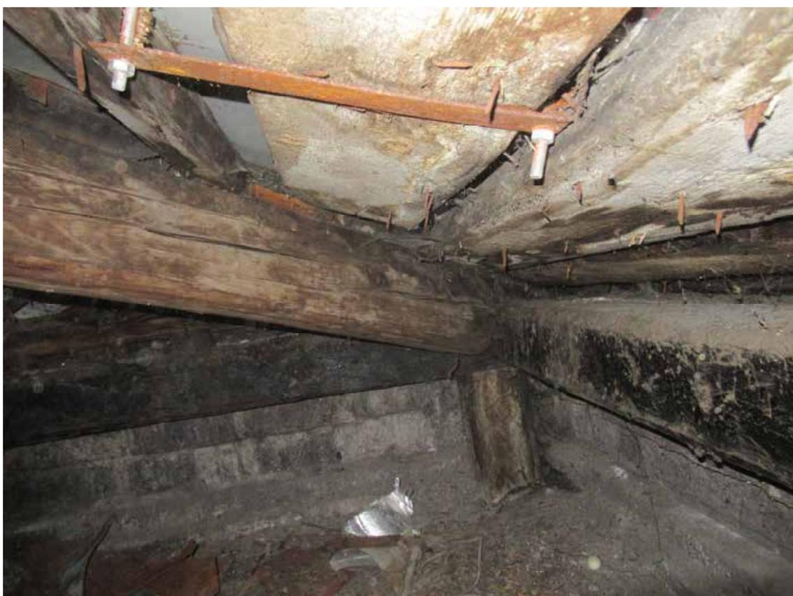
*Фото №29. Опирание стропильной ноги в осях П/7*
