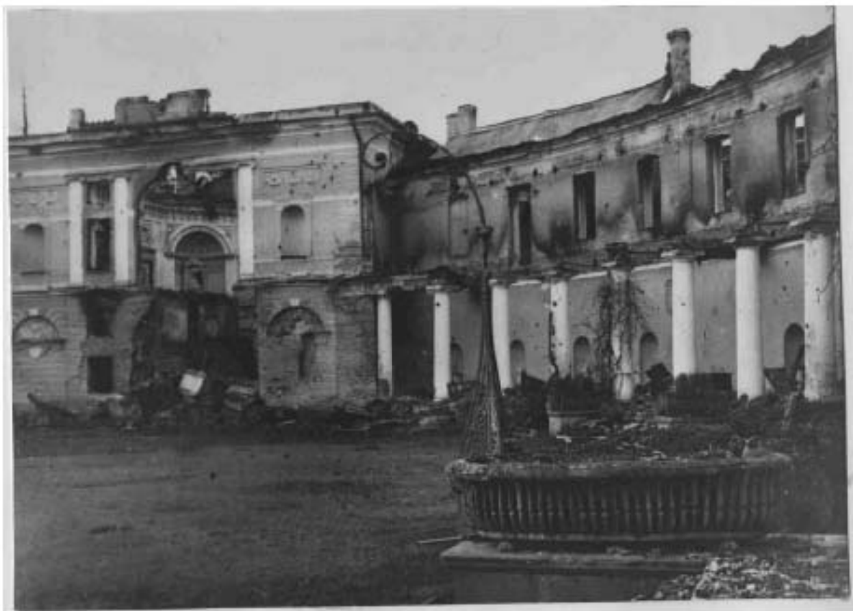
28. Центральный корпус дворца со стороны парадного плаца. Вид сбоку [Изоматериал] : [фотография]. - Павловск, 1944. — https://www.prlib.ru/item/389475
