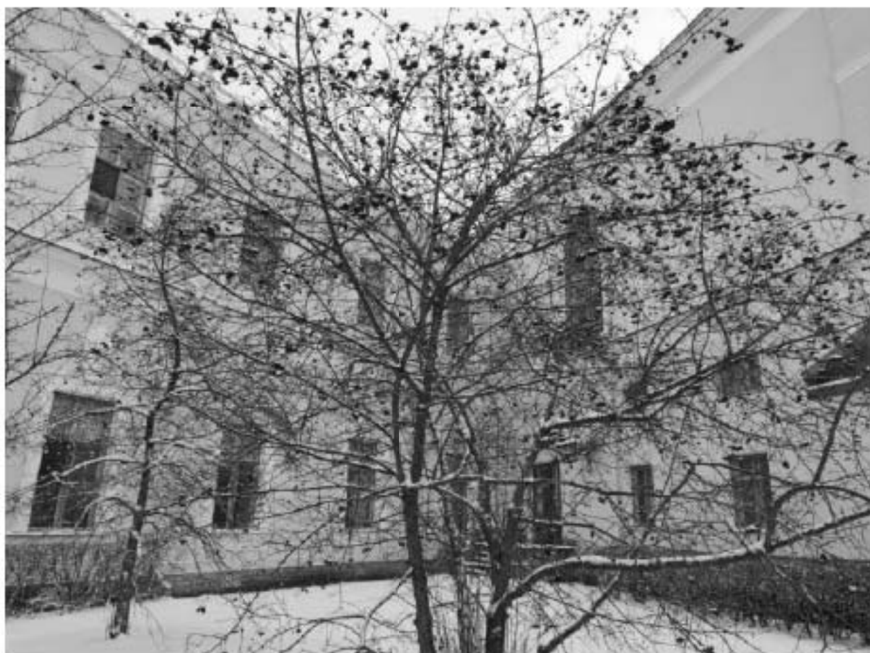
5. Юго-восточный полуциркульный корпус и Южный прямоугольный корпус. Фасад со стороны плаца.
