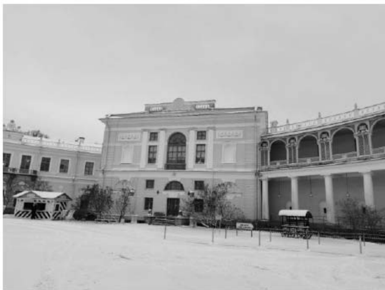
3. Южный прямоугольный корпус. Фасад со стороны плаца.
