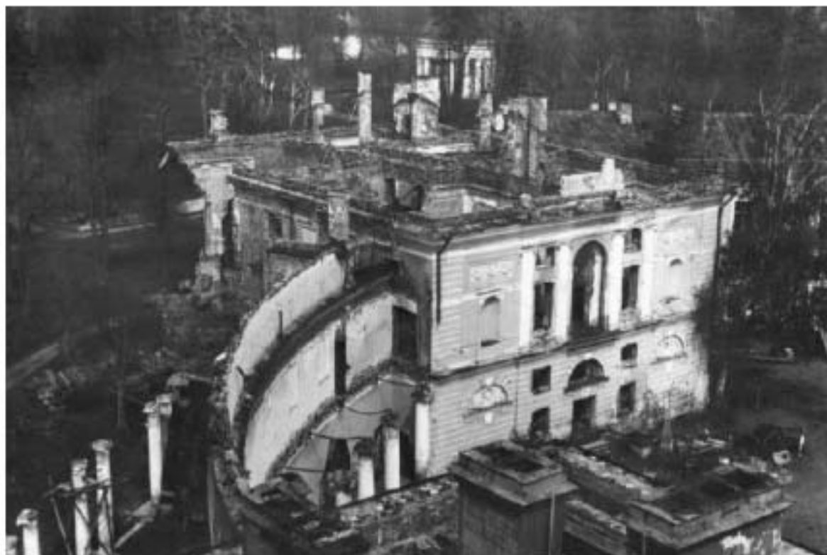
22. Разрушенный северный корпус и галерея. 1944г. https://pastvu.com/ .
