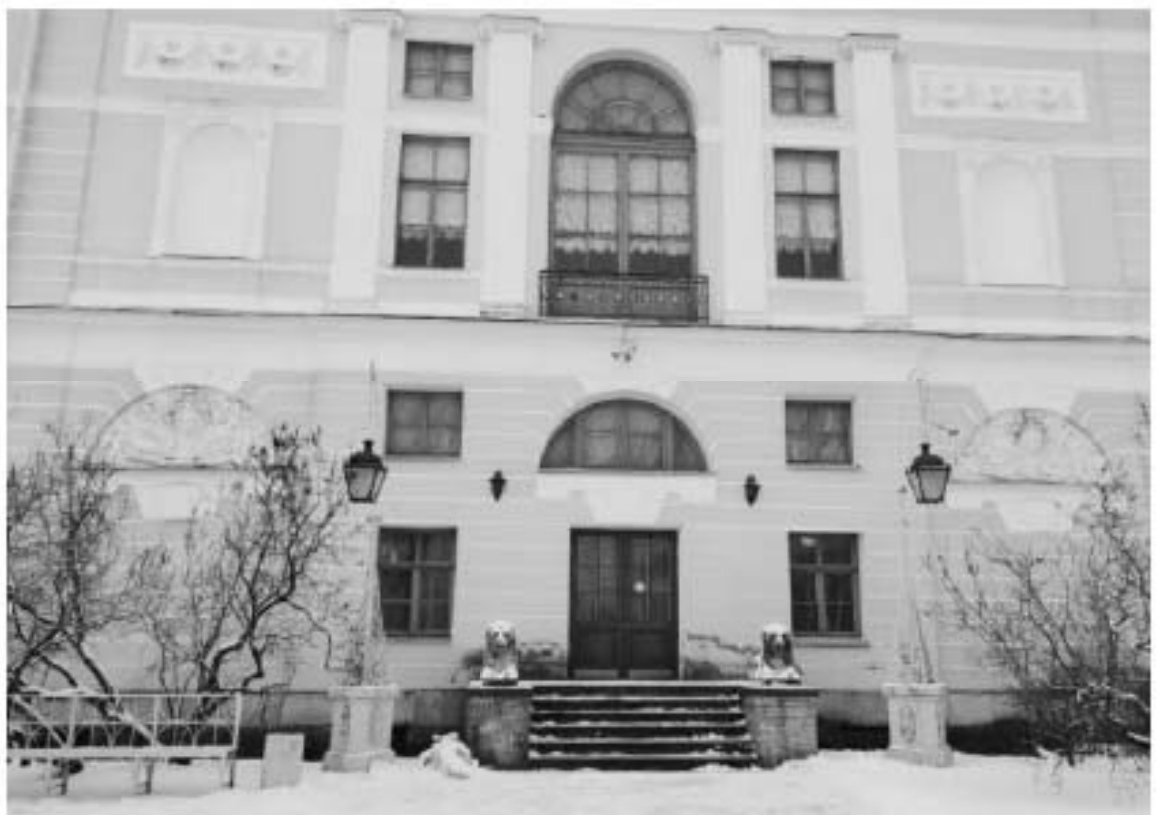
7. Юго-восточный полуциркульный корпус и Южный прямоугольный корпус. Фасад со стороны плаца.
