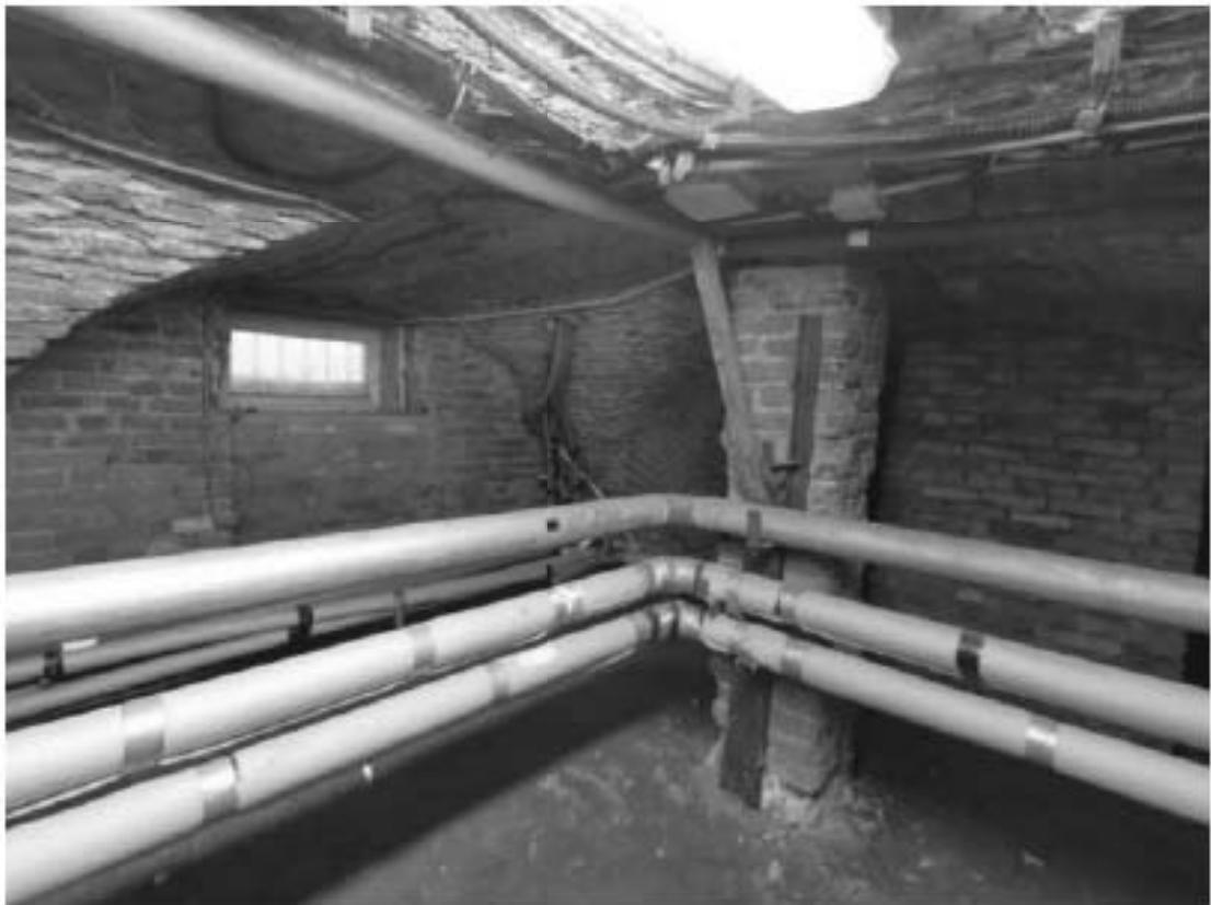
11. Южный прямоугольный (церковный) корпус. Подвал.
