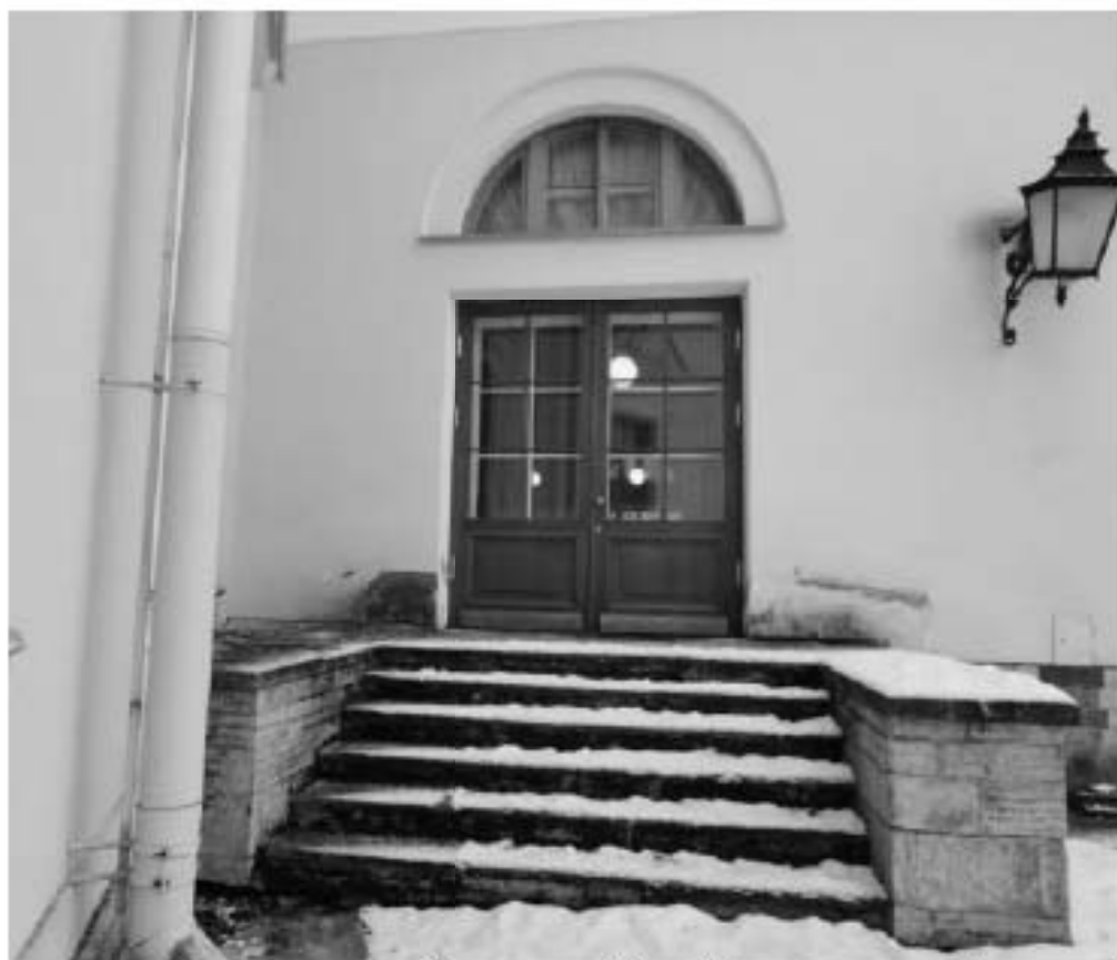
6. Юго-восточный полуциркульный корпус и Южный прямоугольный корпус. Фасад со стороны плаца.
