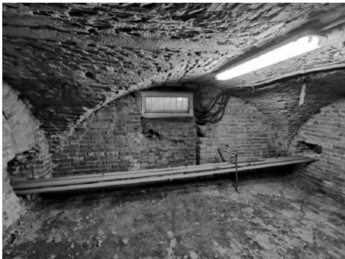
12. Южный прямоугольный (церковный) корпус. Подвал.
