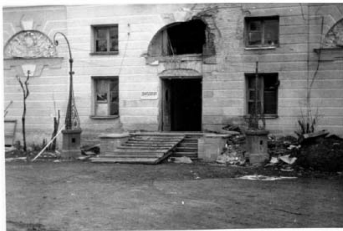
19. Поврежденный фасад Северного корпуса 1944г. https://pastvu.com/
