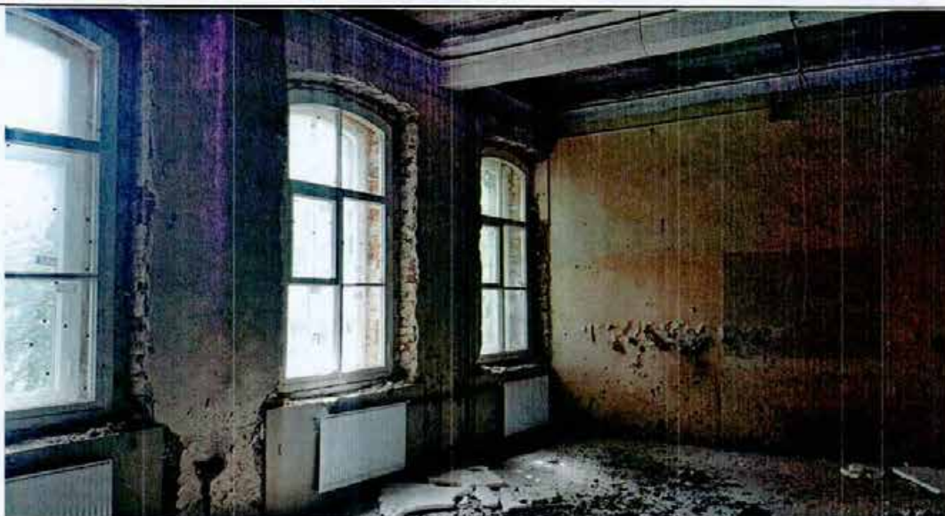
10. Помещение в уровне 2-го этажа
