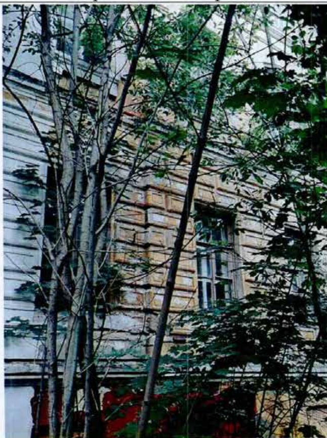
3. Фрагмент восточного фасада
