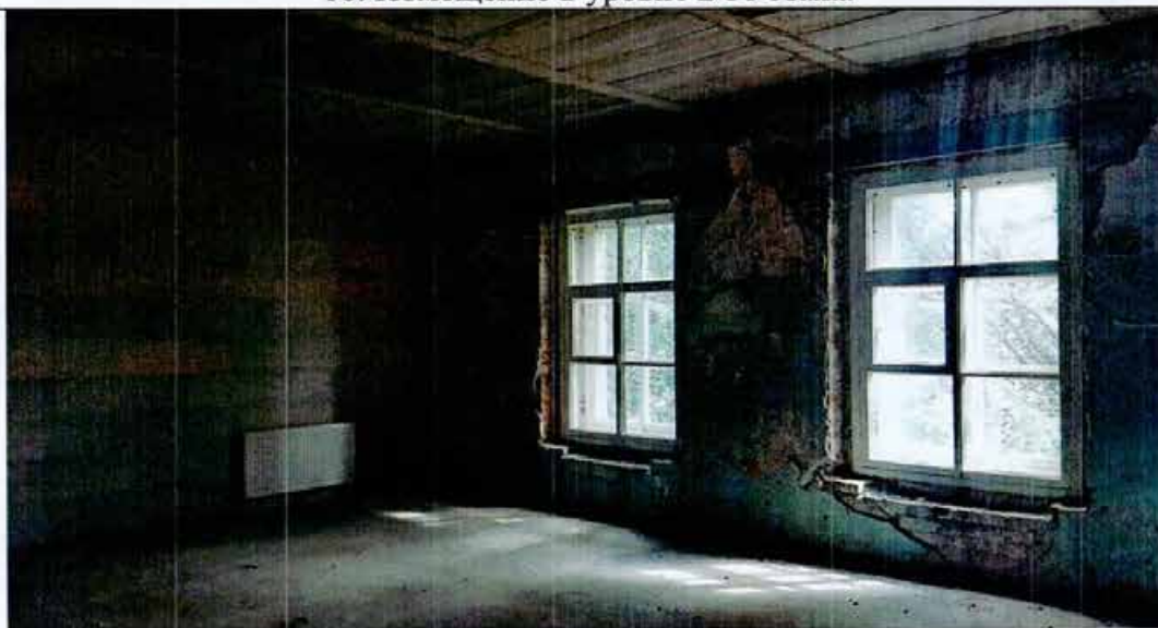
11. Помещение в уровне 2-го этажа
