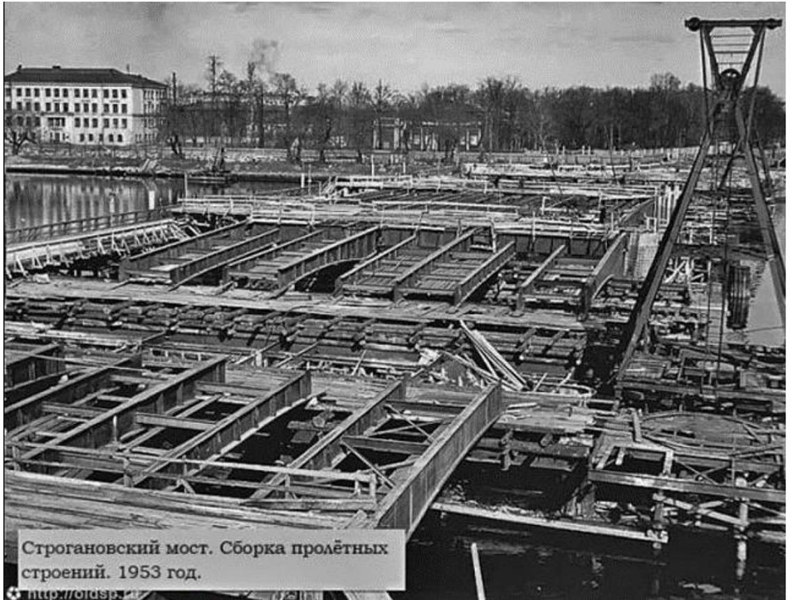
1. «Ушаковский мост (б. Строганов)». 1953 г. Строгановский мост. Сборка пролётных строений [16]/
