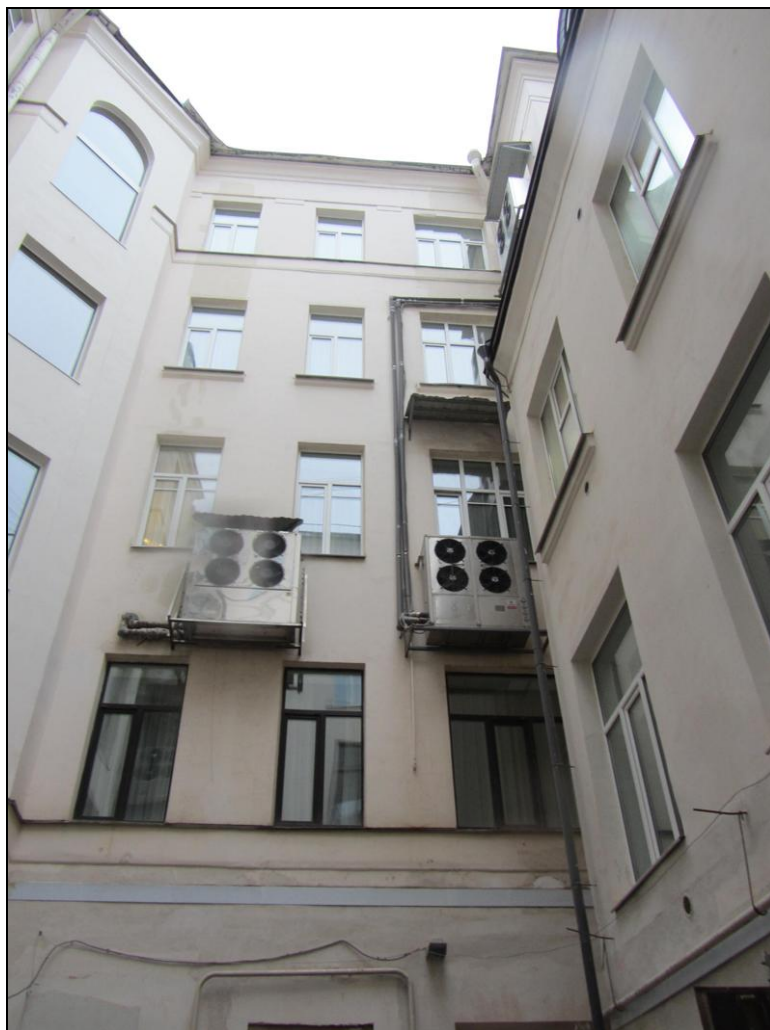
10. «Дом П.Т.Бадаева». Фрагмент дворового фасада. Вид верхних этажей.
