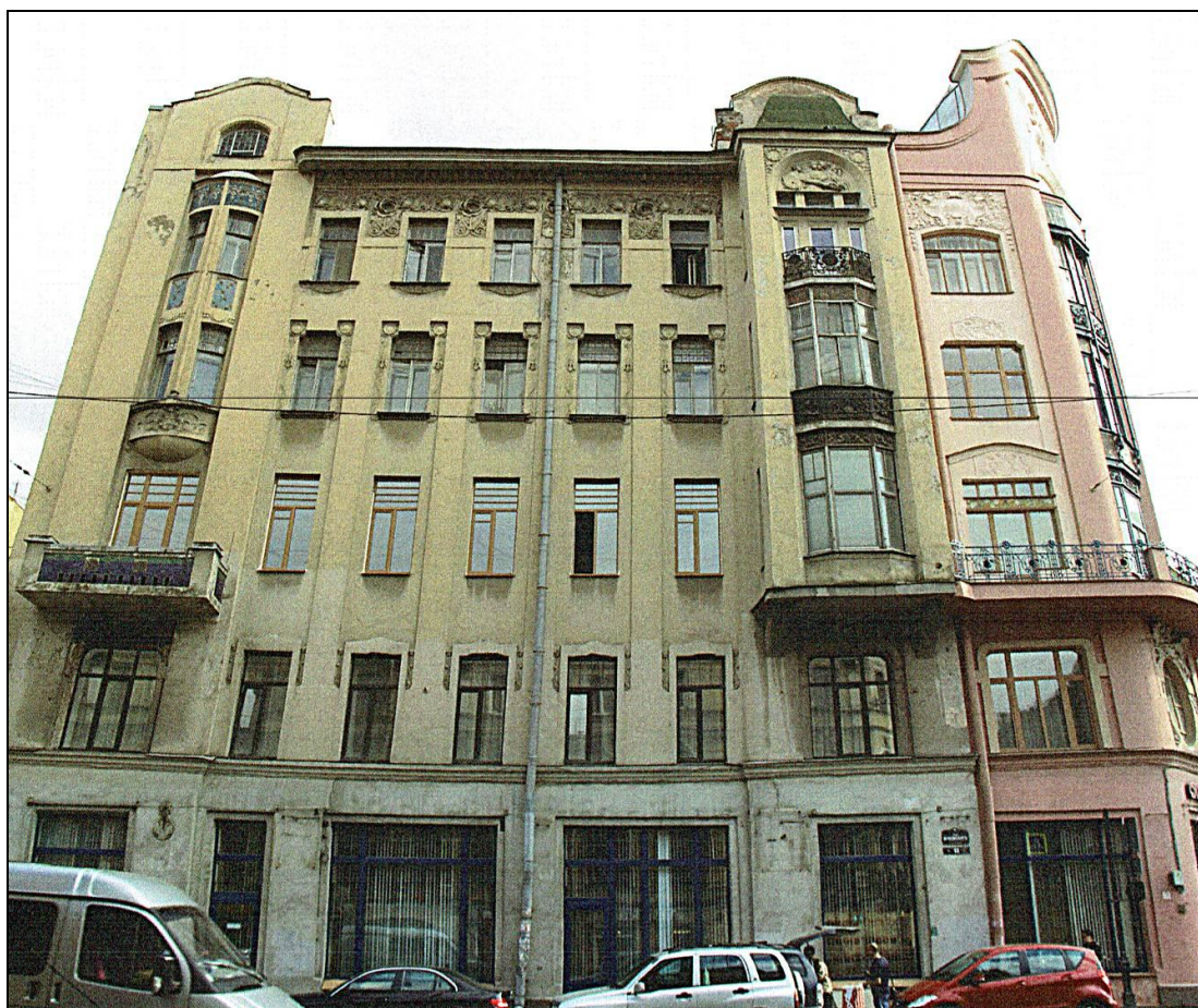
3. «Дом П.Т.Бадаева». Вид северного фасада здания по ул. Жуковского
