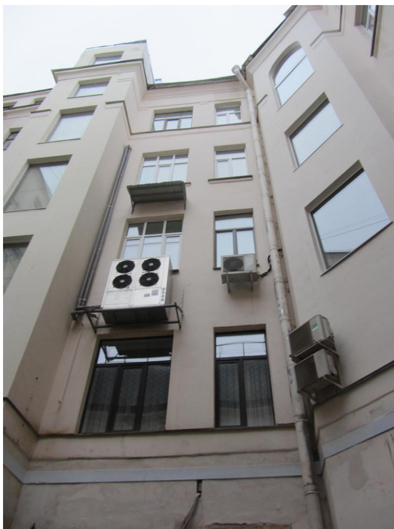
9. «Дом П.Т.Бадаева». Фрагмент дворового фасада. Вид верхних этажей.
