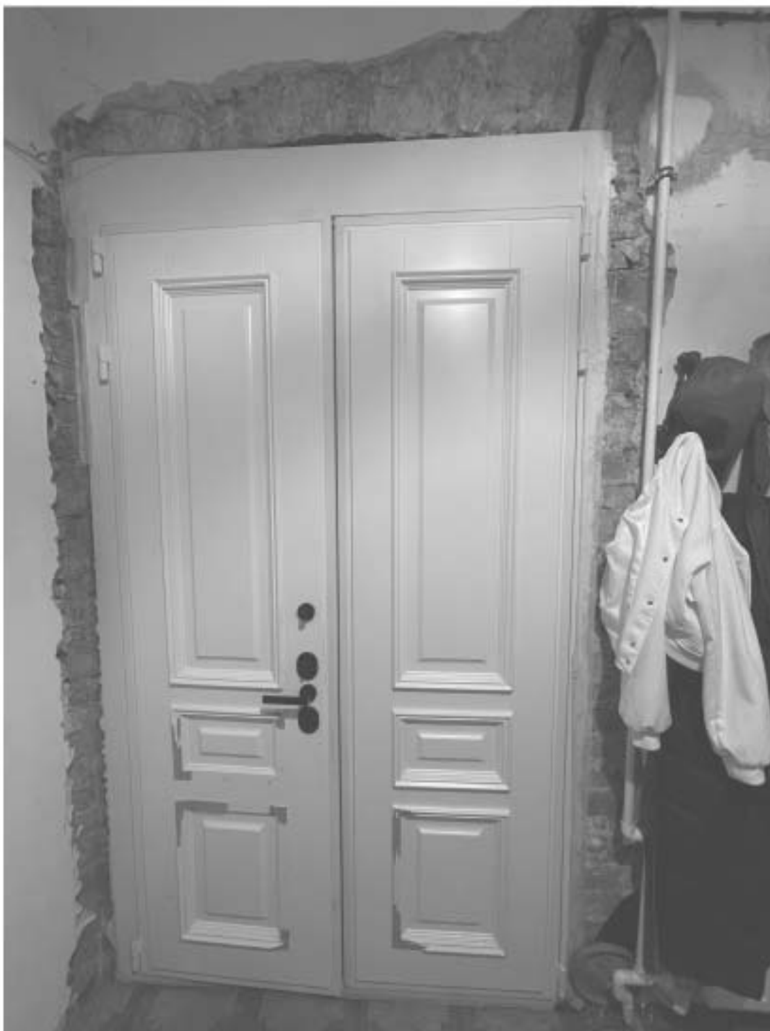
3. Вид на входную дверь в квартире №56;
