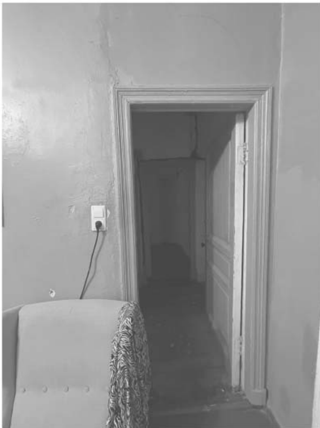
9. Фрагмент интеръера коридора (помещение б/2);
