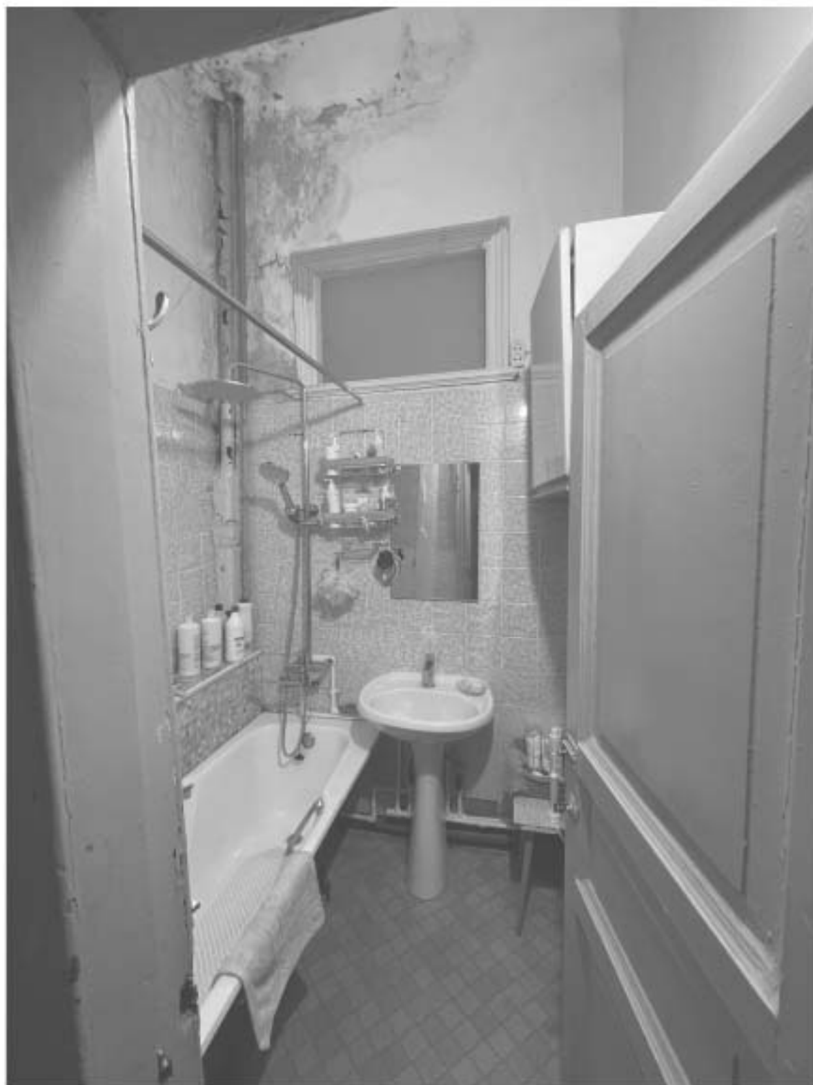
10. Фрагмент интерьера ванной (помещение 5/2.9);
