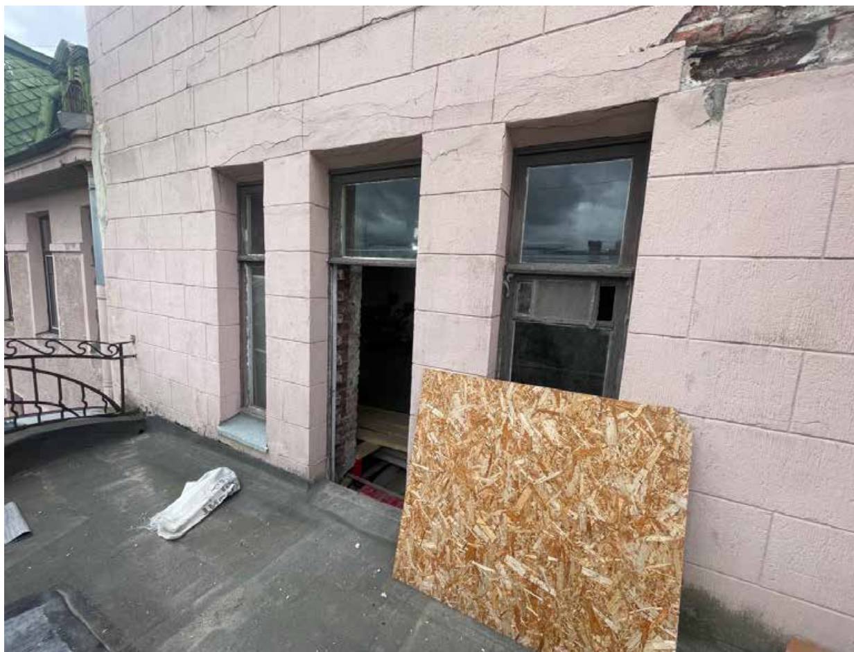
5. Общий вид балконной двери и оконных проемов балкона со стороны лицевого фасада.
