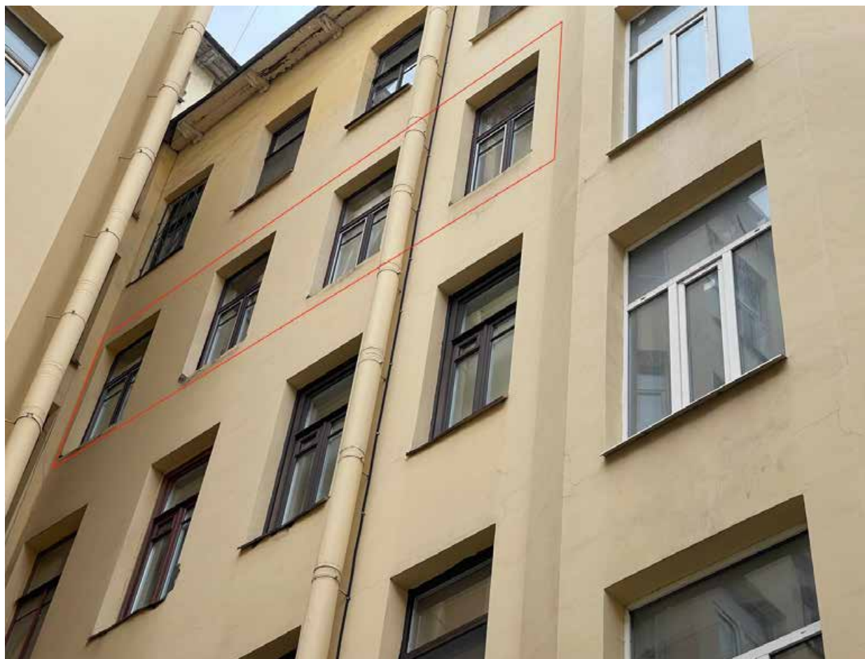
4. Фрагмент дворового фасада. Оконные проемы квартиры №10.
