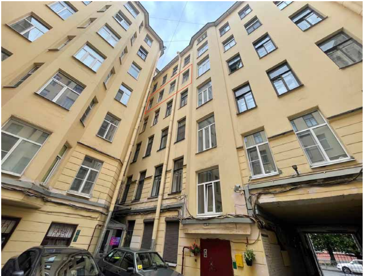
3. Общий вид дворового фасада. Красной линией отмечены оконные проемы квартиры №10.
