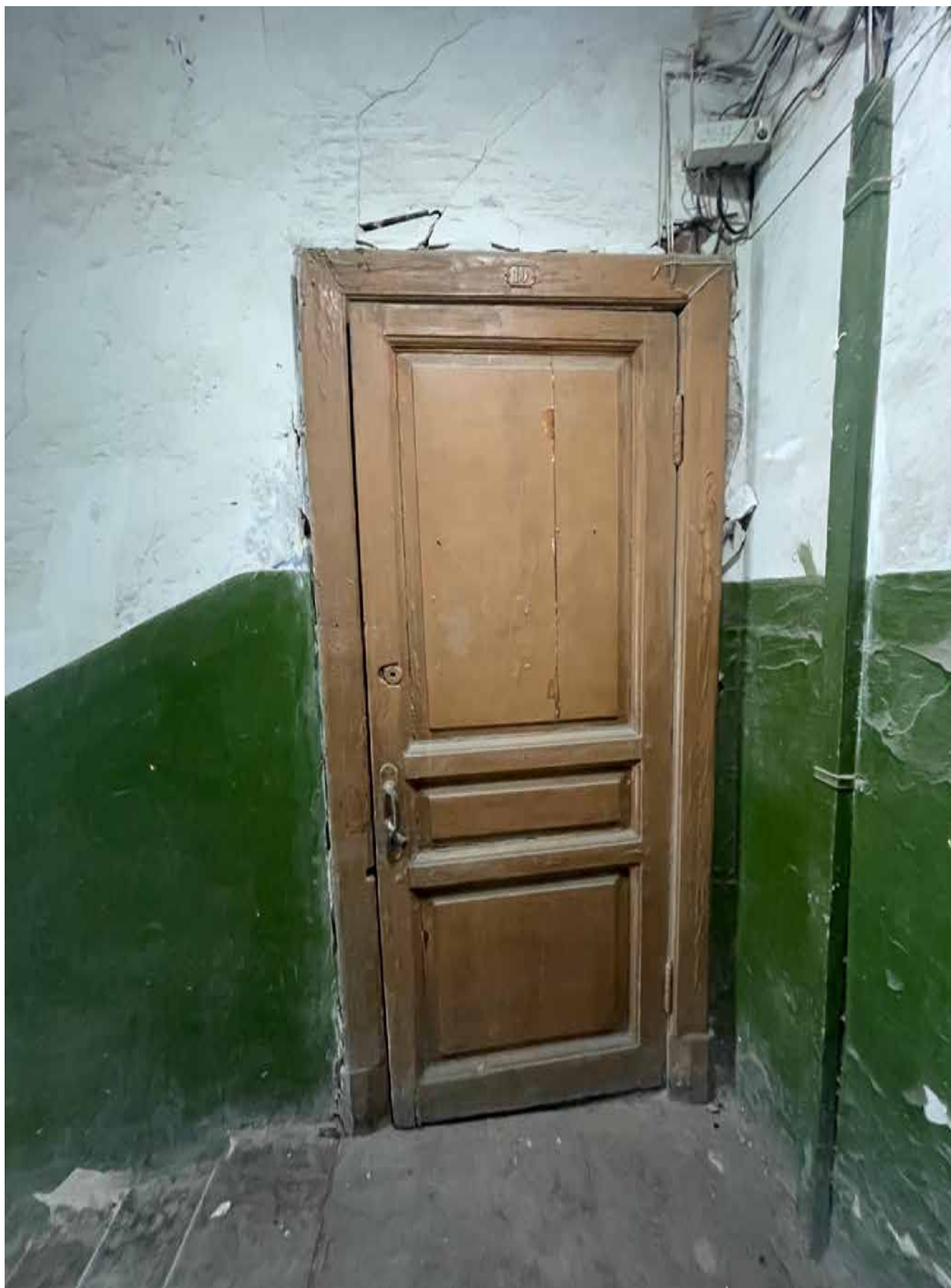
8. Общий вид входной двери в квартиру №10 со стороны 5ЛК.
