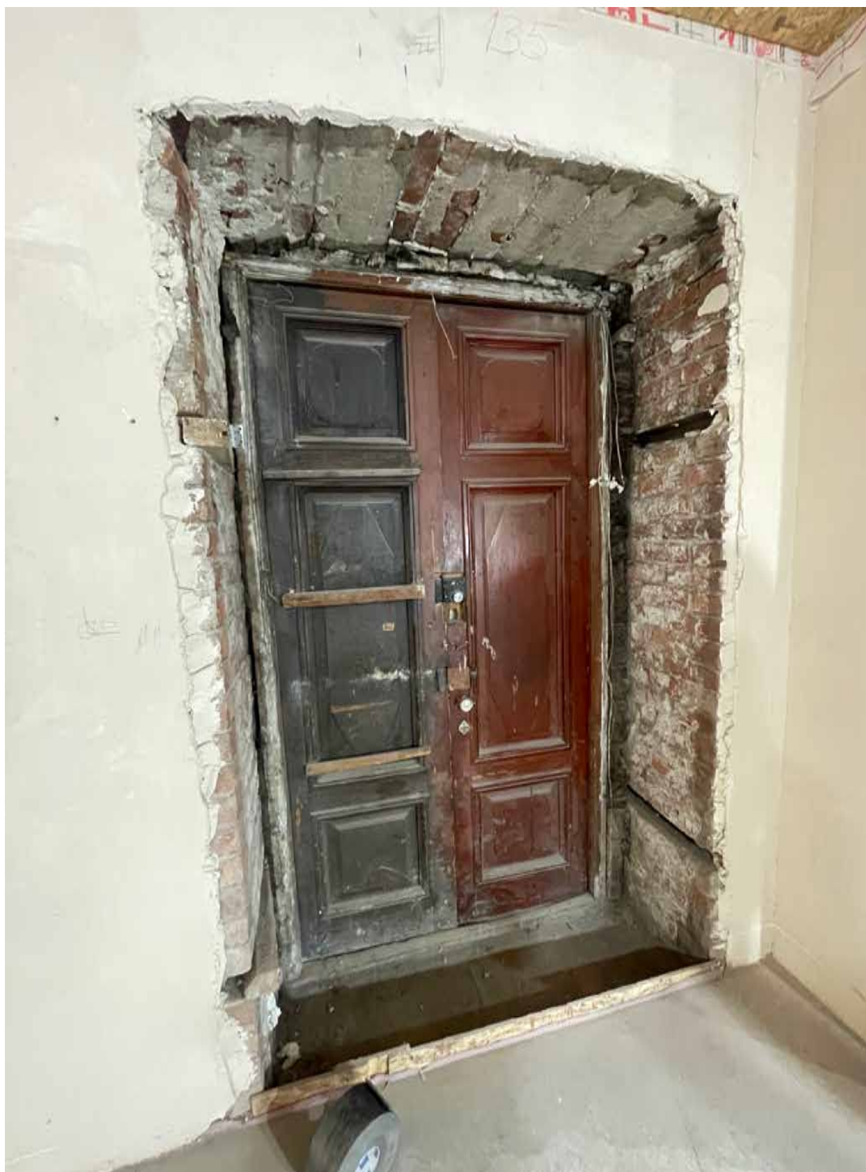
10.Общий вид входной двери со стороны 2ЛК изнутри (помещение 3).
