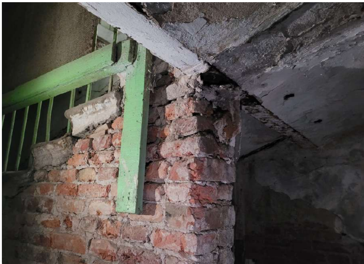
3. ВОКН «Воздвиженское городское мужское училище». Устройство существующей лестницы по центральной оси здания. Дата съемки: 10.02.2025г.
