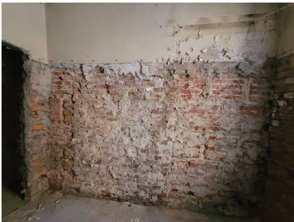
24. ВОКН «Воздвиженское городское мужское училище». Интерьеры 1-го этажа. Следы заложения оконного исторического проема. Дата съемки: 10.02.2025г.
