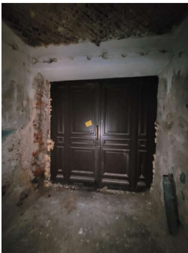
10. ВОКН «Воздвиженское городское мужское училище». Заполнение дверного проема парадного входа. Дата съемки: 10.02.2025г.
