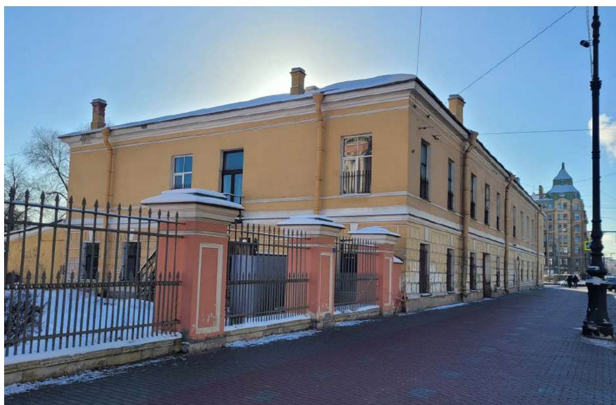
6. ВОКН «Воздвиженское городское мужское училище». Общий вид северного фасада. Дата съемки: 10.02.2025г.
