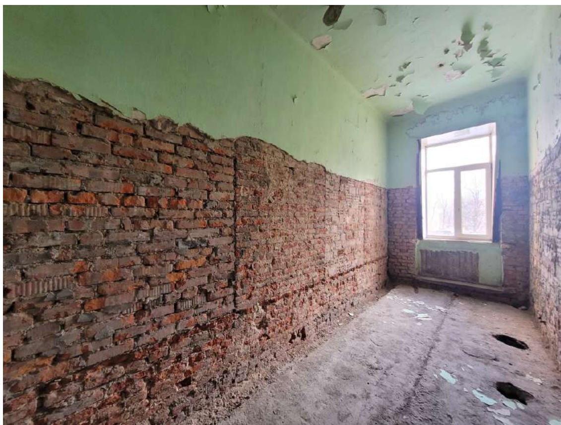
12. ВОКН «Воздвиженское городское мужское училище». Интерьеры 2-го этажа. Следы заложения оконного исторического проема. Дата съемки: 10.02.2025г.
