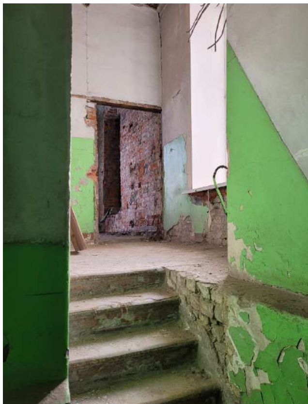
1. ВОКН «Воздвиженское городское мужское училище». Марш лестницы в пристройку. Дата съемки: 10.02.2025г.
