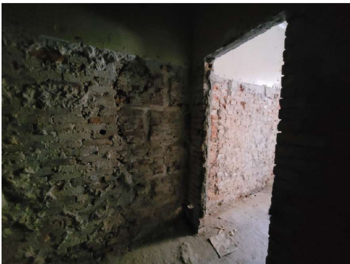
26. ВОКН «Воздвиженское городское мужское училище». Интерьеры 1-го этажа. Следы заложения оконного исторического проема. Дата съемки: 10.02.2025г.
