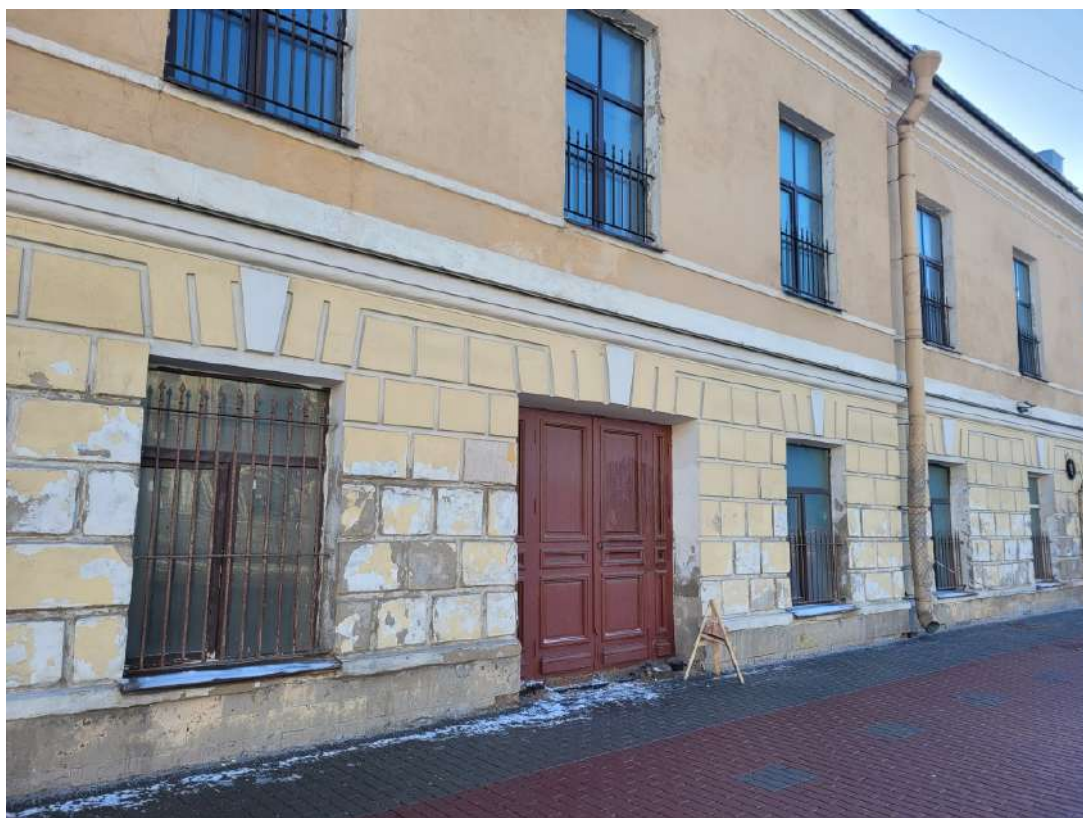
4. ВОКН «Воздвиженское городское мужское училище». Фрагмент западного лицевого фасада. Прямоугольный дверной проем. Дата съемки: 10.02.2025г.
