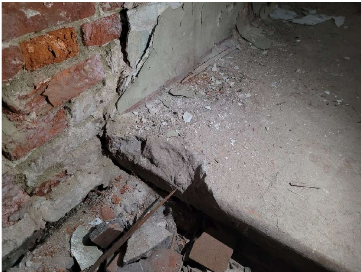
13. ВОКН «Воздвиженское городское мужское училище». Фрагмент площадки вестибюля парадного входа. Дата съемки: 10.02.2025г.
