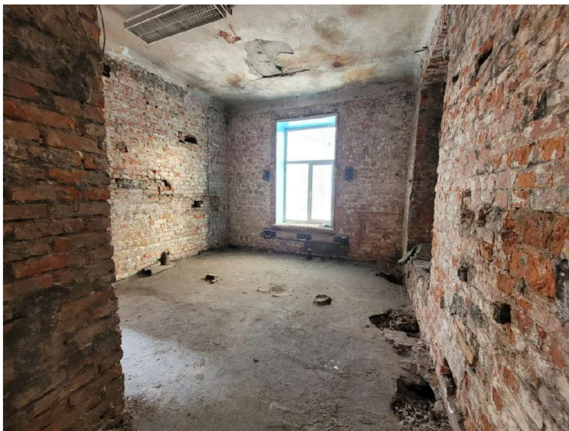
2. ВОКН «Воздвиженское городское мужское училище». Общий вид пристройки. Дата съемки: 10.02.2025г.
