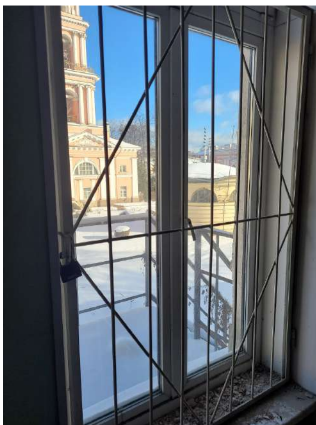
26. ВОКН «Воздвиженское городское мужское училище». Исторический оконный проем. Дата съемки: 10.02.2025г.
