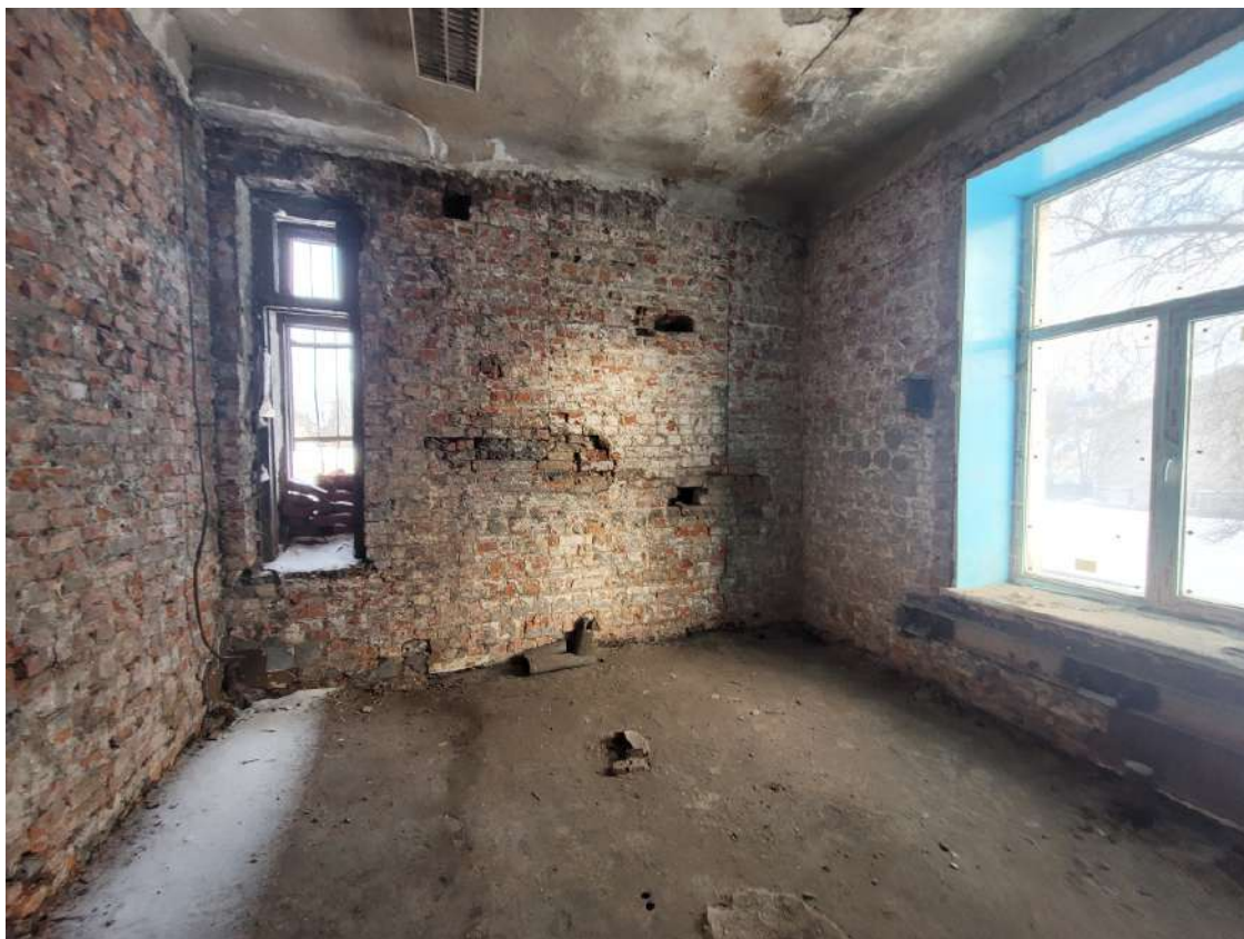
3. ВОКН «Воздвиженское городское мужское училище». Общий вид пристройки. Дата съемки: 10.02.2025г.
