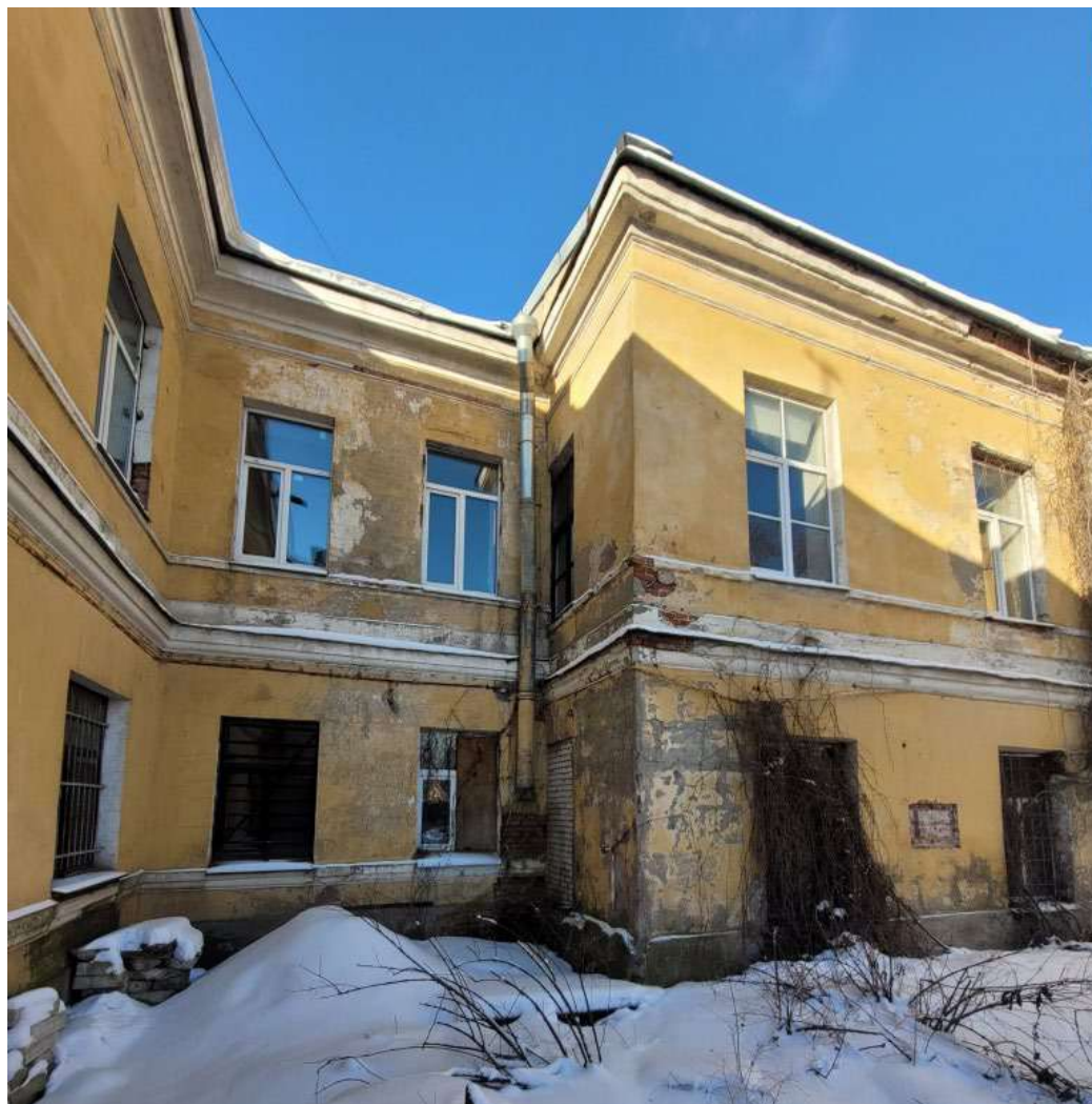
13. ВОКН «Воздвиженское городское мужское училище». Фрагмент дворового фасада. Место примыкания исторического объема и пристройки 1950-х гг. Дата съемки: 10.02.2025г.
