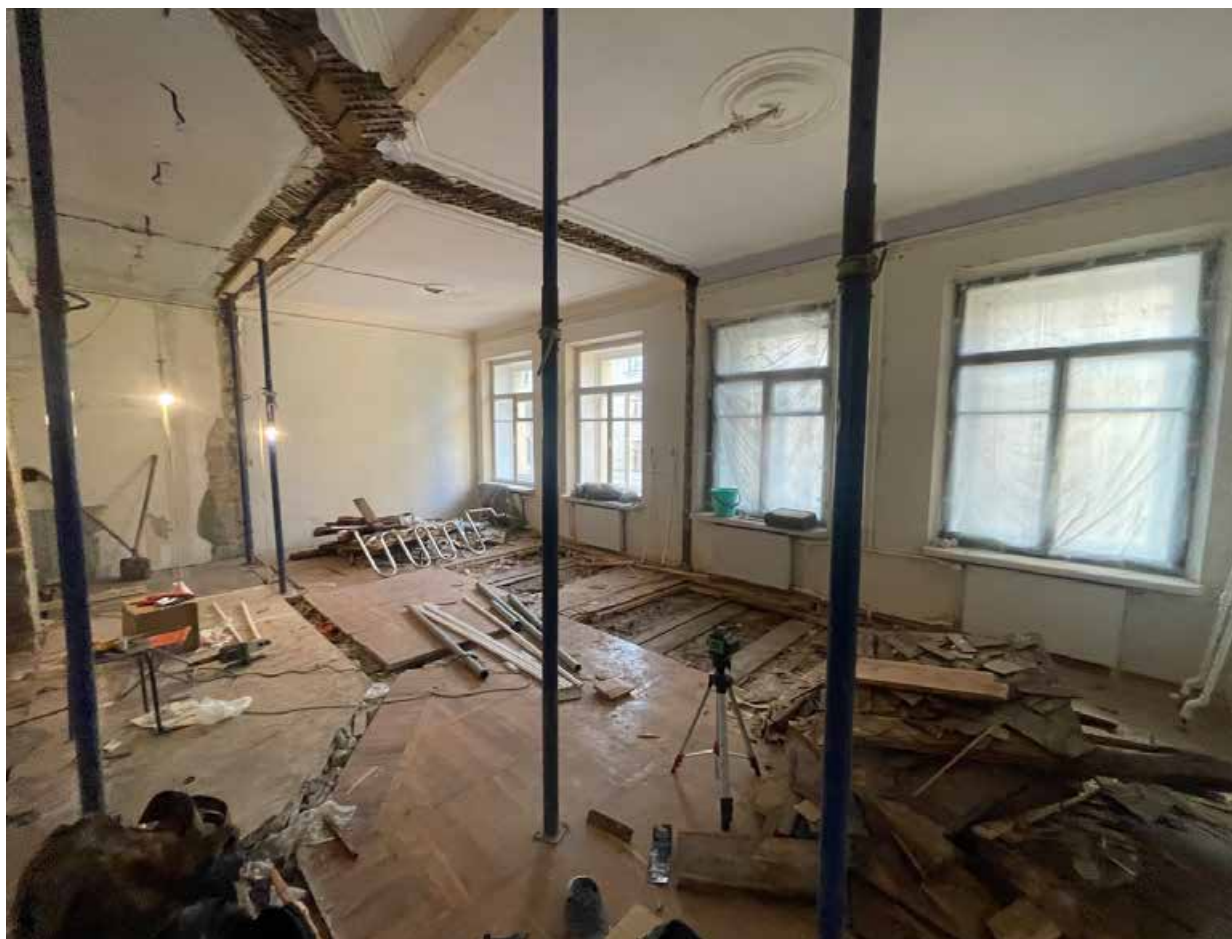
8. Общий вид помещения в квартире № 42 (оконные проемы со стороны лицевого фасада).
