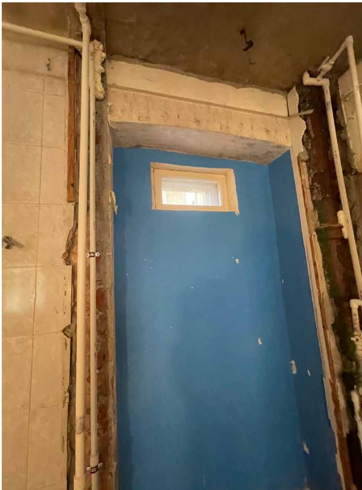
10. Оконный проем со стороны дворового фасада.
