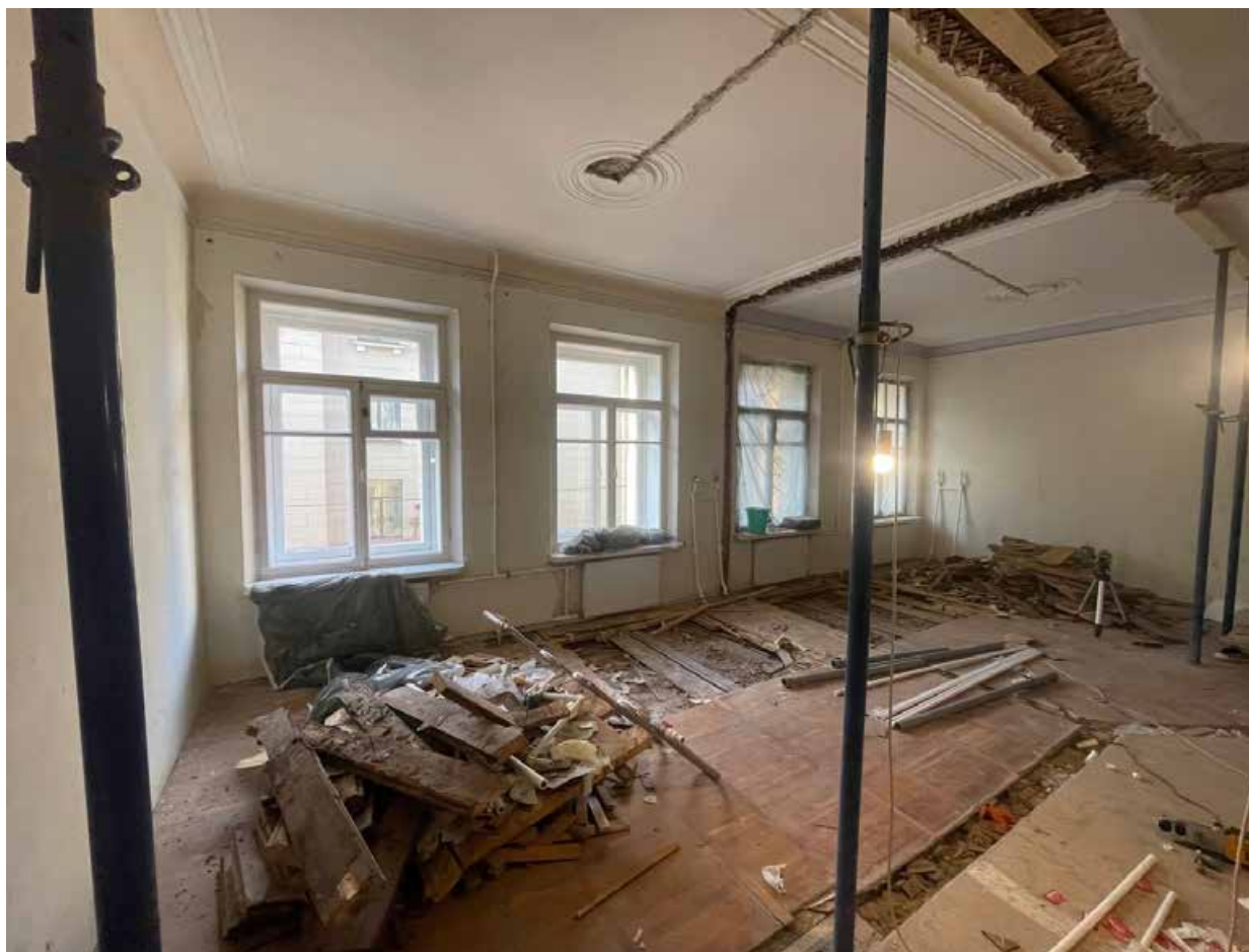
6. Общий вид помещения квартиры № 42 (оконные проемы в сторону лицевого фасада).
