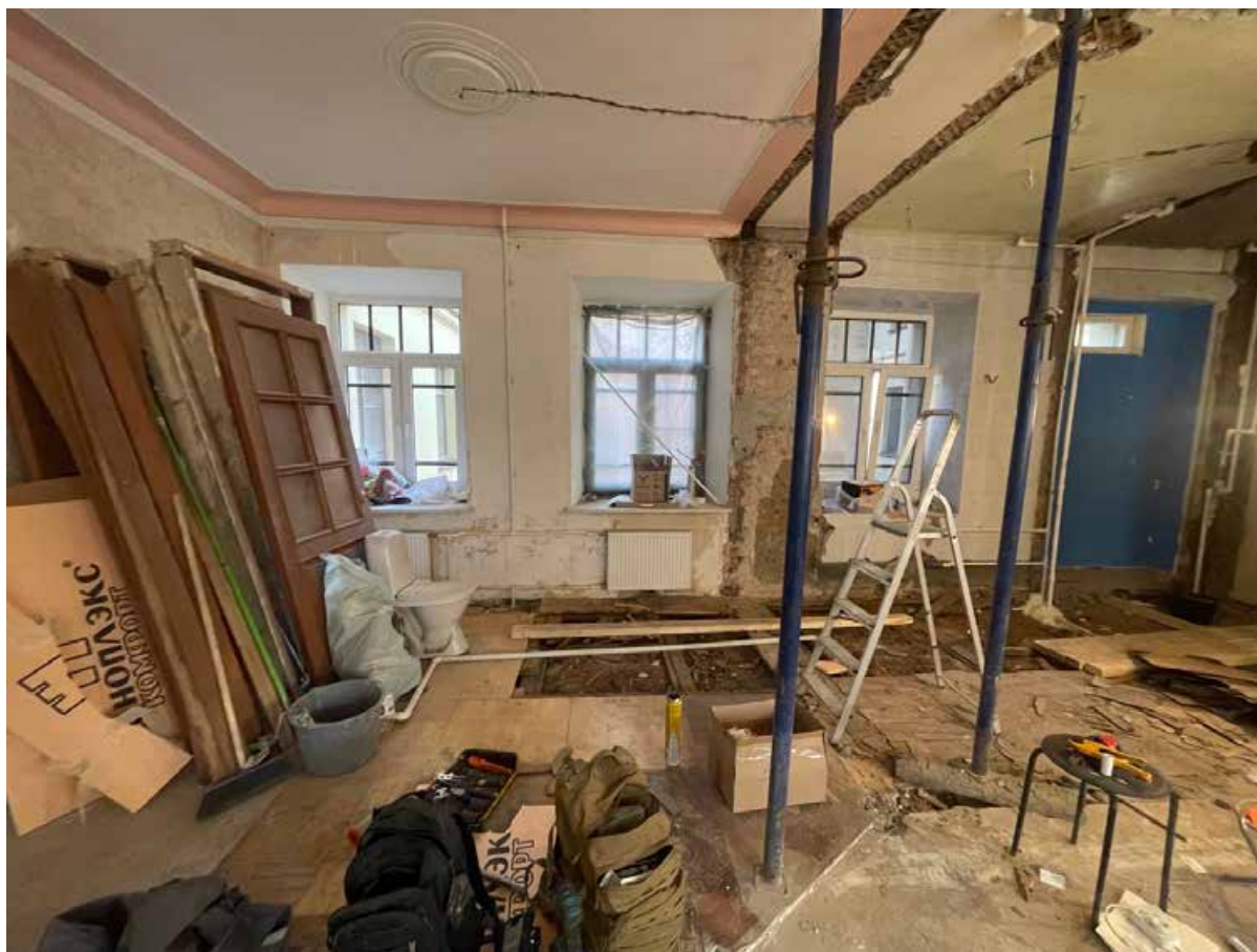
9. Общий вид помещения квартиры № 42 (оконные проемы со стороны дворового фасада).
