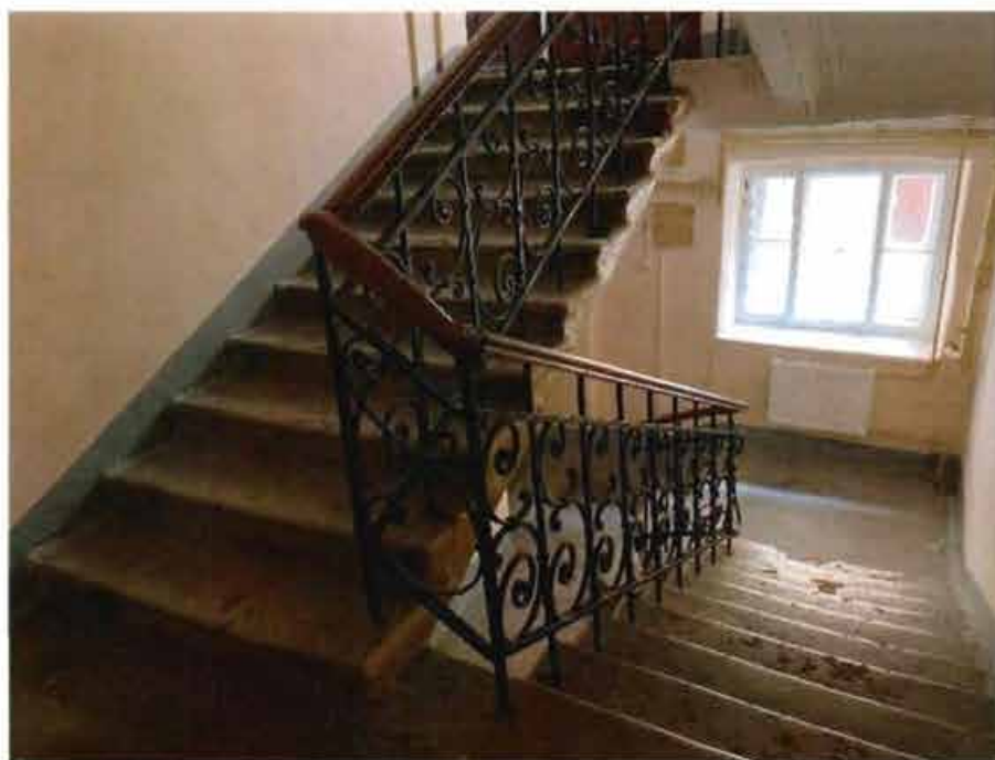
4. Помещение лестницы 2ЛК объекта культурного наследия.
