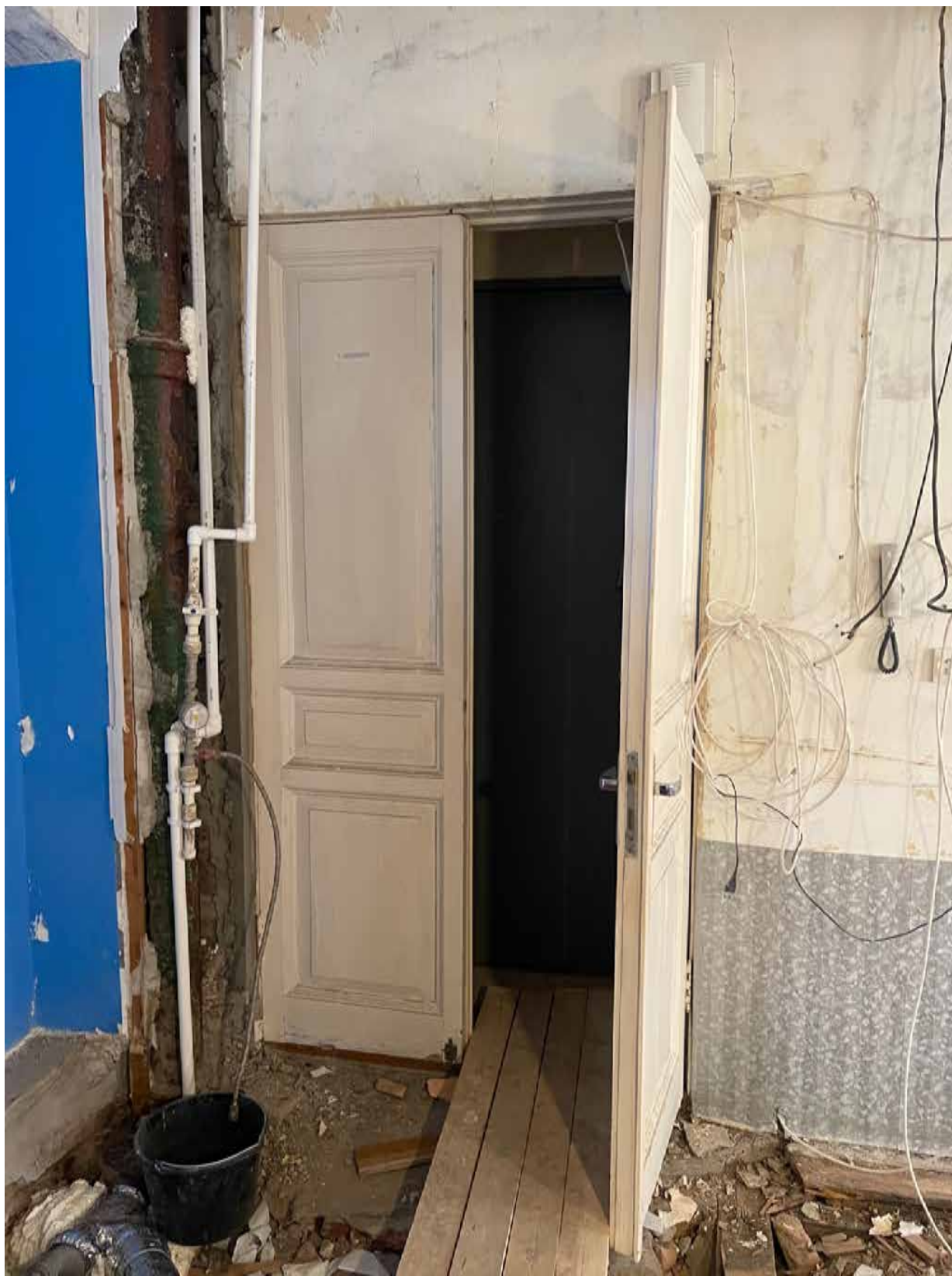
5. Входной тамбур в квартире № 42.
