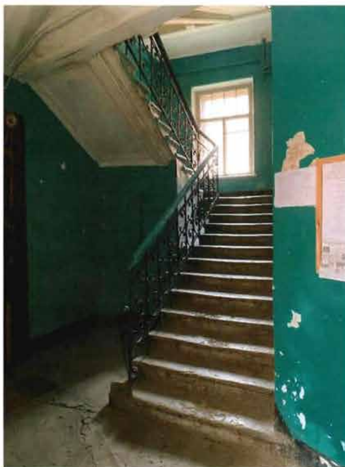
3. Помещение лестницы 3ЛК объекта культурного наследия.
