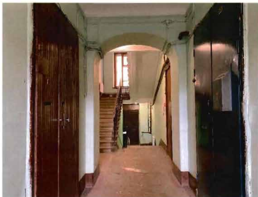
5. Помещение лестницы 1ЛК объекта культурного наследия.
