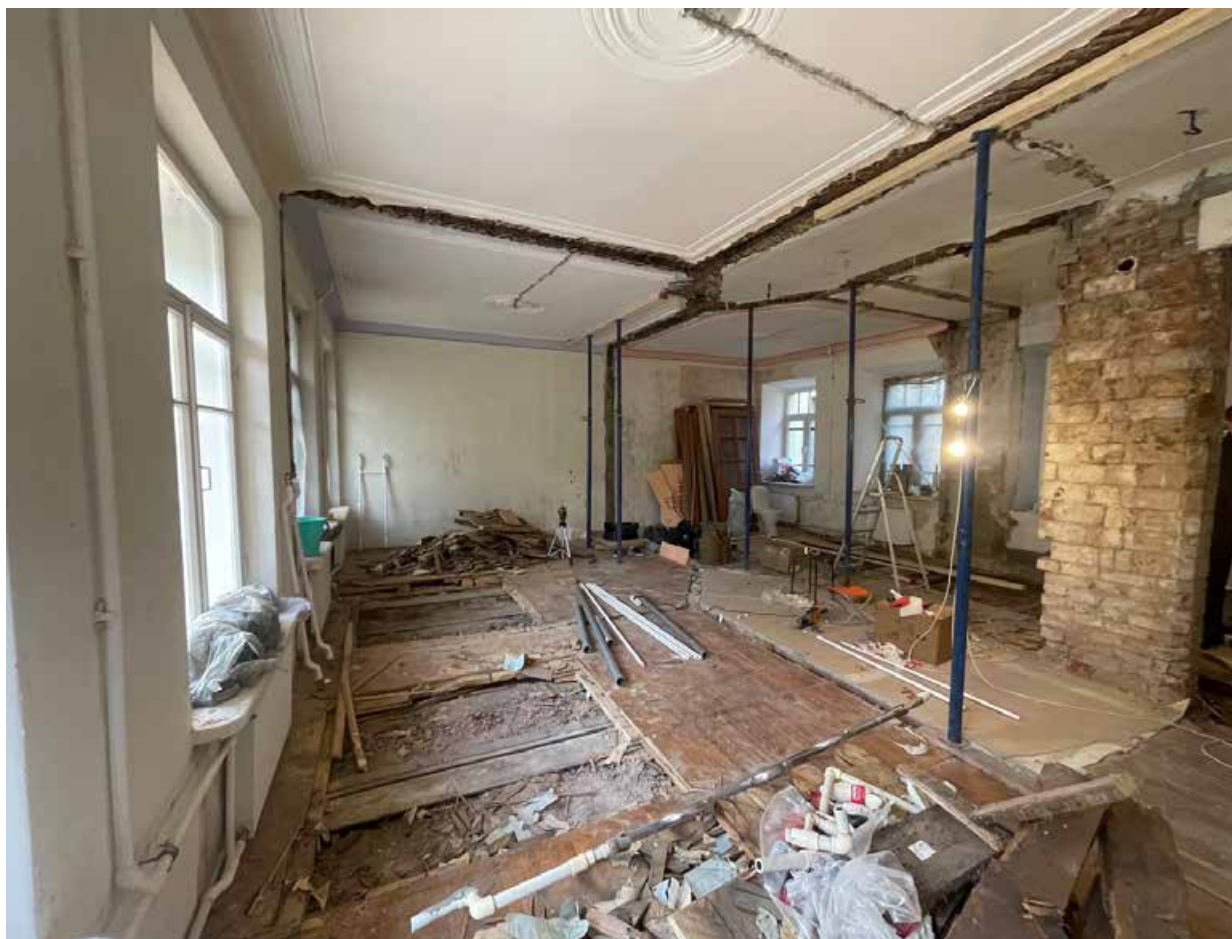
7. Общий вид помещений квартиры № 42 (оконные проемы слева в сторону лицевого фасада, оконные проемы справа – в сторону дворового).
