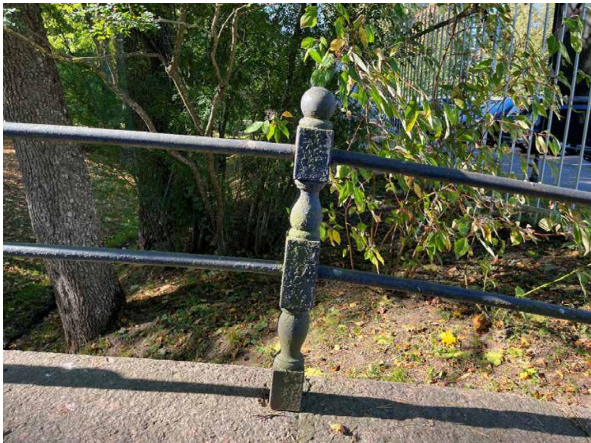
Фото 17. Фигурная вертикальная стойка. Общий вид. Западная сторона. Дата фотофиксации: 29.08.24
