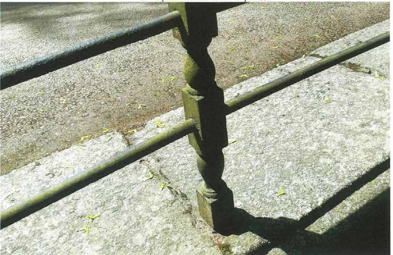
4. Фрагмент перильного ограждения.
