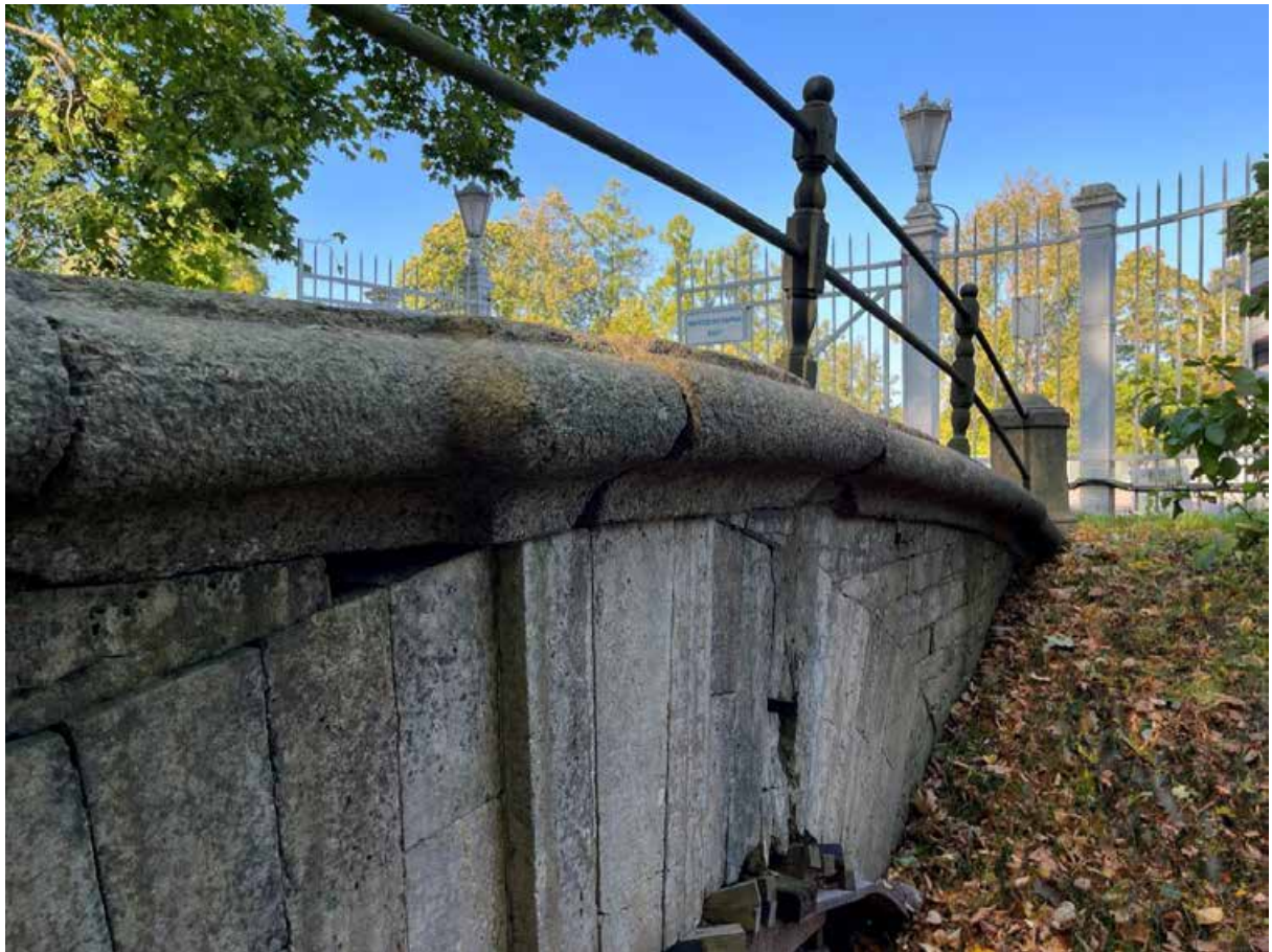
Фото 7. Гранитный блоки с веерной выкладкой и профилировкой по верхнему краю. Фрагмент. Вид с восточной стороны. Дата фотофиксации: 29.08.24
