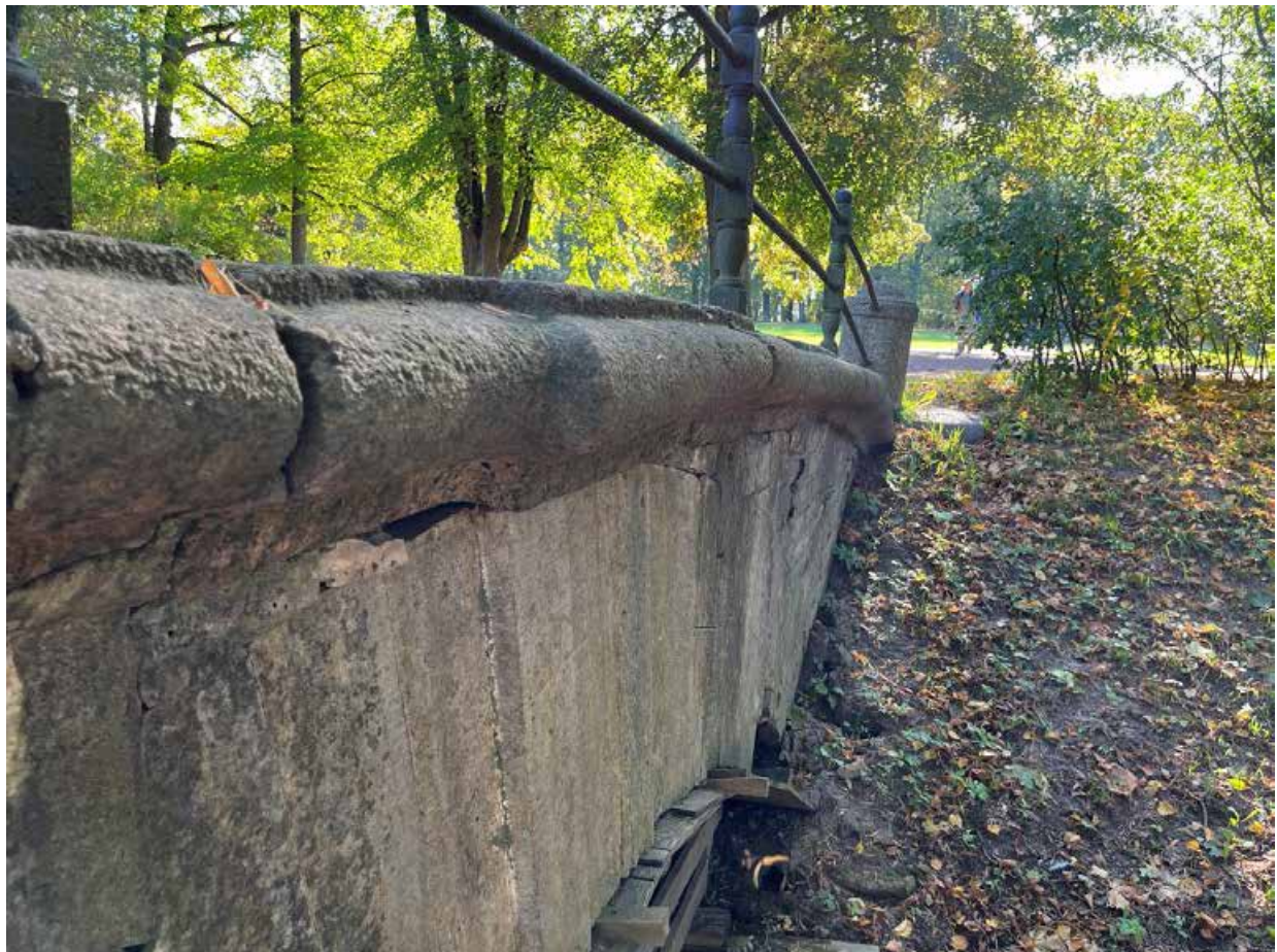
Фото 14. Профилировка по верхнему краю. Фрагмент. Вид с западной стороны. Дата фотофиксации: 29.08.24
