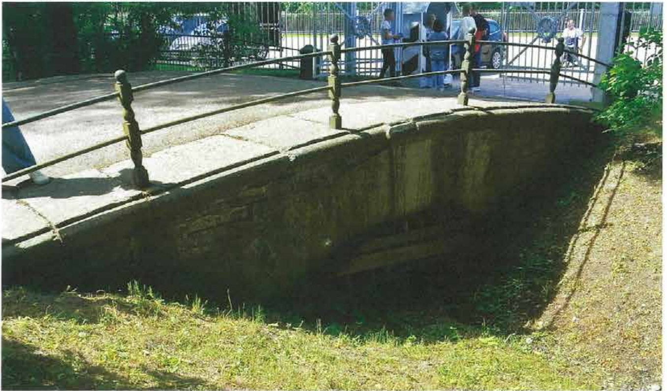
1. Общий вид восточного фасада.
