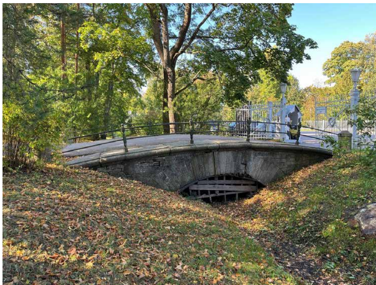
Фото 4. Однопролётный каменный мост с каменными устоями и цилиндрическим сводом. Общий вид с восточной стороны. Дата фотофиксации: 29.08.24
