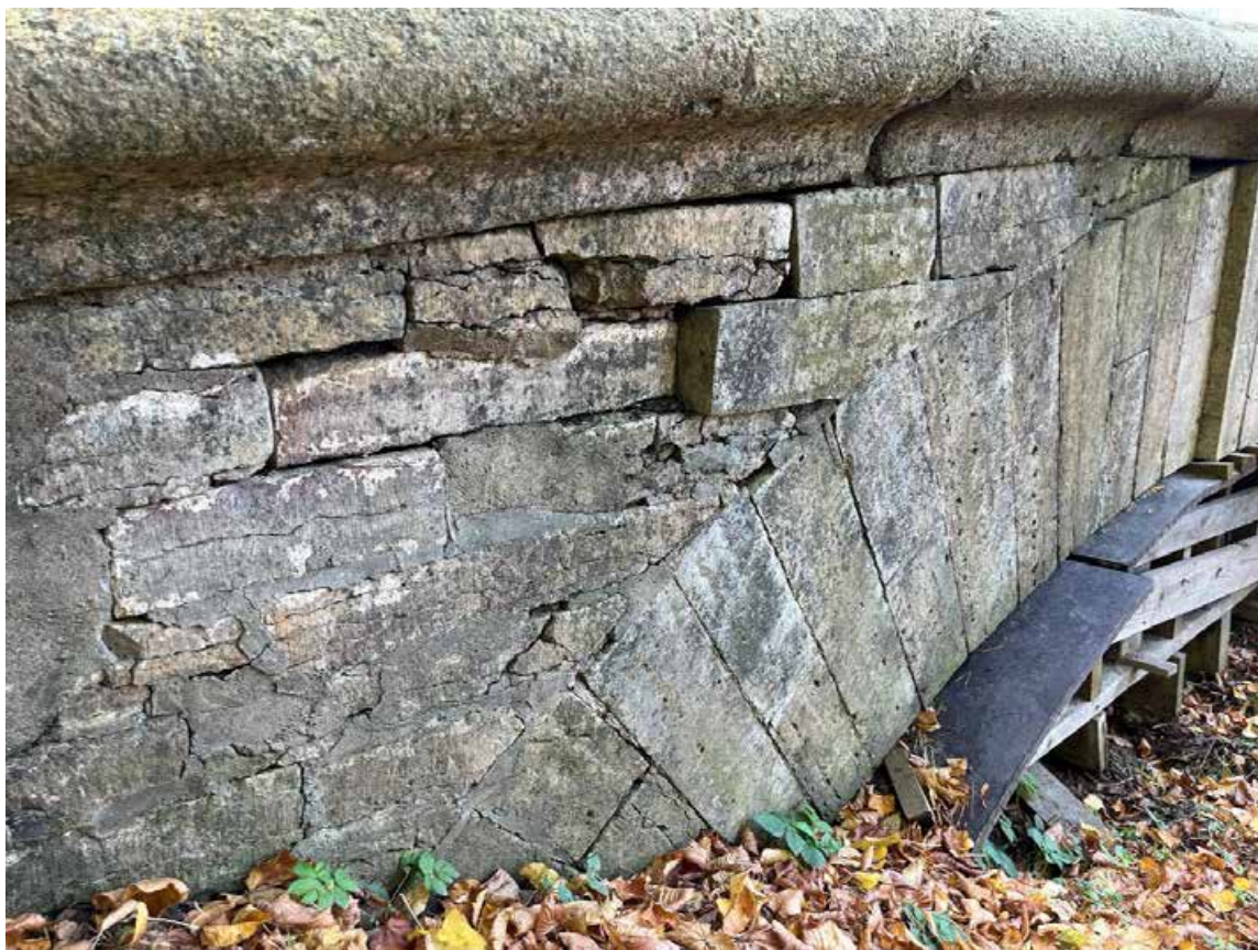
Фото 16. Гранитный блоки с веерной выкладкой и профилировкой по верхнему краю. Фрагмент. Вид с западной стороны. Дата фотофиксации: 29.08.24
