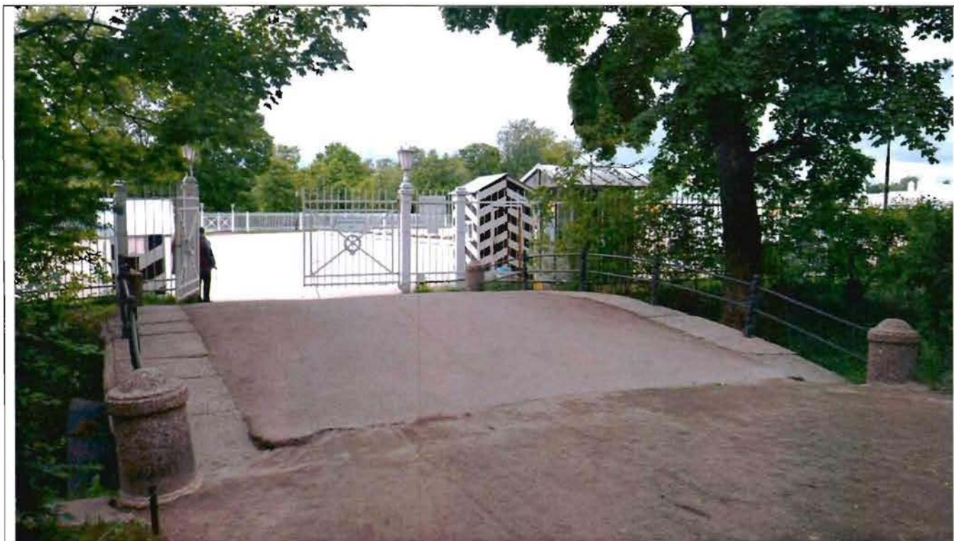
Фото 1. Общий вид моста с южной стороны.
