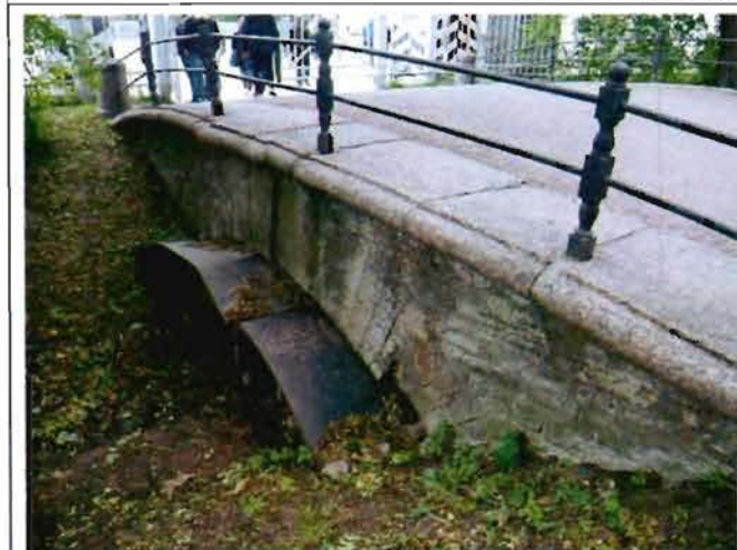
Фото 2. Западный фасад моста. Фрагмент.
