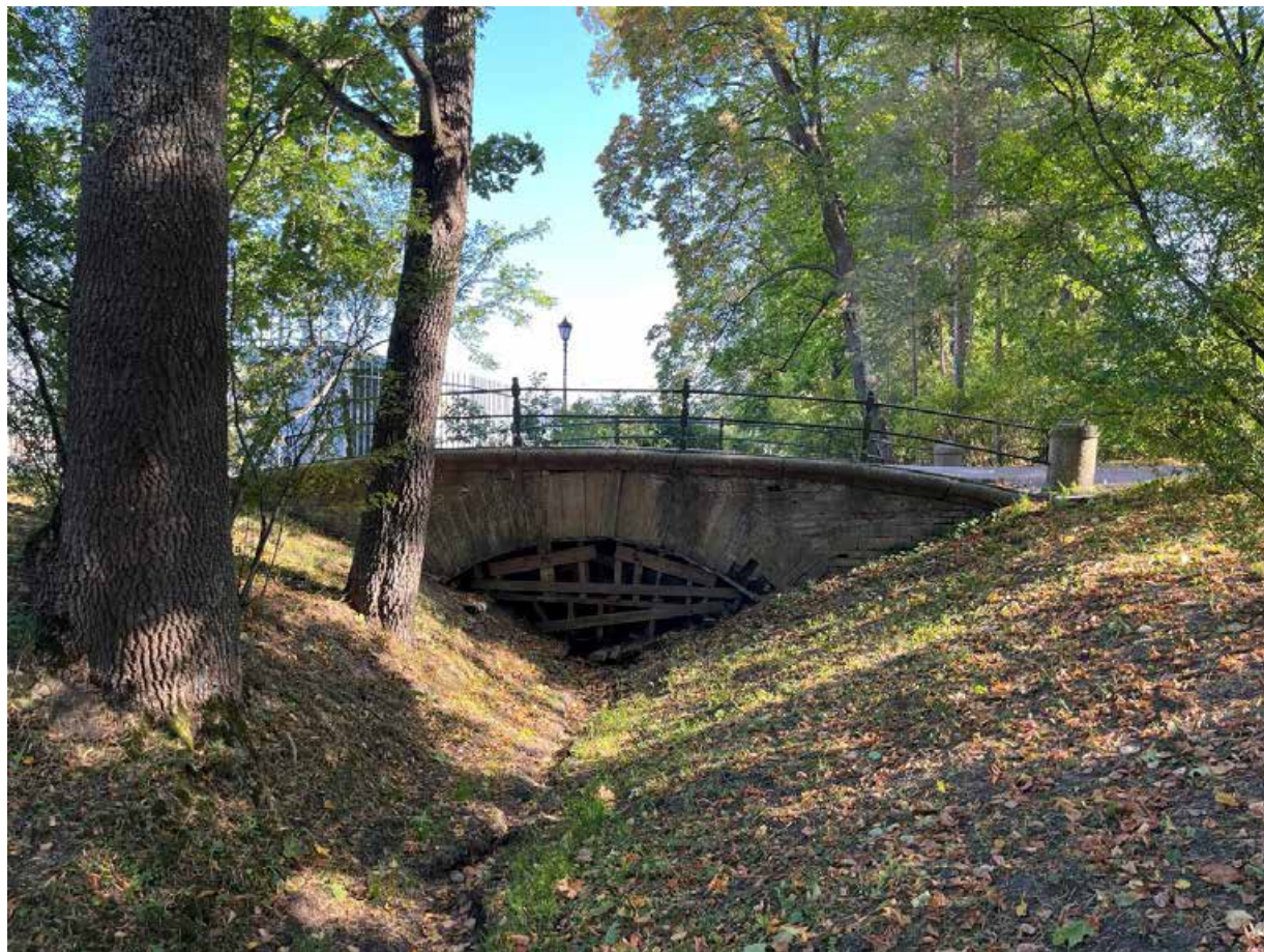
Фото 5. Однопролётный каменный мост с каменными устоями и цилиндрическим сводом. Общий вид с западной стороны. Дата фотофиксации: 29.08.24
