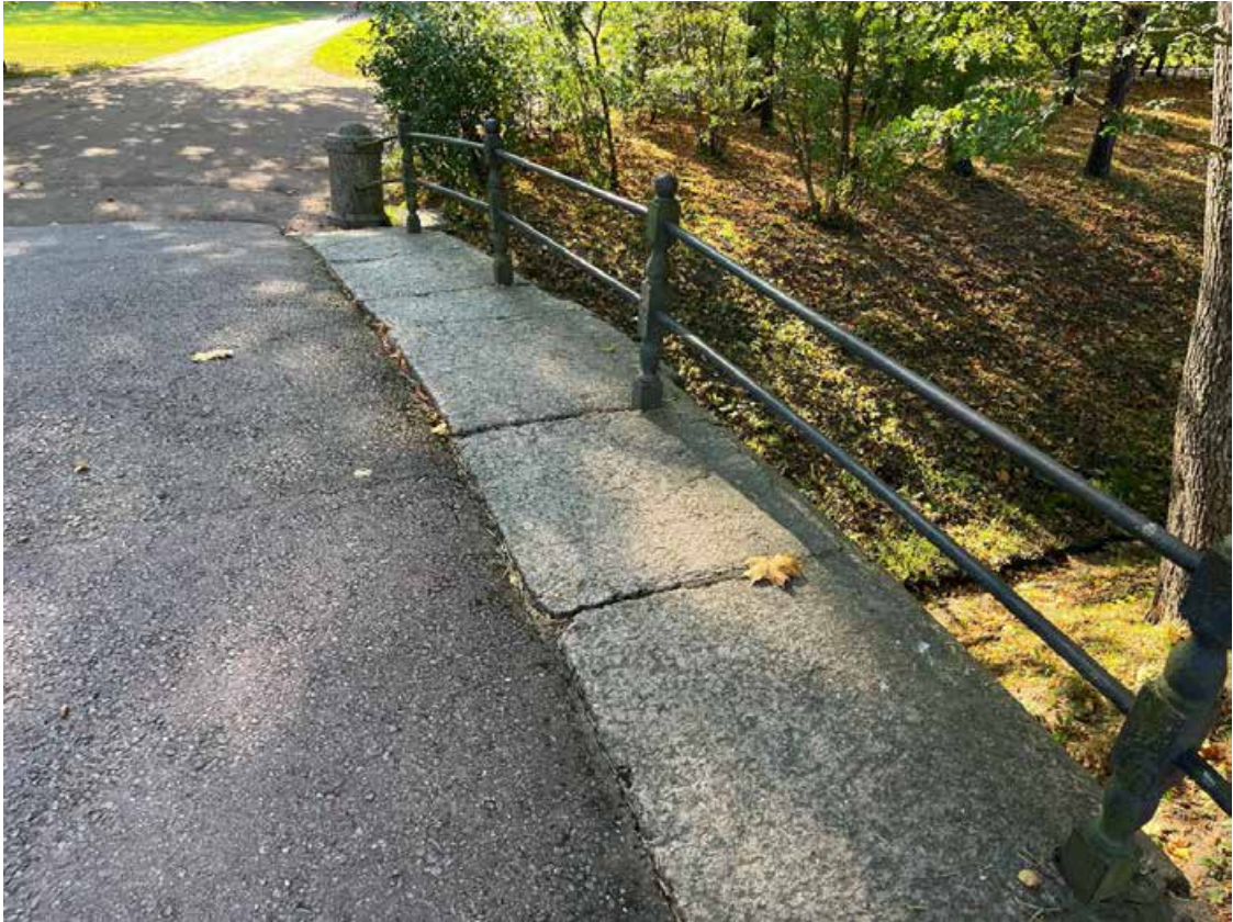
Фото 11. Металлическое перильное ограждение с фигурными вертикальными стойками и горизонтальными направляющими. Фрагмент. Дата фотофиксации: 29.08.24
