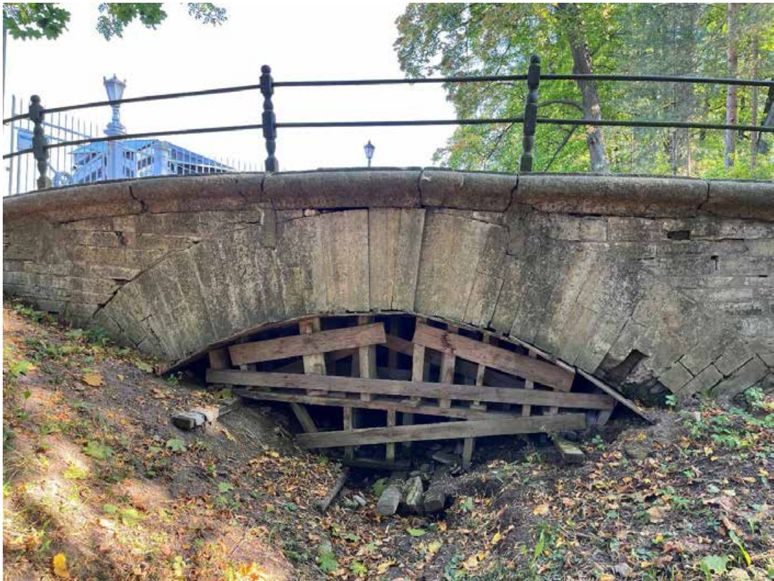
Фото 12. Гранитный блоки с веерной выкладкой и профилировкой по верхнему краю. Фрагмент. Вид с западной стороны. Дата фотофиксации: 29.08.24
