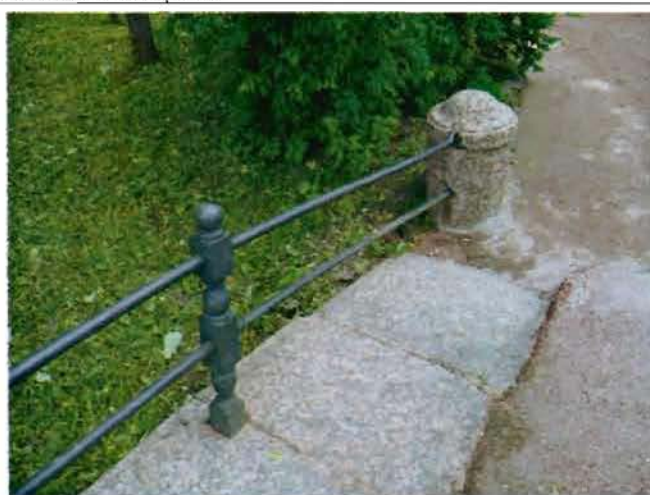
Фото 3. Перильное ограждение моста. Общий вид.
