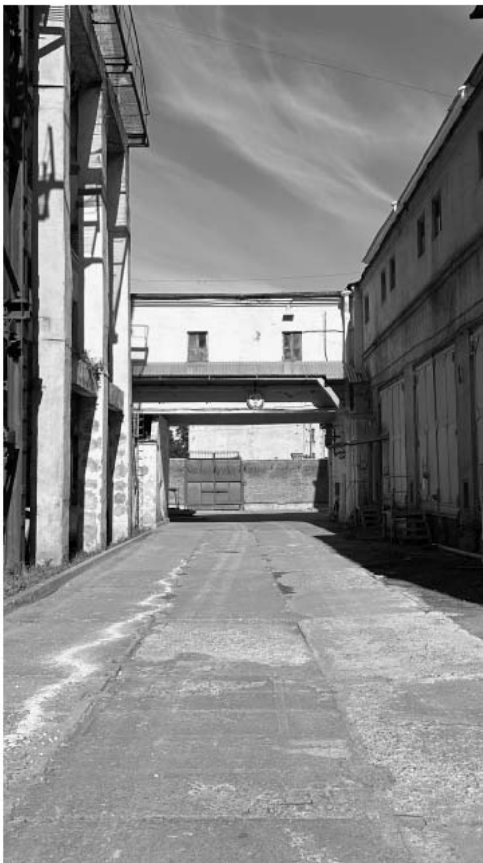
11. Вид с востока на переход между корпусами (объект культурного наследия регионального значения «Административное здание и машинный зал») и объект культурного наследия регионального значения «Котельная ТЭЦ-2» в составе объекта культурного наследия регионального значения «Петроградское общество электрических сооружений (ТЭЦ-2)»).
