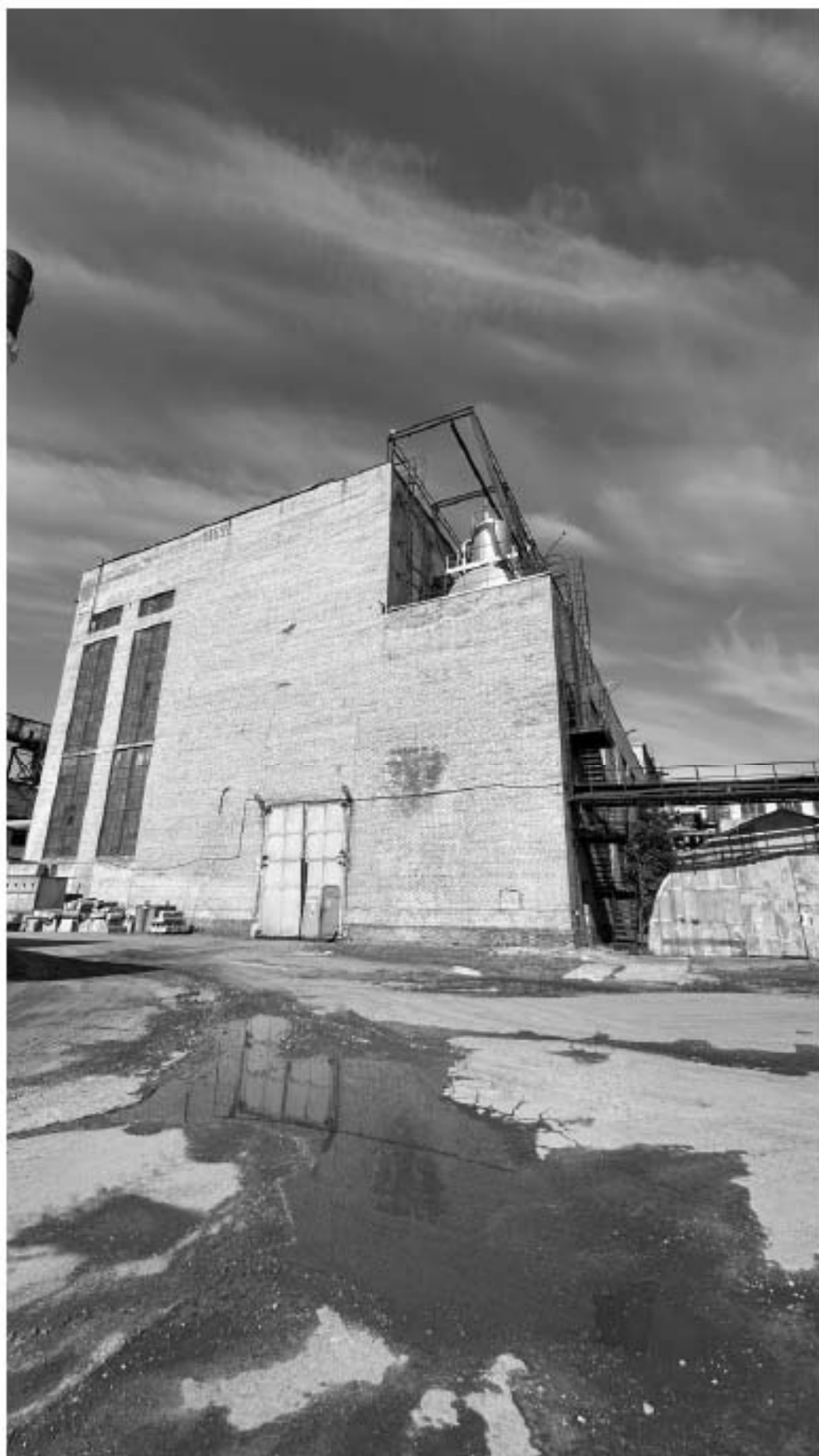
5. Восточный торцевой фасад здания по адресу: Санкт-Петербург, Новгородская улица, дом 11, литера А.
