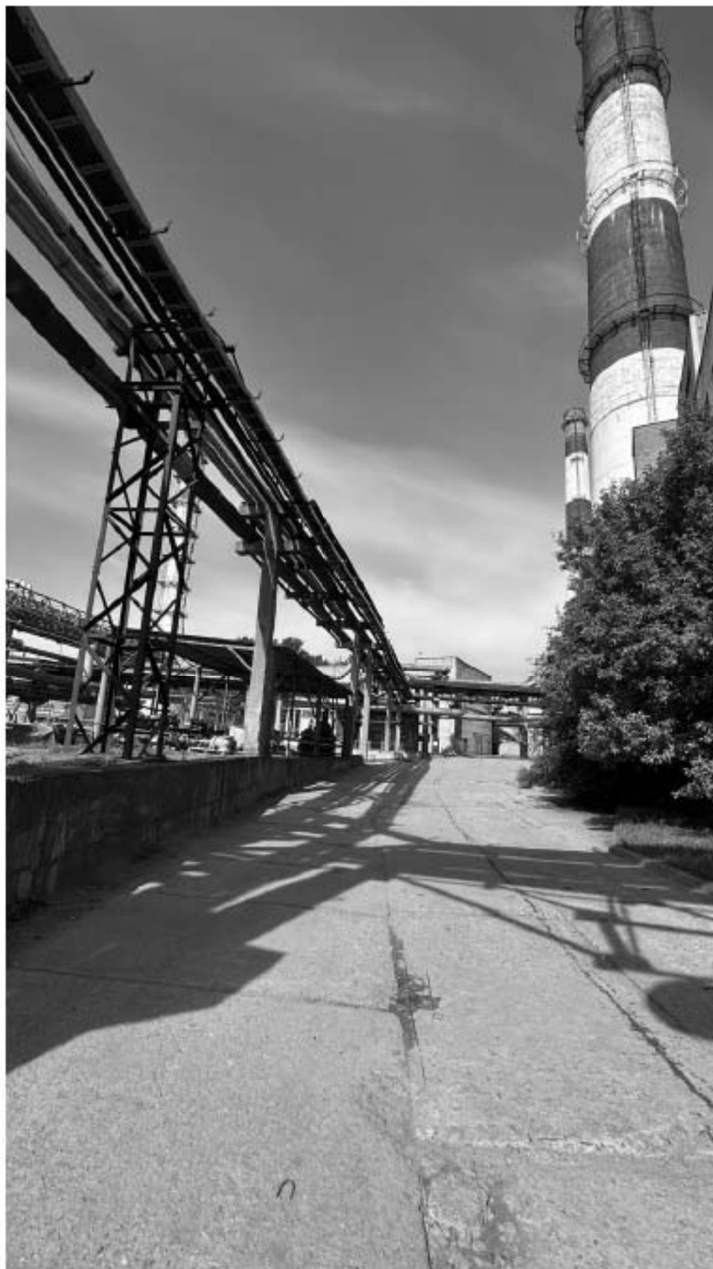
24. Вид на участок реализации проекта «Строительство здания администрации ЭС-2 Центральной ТЭЦ филиала «Невский» ПАО «ТГК-1».
