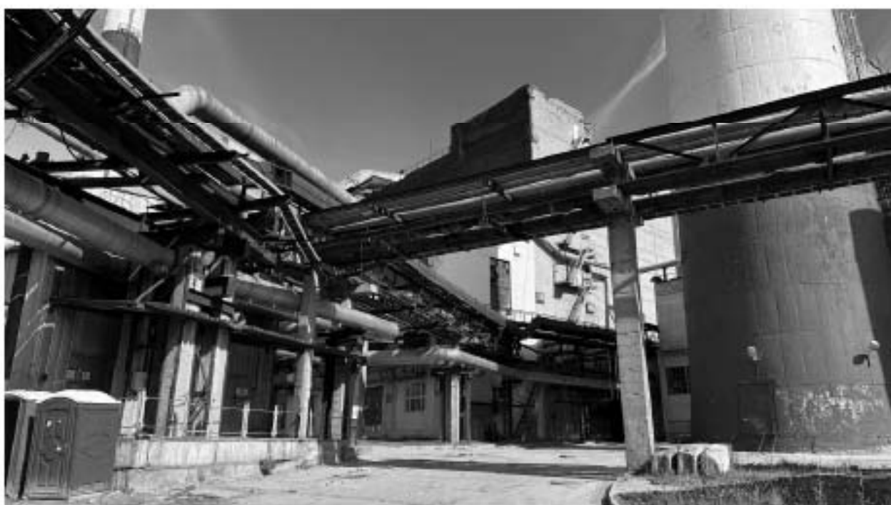
23. Вид на участок реализации проекта «Строительство здания администрации ЭС-2 Центральной ТЭЦ филиала «Невский» ПАО «ТГК-1».
