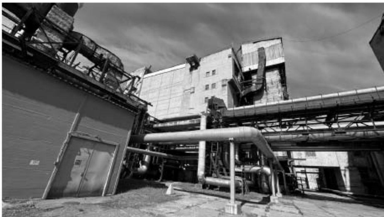
9. Вид с запада на переход между корпусами здания по адресу: Санкт-Петербург, Новгородская улица, дом 11, литера А.
