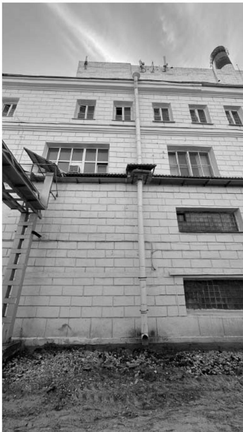
15. Вид с запада на объект культурного наследия (объект культурного наследия регионального значения «Котельная ТЭЦ-2» в составе объекта культурного наследия регионального значения «Петроградское общество электрических сооружений (ТЭЦ-2)»).
