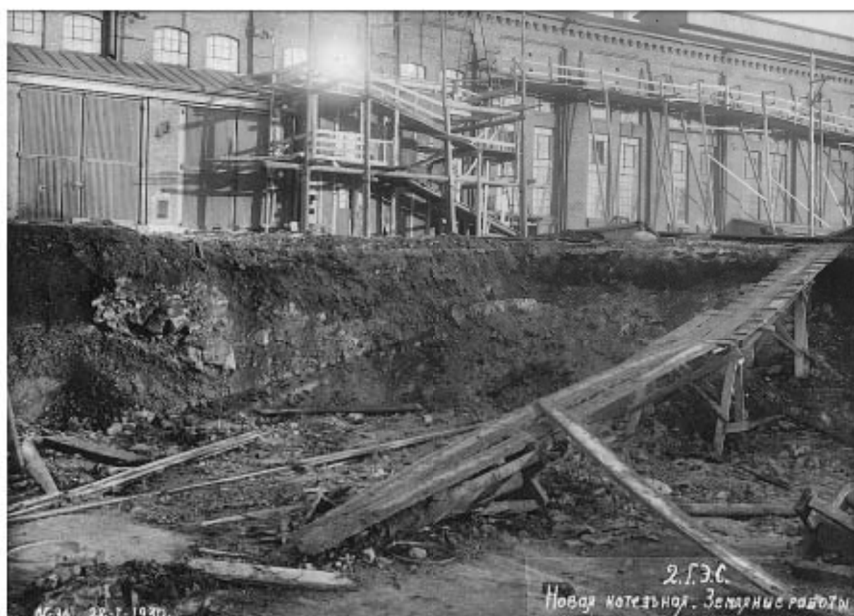
43. Строительство новой котельной 2-й ГЭС. Дата съемки: 28.01.1930 г. //
