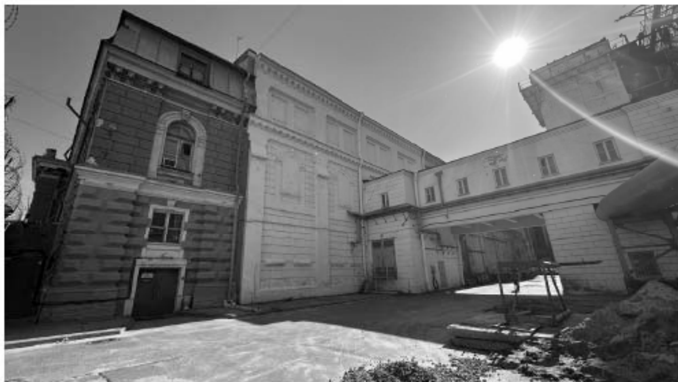
13. Вид с юга на объект культурного наследия (объект культурного наследия регионального значения «Административное здание и машинный зал» в составе объекта культурного наследия регионального значения «Петроградское общество электрических сооружений (ТЭЦ-2)»).
