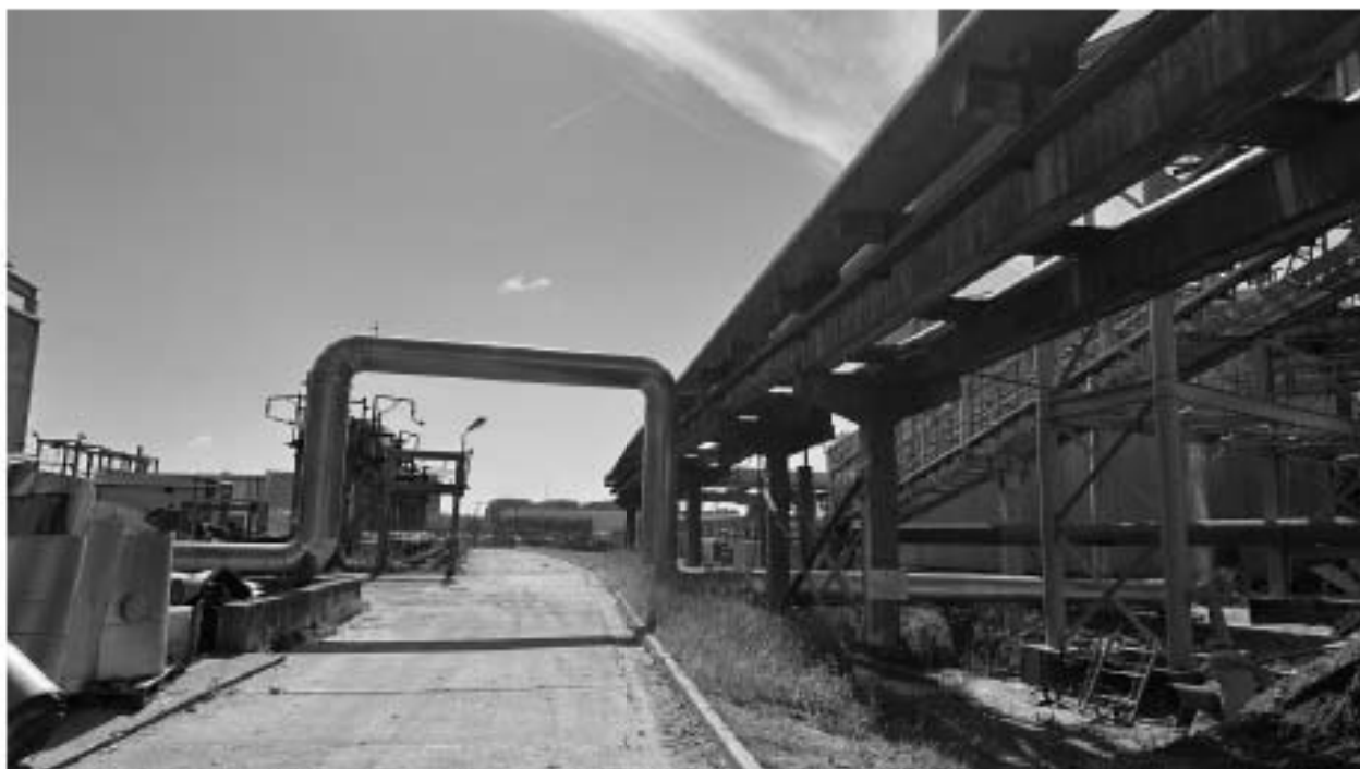
22. Вид на участок реализации проекта «Строительство здания администрации ЭС-2 Центральной ТЭЦ филиала «Невский» ПАО «ТГК-1».
