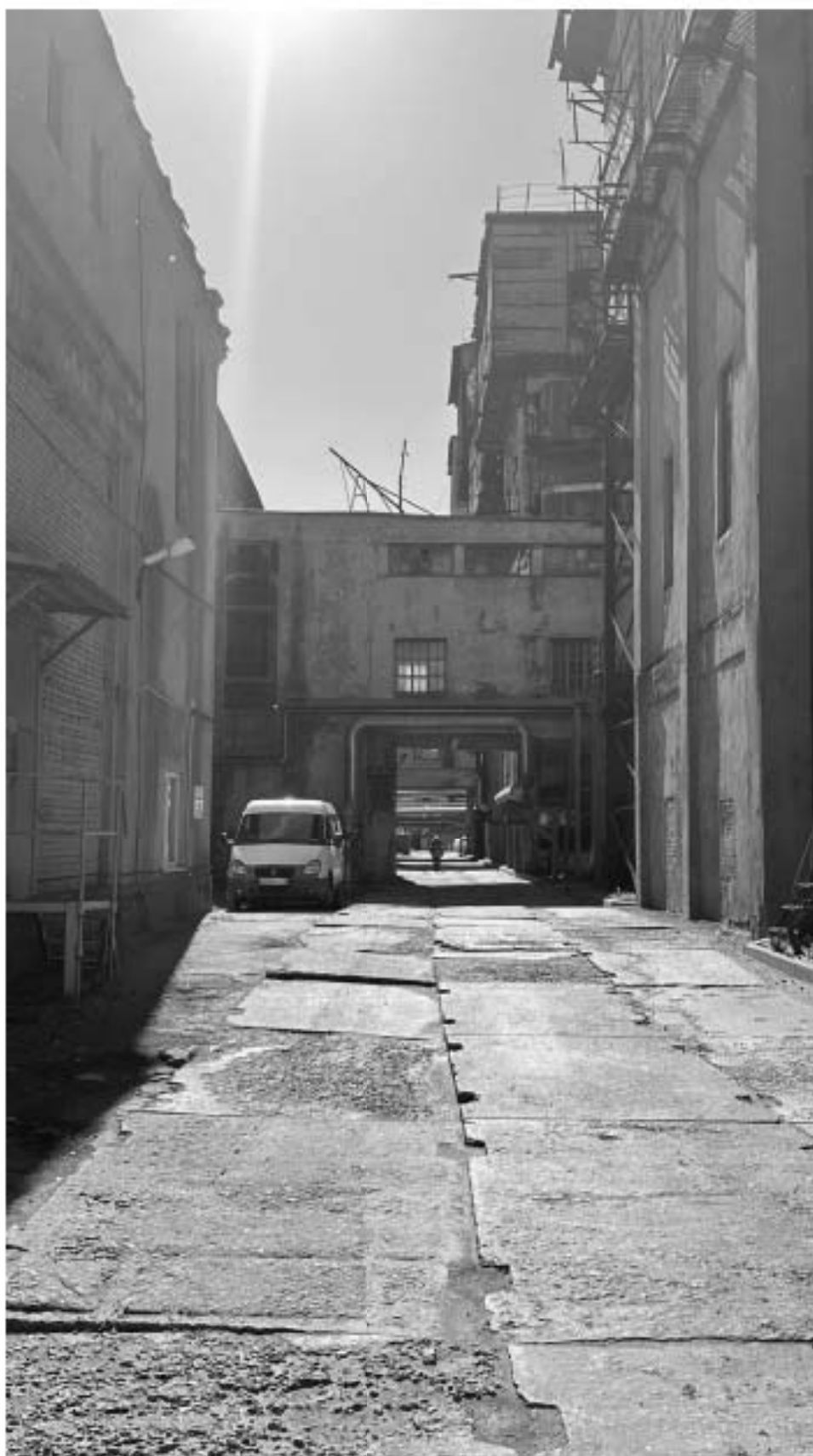
15. Вид с запада на переход между корпусами (объект культурного наследия регионального значения «Административное здание и машинный зал») и объект культурного наследия регионального значения «Котельная ТЭЦ-2» в составе объекта культурного наследия регионального значения «Петроградское общество электрических сооружений (ТЭЦ-2)»).
