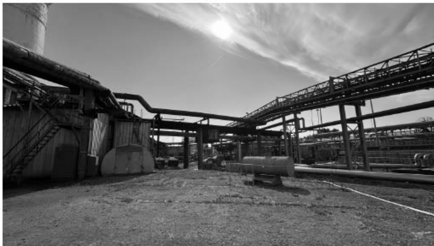
20. Вид на участок реализации проекта «Строительство здания администрации ЭС-2 Центральной ТЭЦ филиала «Невский» ПАО «ТГК-1».
