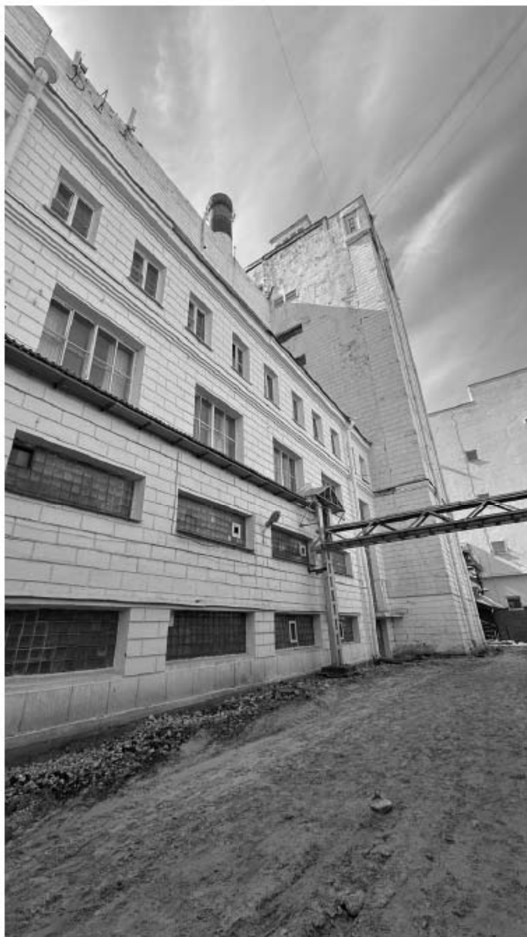
14. Вид с севера на объект культурного наследия (объект культурного наследия регионального значения «Котельная ТЭЦ-2» в составе объекта культурного наследия регионального значения «Петроградское общество электрических сооружений (ТЭЦ-2)»).
