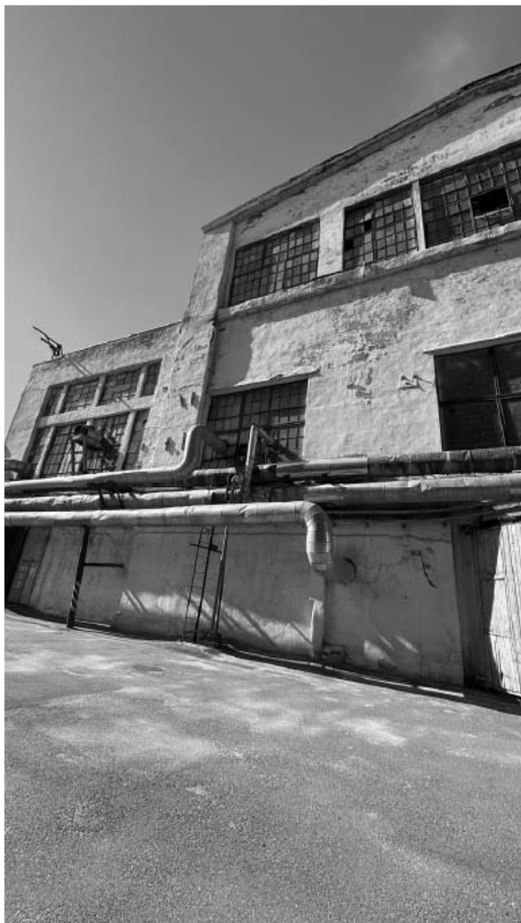
6. Северный фасад здания по адресу: Санкт-Петербург, Новгородская улица, дом 11, литера А.
