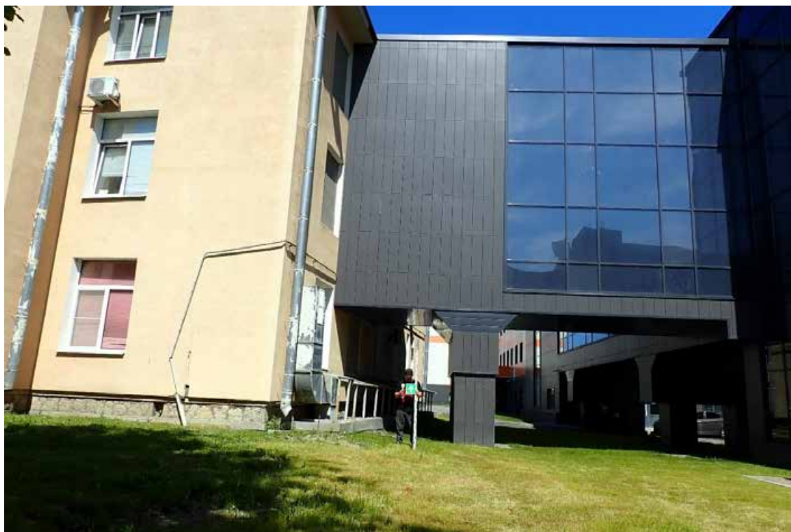
Рис. 24. Санкт-Петербург. Сестрорецк ул. Борисова, уч. 18. (к/н78:38:0011103:3216). Отвод реконструкции здания литеры Л, дома 9 ГБУЗ «Городская больница № 40. Точка фотофиксации 5. Общий вид юго-восточной части участка. Вид с Ю.
