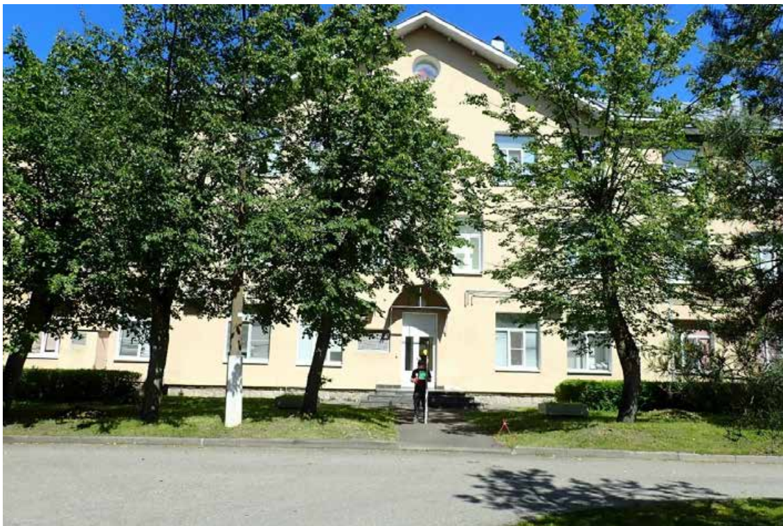
Рис. 26. Санкт-Петербург. Сестрорецк ул. Борисова, уч. 18. (к/н78:38:0011103:3216). Отвод реконструкции здания литеры Л, дома 9 ГБУЗ «Городская больница № 40. Точка фотофиксации 6. Общий вид южной части участка. Вид с Ю.
