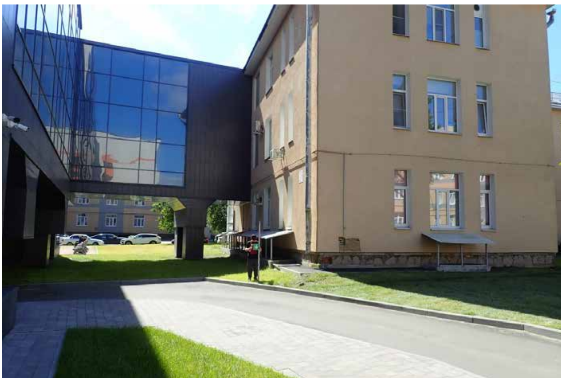
Рис. 21. Санкт-Петербург. Сестрорецк ул. Борисова, уч. 18. (к/н78:38:0011103:3216). Отвод реконструкции здания литеры Л, дома 9 ГБУЗ «Городская больница № 40. Точка фотофиксации 4. Общий вид северо-восточной части участка. Вид с 3.
