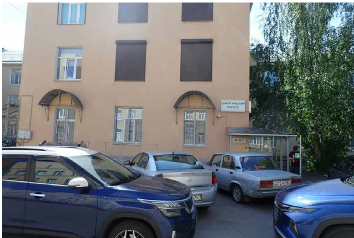
Рис. 18. Санкт-Петербург. Сестрорецк ул. Борисова, уч. 18. (к/н78:38:0011103:3216). Отвод реконструкции здания литеры Л, дома 9 ГБУЗ «Городская больница № 40. Точка фотофиксации 3. Общий вид северной части участка. Вид с С.
