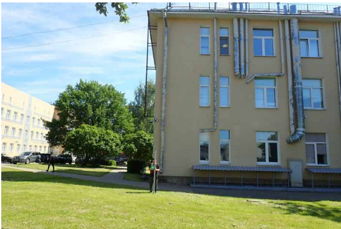
Рис. 16. Санкт-Петербург. Сестрорецк ул. Борисова, уч. 18. (к/н78:38:0011103:3216). Отвод реконструкции здания литеры Л, дома 9 ГБУЗ «Городская больница № 40. Точка фотофиксации 2. Общий вид северо-западной части участка. Вид с В.
