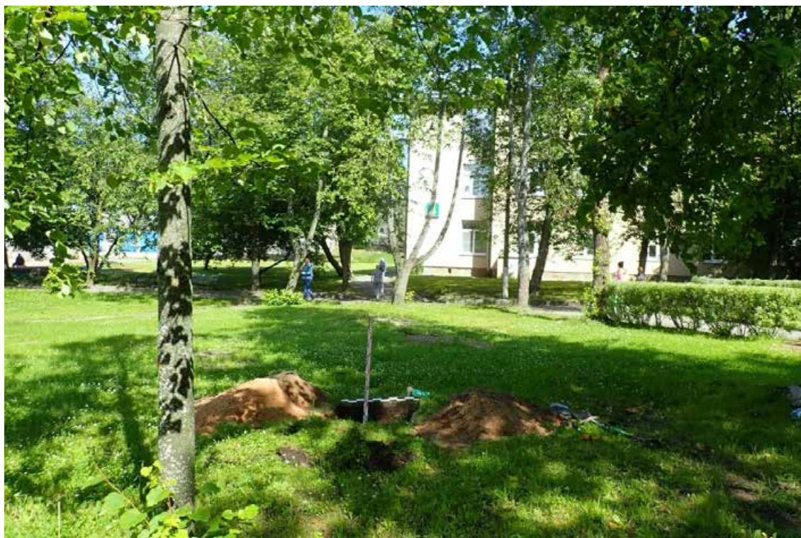
Рис. 19. Санкт-Петербург. Сестрорецк ул. Борисова, уч. 18. (к/н78:38:0011103:3216). Отвод реконструкции здания литеры Л, дома 9 ГБУЗ «Городская больница № 40. Шурф 1. Выкопанный шурф с включением окружающего пейзажа. Вид с Ю.
