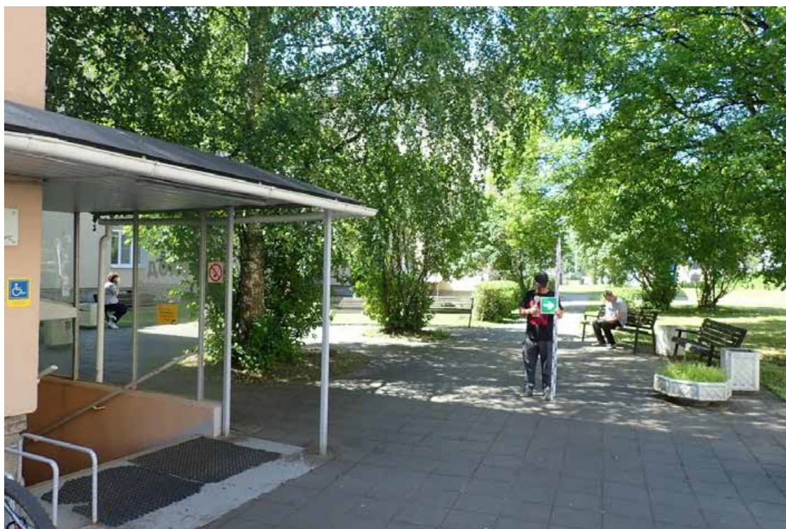
Рис. 19. Санкт-Петербург. Сестрорецк ул. Борисова, уч. 18. (к/н78:38:0011103:3216). Отвод реконструкции здания литеры Л, дома 9 ГБУЗ «Городская больница № 40. Точка фотофиксации 3. Общий вид северной части участка. Вид с В.
