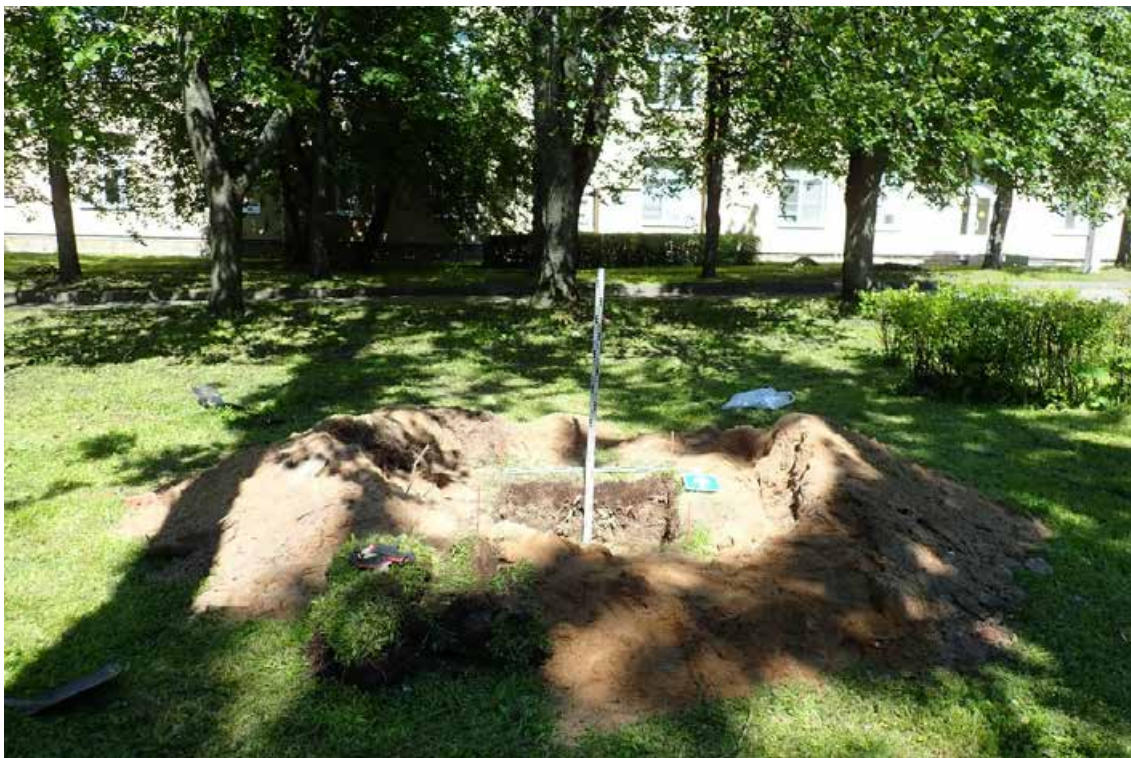
Рис. 39. Санкт-Петербург. Сестрорецк ул. Борисова, уч. 18. (к/н78:38:0011103:3216). Отвод реконструкции здания литеры Л, дома 9 ГБУЗ «Городская больница № 40. Шурф 2. Выкопанный шурф с включением окружающего пейзажа. Вид с Ю.
