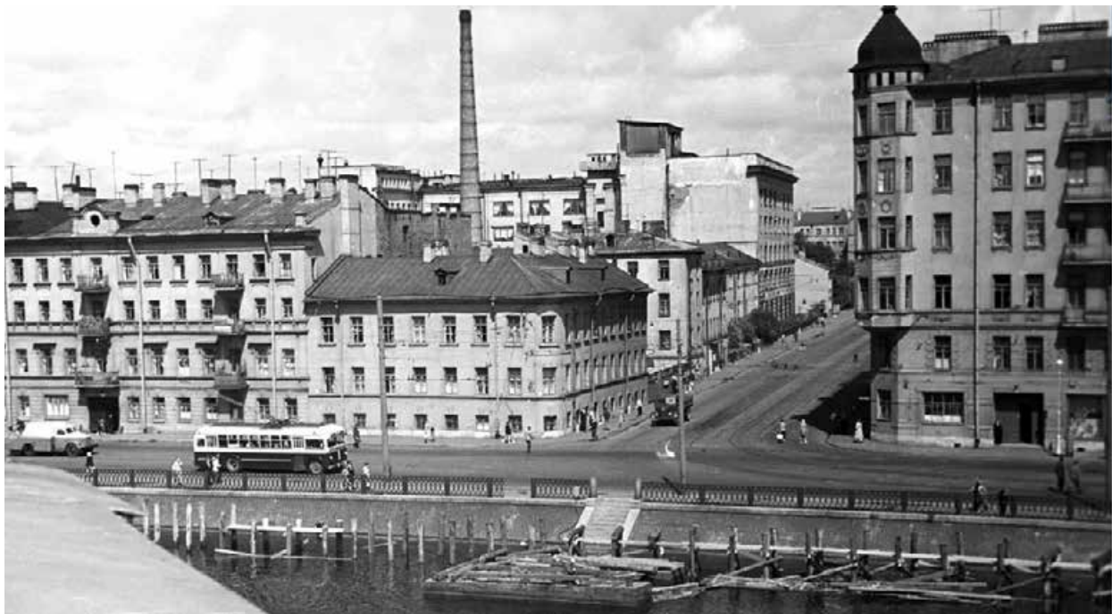
Илл.53 Ждановская набережная, начало реконструкции. 1962 год. [Электронный ресурс]: URL: //https://pastvu.com/p/514962
