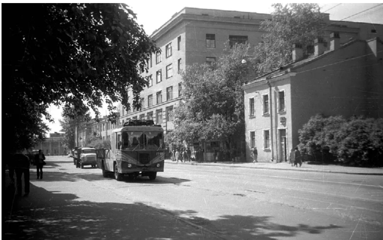
Илл. 54. Вид на дом 4 по Малому проспекту с северо-востока. 1987год. [Электронный ресурс]: URL: // https://pastvu.com/p/515130
