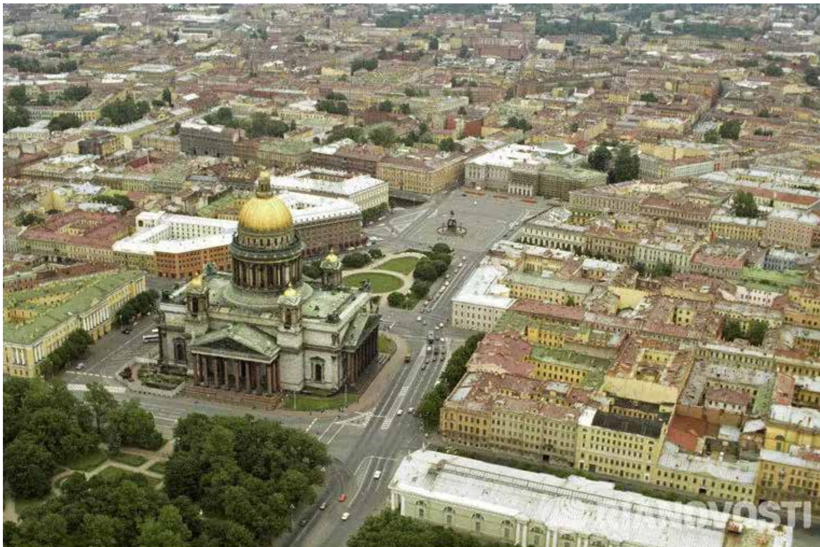
48. Вид на Исаакиевский собор. Фотография. Автор фото – Борис Бабанов. 1996 г. // Источник: https://pastvu.com/p/745037 (дата обращения 06.12.2024).
