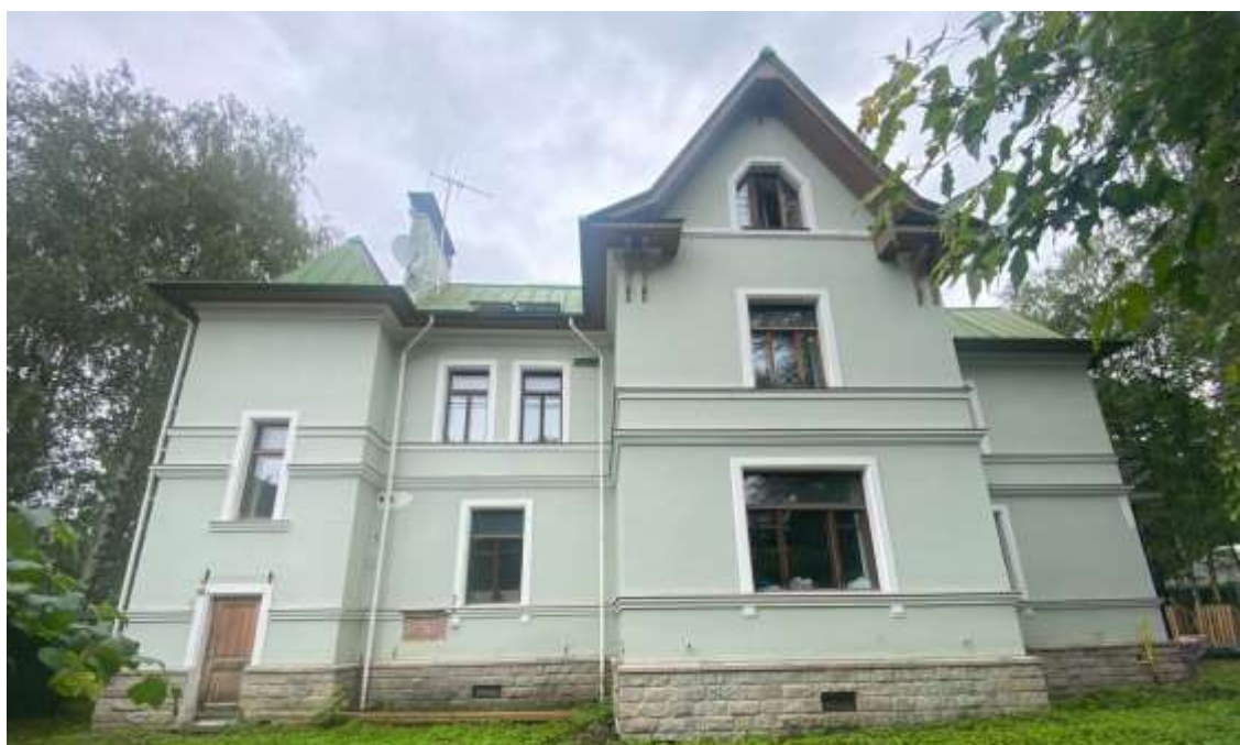
Фото 5. Общий вид здания (южный фасад), расположенного по адресу: г. Санкт-Петербург, Санаторная аллея, д. 4, литера А
