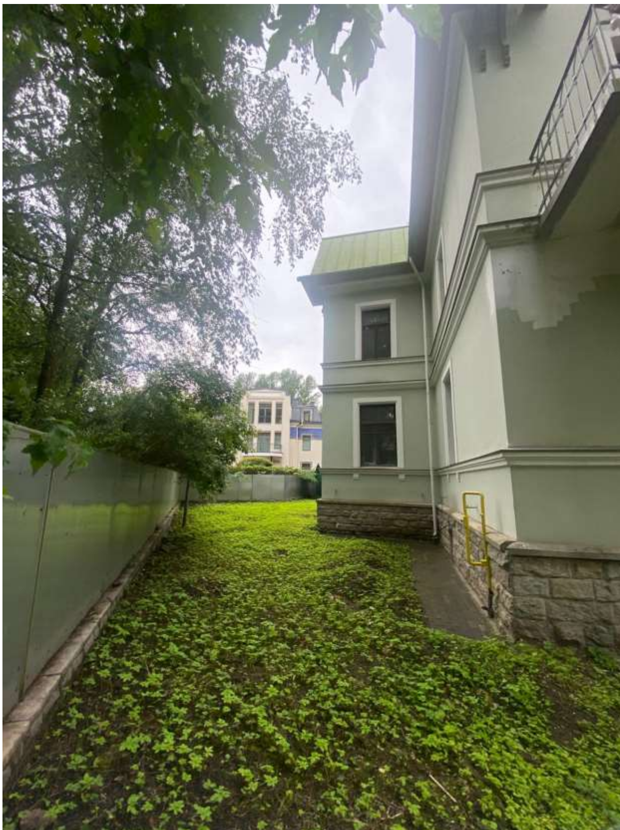
Фото 12. Общий вид на часть здания (южный фасад), расположенного по адресу: г. Санкт-Петербург, Санаторная аллея, д. 4, литера А
