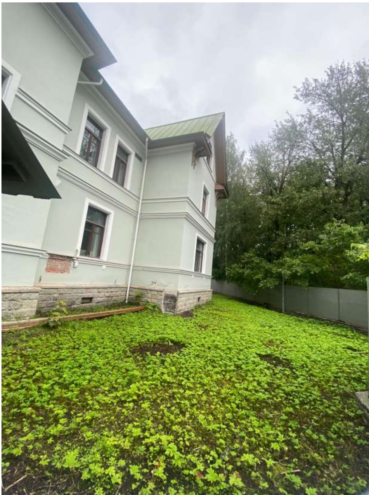
Фото 11. Общий вид на часть здания (южный фасад), расположенного по адресу: г. Санкт-Петербург, Санаторная аллея, д. 4, литера А
