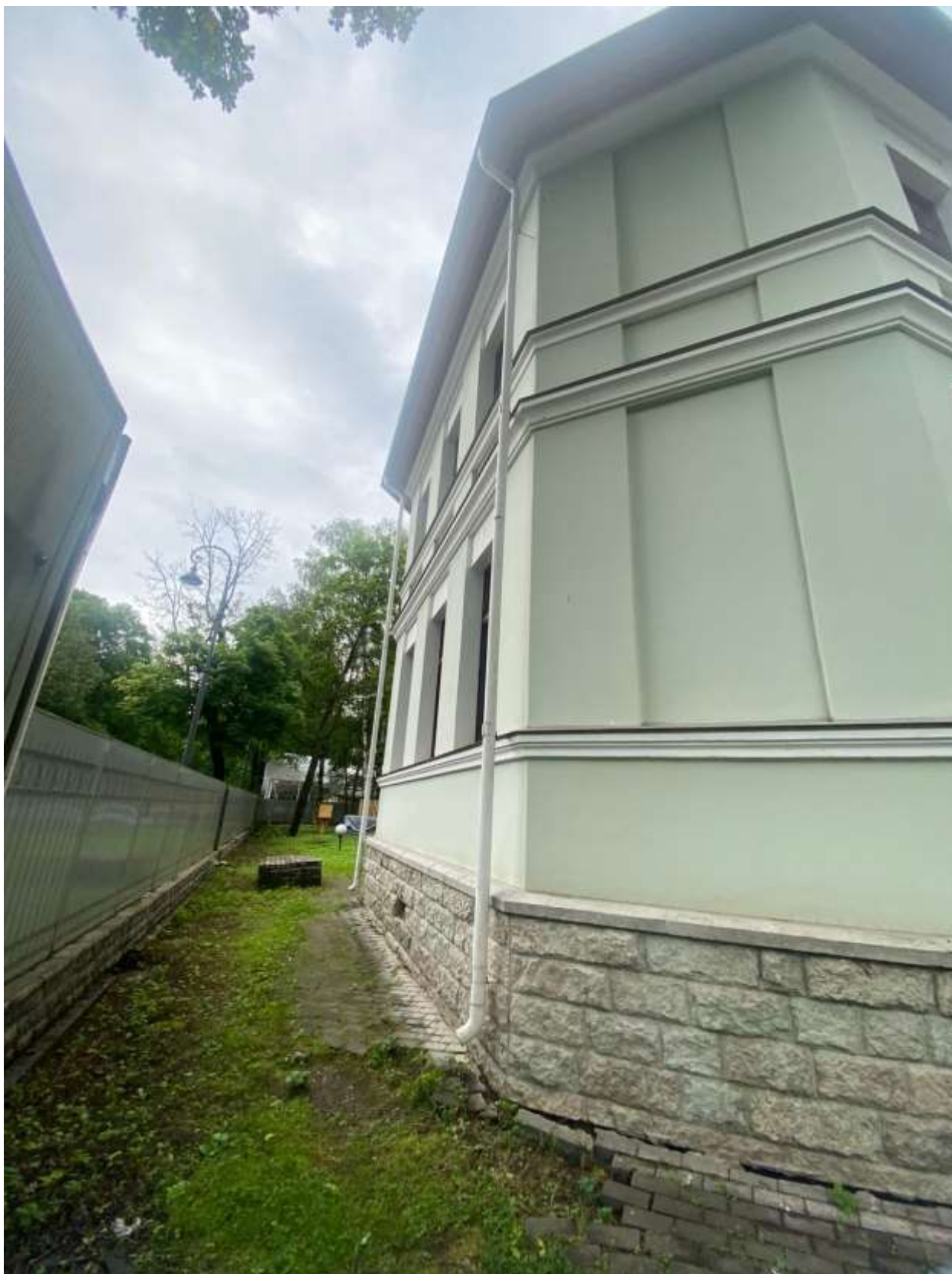
Фото 13. Общий вид на часть здания (северо-западный фасад), расположенного по адресу: г. Санкт-Петербург, Санаторная аллея, д. 4, литера А
