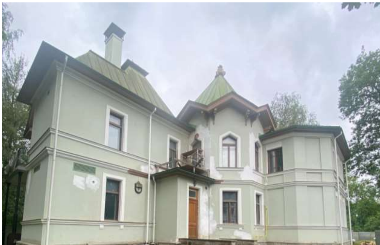
Фото 2. Общий вид здания (северо-восточный фасад), расположенного по адресу: г. Санкт-Петербург, Санаторная аллея, д. 4, литера А
