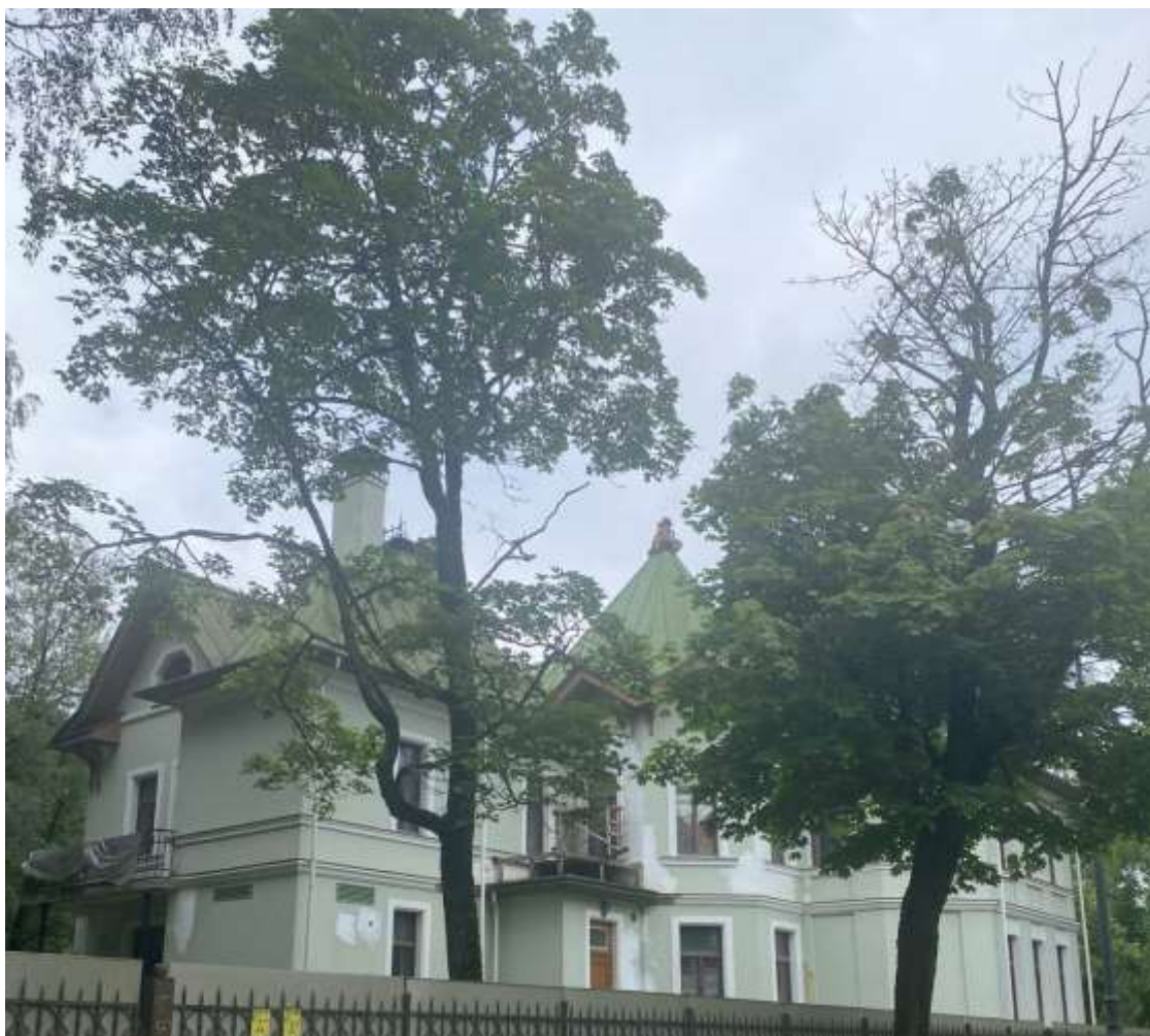
Фото 4. Общий вид здания (северо-восточный фасад), расположенного по адресу: г. Санкт-Петербург, Санаторная аллея, д. 4, литера А
