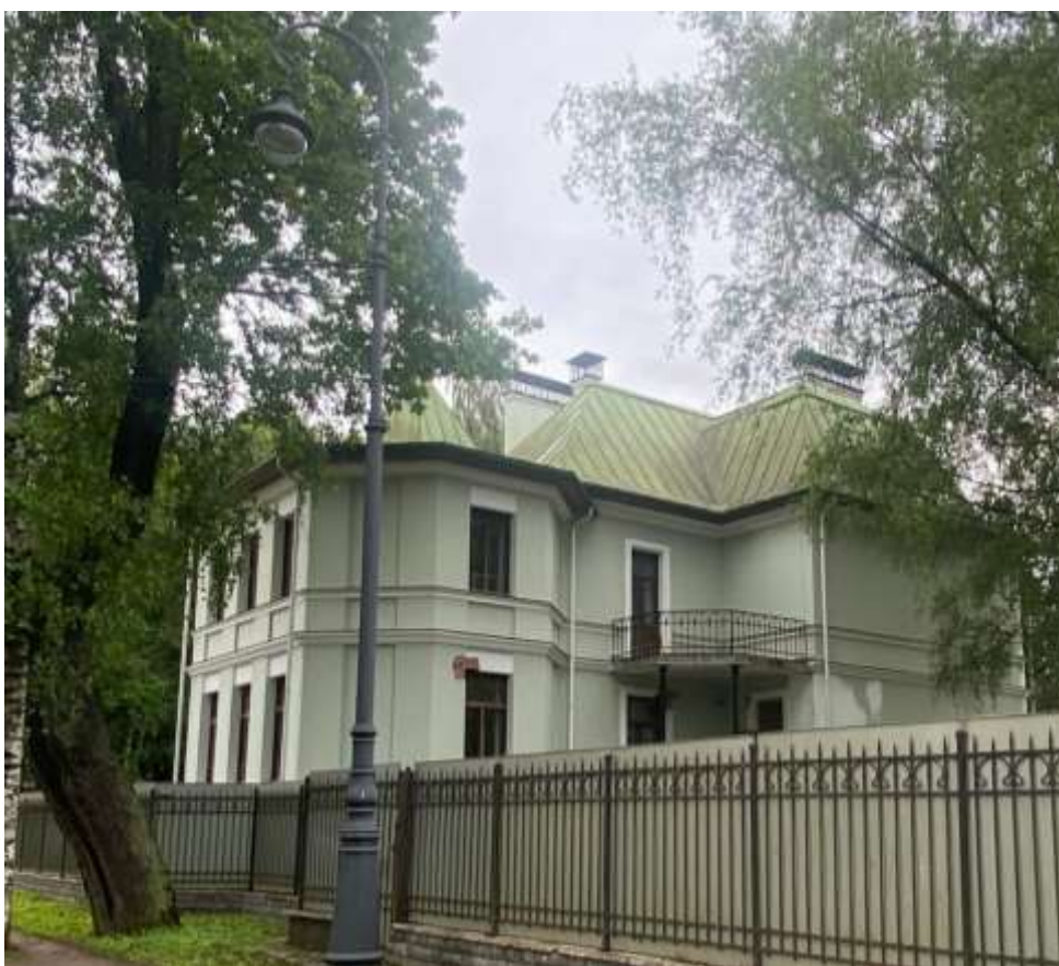
Фото 7. Общий вид здания (северо-западный фасад), расположенного по адресу: г. Санкт-Петербург, Санаторная аллея, д. 4, литера А
