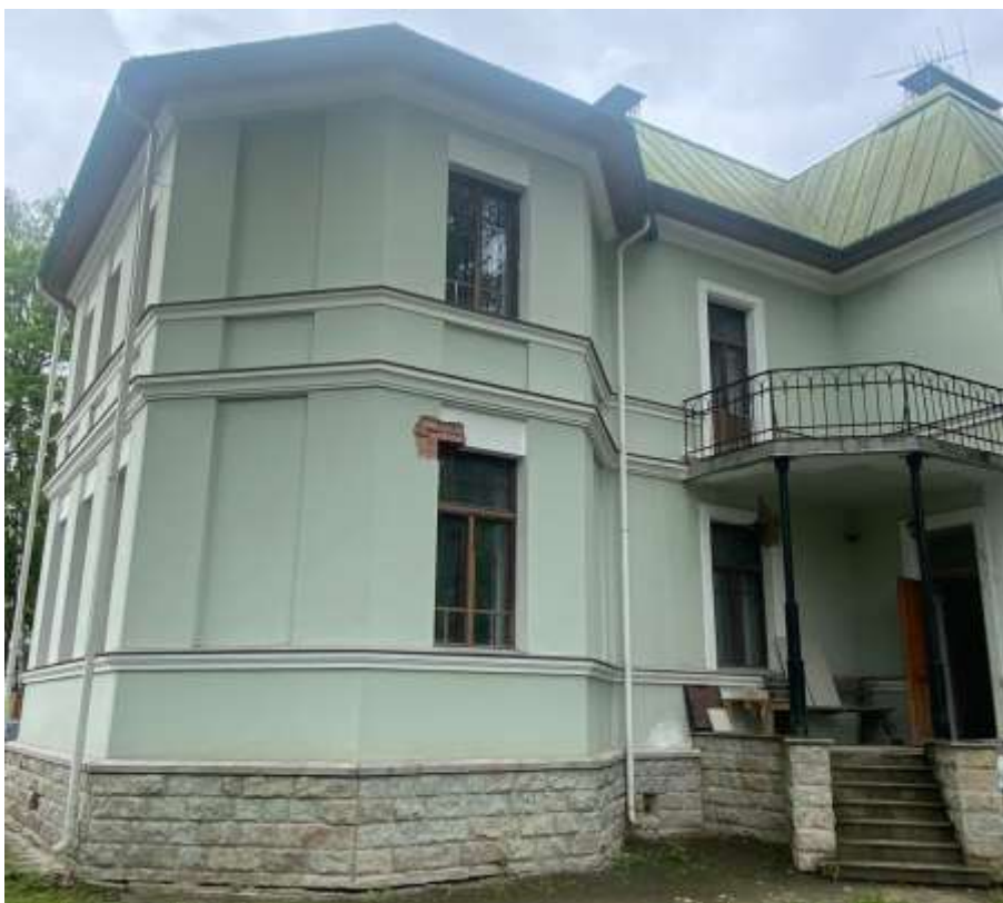
Фото 6. Общий вид здания (северо-западный фасад), расположенного по адресу: г. Санкт-Петербург, Санаторная аллея, д. 4, литера А
