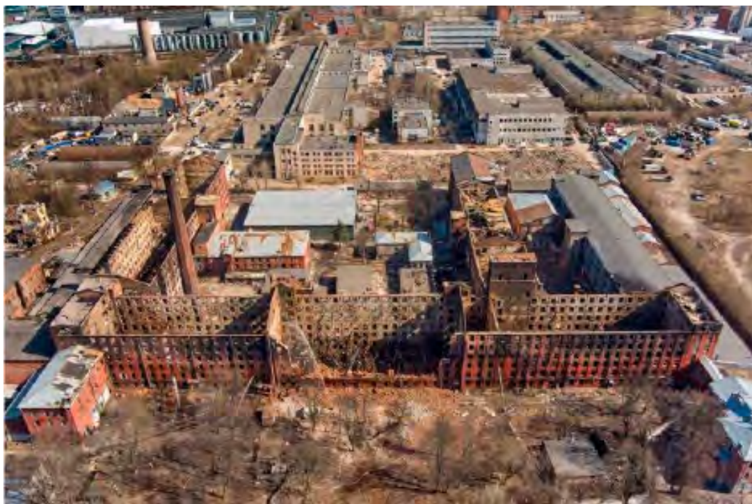
Илл.10. Общий вид объекта культурного наследия после пожара Апрель 2021 г. Интернет-ресурс: https://www.fontanka.ru/
