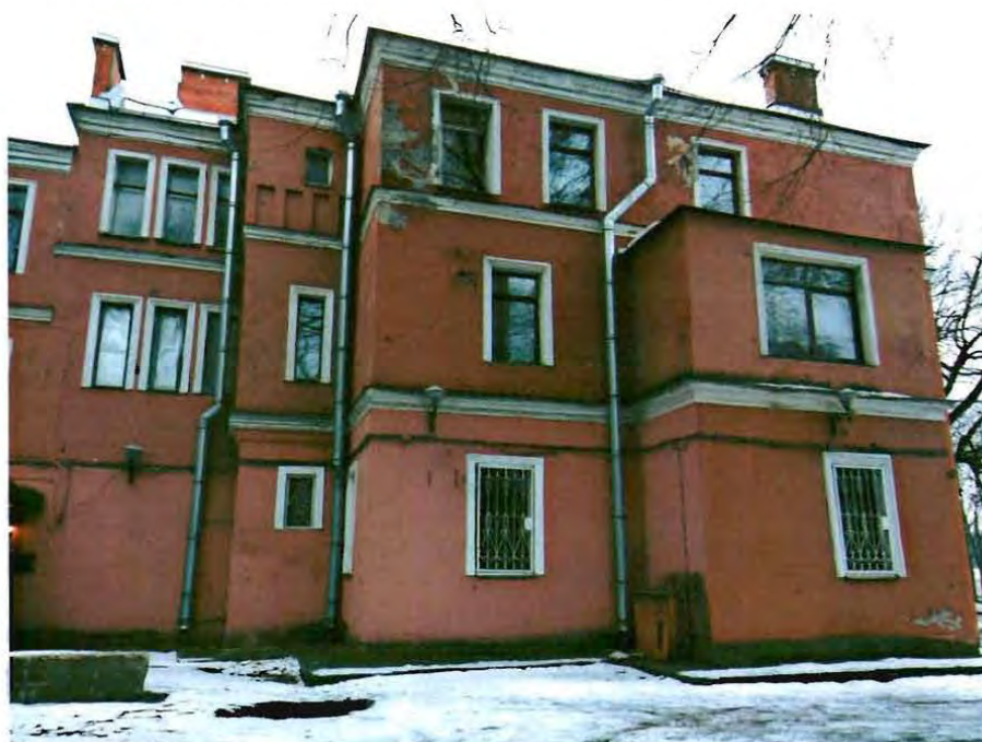
3. Вид на северный фасад. Фрагмент.
