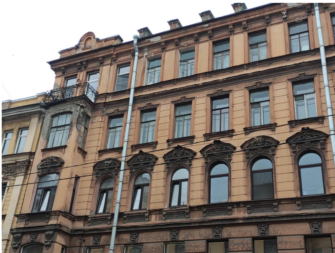
Фото 2. Фрагмент лицевого фасада выявленного объекта культурного наследия «Дом А.Г.Романова», оконные заполнения квартиры
