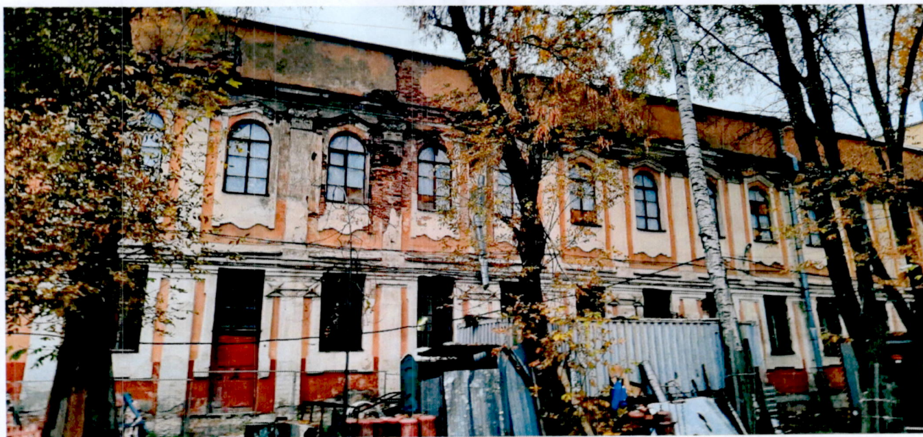
17. Фрагмент дворового фасада.
