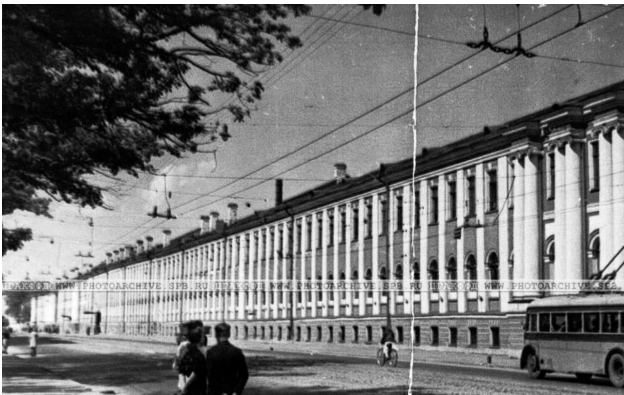
Илл. 9. Фасад здания Военно-политического училища им. Ф. Энгельса на Съездовской линии (б. Первый Кадетский корпус). Фотография. 1947 г. Приведено на: https://www.citywalls.ru/
