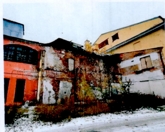
16. Фрагмент дворового фасада.
