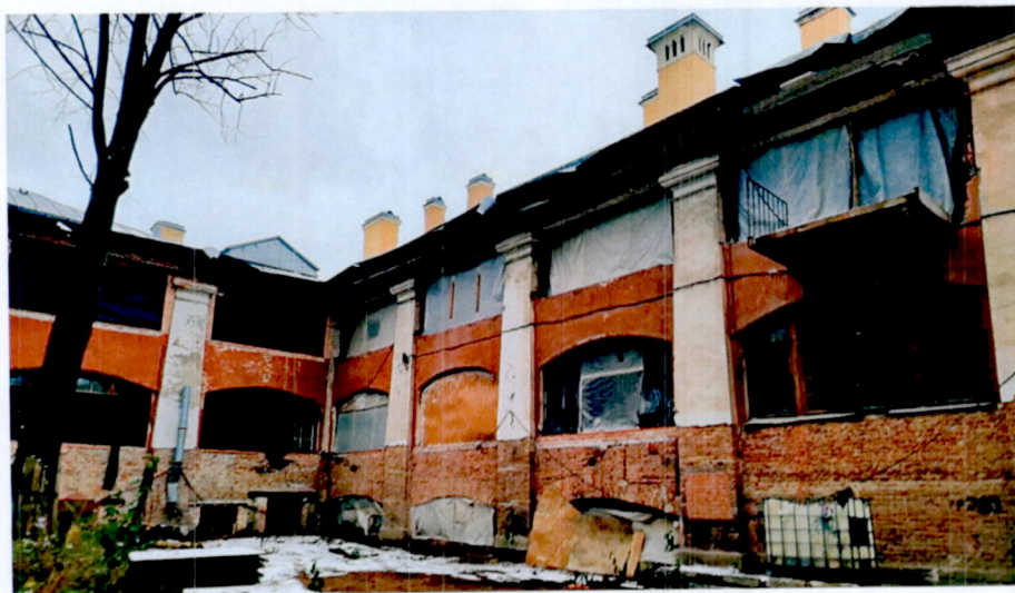
18. Фрагмент дворового фасада.
