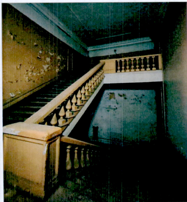
25. Лестница с ограждением в виде балясин.
