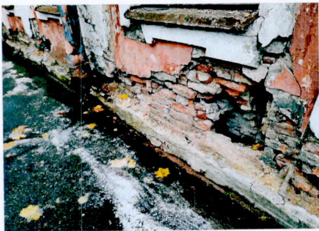
13. Фрагмент восточного фасада.
