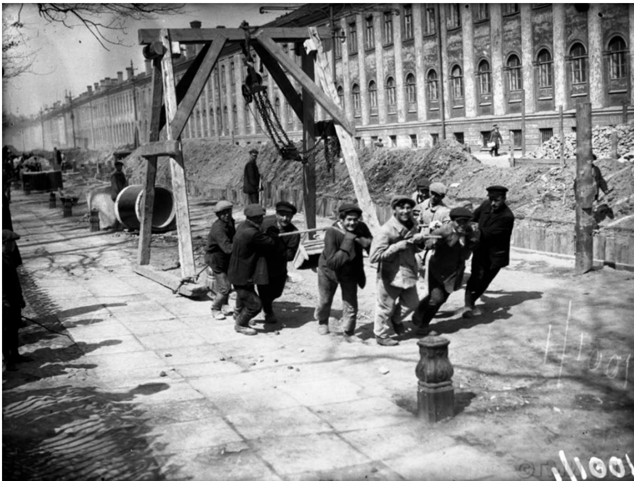
Илл.7. Первый Кадетский корпус. Вид со стороны Съездовской (Кадетской) линии. Канализационные работы на Съездовской линии. Фотография 1930 – 1935 гг. Приведено на: https://www.citywalls.ru/
