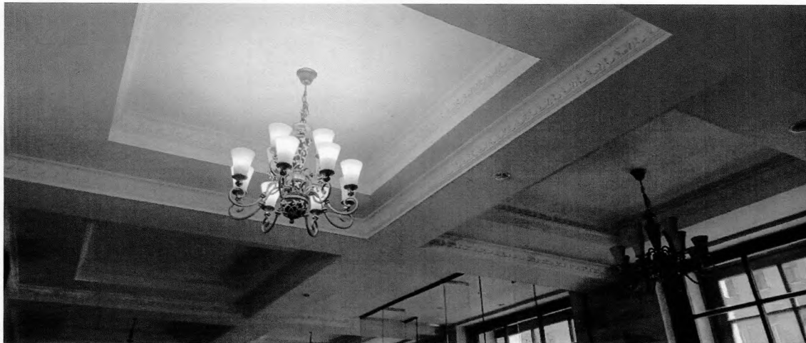
50. Оформление потолка вестибюля парадного входа
