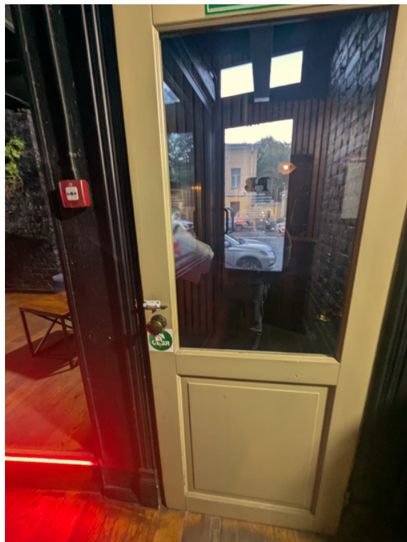
Фото 12. Помещение 46-Н. Объект культурного наследия регионального значения «Здание Шереметьевского Пассажа» расположенный по адресу: Центральный район, Литейный проспект, дом 53, литера А.
