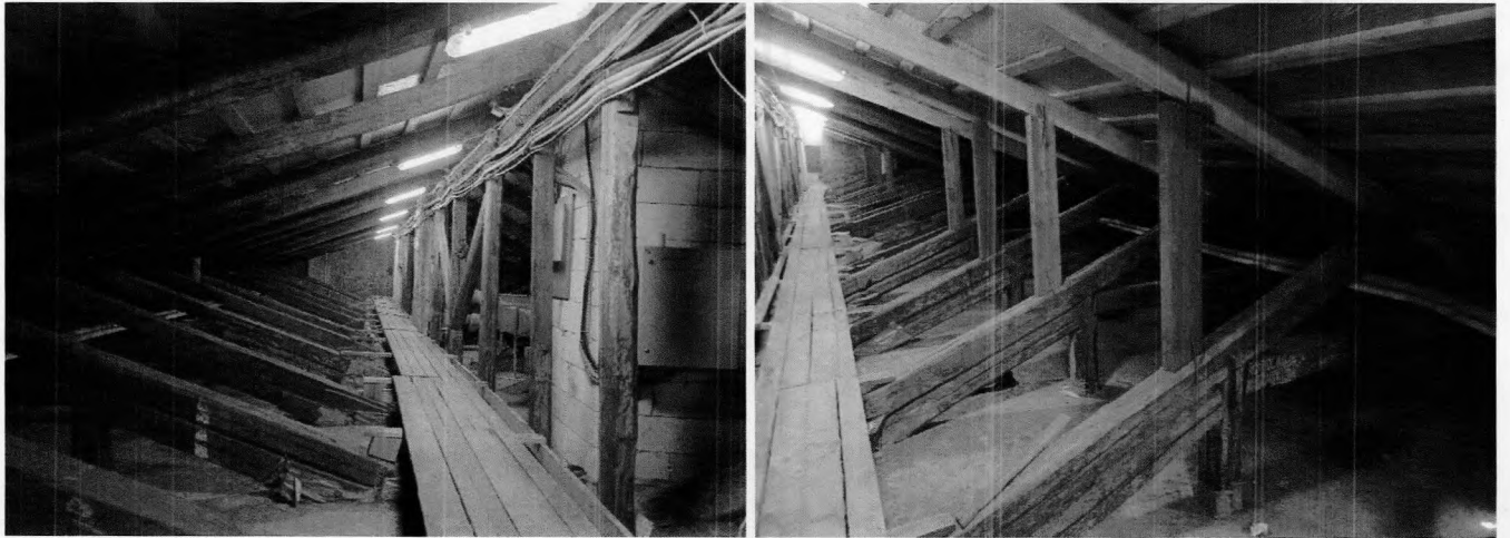
45, 46. Стропильная система
