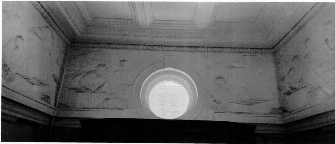
60. Декоративное оформление вестибюля лестницы 2-ЛК
