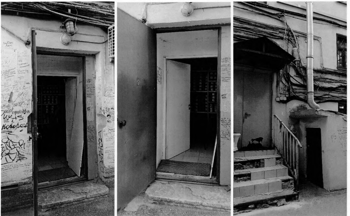
42, 43, 44. Крыльца входов со стороны дворового фасада
