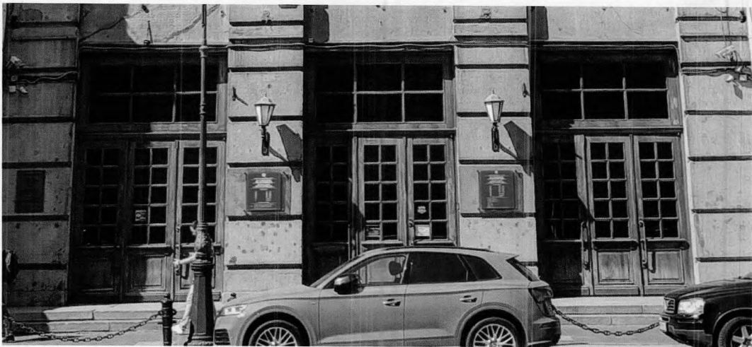
11. Дверные заполнения парадного входа
