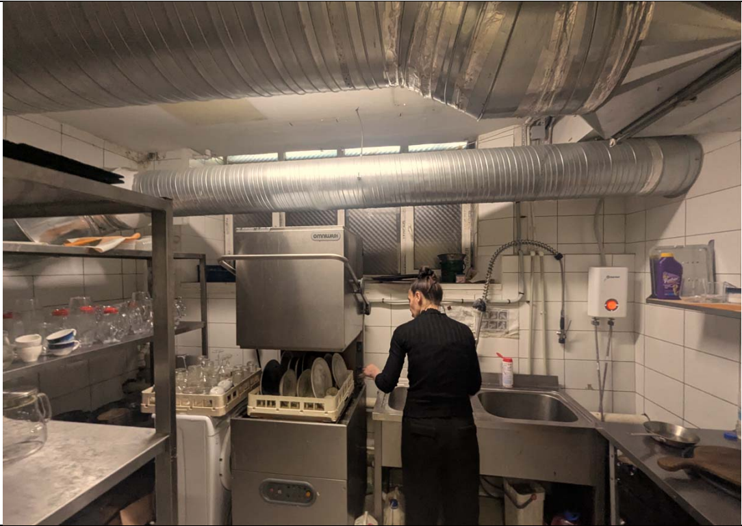
Фото 47. Помещение 48-Н подвал. Объект культурного наследия регионального значения «Здание Шереметьевского Пассажа» расположенный по адресу: Центральный район, Литей-ный проспект, дом 53, литера А.
