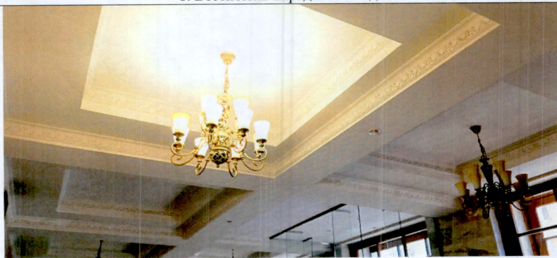
9. Оформление потолка вестибюля парадного входа
