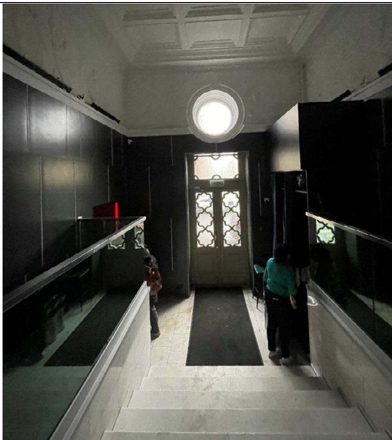
Фото 17. Помещение 41-Н. Объект культурного наследия регионального значения «Здание Шереметьевского Пассажа» расположенный по адресу: Центральный район, Литейный проспект, дом 53, литера А.
