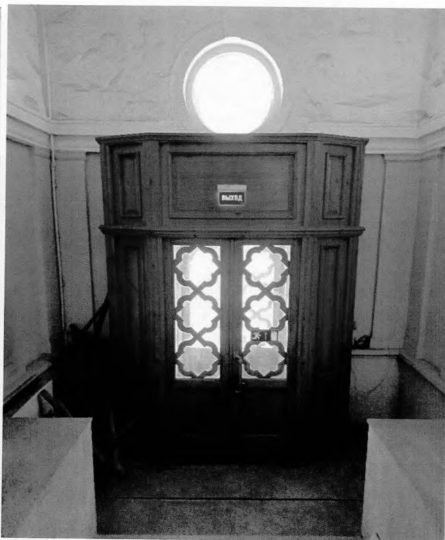
63. Тамбур в вестибюле лестницы 2-ЛК
