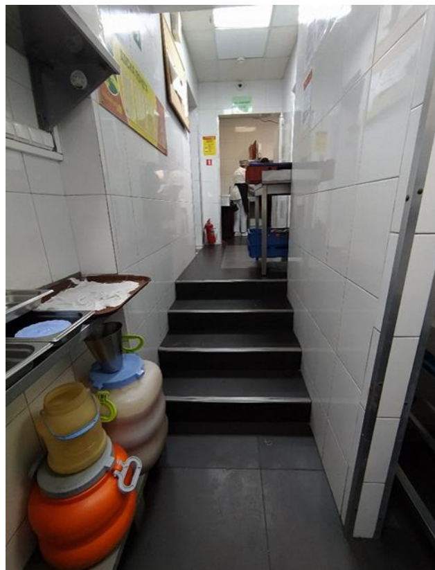
Фото 20. Вид на лестницу в створе дверного проёма, ведущую в кухонную зону (проём № 7 на плане перепланировки).
