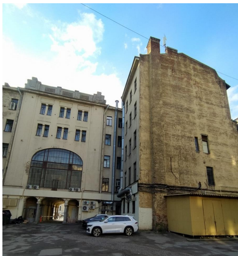
Фото 6. Вид на часть дворового фасада лицевого корпуса и торцевую стену южного ризалита
