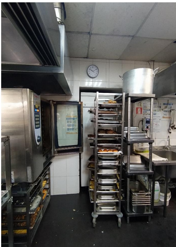
Фото 25. Вид на нишу в помещении № 13(в помещении кухни).
