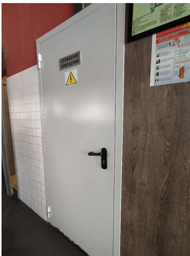
Фото 18. Вход в помещения № 7 и № 8 (коридор и электрощитовая)
