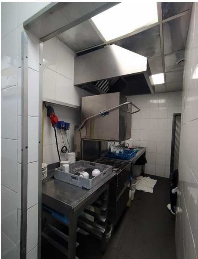
Фото 19. Вид на помещение № 10 (моечная)
