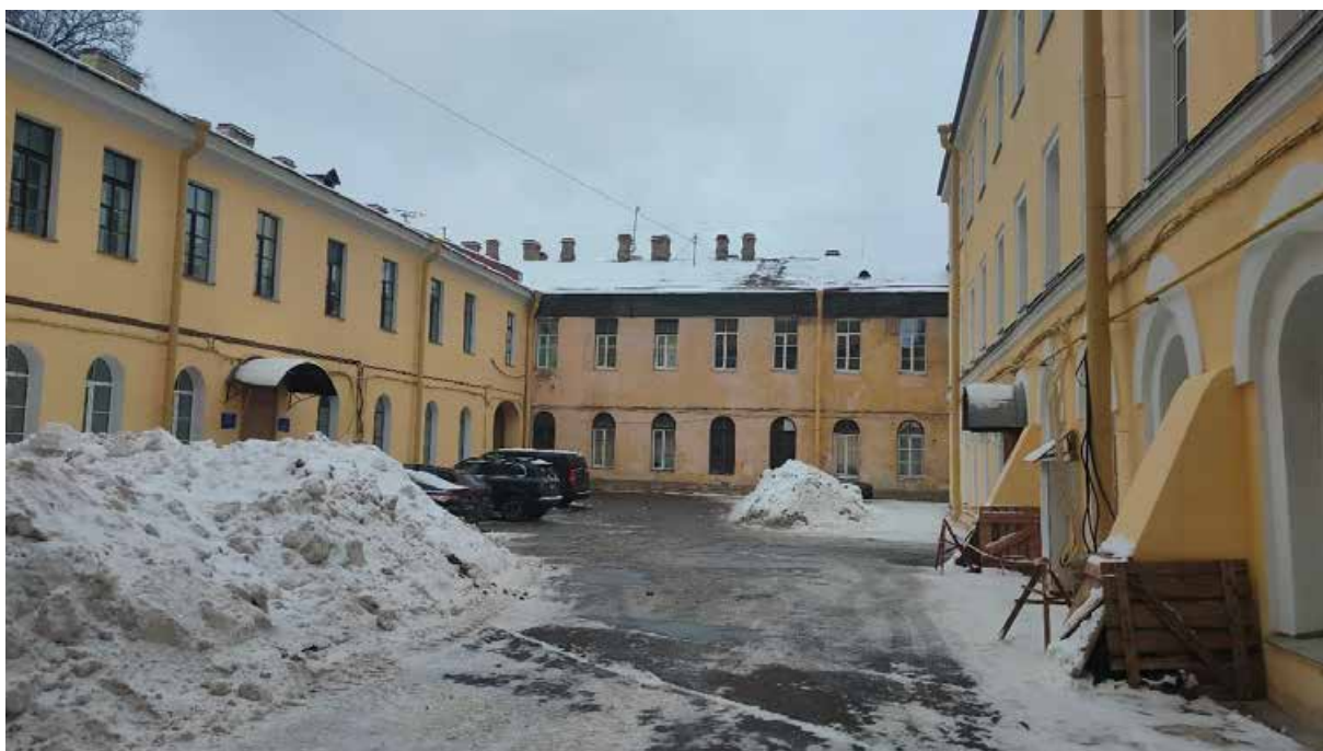
Фото 39. Дворовое пространство объекта культурного наследия федерального значения
