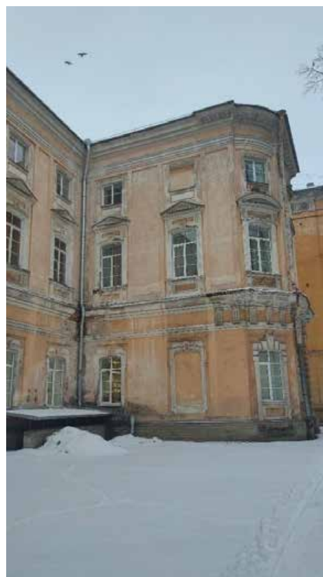
Фото 10. Фрагмент юго-восточного фасада объекта культурного наследия федерального значения «Дворец Разумовского К.Г. Никольский сиротский институт», входящего в состав объекта культурного наследия федерального значения «Воспитательный дом Императорский», расположенный по адресу: Санкт-Петербург, наб. р. Мойки, д. 48, лит. А,
