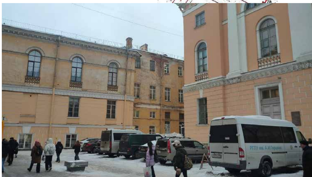
Фото 19. Фрагмент юго-восточного фасада объекта культурного наследия федерального значения «Дворец Разумовского К.Г. Никольский сиротский институт», входящего в состав объекта культурного наследия федерального значения «Воспитательный дом Императорский», расположенный по адресу: Санкт-Петербург, наб. р. Мойки, д. 48, лит. А, корп. 5
