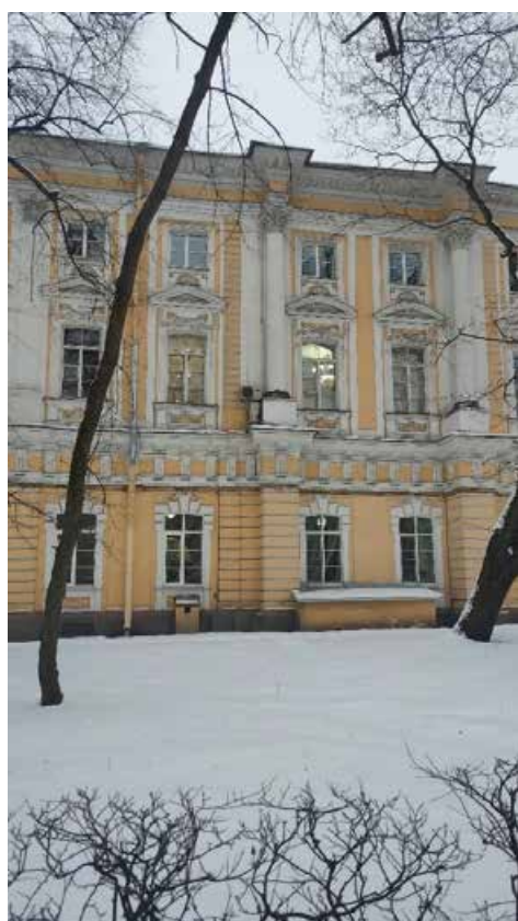
Фото 35. Фрагмент северо-западного фасада объекта культурного наследия федерального значения «Дворец Разумовского К.Г. Никольский сиротский институт», входящего в состав объекта культурного наследия федерального значения «Воспитательный дом
