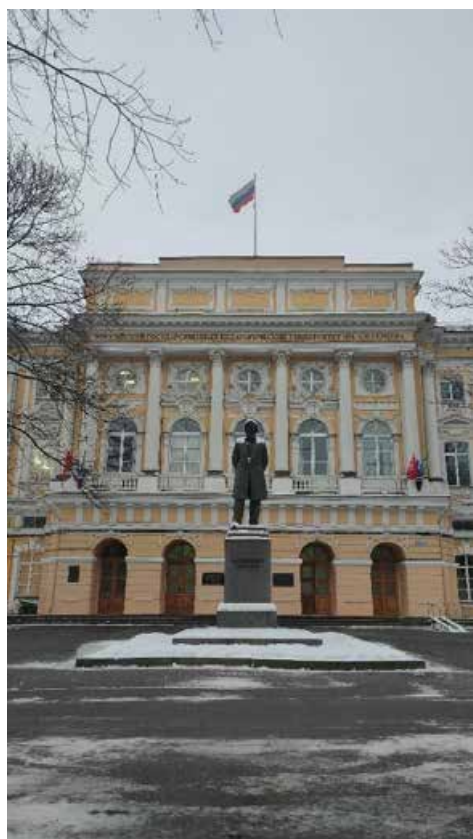
Фото 31. Вид на ризалит, фрагмент северо-западного фасада объекта культурного наследия федерального значения «Дворец Разумовского К.Г. Никольский сиротский институт», входящего в состав объекта культурного наследия федерального значения «Воспитательный дом Императорский», расположенный по адресу: Санкт-Петербург, наб. р. Мойки, д. 48, лит. А,
