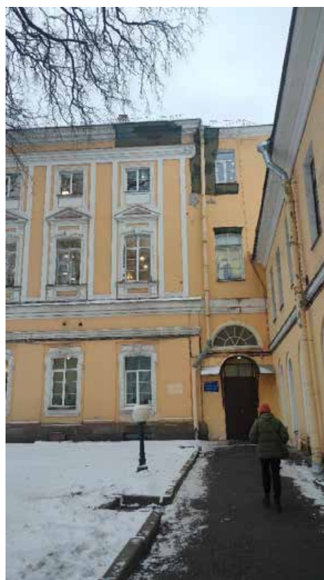
Фото 34. Фрагмент северо-западного фасада объекта культурного наследия федерального значения «Дворец Разумовского К.Г. Никольский сиротский институт», входящего в состав объекта культурного наследия федерального значения «Воспитательный дом Императорский»,
