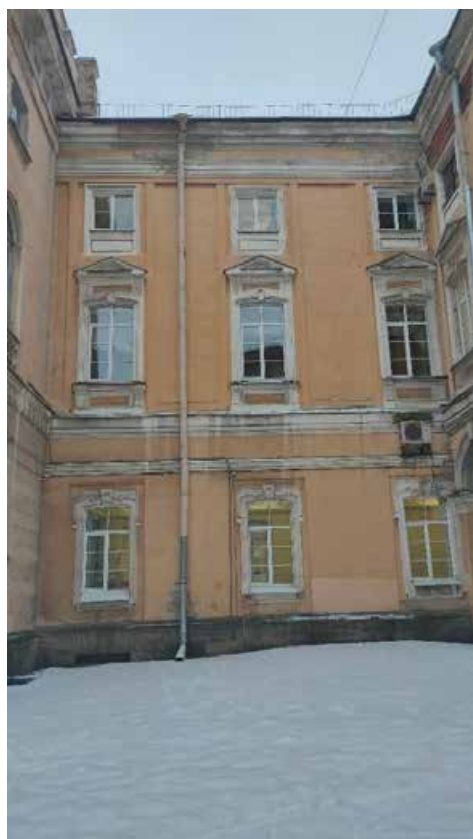
Фото 15. Вид в сторону юга. Фрагмент юго-восточного фасада объекта культурного наследия федерального значения «Дворец Разумовского К.Г. Никольский сиротский институт», входящего в состав объекта культурного наследия федерального значения «Воспитательный дом Императорский», расположенный по адресу: Санкт-Петербург, наб. р. Мойки, д. 48, лит. А,
