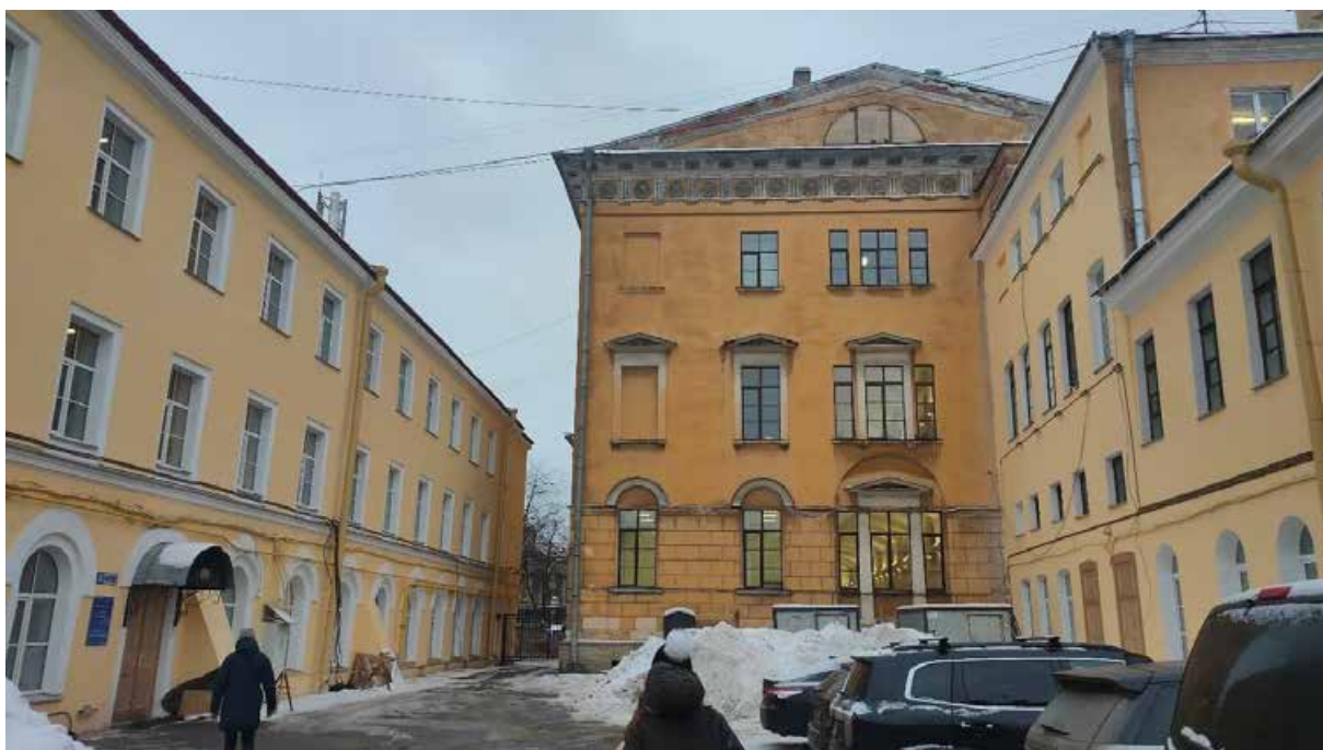
Фото 38. Дворовое пространство объекта культурного наследия федерального значения
