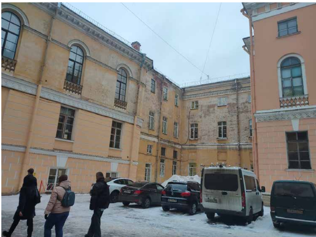
Фото 21. Фрагмент юго-восточного фасада объекта культурного наследия федерального значения «Дворец Разумовского К.Г. Никольский сиротский институт», входящего в состав объекта культурного наследия федерального значения «Воспитательный дом Императорский», расположенный по адресу: Санкт-Петербург, наб. р. Мойки, д. 48, лит. А, корп. 5
