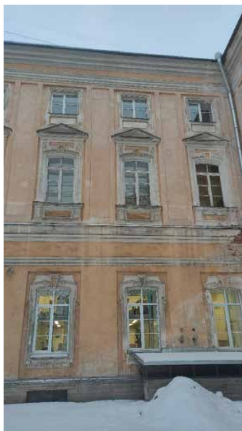
Фото 9. Фрагмент юго-восточного фасада объекта культурного наследия федерального значения «Дворец Разумовского К.Г. Никольский сиротский институт», входящего в состав объекта культурного наследия федерального значения «Воспитательный дом Императорский», расположенный по адресу: Санкт-Петербург, наб. р. Мойки, д. 48, лит. А, корп. 5
