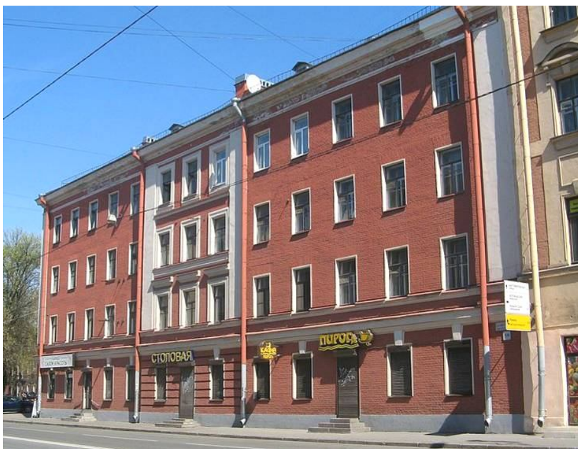
Илл.15. Вид на лицевой фасад дома по Большому Сампсониевскому пр. № 59. 2016 г. Источник – сайт wikivoyage.org .
