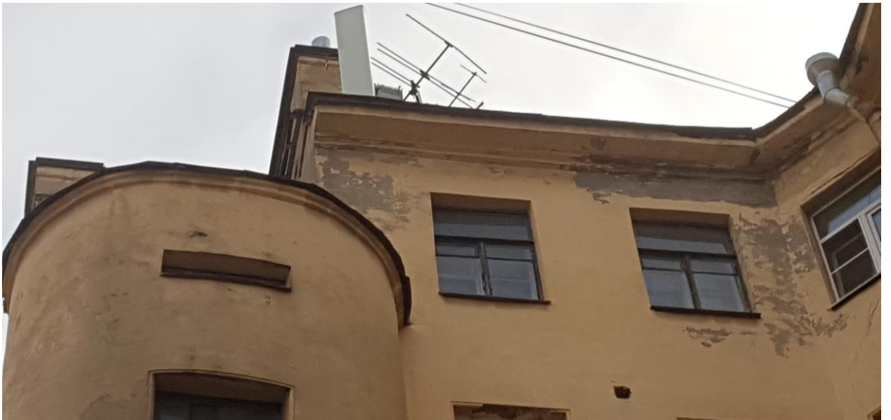
Фото 42. Карнизы фасадов во втором дворе.
