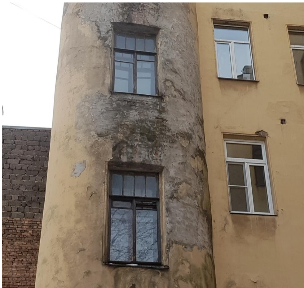
Фото 40. Оконные проемы в уровне 3 и 4-го этажей в ризалите. Второй двор.
