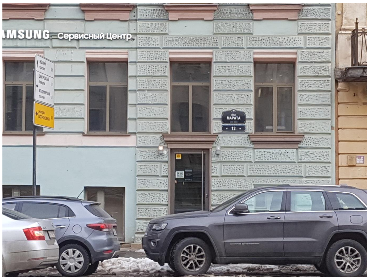
Фото 7. Оформление оконных проемов в уровне 2-го этажа.
