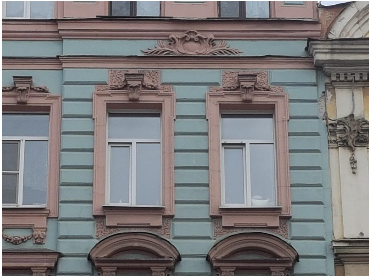
Фото 4. Оформление оконных проемов в уровне 5-го этажа.
