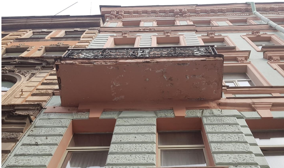
Фото 9. Балкон в уровне 5-го этажа по левой оси фасада. Вид снизу.
