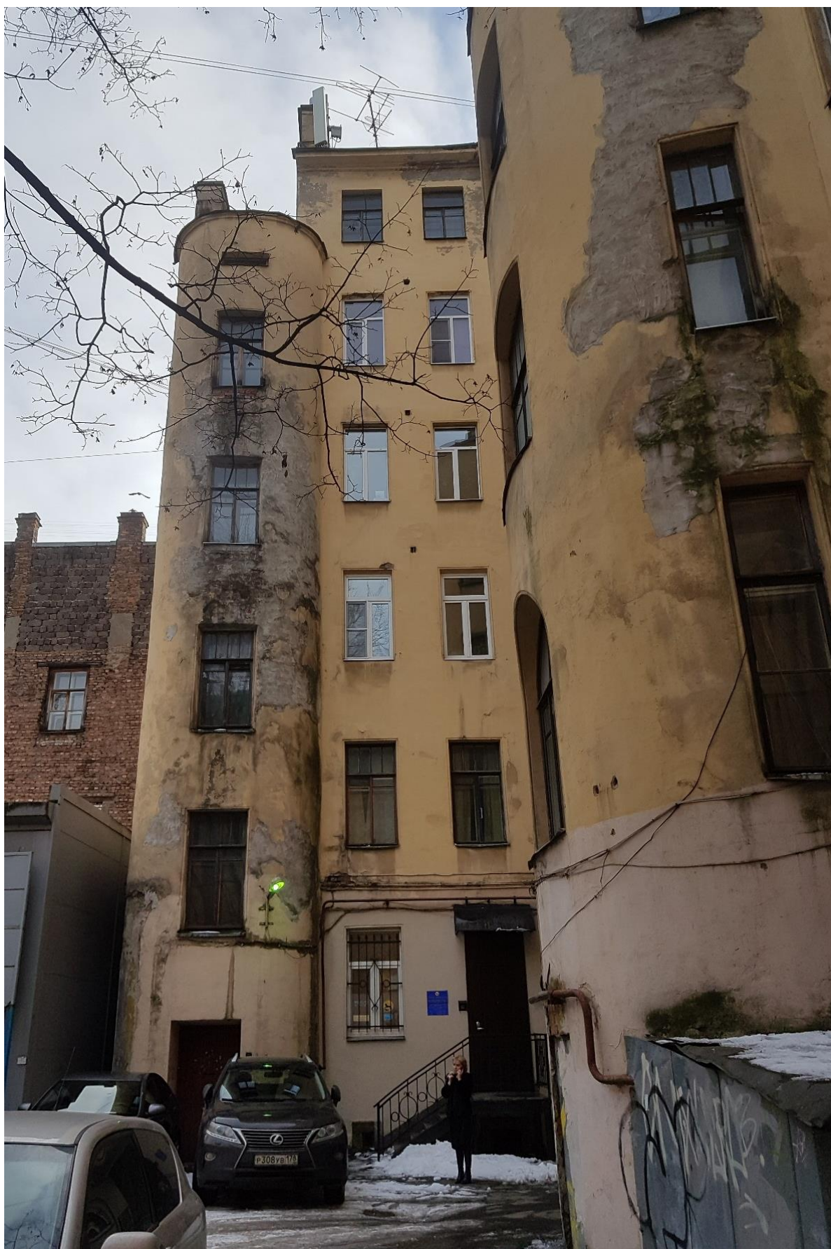
Фото 37. Дворовой фасад второго двора.
