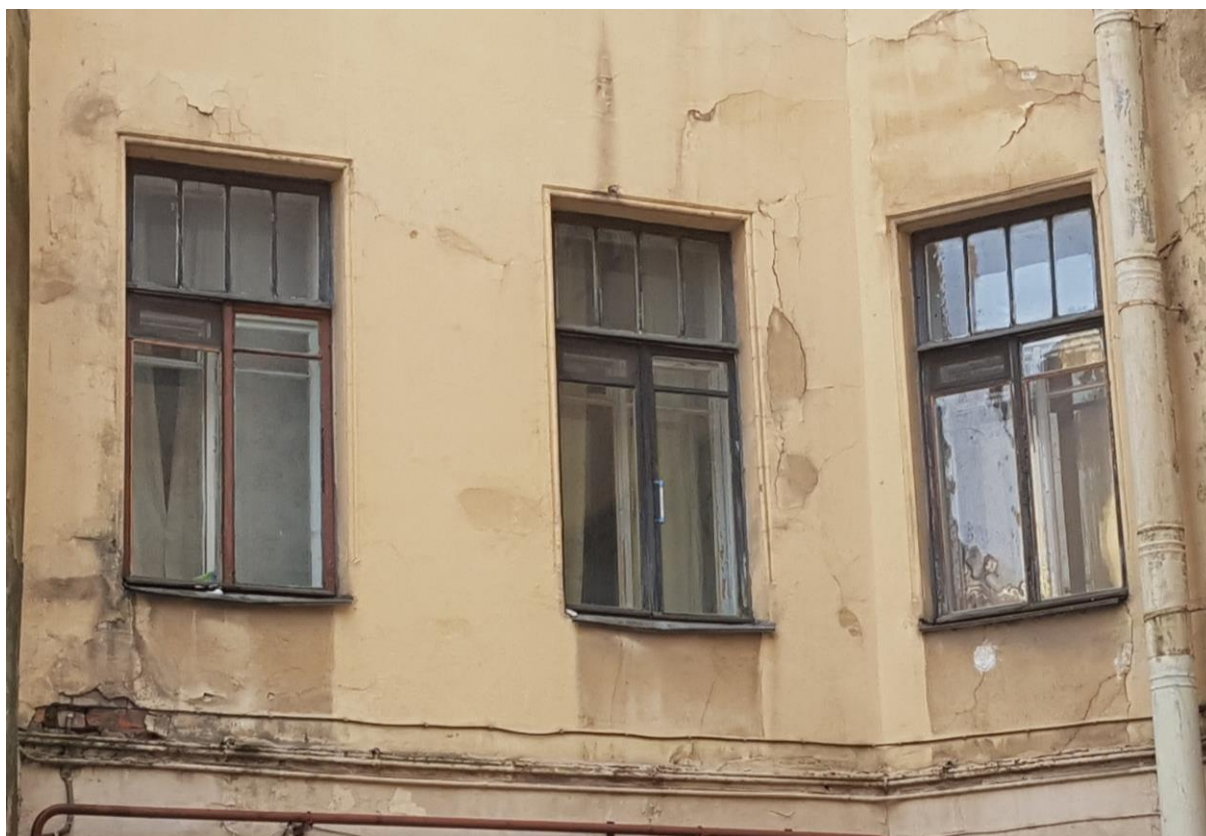
Фото 41. Оконные проемы в уровне 2-го этажа. Второй двор.
