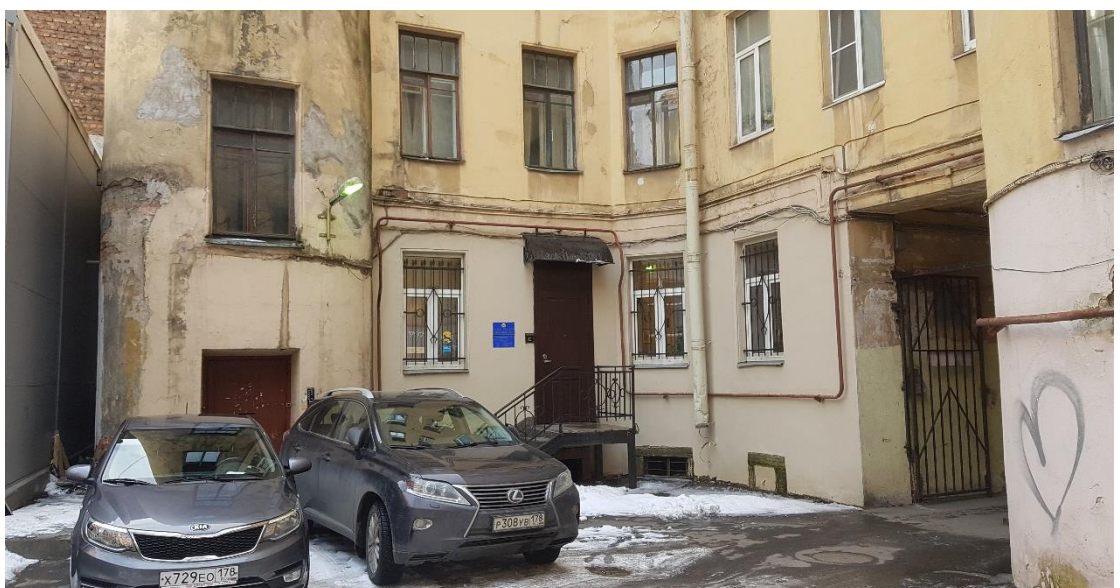
Фото 39. Дверные проемы. Второй двор.
