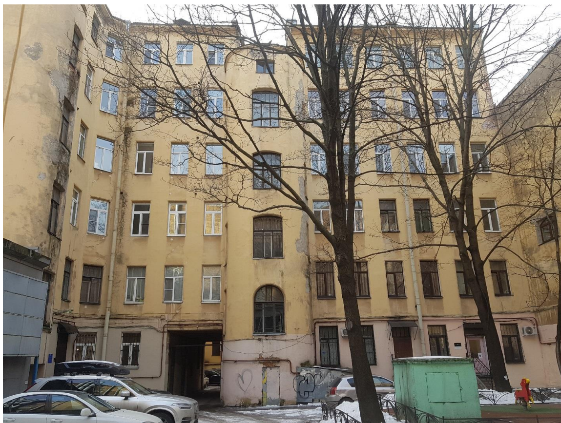
Фото 36. Дворовой фасад второго двора.
