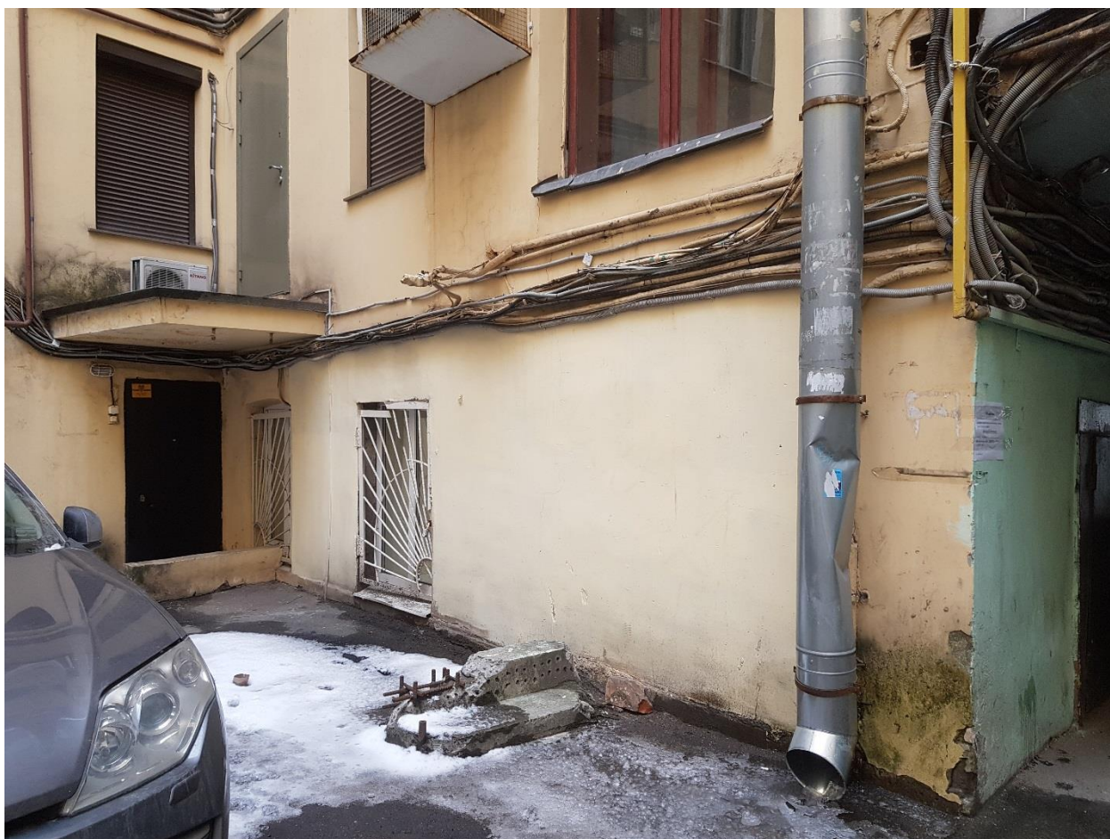
Фото 21. Уровень 1-го этажа дворового фасада лицевого корпуса.
