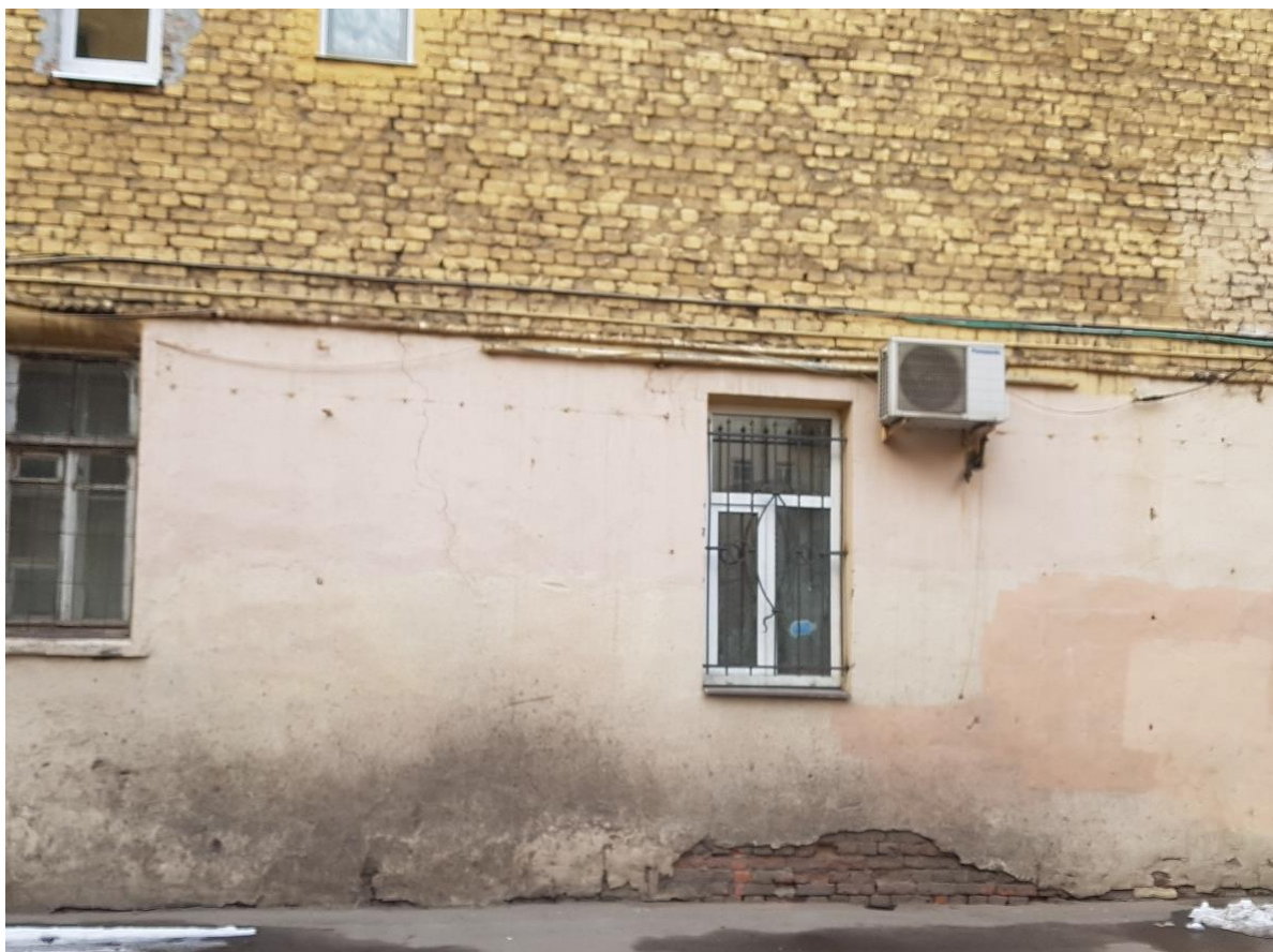
Фото 15. Уровень цоколя фасада со стороны двора №14.
