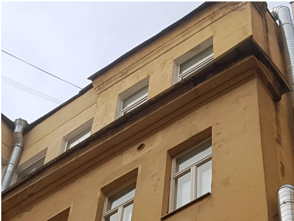
Фото 23. Карнизы. Дворовой северный фасад.
