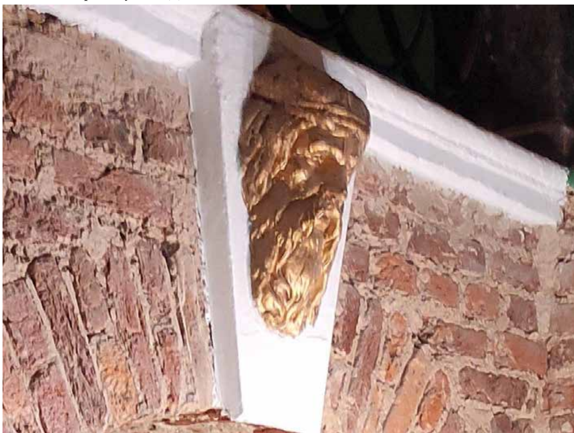
65. Выявленный объект культурного наследия «Дом С. Крамера (Г.А. Лепена)», по адресу: г. Санкт-Петербург, Морская Большая ул., 50; Мойки р. наб., 95. Фрагмент пом. 4ЛК (3) в уровне 1-го этажа северо-западного лицевого корпуса по Большой Морской улице. Замковый камень с мужским маскаронном в оформлении арочного проема. Дата съёмки: 19.06.2025.
