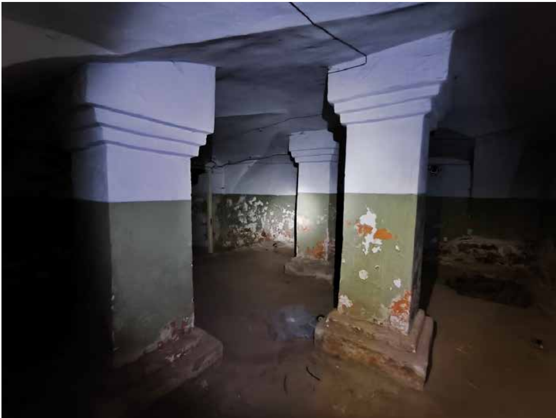
32.Выявленный объект культурного наследия «Дом С. Крамера (Г.А. Лепена)», по адресу: г. Санкт-Петербург, Морская Большая ул., 50; Мойки р. наб., 95. Общий вид пом. 13-Н (4) в уровне подвала. Дата съёмки: 03.07.2025.
