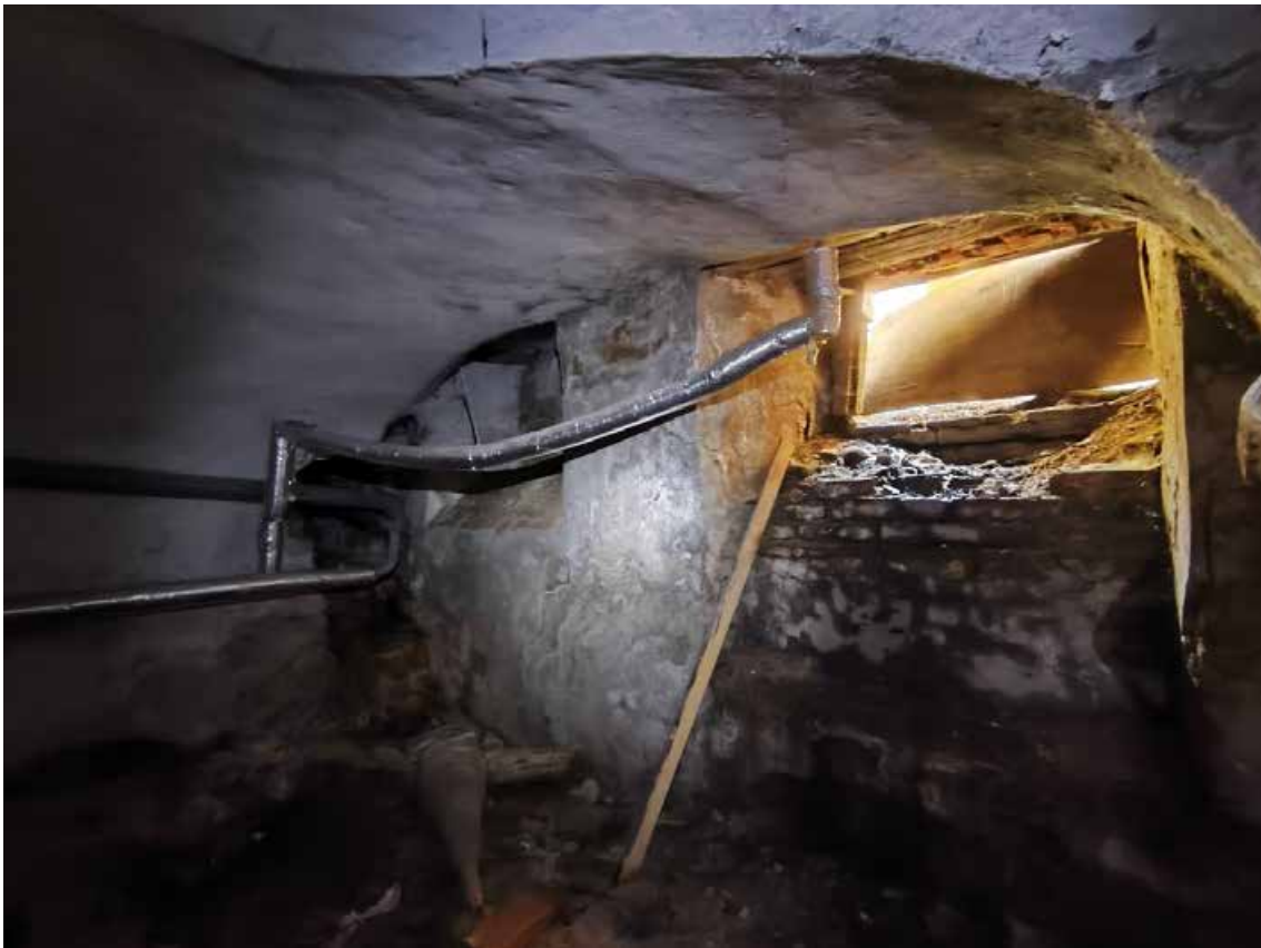
30.Выявленный объект культурного наследия «Дом С. Крамера (Г.А. Лепена)», по адресу: г. Санкт-Петербург, Морская Большая ул., 50; Мойки р. наб., 95. Общий вид пом. 13-Н (13) в уровне подвала. Дата съёмки: 03.07.2025.
