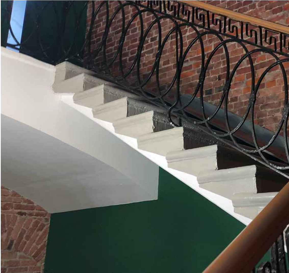
70.Выявленный объект культурного наследия «Дом С. Крамера (Г.А. Лепена)», по адресу: г. Санкт-Петербург, Морская Большая ул., 50; Мойки р. наб., 95. Фрагмент пом. ЛК4 (5) в уровне 3-го этажа северо-западного лицевого корпуса по Большой Морской улице. Вид ограждения и профиля ступеней лестницы 4ЛК. Дата съёмки: 19.06.2025.
