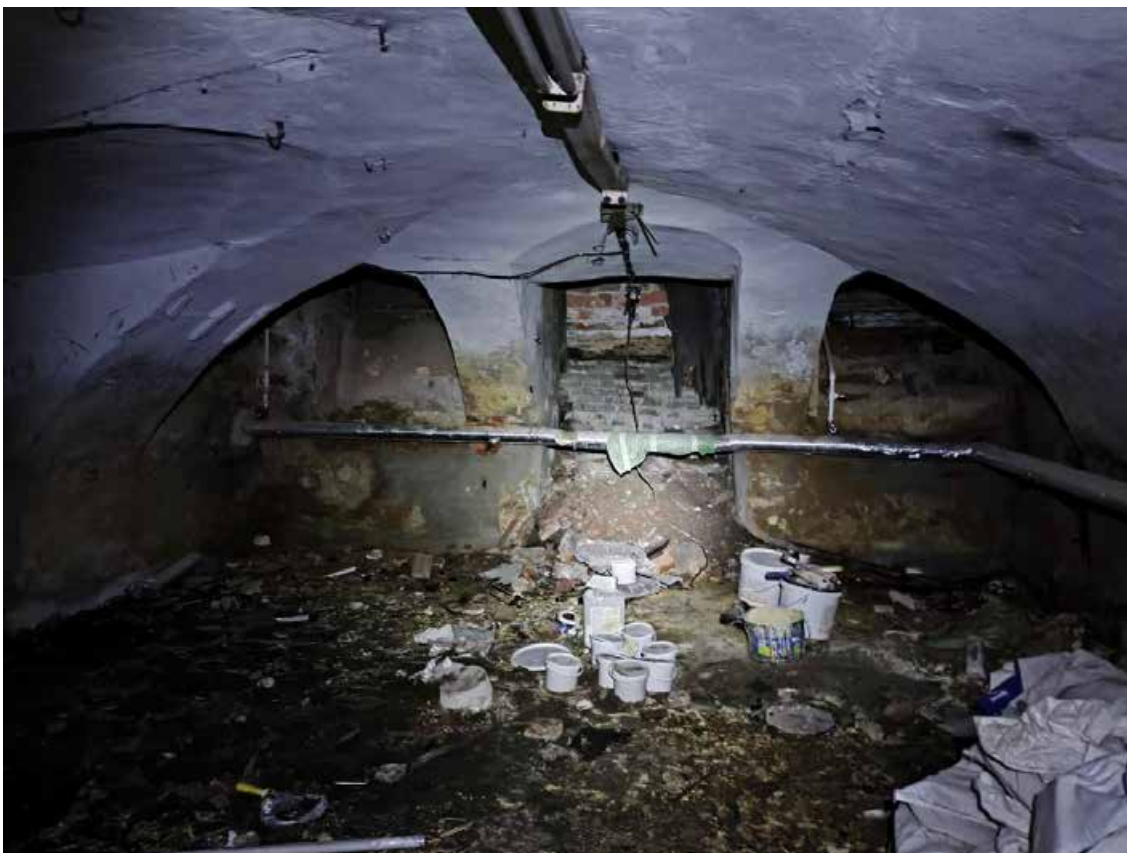
29'. Выявленный объект культурного наследия «Дом С. Крамера (Г.А. Лепена)», по адресу: г. Санкт-Петербург, Морская Большая ул., 50; Мойки р. наб., 95. Общий вид пом. 13-Н (9) в уровне подвала. Дата съёмки: 03.07.2025.
