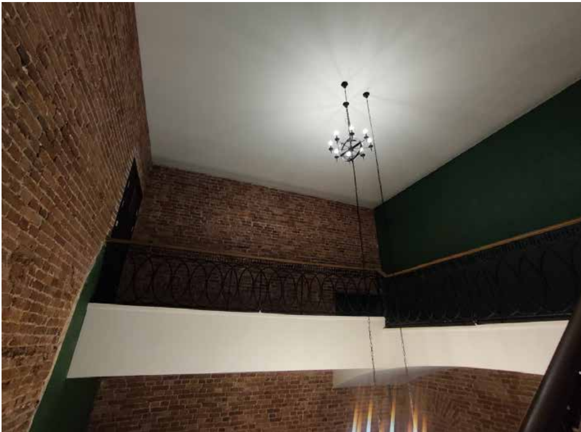
71.Выявленный объект культурного наследия «Дом С. Крамера (Г.А. Лепена)», по адресу: г. Санкт-Петербург, Морская Большая ул., 50; Мойки р. наб., 95. Общий вид пом. ЛК4 (5) в уровне 3-го этажа северо-западного лицевого корпуса по Большой Морской улице. Дата съёмки: 19.06.2025.
