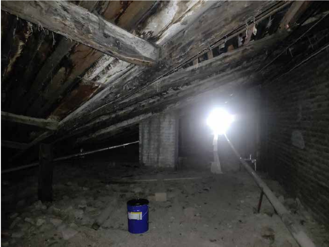
85.Выявленный объект культурного наследия «Дом С. Крамера (Г.А. Лепена)», по адресу: г. Санкт-Петербург, Морская Большая ул., 50; Мойки р. наб., 95. Фрагмент стропильной системы крыши северо-западного лицевого корпуса по Большой Морской улице. Дата съёмки: 19.06.2025.
