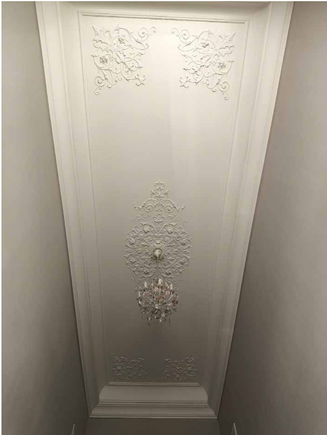
47. Выявленный объект культурного наследия «Дом С. Крамера (Г.А. Лепена)», по адресу: г. Санкт-Петербург, Морская Большая ул., 50; Мойки р. наб., 95. Фрагмент пом. 2ЛК (4) в уровне 3-го этажа юго-восточного лицевого корпуса по набережной реки Мойки. Зеркальный свод перекрытия с падугой и тягами. Дата съёмки: 03.07.2025.
