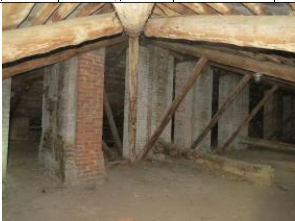
16.«Солдатская казарма с палисадником». Стропильная система общий вид.
