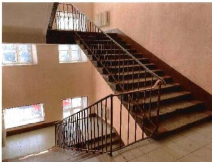
4. Лестница ИЛК в восточной части основного корпуса объекта культурного наследия (литера Д). Фото от 15.07.2022.
