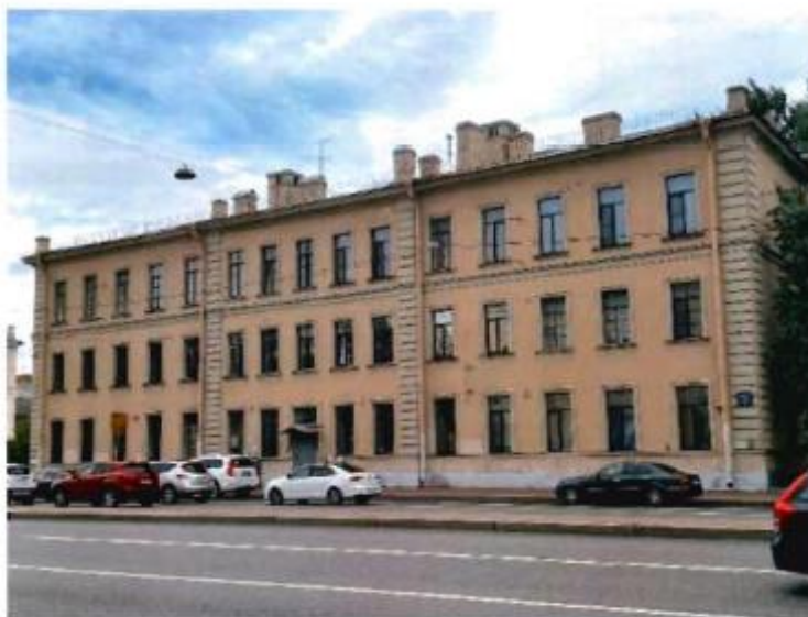
1. Восточный фасад основного корпуса объекта культурного наследия (литера Д). Фото от 02.09.2022.
