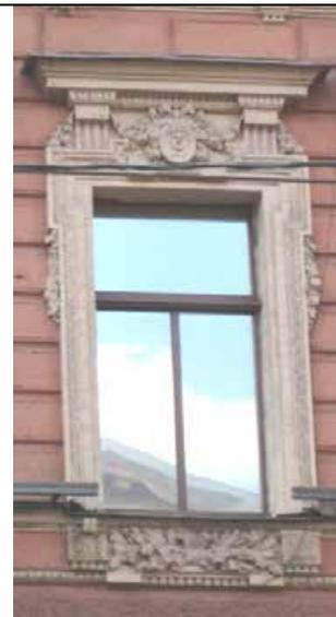
оформление оконных проемов 4-го этажа – лепные профилированные наличники с гирляндами; над окнами профилированный карниз; под окном лепной рельеф с рисунком «бегущая волна»;
