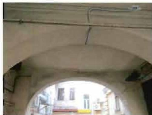
воротный проезд – местоположение ( юго-западный дворовый флигель), габариты, конструкция, перекрытие (плоское, оштукатуренные кирпичные «пруссские» своды по металлическим балкам);
