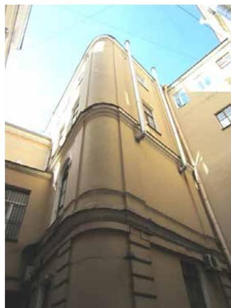
2-3-ий этажи (окна зала) - на 2 этажа арочные, с полуциркульными перемычками, декорированы сложнопрофилированными наличниками, подоконными и надоконными филенками;
