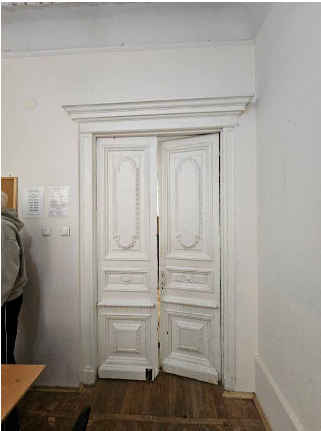
31.Выявленный объект культурного наследия «Здание женской гимназии кн. Оболенской», по адресу: г. Санкт-Петербург, Басков пер., д. 8, лит. А. Общий вид пом. 14-Н (19) в уровне 2-го этажа.
