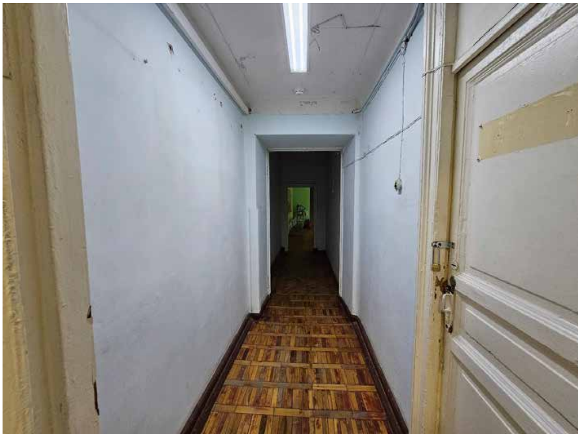
50.Выявленный объект культурного наследия «Здание женской гимназии кн. Оболенской», по адресу: г. Санкт-Петербург, Басков пер., д. 8, лит. А. Общий вид пом. 21-Н (10, 5) в уровне 5-го этажа.
