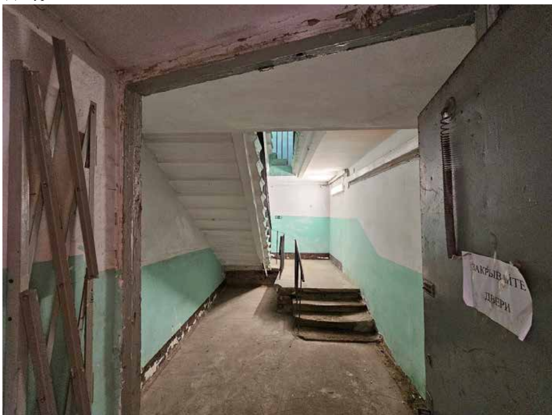
14.Выявленный объект культурного наследия «Здание женской гимназии кн. Оболенской», по адресу: г. Санкт-Петербург, Басков пер., д. 8, лит. А. Фрагмент двухмаршевой межэтажной лестницы в восточном дворовом флигеле (пом. Л-2 (I) в уровне 1-го этажа).
