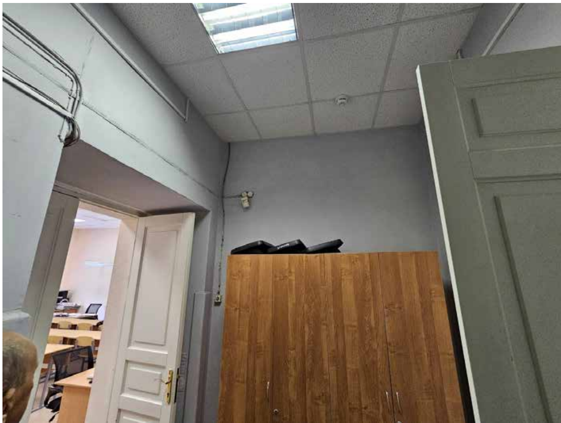
41.Выявленный объект культурного наследия «Здание женской гимназии кн. Оболенской», по адресу: г. Санкт-Петербург, Басков пер., д. 8, лит. А. Общий вид пом. 16-Н (1) в уровне 3-го этажа.
