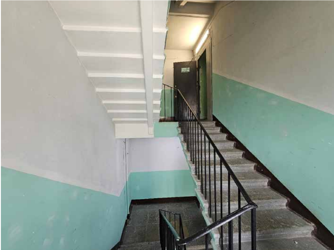
52.Выявленный объект культурного наследия «Здание женской гимназии кн. Оболенской», по адресу: г. Санкт-Петербург, Басков пер., д. 8, лит. А. Общий вид двухмаршевой межэтажной лестницы в восточном дворовом флигеле (пом. Л-2 (IX) в уровне 6-го этажа).
