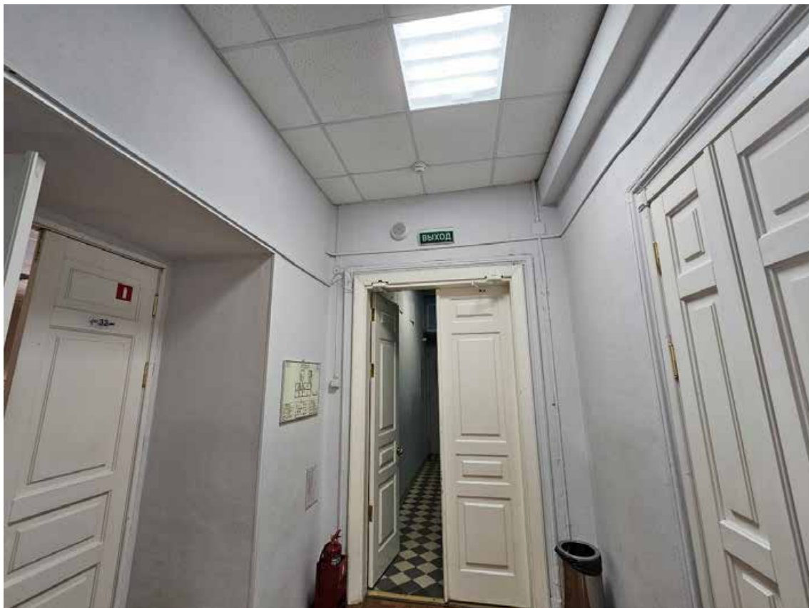
37.Выявленный объект культурного наследия «Здание женской гимназии кн. Оболенской», по адресу: г. Санкт-Петербург, Басков пер., д. 8, лит. А. Общий вид пом. 18-Н (1) в уровне 3-го этажа.
