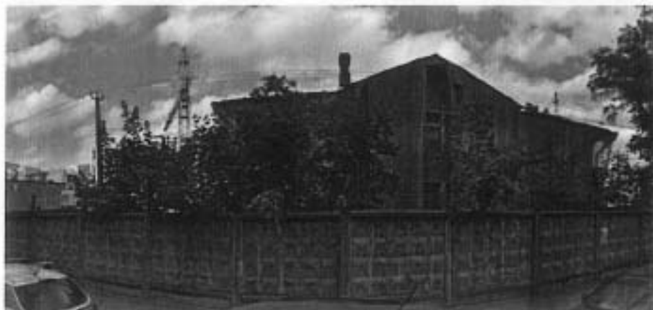
1. Фасад со стороны Красногвардейского переулкa
