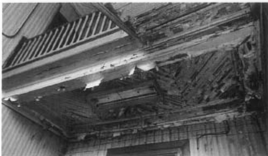
10. Интерьеры помещений 1-го этажа
