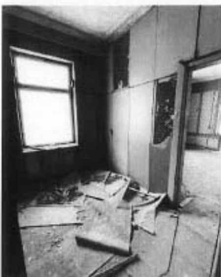
14. Интерьеры помещений 2-го этажа
