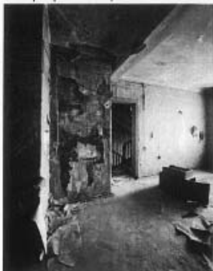
17. Интерьеры помещений 2-го этажа
