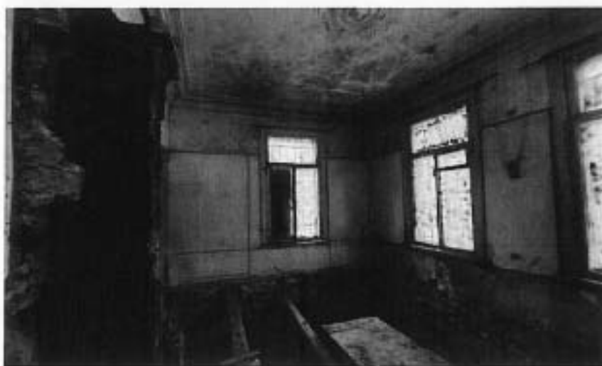
12. Интерьеры помещений 1-го этажа
