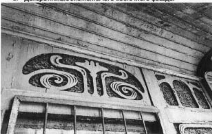
6. Декоративные элементы юго-восточного фасада.
