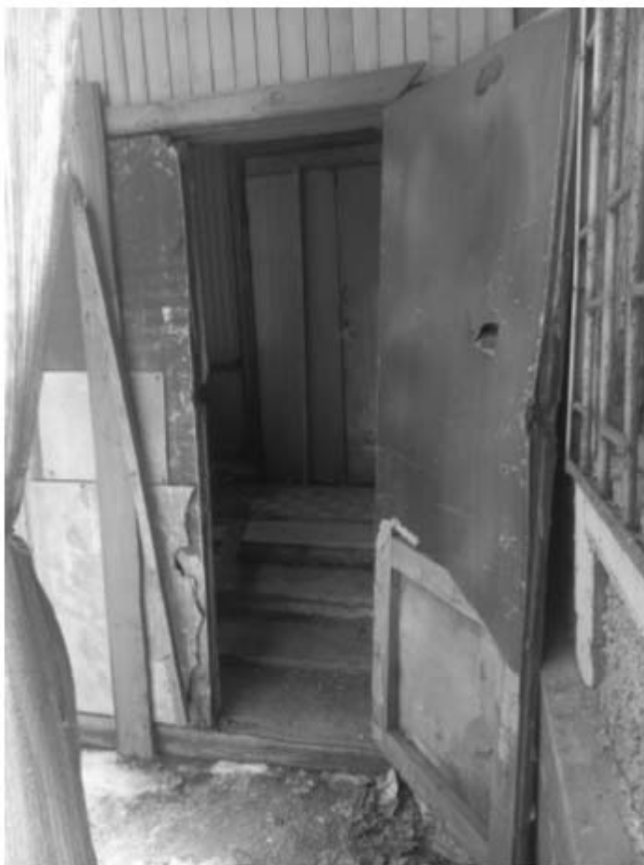
Фото 5. Главный вход в здание.
