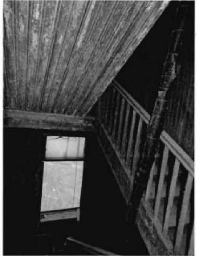
4. Лестница в северо-восточной части объекта культурного наследия.
