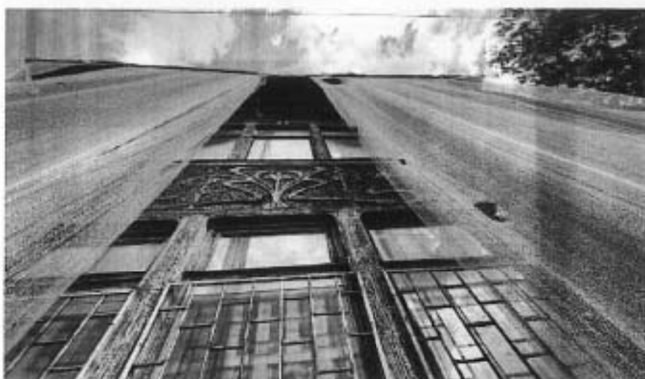
2. Фрагмент юго-западного фасада. Центральная часть.
