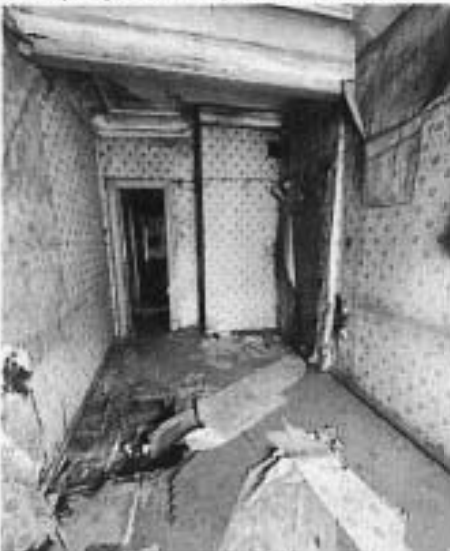
15. Интерьеры помещений 2-го этажа
