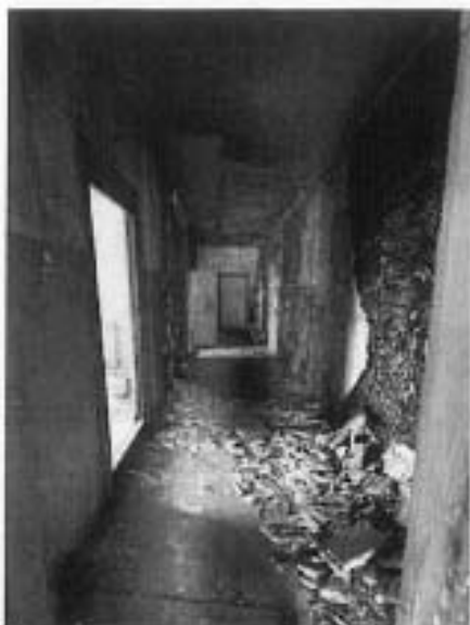
16. Интерьеры помещений 2-го этажа
