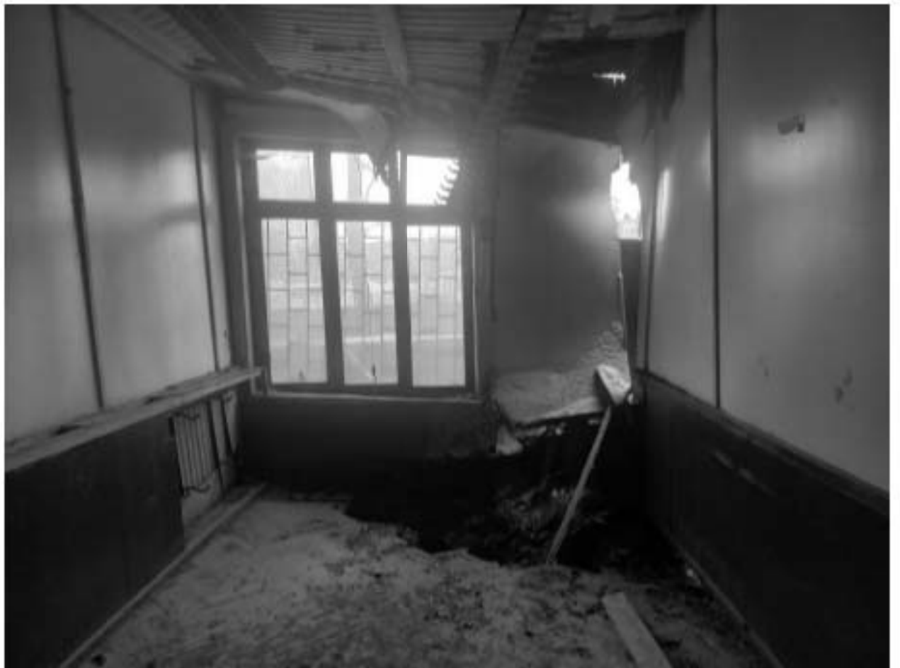
Фото 18. Внутренние помещения. 1 этаж.
