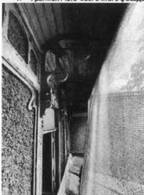
5. Декоративные элементы юго-восточного фасада.
