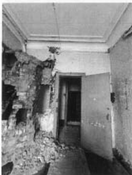
11. Интерьеры помещений 1-го этажа
