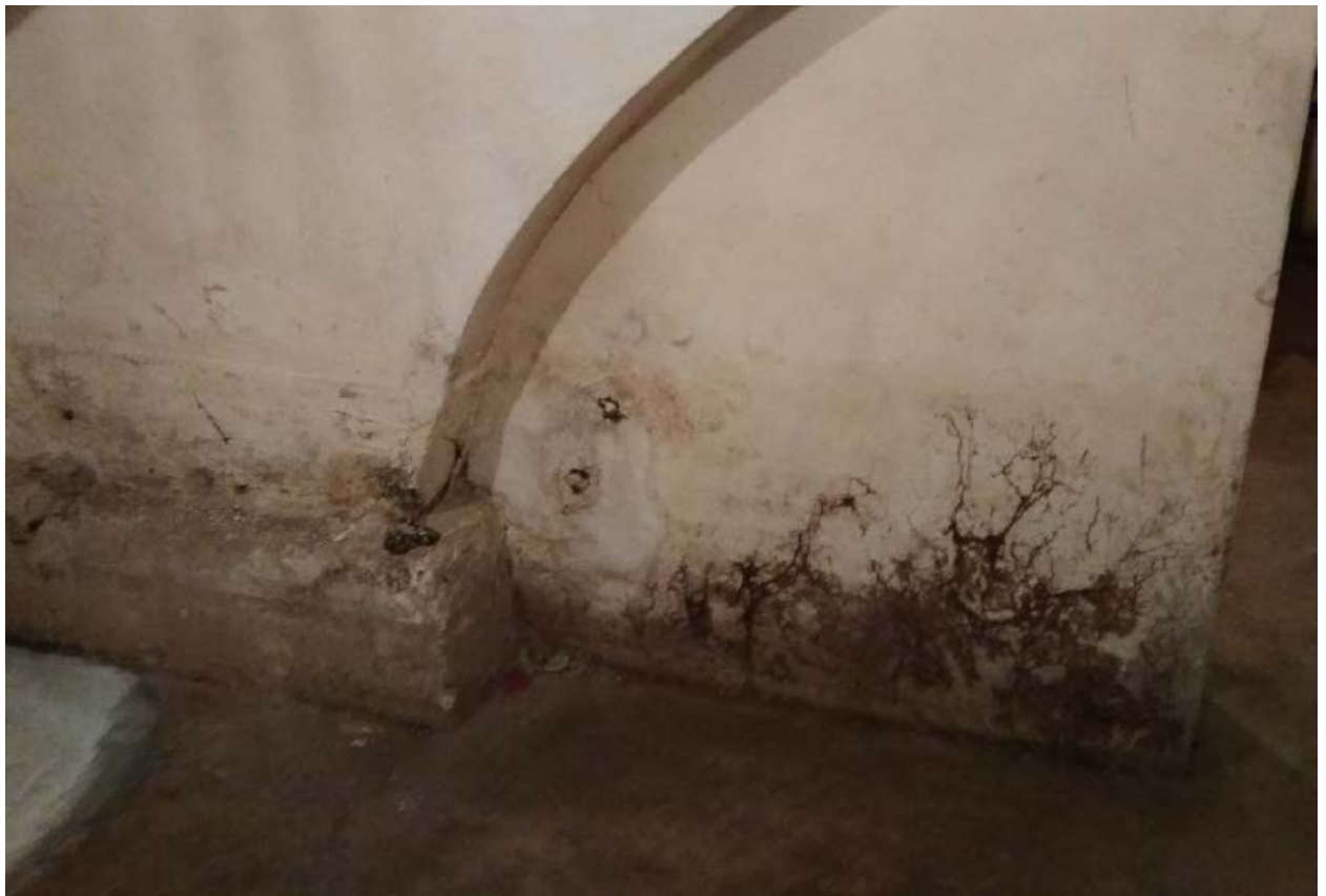
21. Стена и полы подвала здания объекта культурного наследия федерального значения «Дом Голенищева - Кутузова П.В., 1820-е гг., 1830-е гг. (фасады), арх. Росси К.И. Здесь в 1924 - 1939 гг. жил художник Бродский И.И.», расположенного по адресу: г. Санкт-Петербург, пл. Искусств, д. 3, литера А. 15.09.2020
