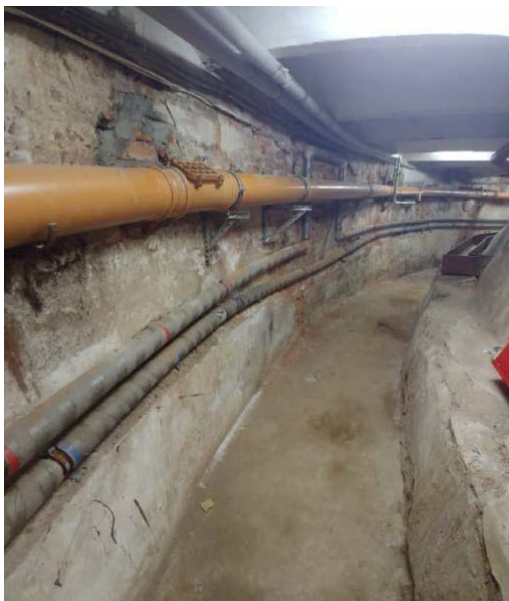
11. Подвал в зоне зрительного зала объекта культурного наследия федерального значения «Театр Михайловский 1831-1833 гг., арх. Росси К.И., арх. Брюллов А.П.», расположенного по адресу: г. Санкт-Петербург, пл. Искусств, д. 1, литера А. 15.09.2020
