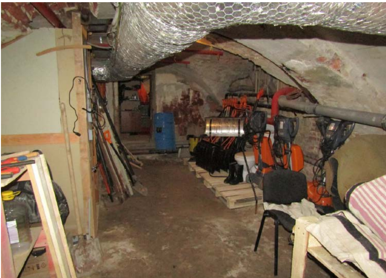
16. Пол подвала здания объекта культурного наследия федерального значения «Театр Михайловский 1831-1833 гг., арх. Росси К.И., арх. Брюллов А.П.», расположенного по адресу: г. Санкт-Петербург, пл. Искусств, д. 1, литера А. 15.09.2020
