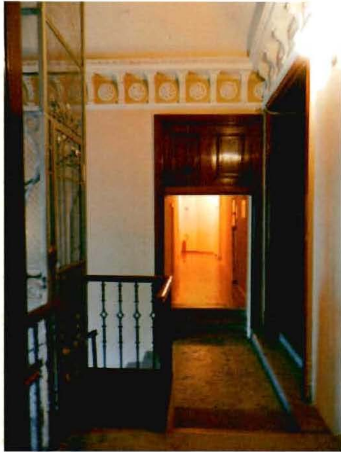
7. Лестничная клетка 3-го этажа
