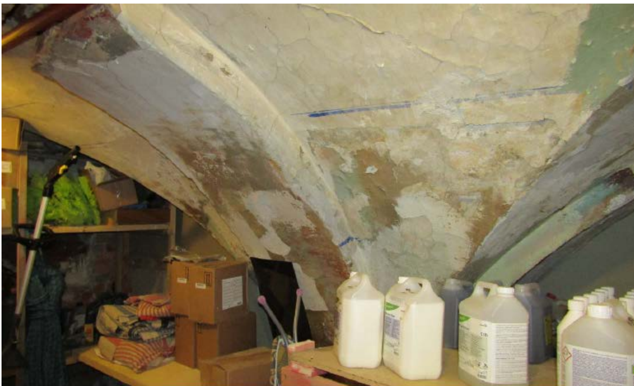
15. Стена подвала здания объекта культурного наследия федерального значения «Театр Михайловский 1831-1833 гг., арх. Росси К.И., арх. Брюллов А.П.», расположенного по адресу: г. Санкт-Петербург, пл. Искусств, д. 1, литера А. 15.09.2020
