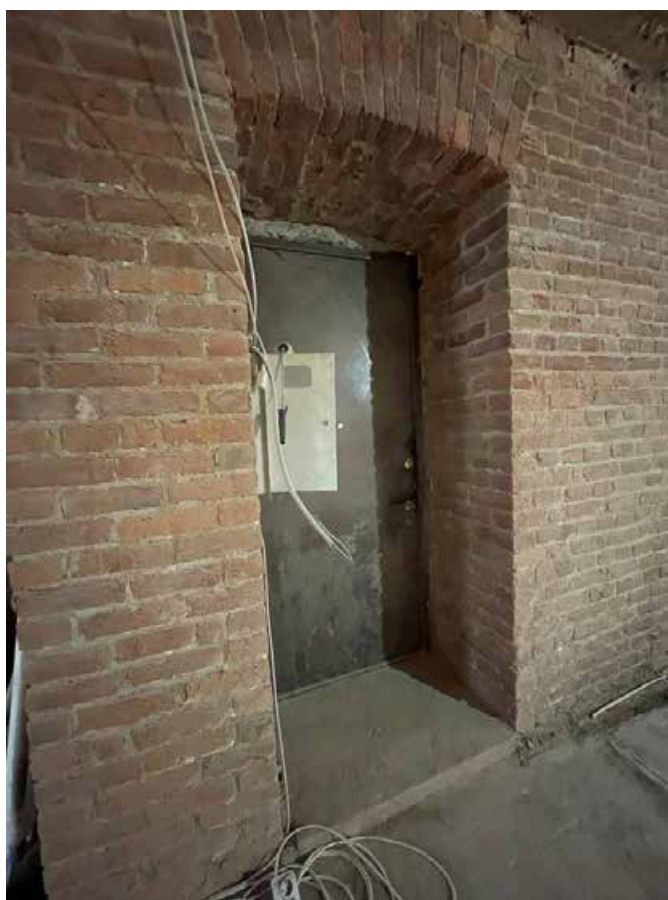
Фото 10. Интерьер квартиры № 45 выявленного объекта культурного наследия «Дом Ф.Л. и Д.Л. Парфеновых», вход в квартиру
