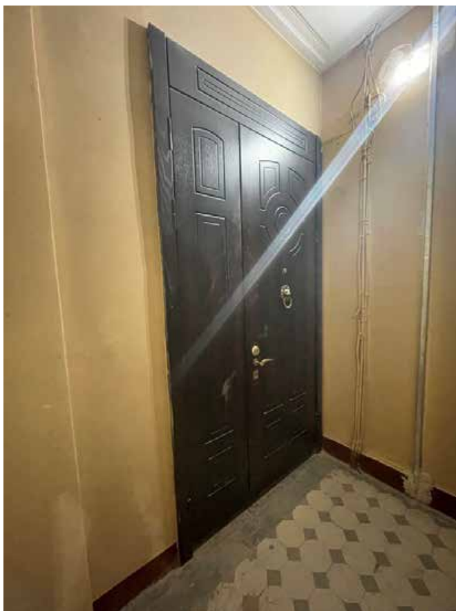
Фото 5. Интерьер квартиры № 45 выявленного объекта культурного наследия «Дом Ф.Л. и Д.Л. Парфеновых», вход в квартиру
