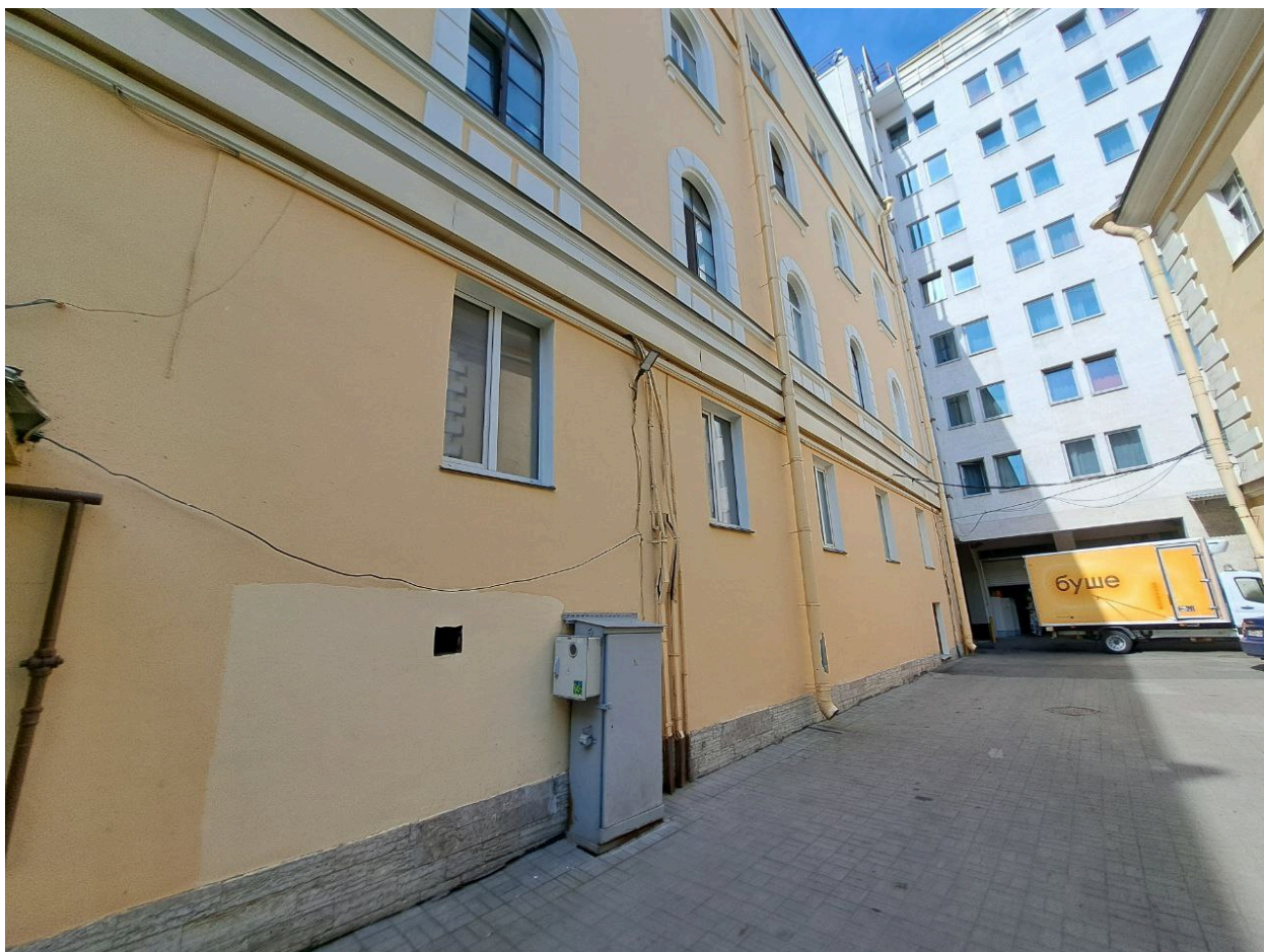
Фото № 1. Фрагмент дворового фасада здания.
