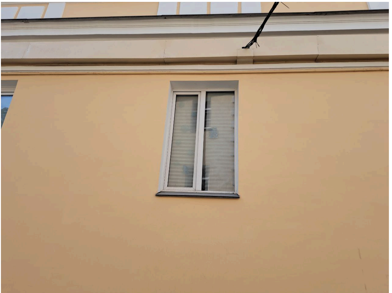
Фото № 7. Фрагмент дворового фасада. Оконное заполнение квартиры № 1.
