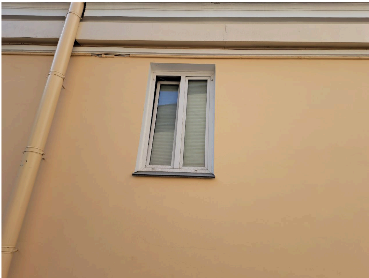
Фото № 8. Фрагмент дворового фасада. Оконное заполнение квартиры № 1.
