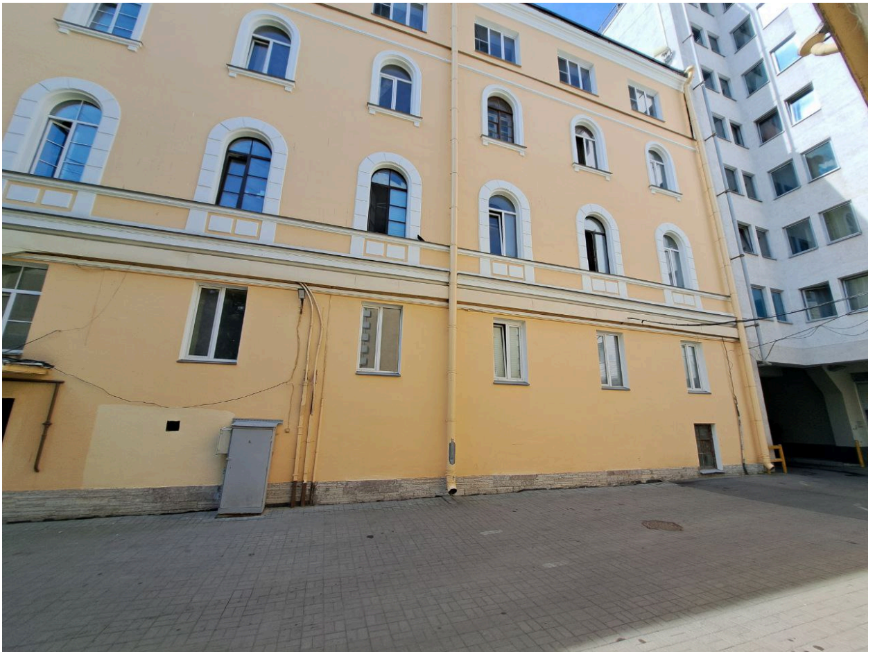
Фото № 12. Фрагмент дворового фасада.
