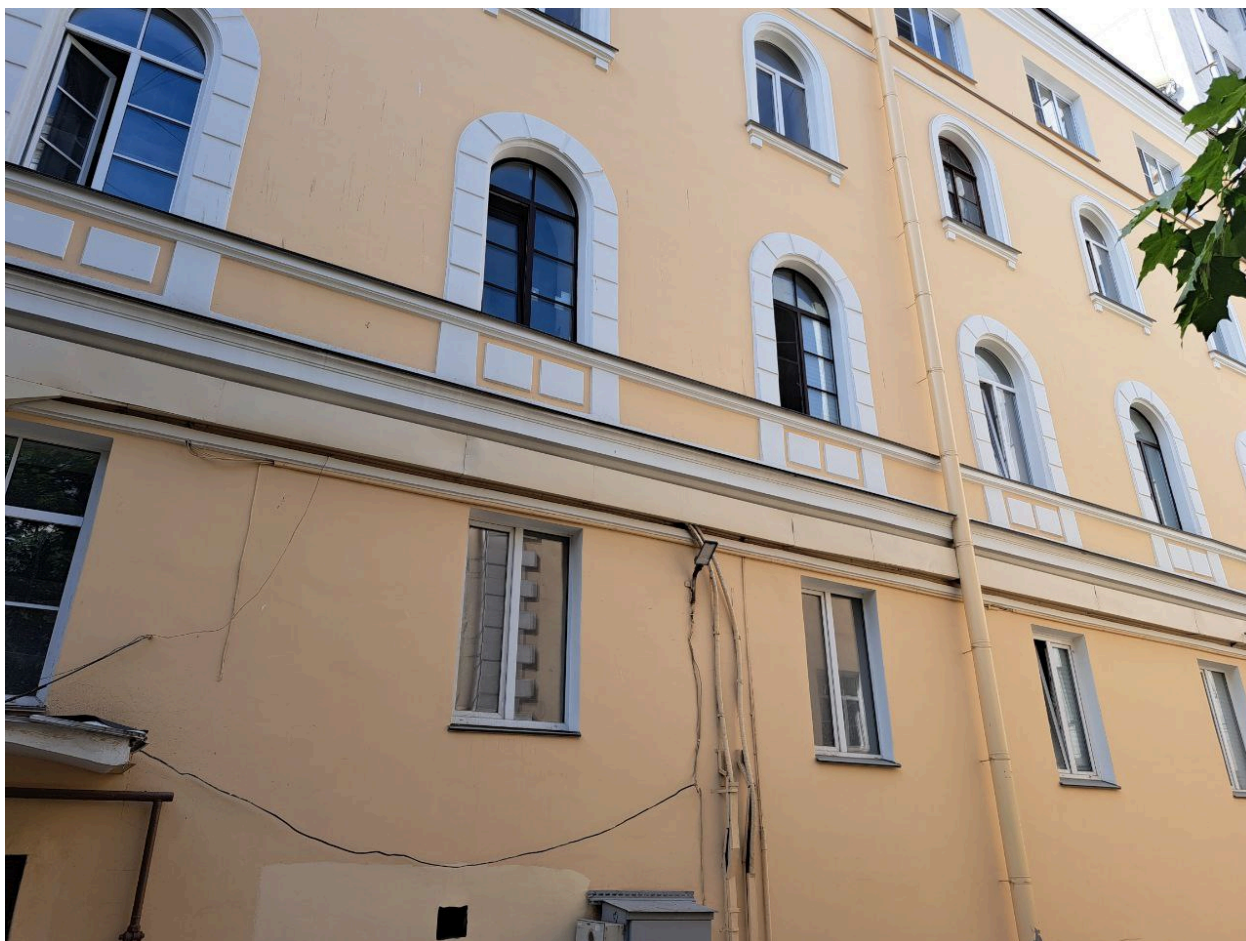
Фото № 2. Фрагмент дворового фасада здания.
