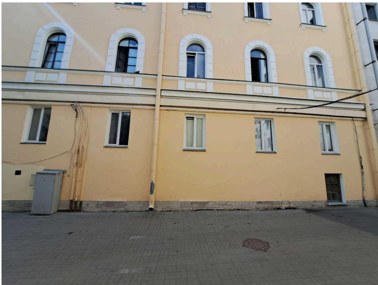
Фото № 13. Фрагмент дворового фасада.
