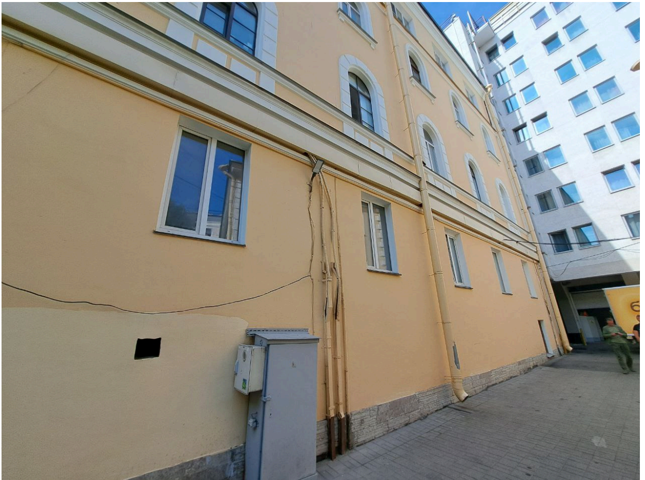
Фото № 11. Фрагмент дворового фасада.
