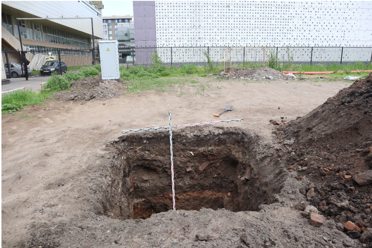
Рис. 32. Санкт-Петербург, Василеостровский р-н, Малый проспект В.О., участок 35, (у дома 68, корпус 3, литера Г). Шурф 1. Фотофиксация общего вида шурфа с окружающим пейзажем после остановки работ. Вид на северо-восток.
