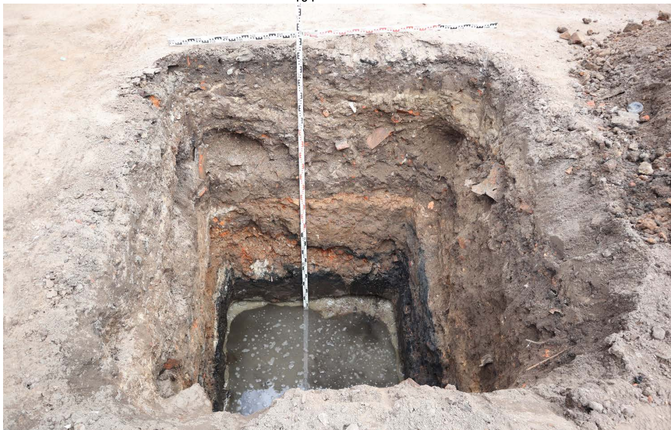
Рис. 26. Санкт-Петербург, Василеостровский р-н, Малый проспект В.О., участок 35, (у дома 68, корпус 3, литера Г). Шурф 1. Фотофиксация по матерiku (светло-серая супесь), затопленному водой. Вид на северо-восток.
