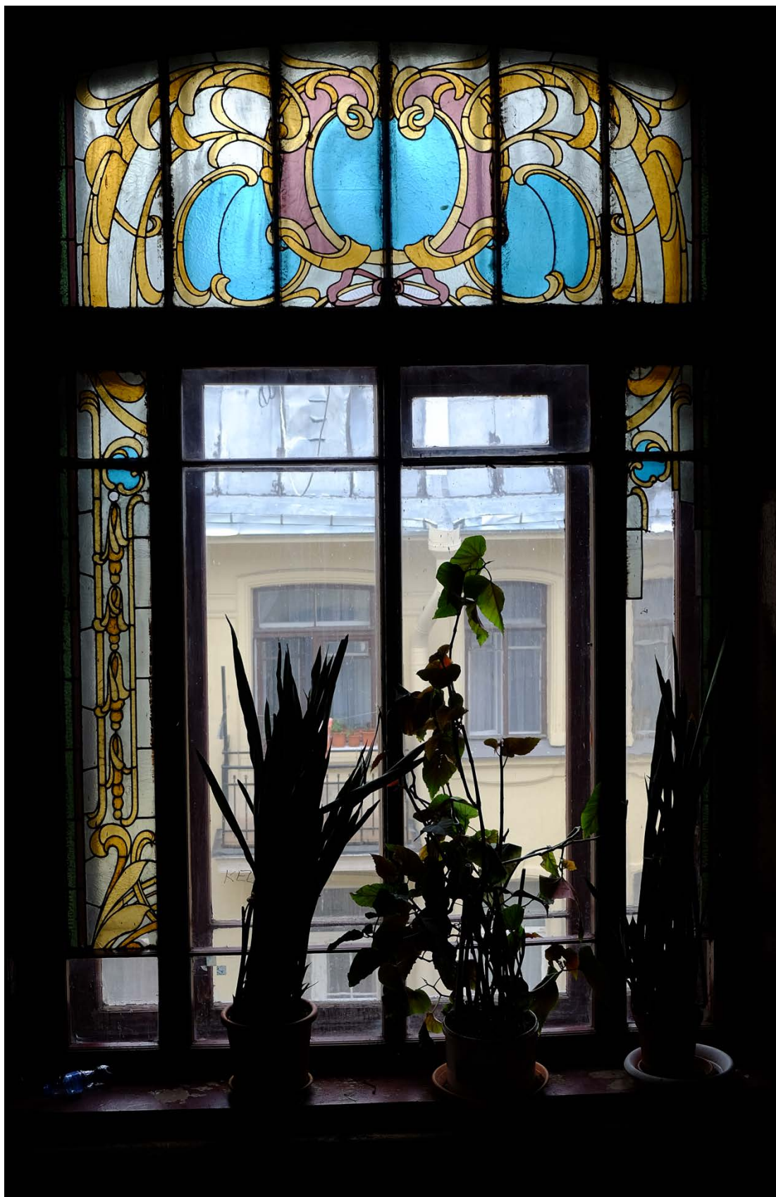
28. Кирочная улица, дом 24, литера А. «Дом Ю.Бака». Парадная лестница № 1. Шестой этаж. Оконное заполнение. Общий вид.
