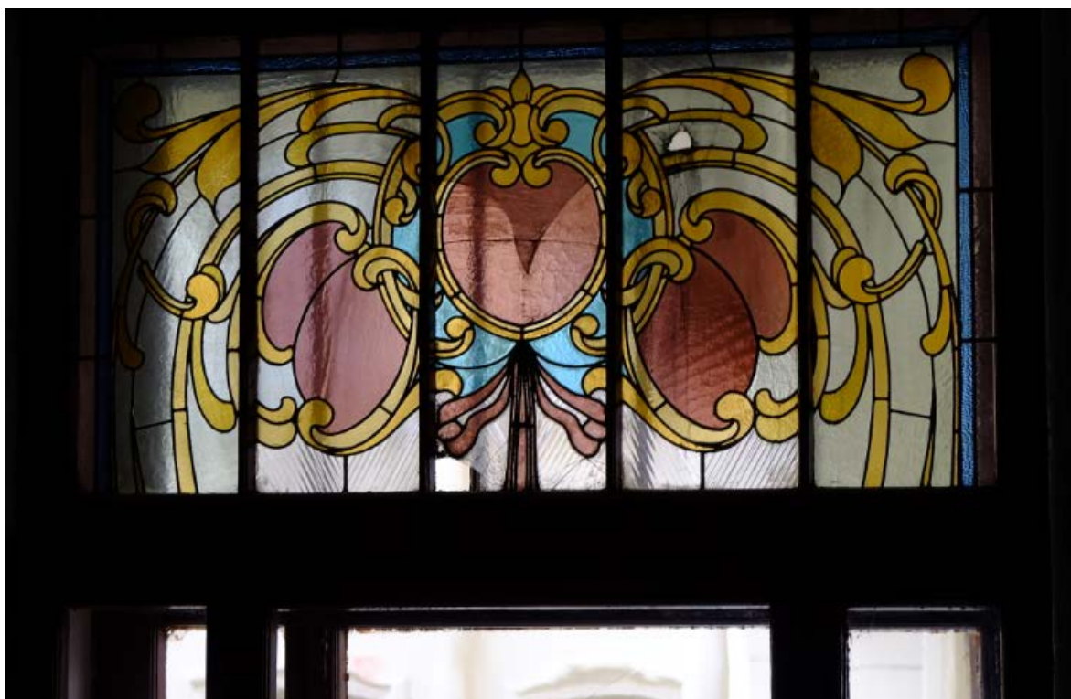
56. Кирочная улица, дом 24, литера А. «Дом Ю.Бака». Парадная лестница № 2. Четвертый этаж. Витраж центрального окна. Крупный план.
