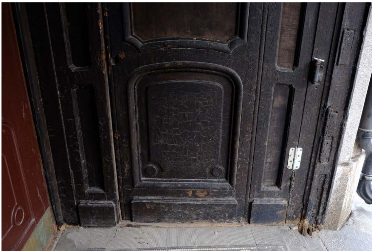
14. Кирочная улица, дом 24, литера А. «Дом Ю.Бака». Тамбур парадной лестницы № 1. Правая боковая панель. Нижняя часть.
