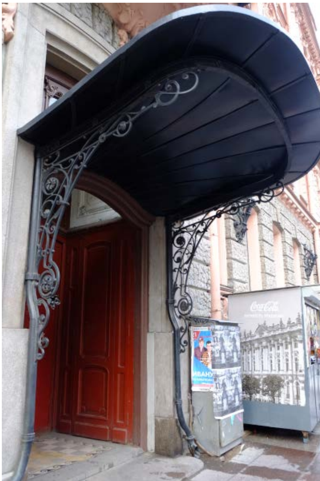
33. Кирочная улица, дом 24, литера А. «Дом Ю.Бака». Парадная лестница № 2. Дверное заполнение и откосы.
