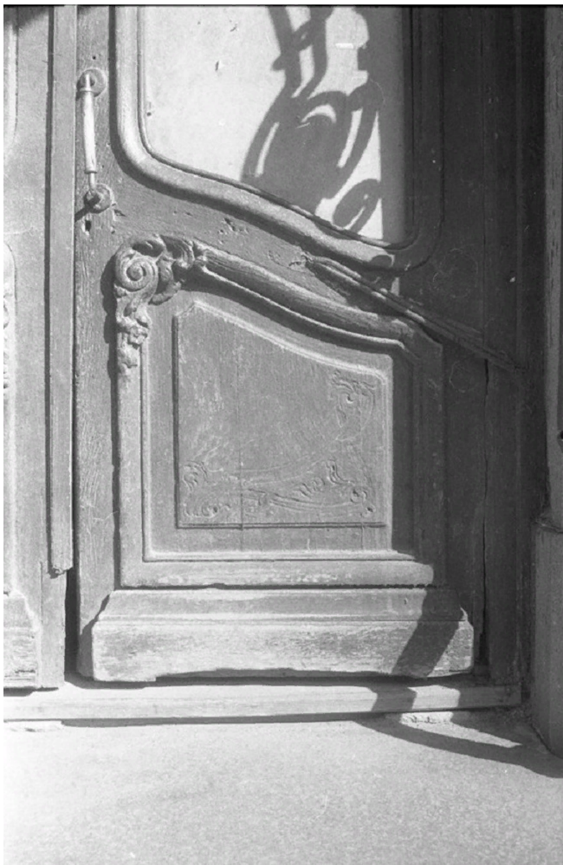
49. Входная дверь. До 1998. Источник: www.protect812.com
