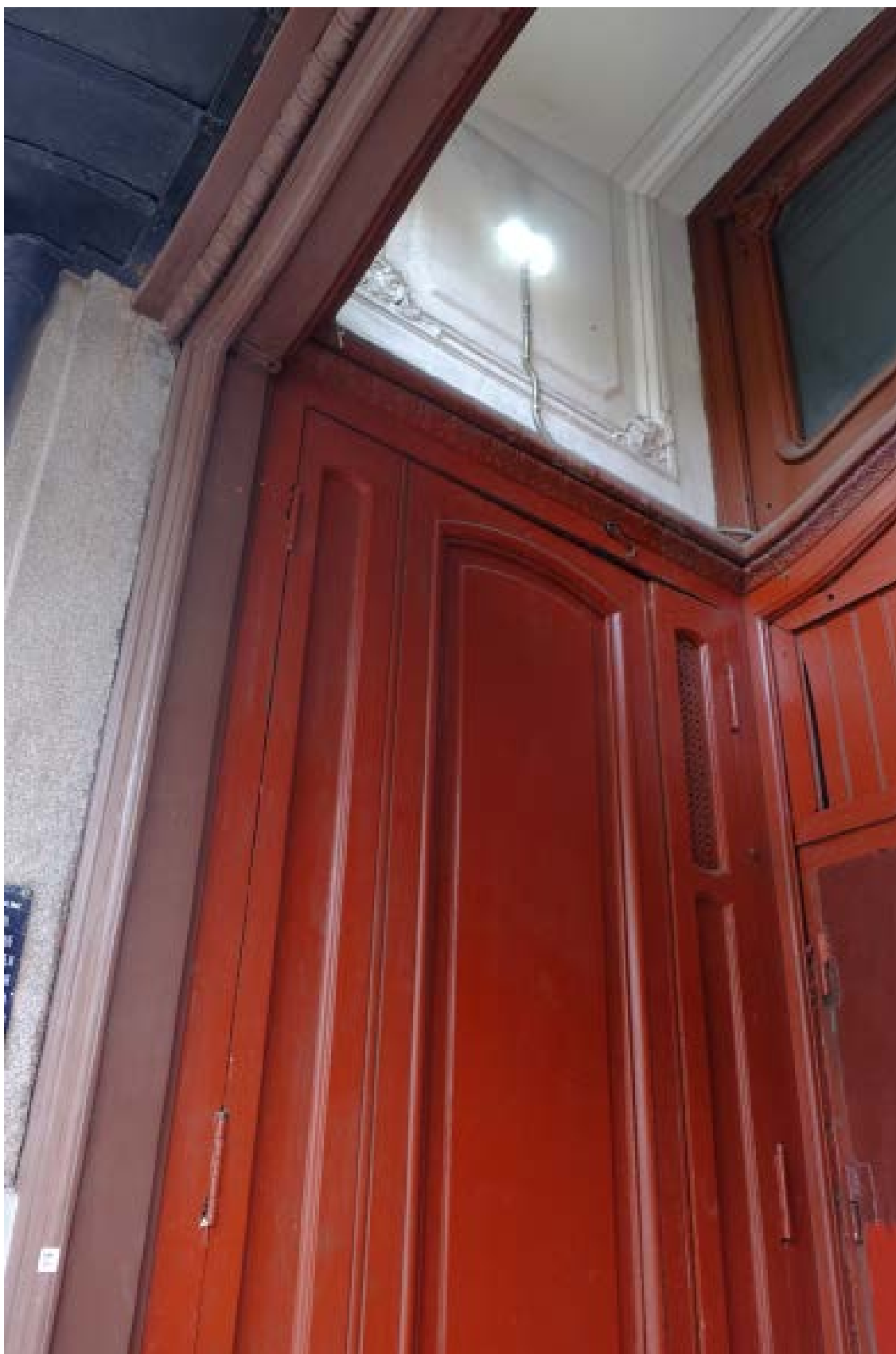
36. Кирочная улица, дом 24, литера А. «Дом Ю.Бака». Парадная лестница № 2. Тамбур. Левая боковая панель.
