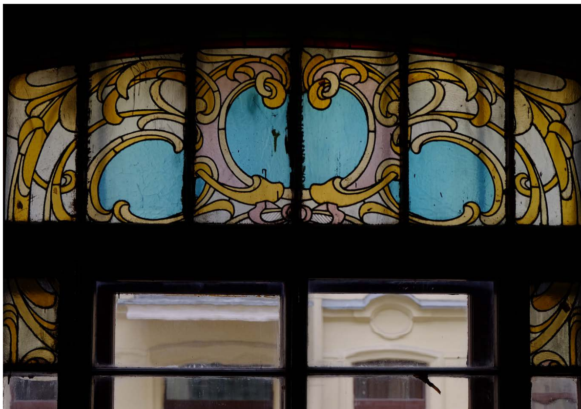
25. Кирочная улица, дом 24, литера А. «Дом Ю.Бака». Парадная лестница № 1. Четвертый этаж. Витраж.. Крупный план.
