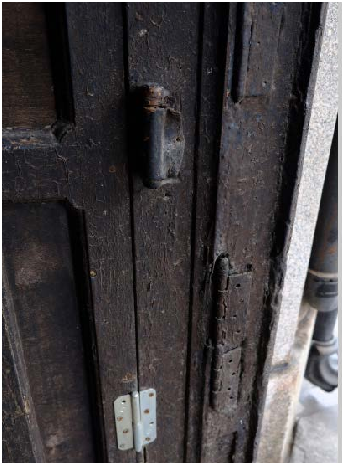
15. Кирочная улица, дом 24, литера А. «Дом Ю.Бака». Тамбур парадной лестницы № 1. Петли.
