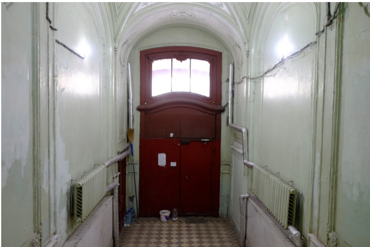
46. Кирочная улица, дом 24, литера А. «Дом Ю.Бака». Парадная лестница № 2. Вестибюль. Вид с лестницы.
