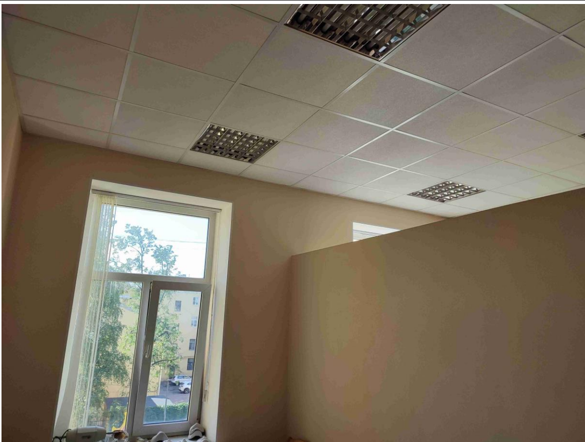
30. Фрагмент пом. 12-Н (26) в уровне 3-го этажа.
