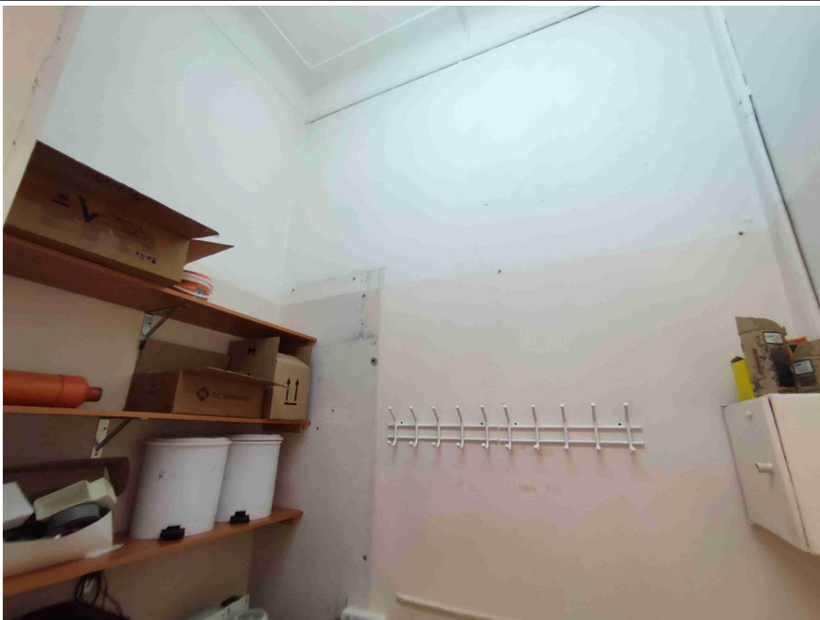
38. Общий вид пом. 14-Н (10) в уровне 4-го этажа.
