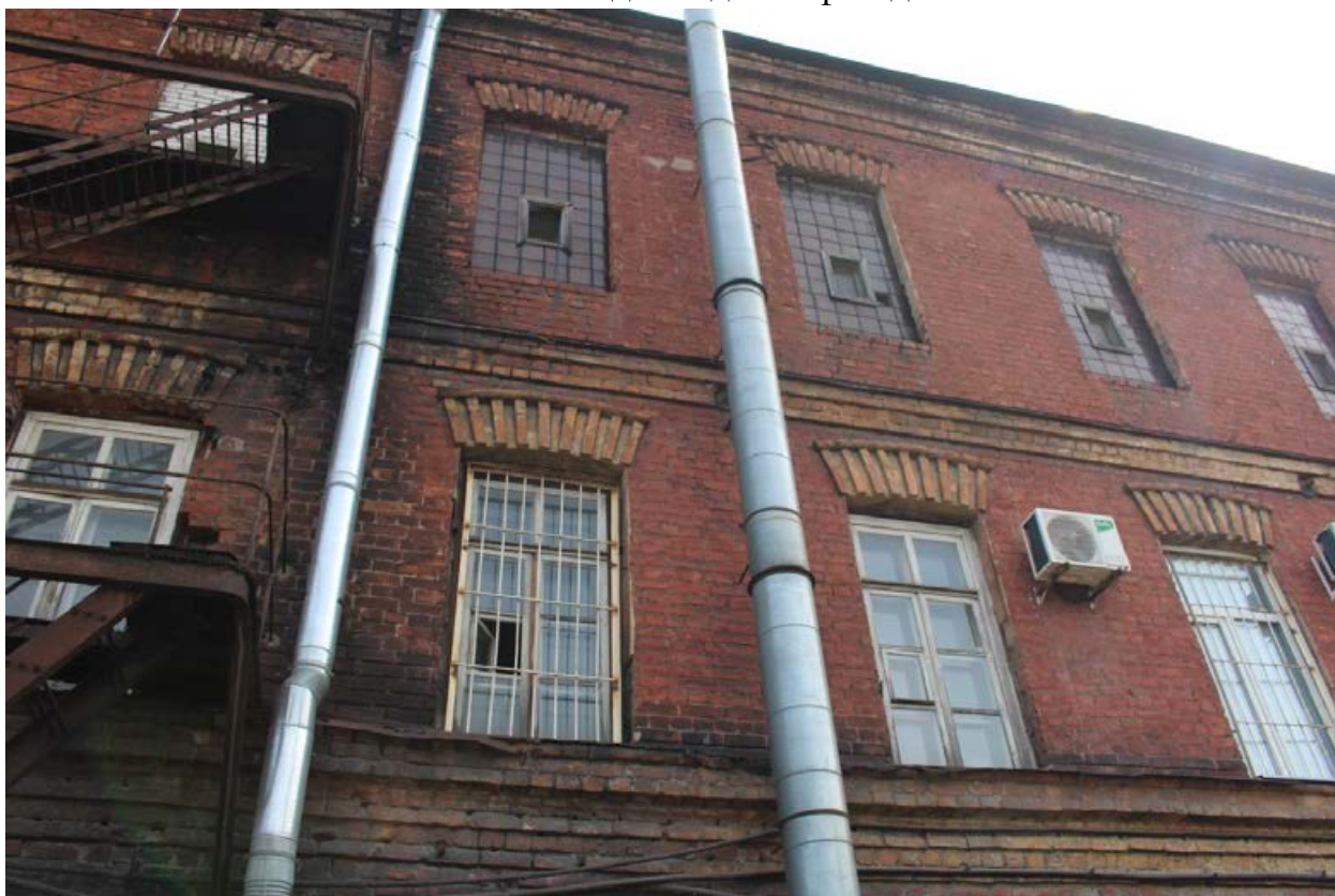
Фото 16. Фрагмент западного фасада в центральной части.
