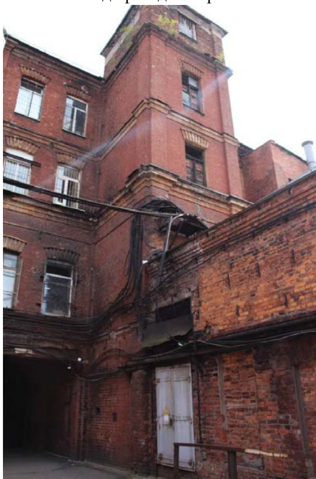
Фото 30. Общий вид северного ризалита западного фасада.
