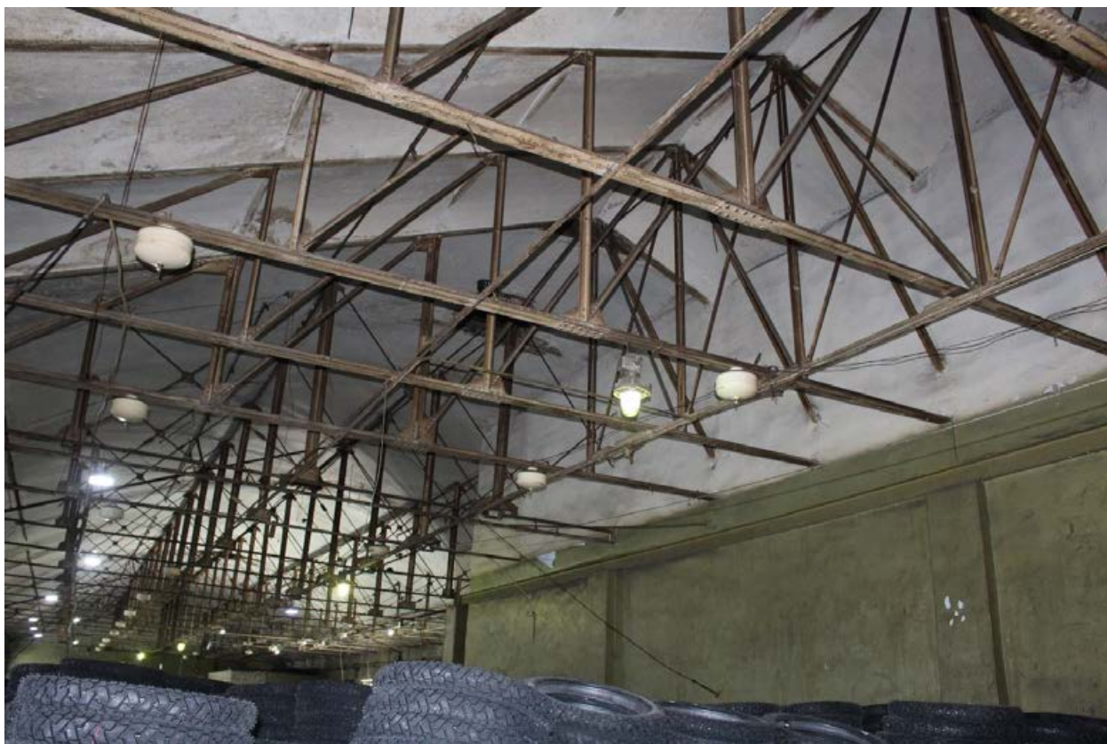
Фото 47. Вид ферм и покрытия 4 этажа.
