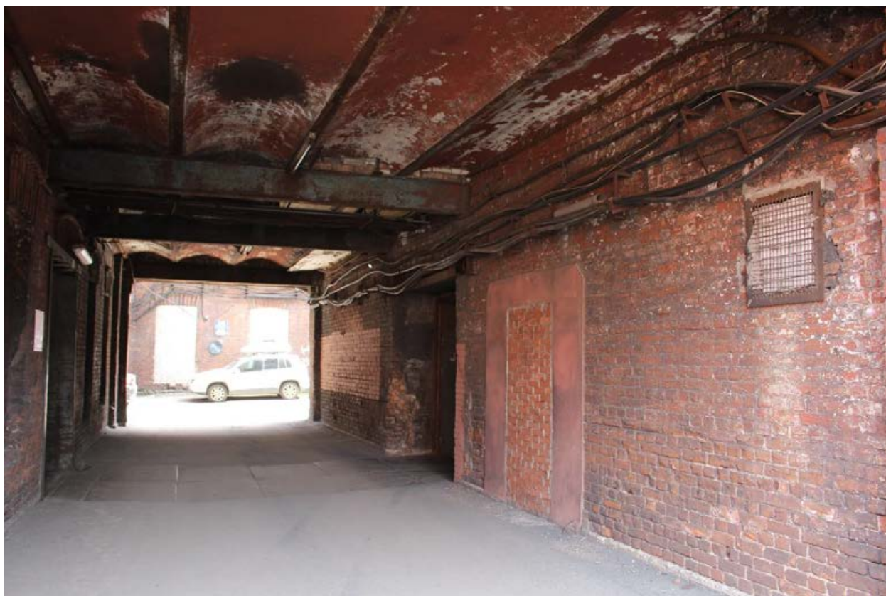
Фото 27. Общий вид проездной арки.
