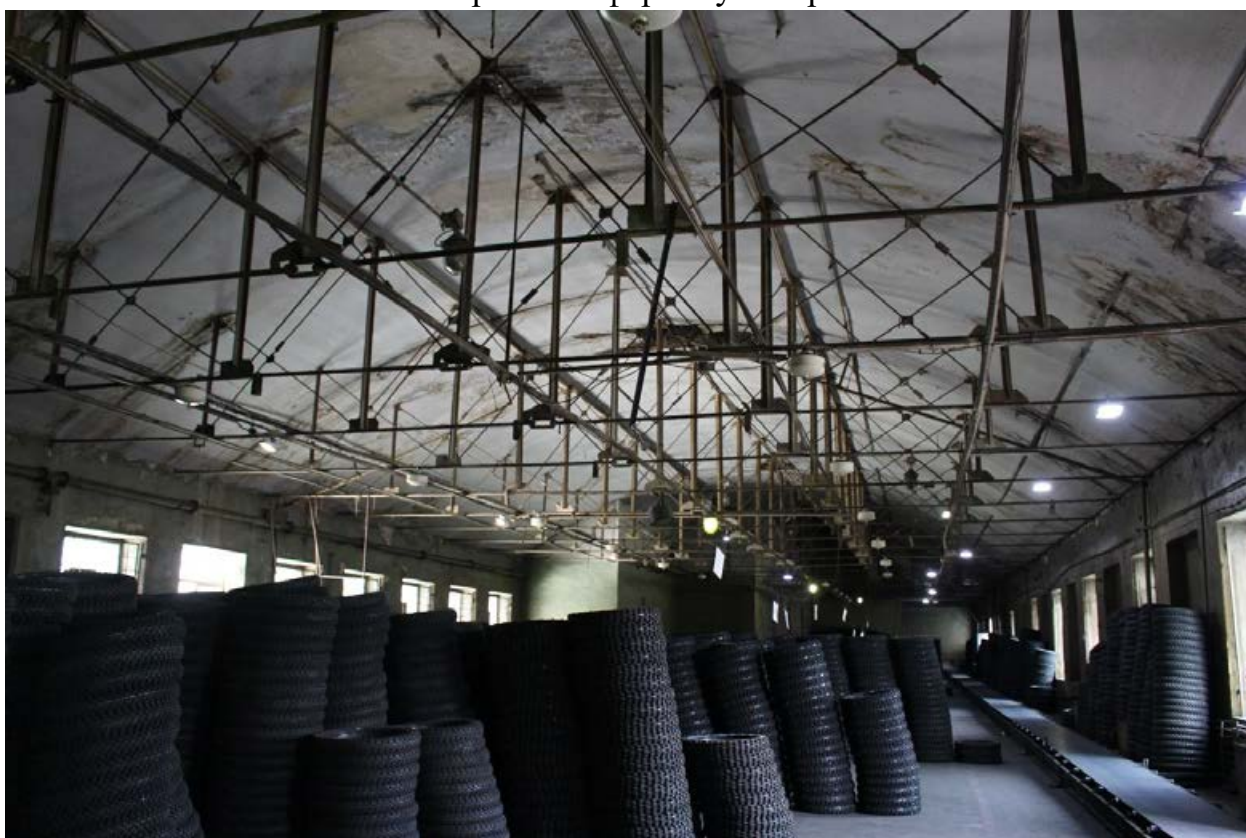
Фото 44. Общий вид южного покрытия 4 этажа.
