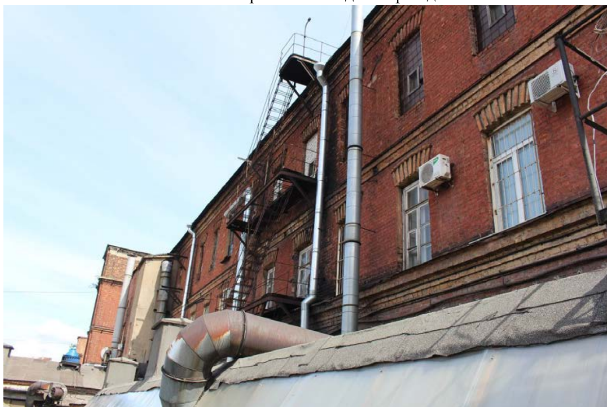
Фото 18. Вид с юга на северную часть западного фасада.
