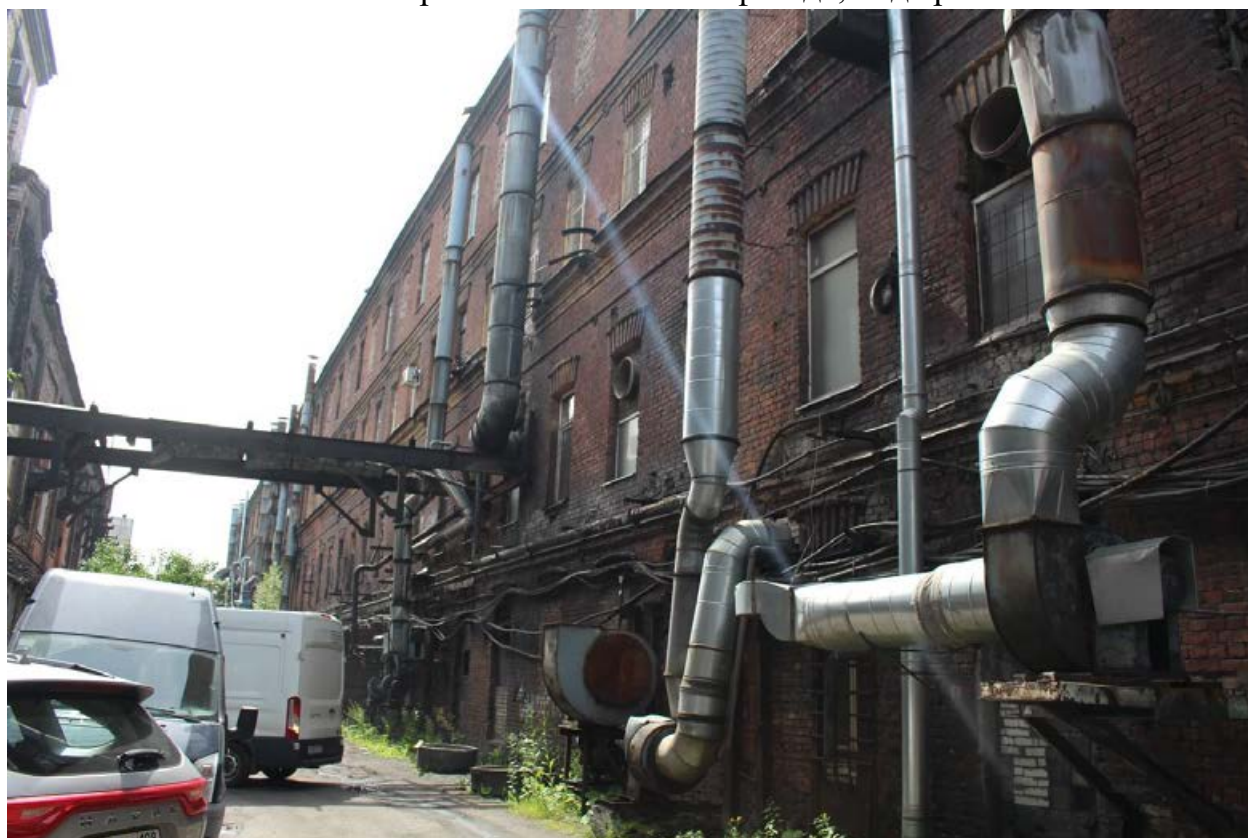
Фото 34. Вид с северо-востока на восточный фасад.
