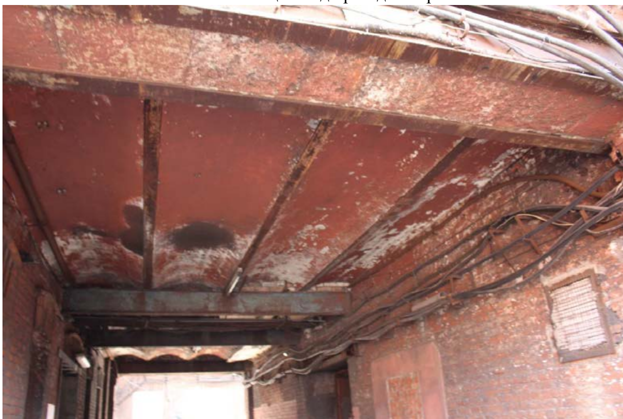
Фото 28. Перекрытие проездной арки.
