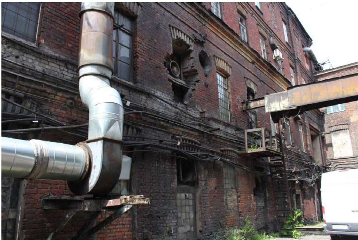
Фото 35. Фрагмент восточного фасада.
