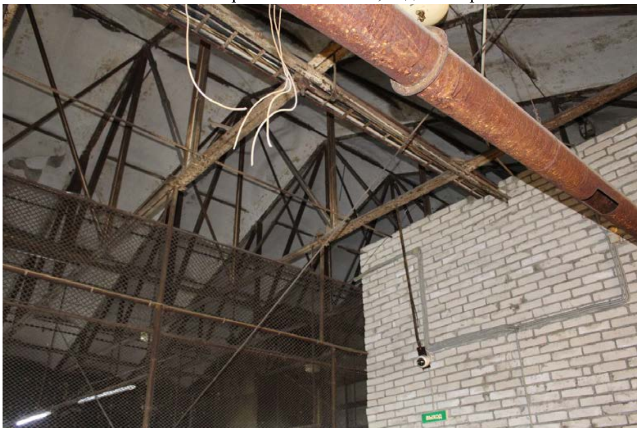
Фото 40. Фрагмент северного помещения, 4 этаж.
