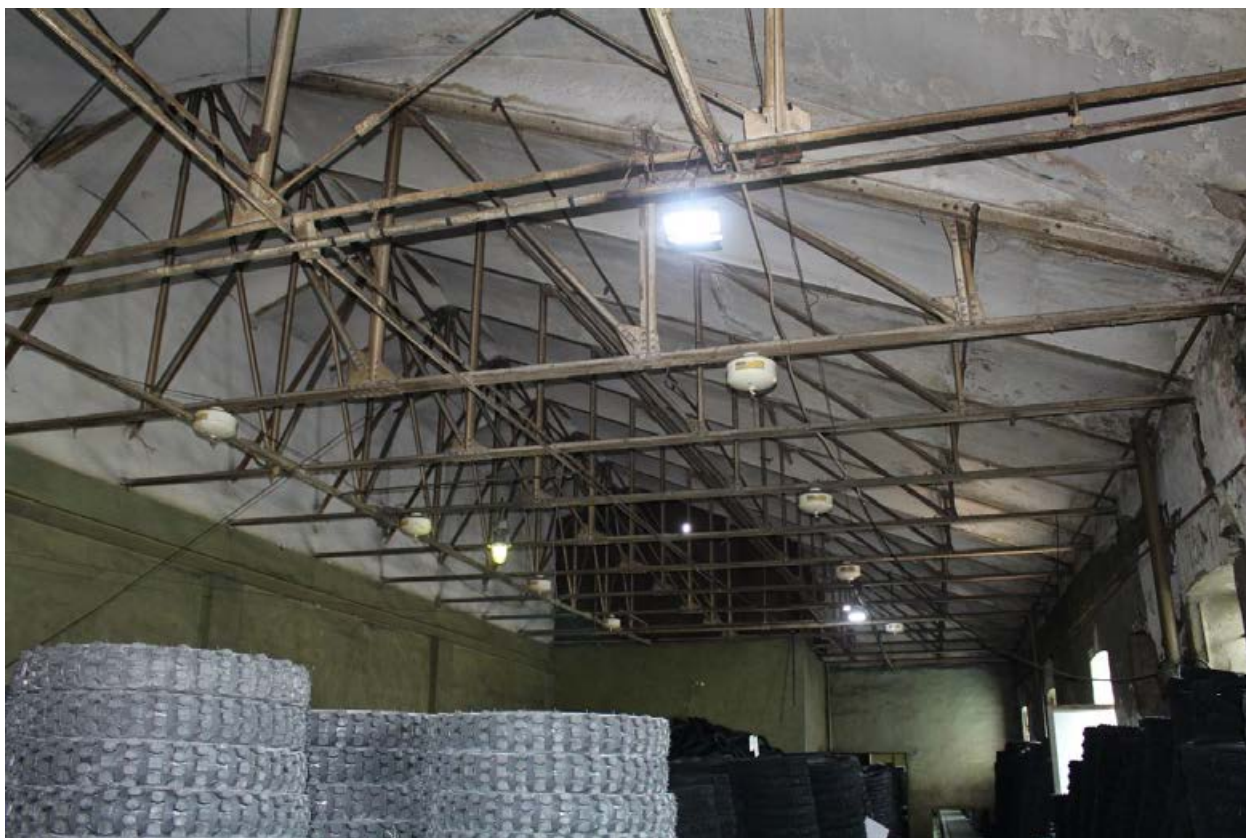
Фото 45. Юго-восточная часть северного участка 4 этажа.
