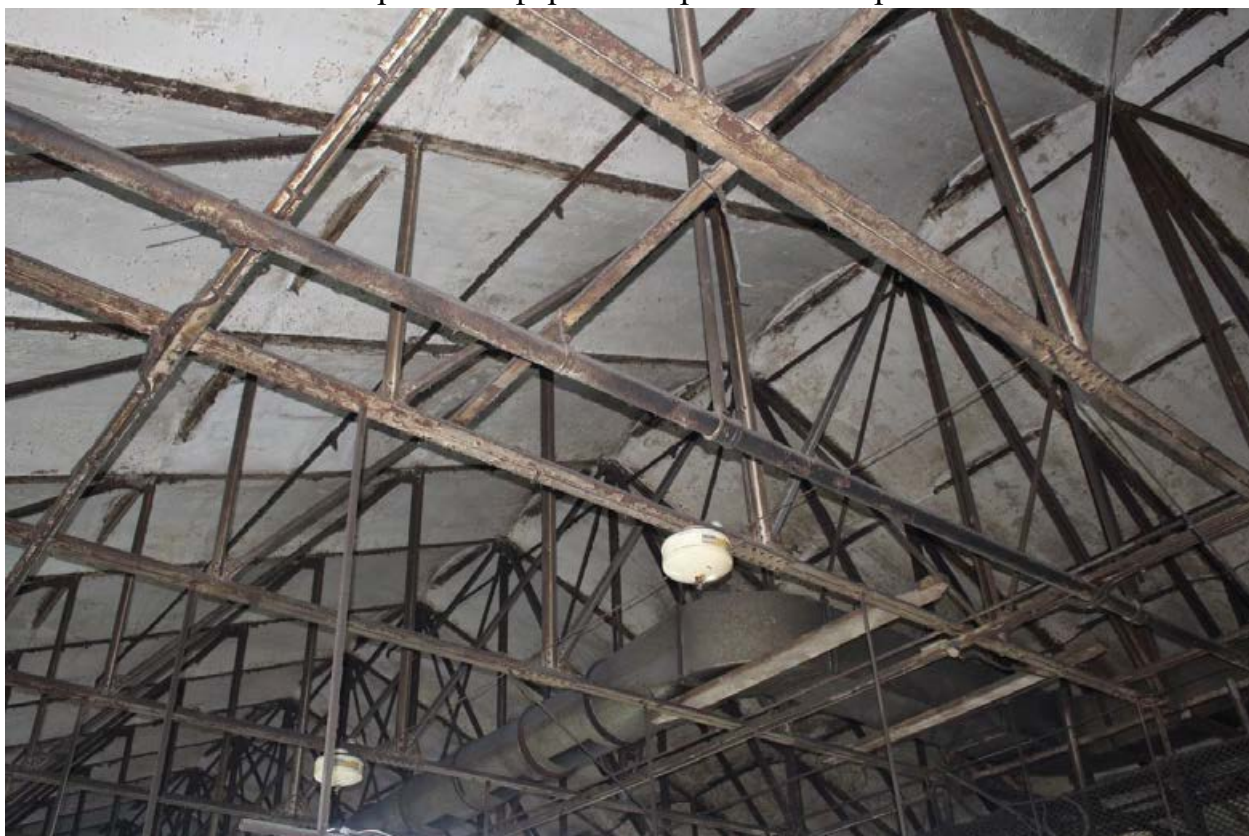
Фото 42. Фермы северной части 4 этажа.
