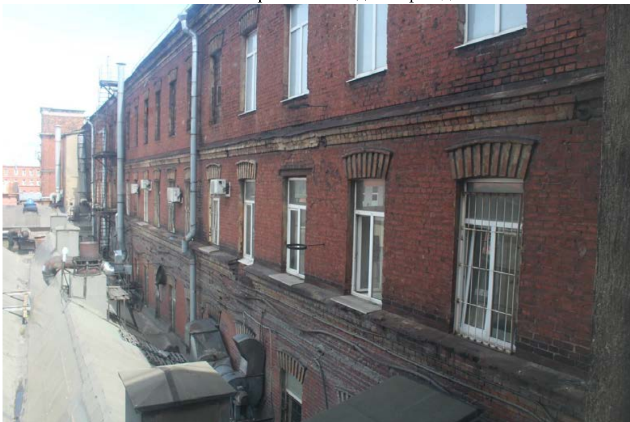
Фото 26. Вид на западный фасад с лестницы.
