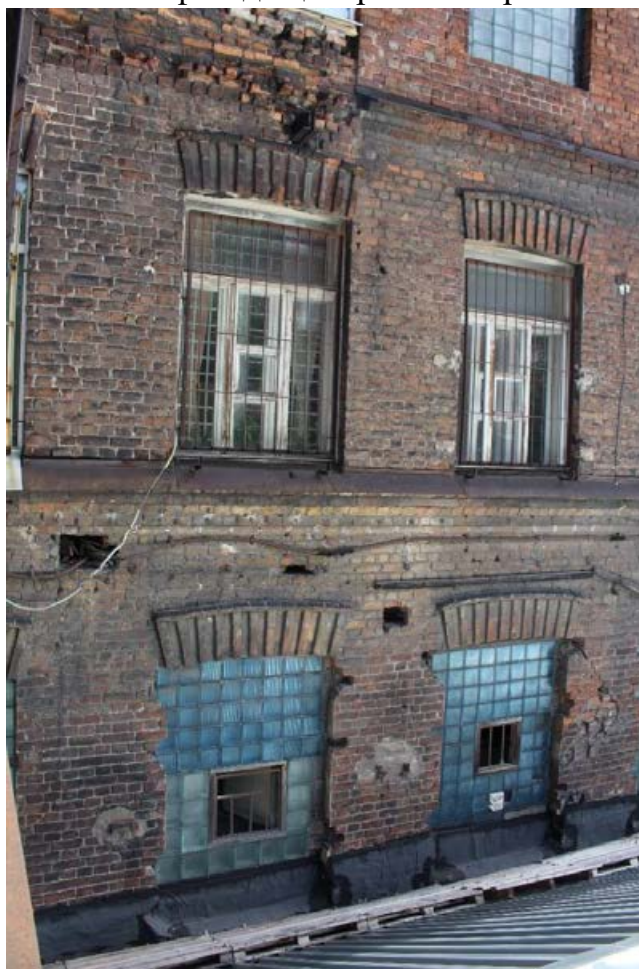
Фото 24. Фрагмент южной части западного фасада.
