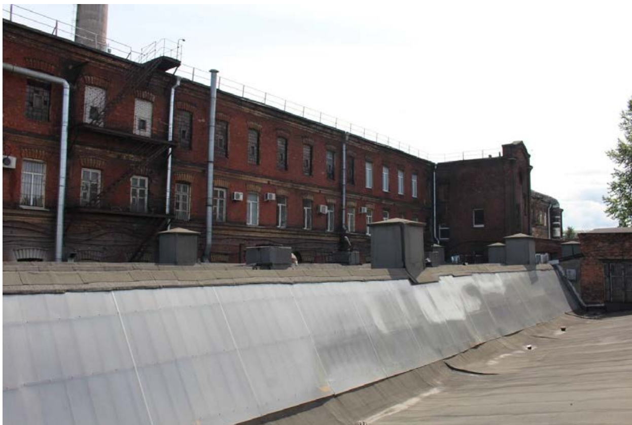
Фото 11. Общий вид западного фасада.
