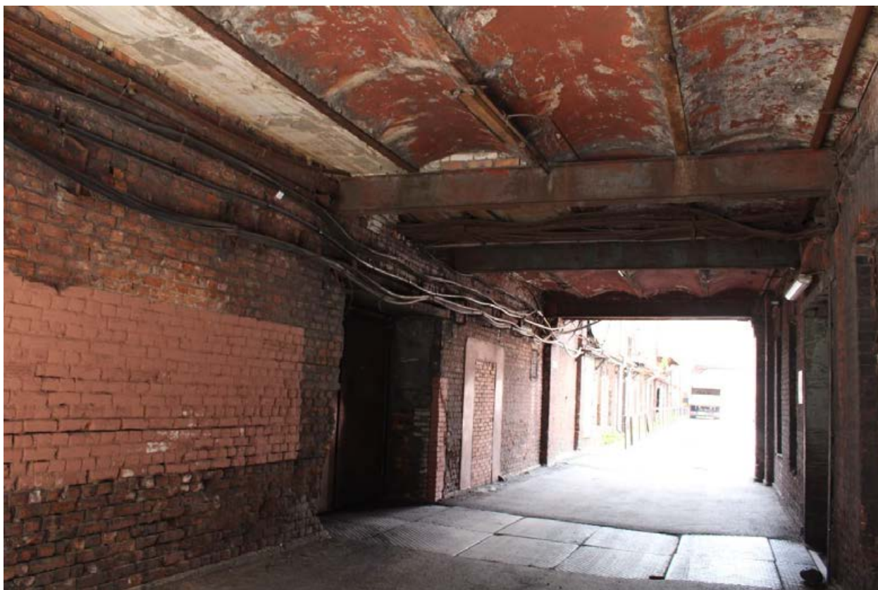
Фото 29. Вид проездной арки с востока.
