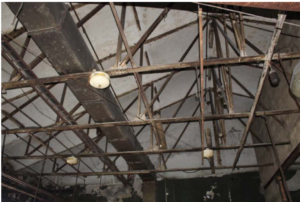
Фото 43. Покрытие и фермы у северной стены.
