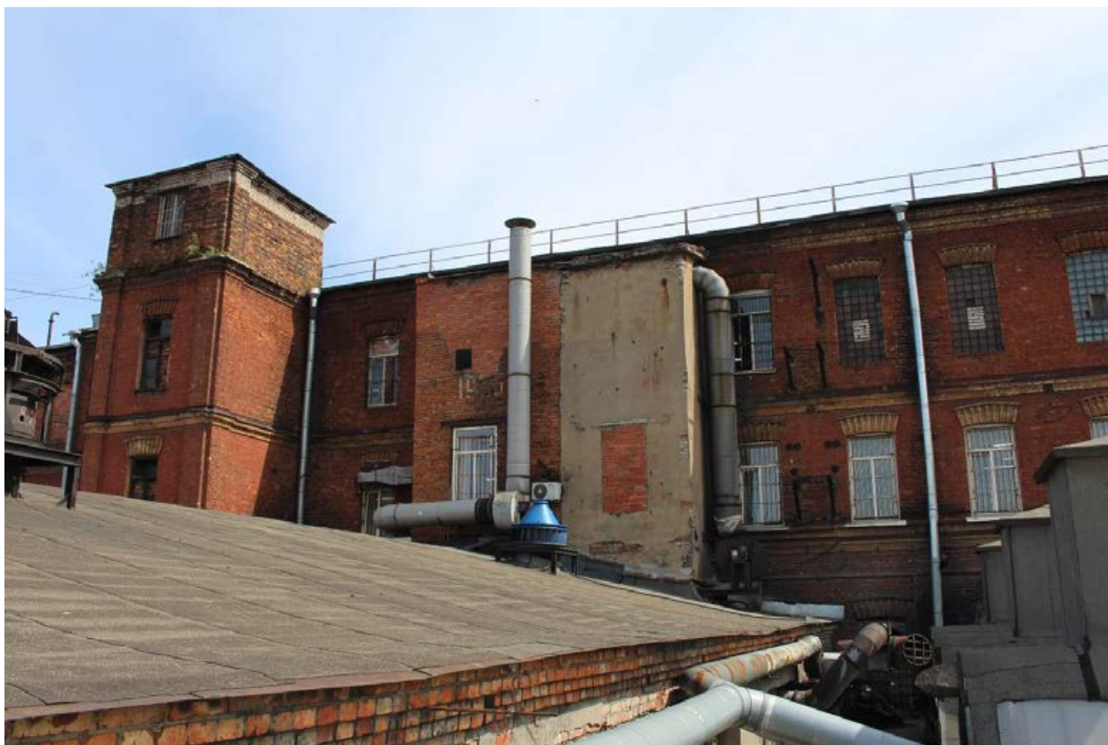
Фото 13. Вид на северный ризалит на западном фасаде
