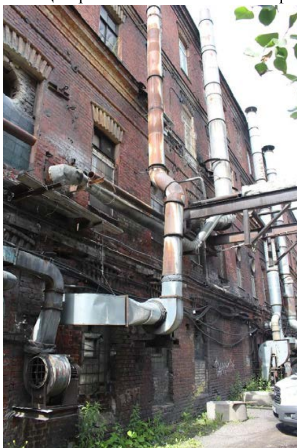
Фото 38. Фрагмент восточного фасада.
