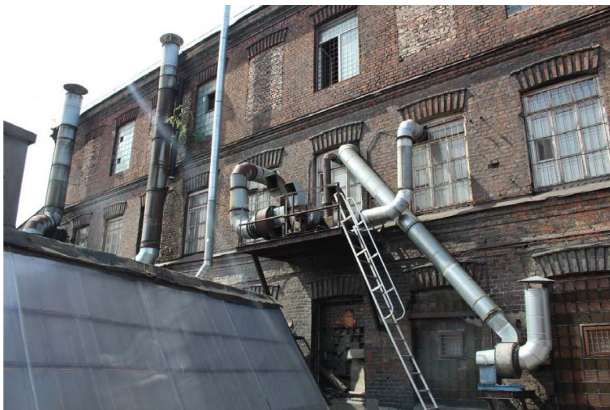
Фото 3. Южный фрагмент восточного фасада.
