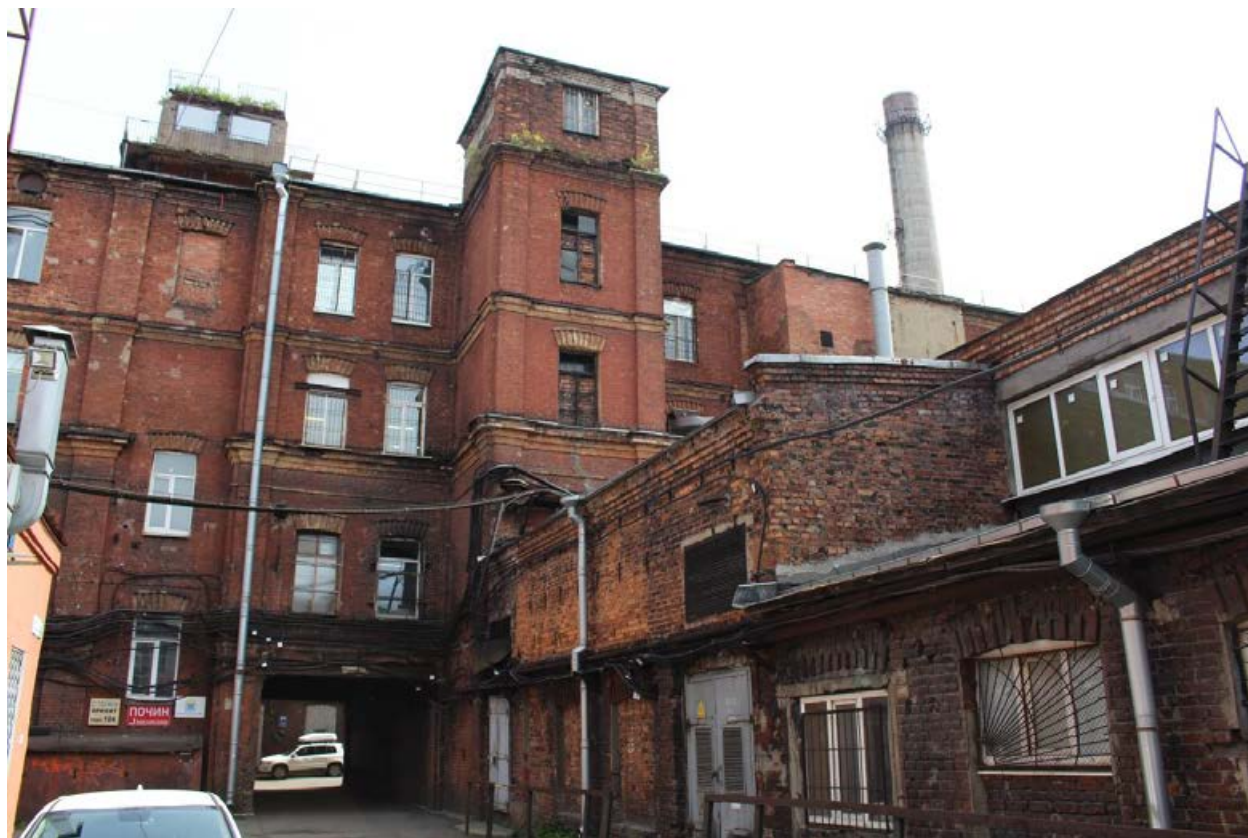
Фото 31. Общий вид с запада.
