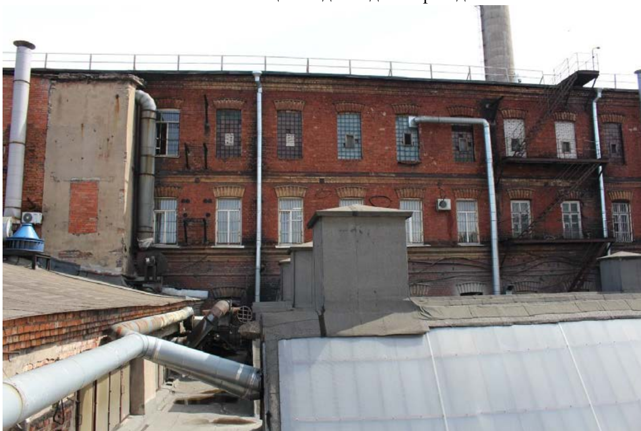
Фото 12. Северный фрагмент западного фасада.
