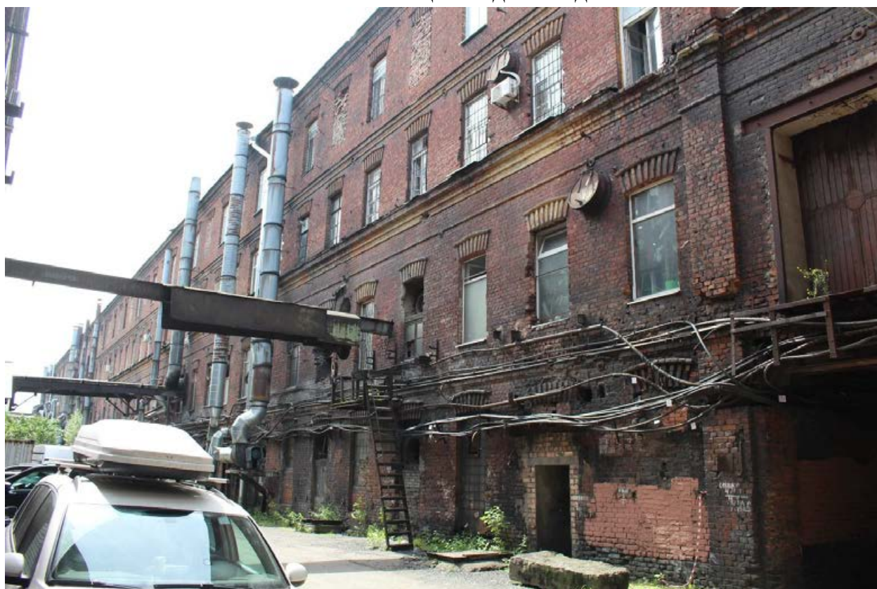
Фото 32. Общий вид с востока.
