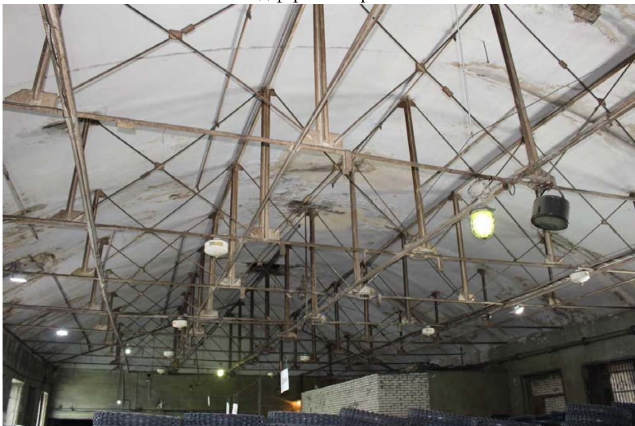
Фото 48. Вид с севера 4 этажа.
