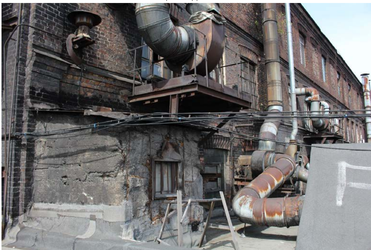
Фото 6. Юго-восточный угол, вид с юга.
