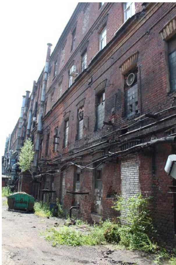
Фото 37. Центральная часть восточного фасада.
