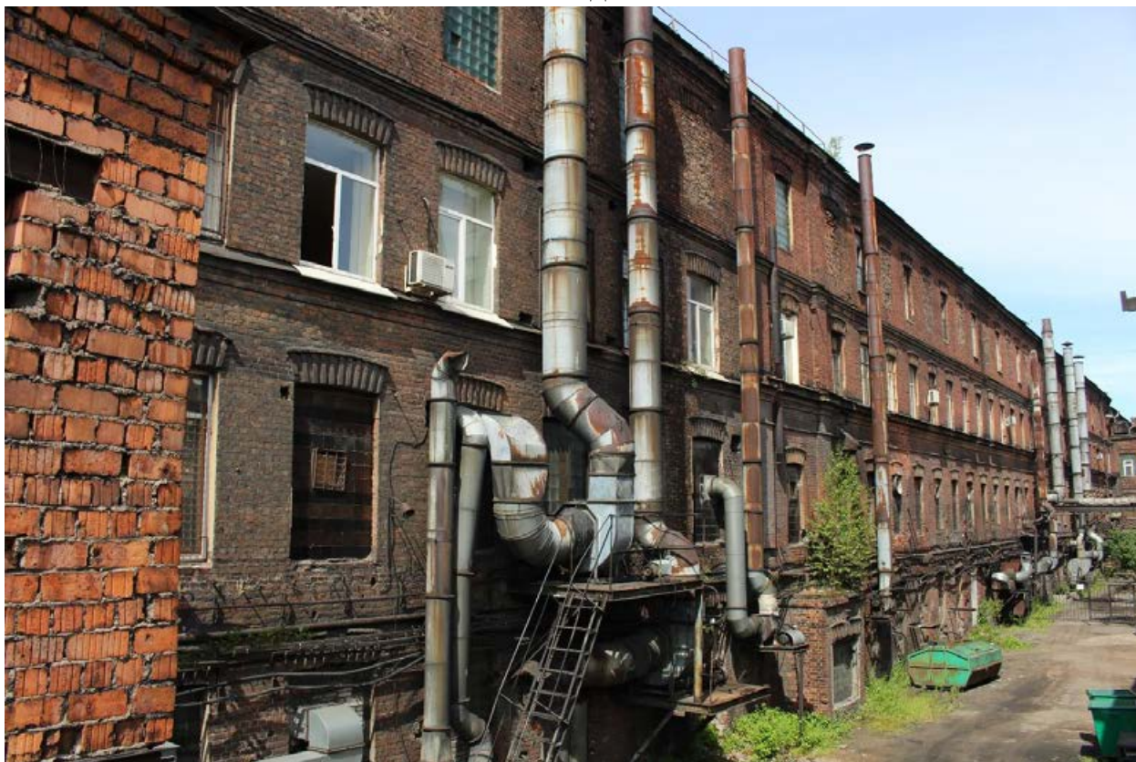
Фото 1. Общий вид восточного фасада.
