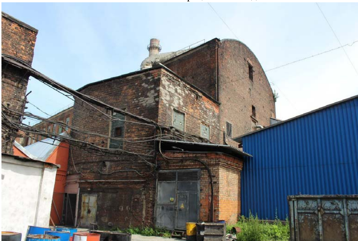
Фото 20. Общий вид с юго-запада.
