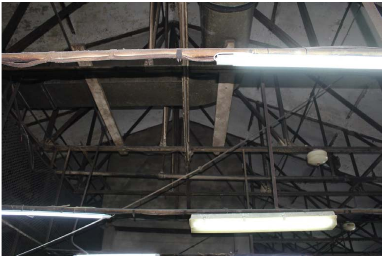
Фото 41. Фрагмент ферм и покрытия в северной части.
