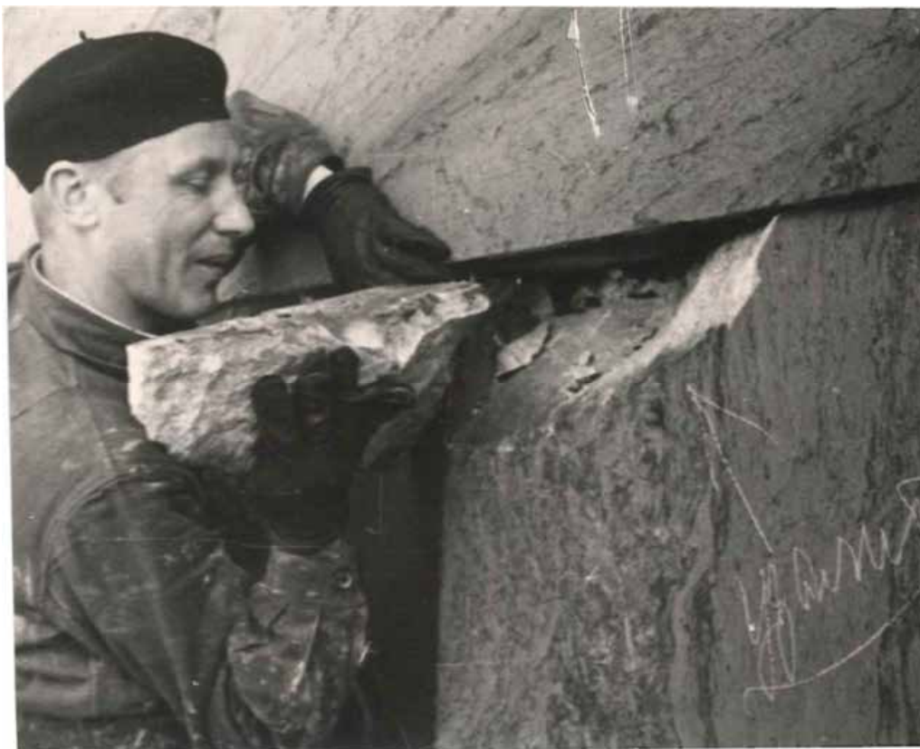
28. Выемка отколотых кусков из облицовки фасада. Архив ЦГАЛИ СПб. Ф. 598. Оп 1. Д. 55. Л. 6.
