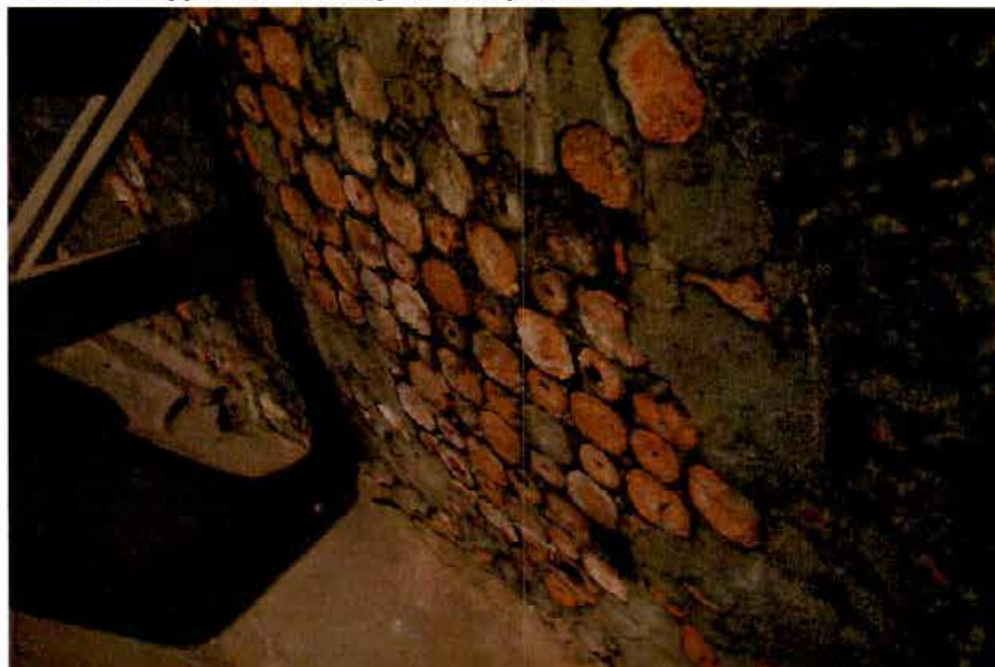
24. Теплоизолирующий слой среднего купола
