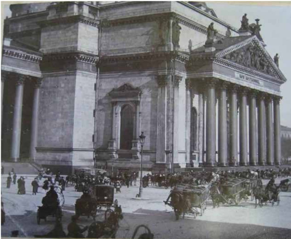
26. Общий вид фасада С-З угол. Архив КГИОП. Фотоальбом А-219.Л 19. Дата фото до 1917 г.
