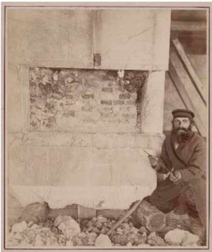
24. Замена мраморного блока. Архив РГИА СПб. Ф 502 Оп. 3 Д. 2 Л. 6. 1873 г.
