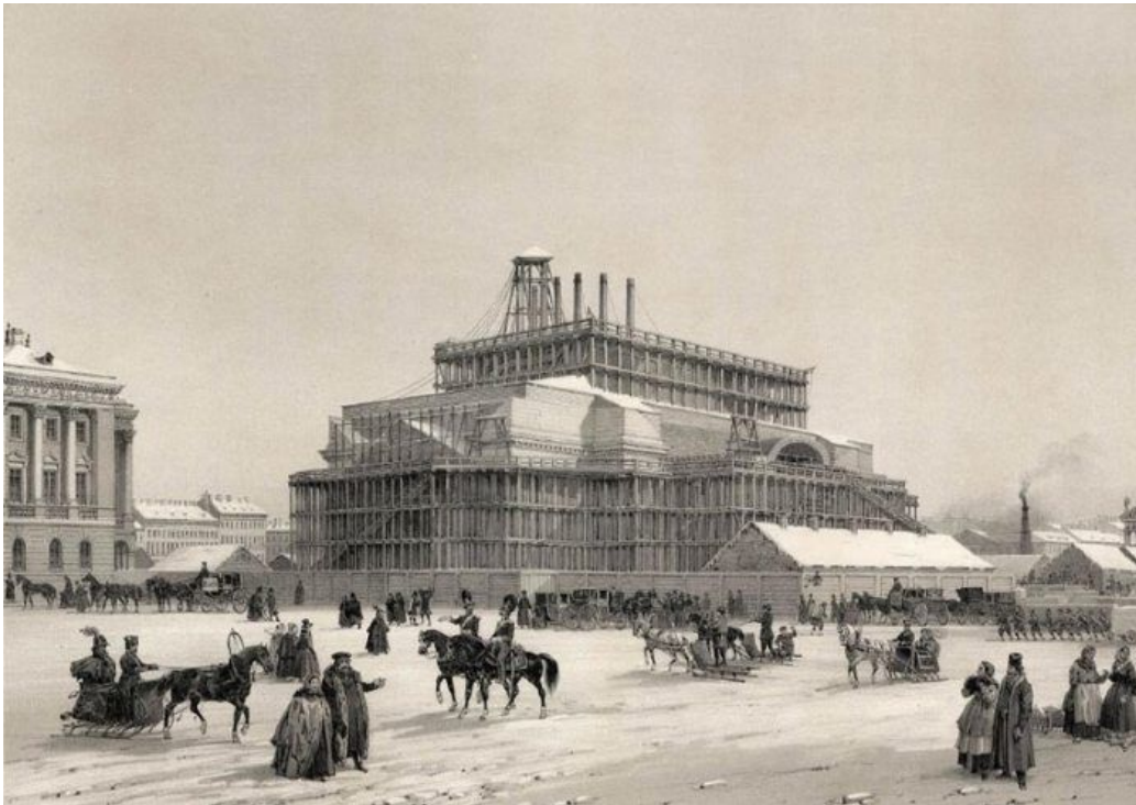
14. Вид строящегося Исаакиевского собора в 1838 г. Литография с тоном. Ф. Бенуа, по оригиналу О. Монферрана.
