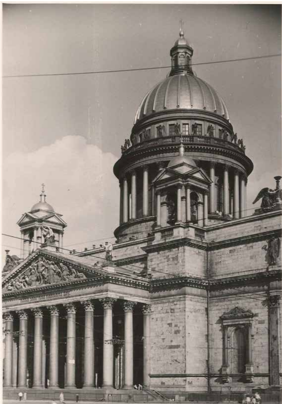
29. На фасаде, ниже северной балюстрады С-З колокольни видны подтеки воды, как на поверхности, так и вымывающие кальциты из кладки. Архив ЦГАЛИ СПб. Ф. 598. Оп 1. Д. 68. Л.21. Фото сделано в период 1945-1964 гг.
