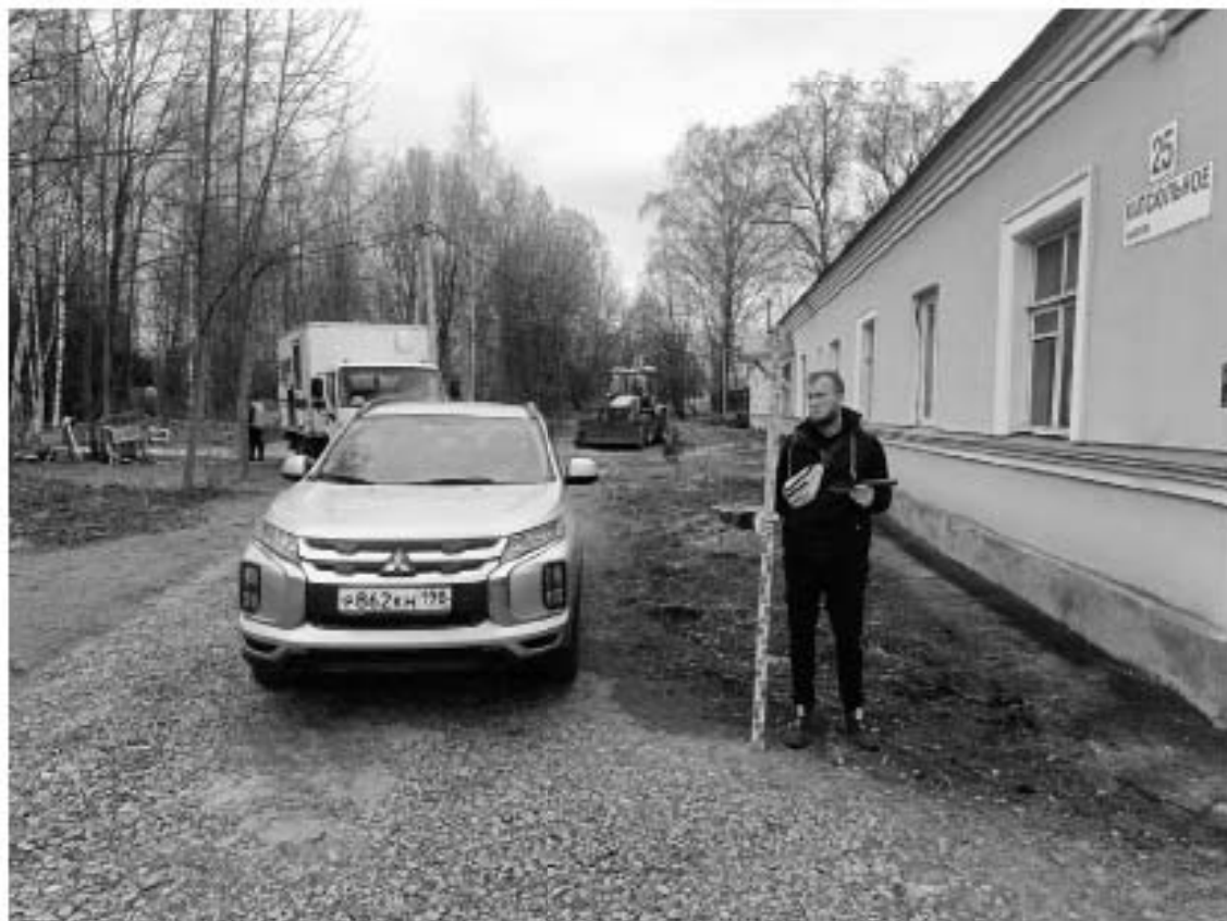
Рис. 42. СПб-2025. Р. Охта, Лубья, ручьи Безьямный, Горелый. Точка фотофиксации 14, вид с запада.
