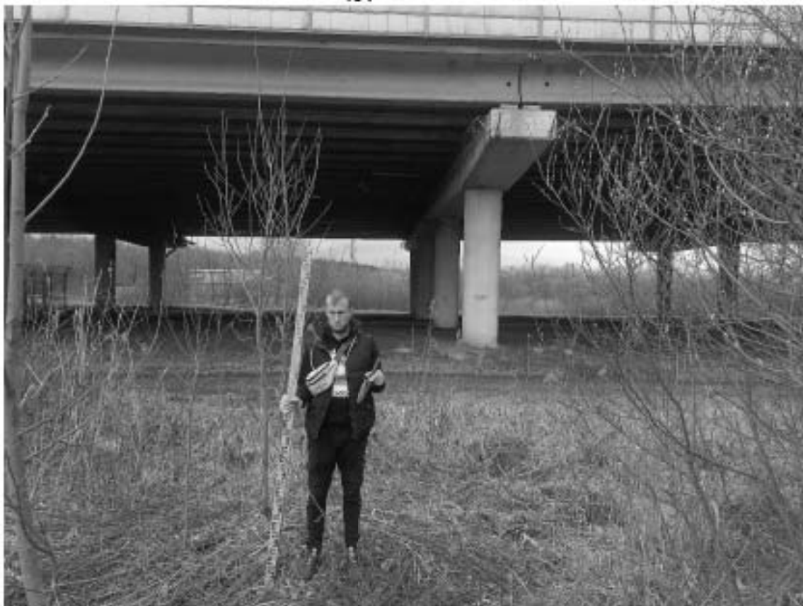
Рис. 93. СПб-2025. Р. Охта, Лубья, ручьи Безымянный, Горельи. Точка фотофиксации 34, вид с юга.
