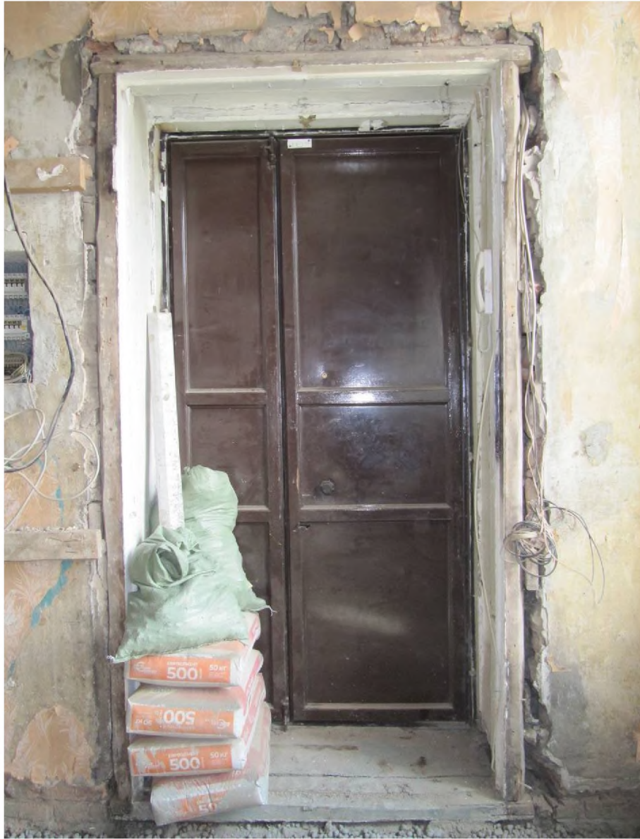
4. Вид на вход в помещение квартиры №77.
