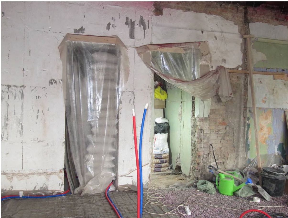
11. Вид в помещении квартиры № 77 (вход в пом.2 из пом.1).
