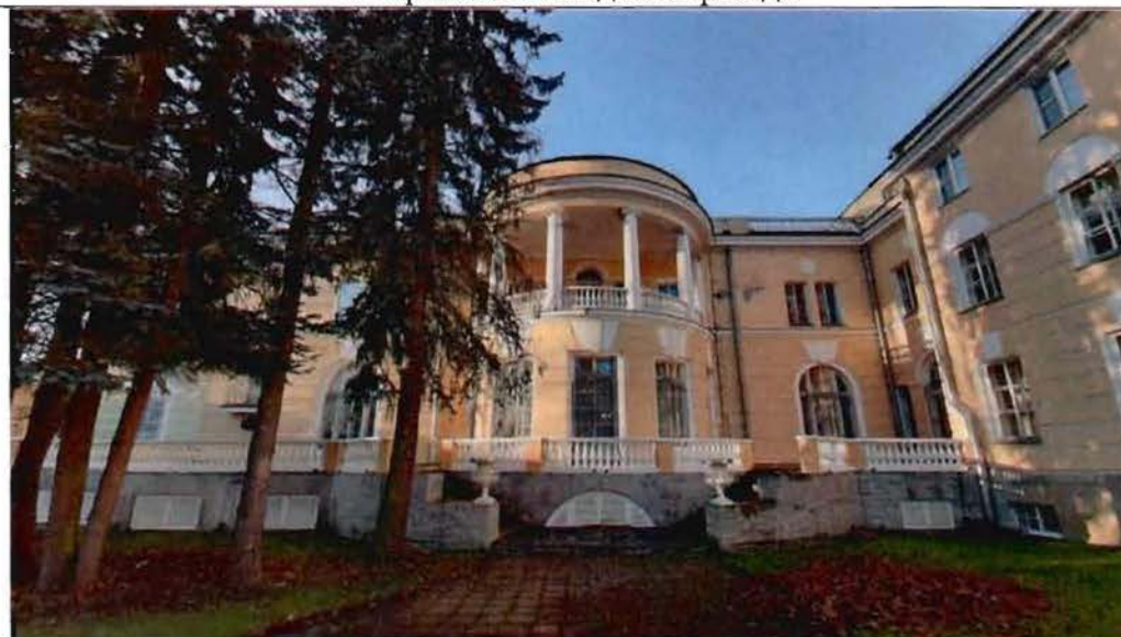
2. Фрагмент восточного фасада
