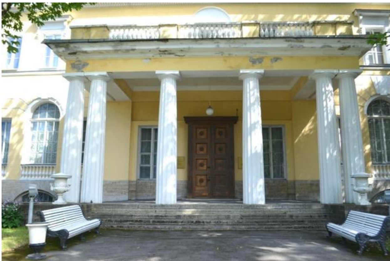
Фото 11. Особняк Кочубея В.П. (Пушкин, ул. Радищева, 4). Шестиколонный портик. Съёмка 15.07.2020 г.
