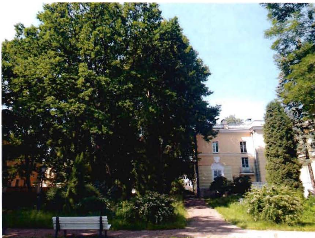
5. Южная часть объекта культурного наследия.
