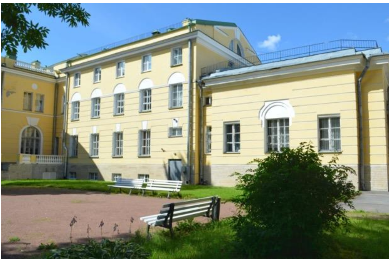
Фото 26. Особняк Кочубея В.П. (Пушкин, ул. Радищева, 4). Площадка перед террасой восточного фасада особняка, фрагмент. Съёмка 15.07.2020 г.
