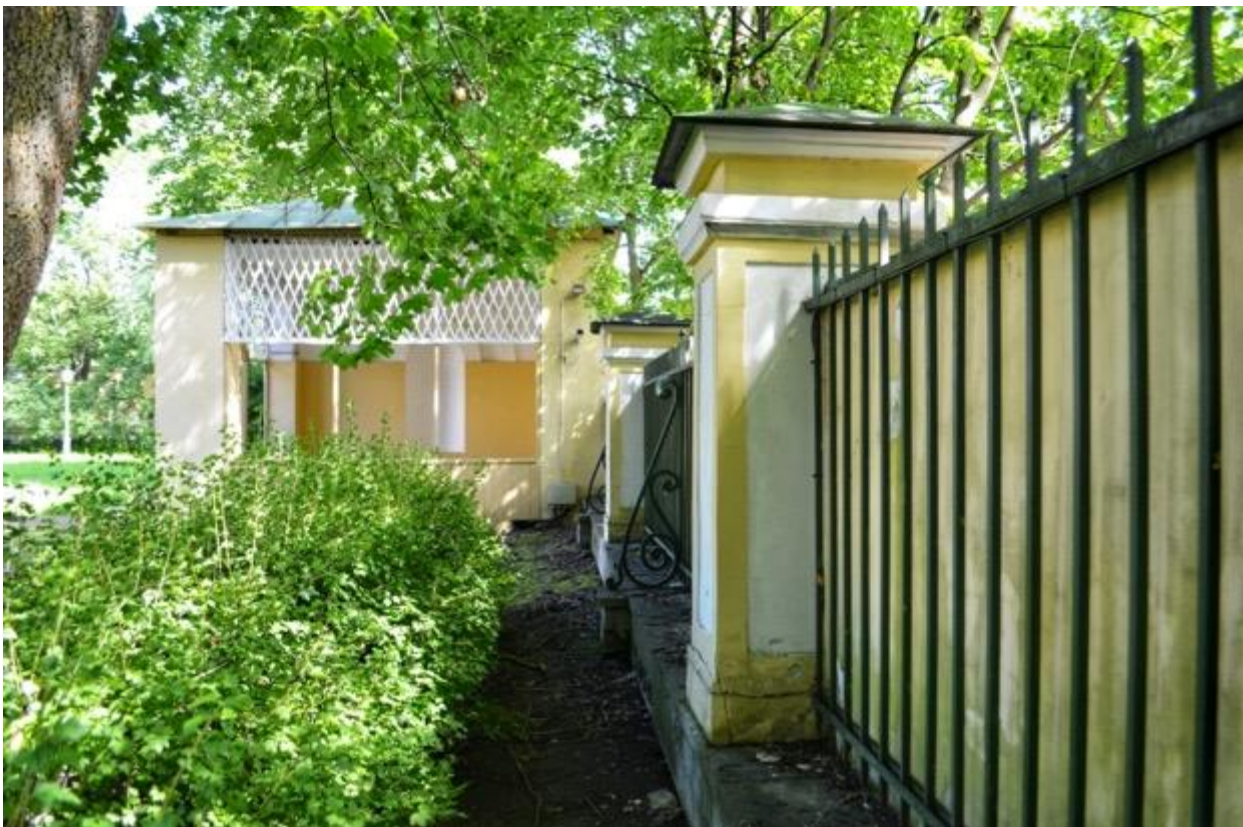
Фото 19. Особняк Кочубея В.П. (Пушкин, ул. Радищева, 4). Ограда вдоль южной границы владельческого участка, вид с запада на беседку в саду. Съёмка 15.07.2020 г.
