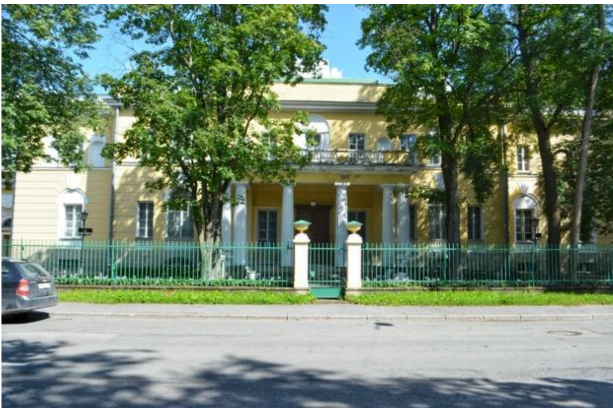
Фото 01. Особняк Кочубея В.П. (Пушкин, ул. Радищева, 4). Лицевой фасад особняка, ограда. Общий вид. Съёмка 15.07.2020 г.
