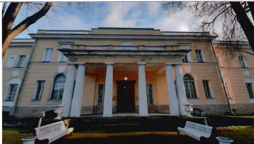
1. Фрагмент западного фасада
