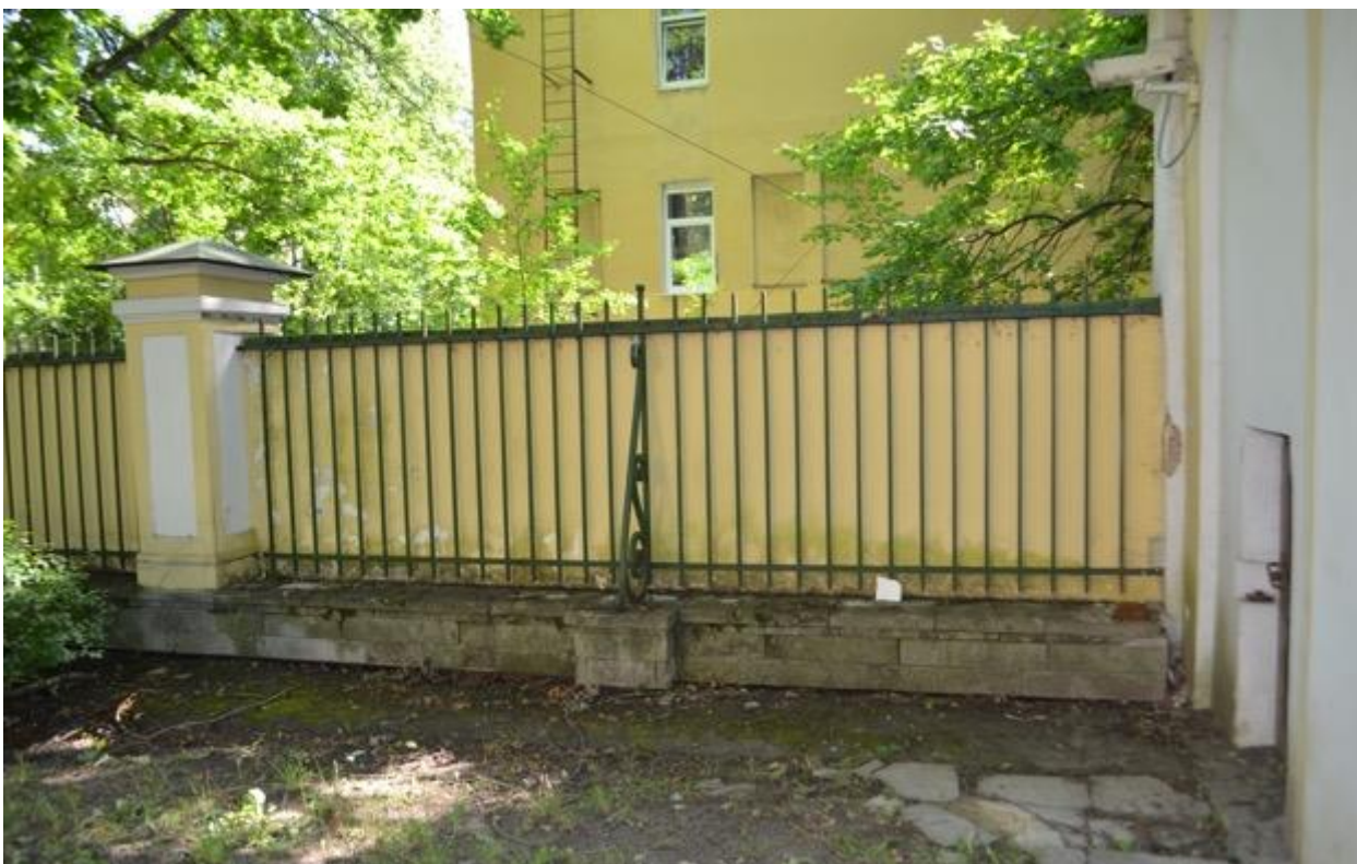
Фото 17. Особняк Кочубея В.П. (Пушкин, ул. Радищева, 4). Ограда вдоль южной границы владельческого участка у павильона бывшей электрической подстанции, фрагмент. Съёмка 15.07.2020 г.
