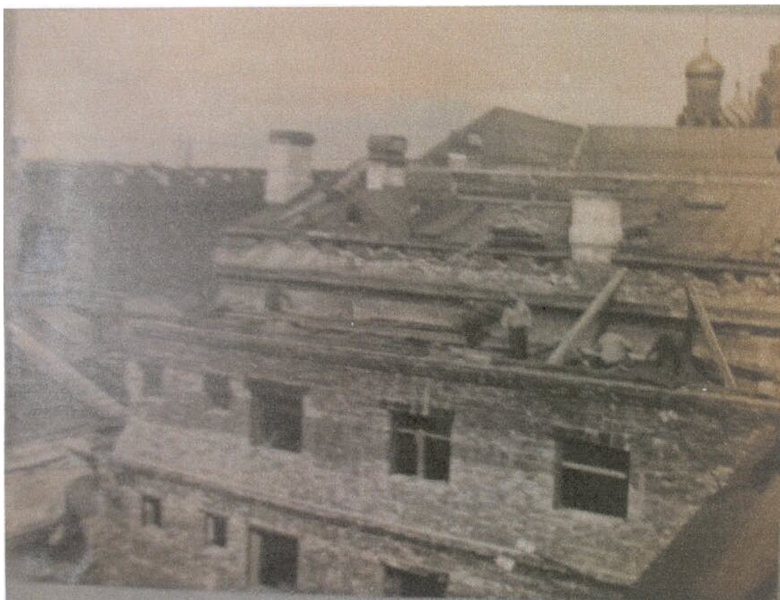
20. МАЛЕГОТ. Строительство репетиционных залов и гримуборных на месте электростанции театра. 1936
