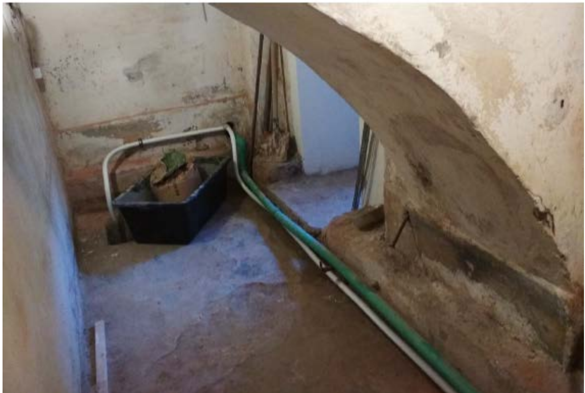
22. Стена и полы подвала здания объекта культурного наследия федерального значения «Дом Голенищева - Кутузова П.В., 1820-е гг., 1830-е гг. (фасады), арх. Росси К.И. Здесь в 1924 - 1939 гг. жил художник Бродский И.И.», расположенного по адресу: г. Санкт-Петербург, пл. Искусств, д. 3, литера А. 15.09.2020
