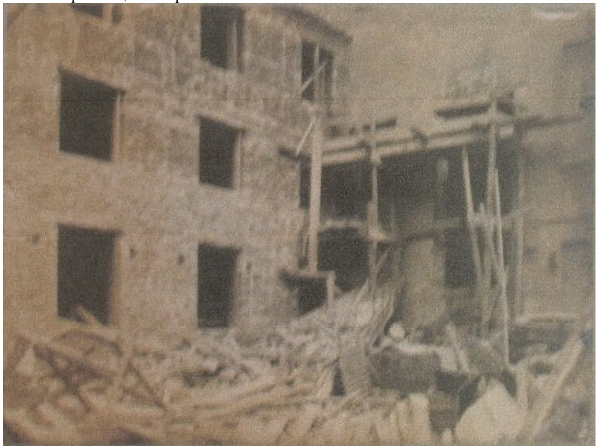
19. Расширение помещений гримбуорных. Вид со двора наб. Канала Грибоедова. 1936
