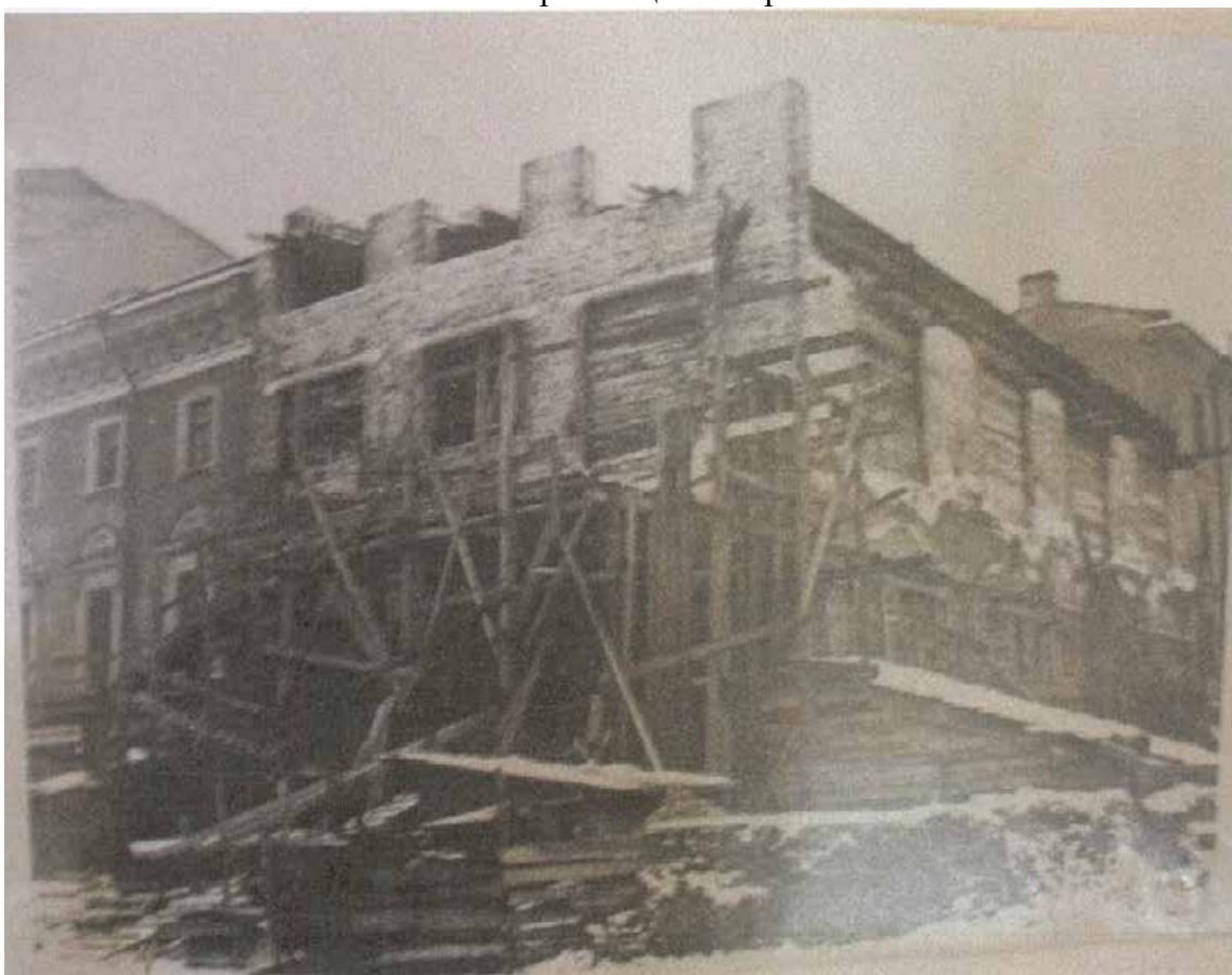
21. МАЛЕГОТ. Строительство репетиционных залов и гримуборных на месте электростанции театра. 1936-1937
