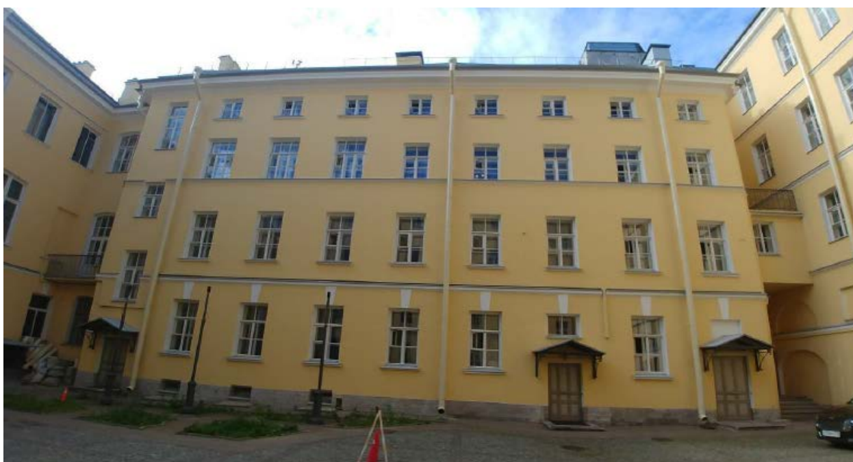
7. Южный дворовый фасад объекта культурного наследия федерального значения «Дом Голенищева - Кутузова П.В., 1820-е гг., 1830-е гг. (фасады), арх. Росси К.И. Здесь в 1924 - 1939 гг. жил художник Бродский И.И.», расположенного по адресу: г. Санкт-Петербург, пл. Искусств, д. 3, литера А. 15.09.2020
