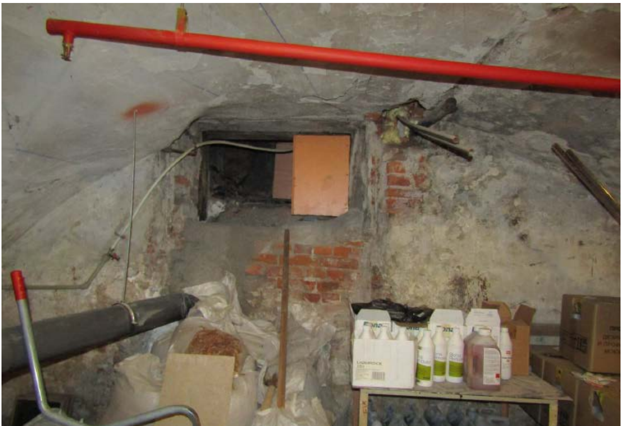
14. Стена подвала здания объекта культурного наследия федерального значения «Театр Михайловский 1831-1833 гг., арх. Росси К.И., арх. Брюллов А.П.», расположенного по адресу: г. Санкт-Петербург, пл. Искусств, д. 1, литера А. 15.09.2020
