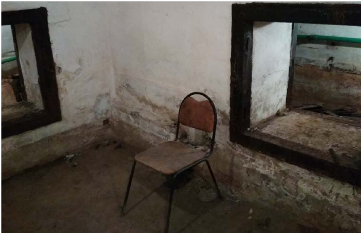
20. Стена и полы подвала здания объекта культурного наследия федерального значения «Дом Голенищева - Кутузова П.В., 1820-е гг., 1830-е гг. (фасады), арх. Росси К.И. Здесь в 1924 - 1939 гг. жил художник Бродский И.И.», расположенного по адресу: г. Санкт-Петербург, пл. Искусств, д. 3, литера А. 15.09.2020
