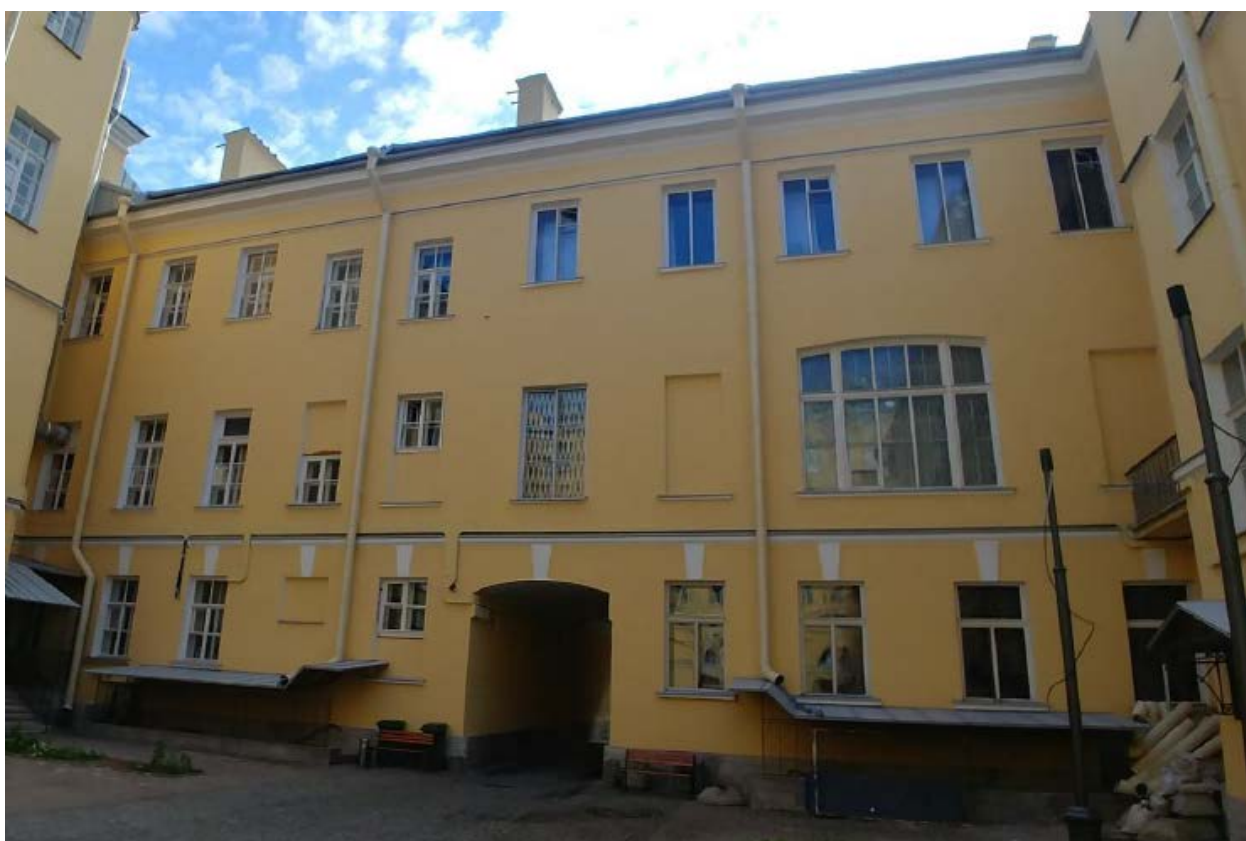
10. Восточный дворовый фасад объекта культурного наследия федерального значения «Дом Голенищева - Кутузова П.В., 1820-е гг., 1830-е гг. (фасады), арх. Росси К.И. Здесь в 1924 - 1939 гг. жил художник Бродский И.И.», расположенного по адресу: г. Санкт-Петербург, пл. Искусств, д. 3, литера А. 15.09.2020
