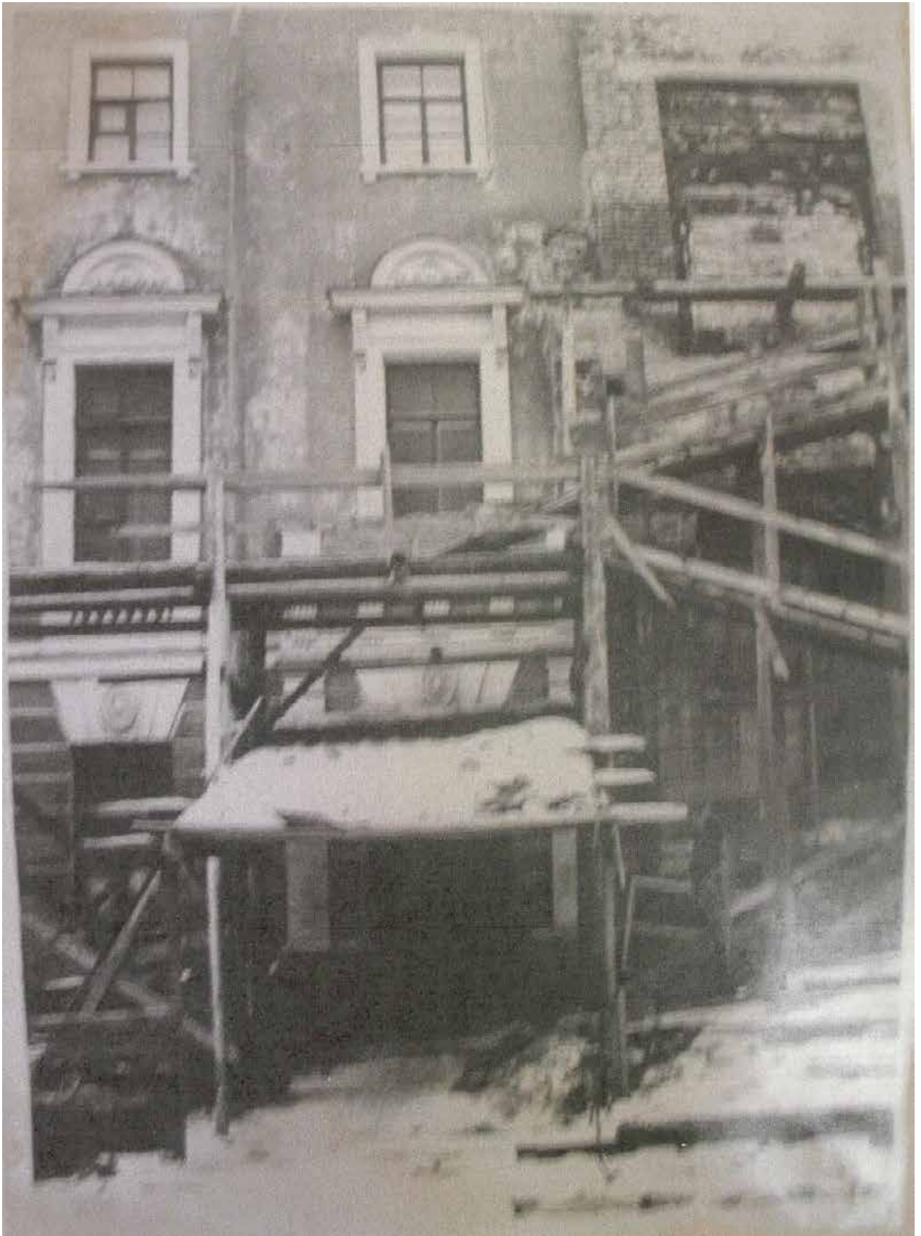
22. МАЛЕГОТ. Строительство репетиционных залов и гримуборных на месте электростанции театра. 1936
