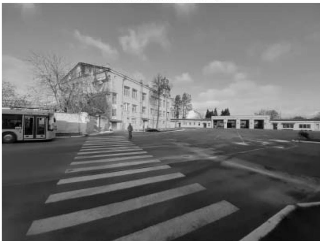
Рис. 28. Санкт-Петербург, Днепропетровская ул., д. 18, литера А. Общий вид участка. Точка съемки 4. Вид на северо-запад.
