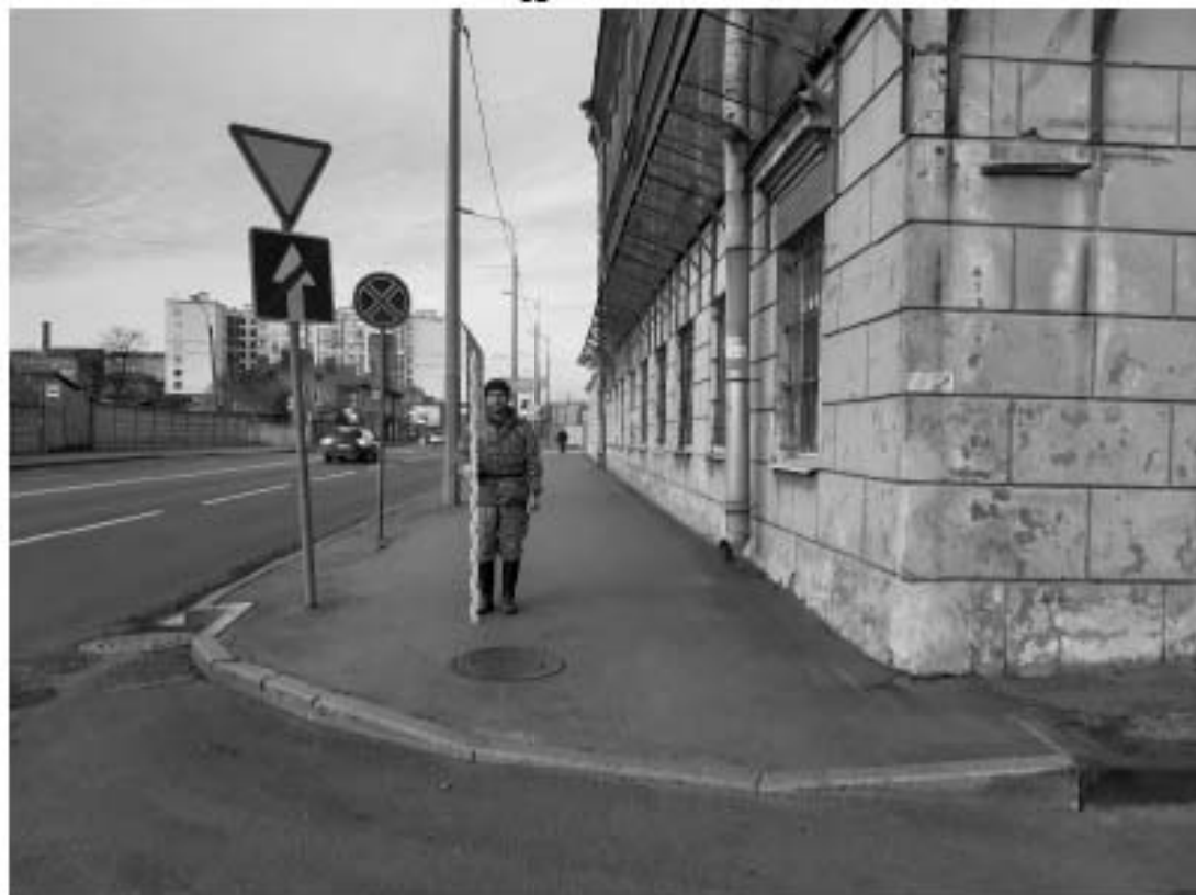
Рис. 31. Санкт-Петербург, Днепропетровская ул., д. 18, литера А. Общий вид участка. Точка съемки 8. Вид на север.
