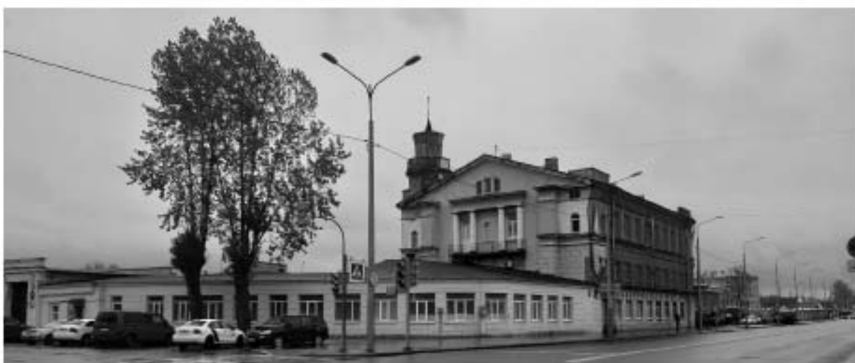
Рис. 18. Лицевой фасад административного корпуса Первого автобусного парка 2021 г.
