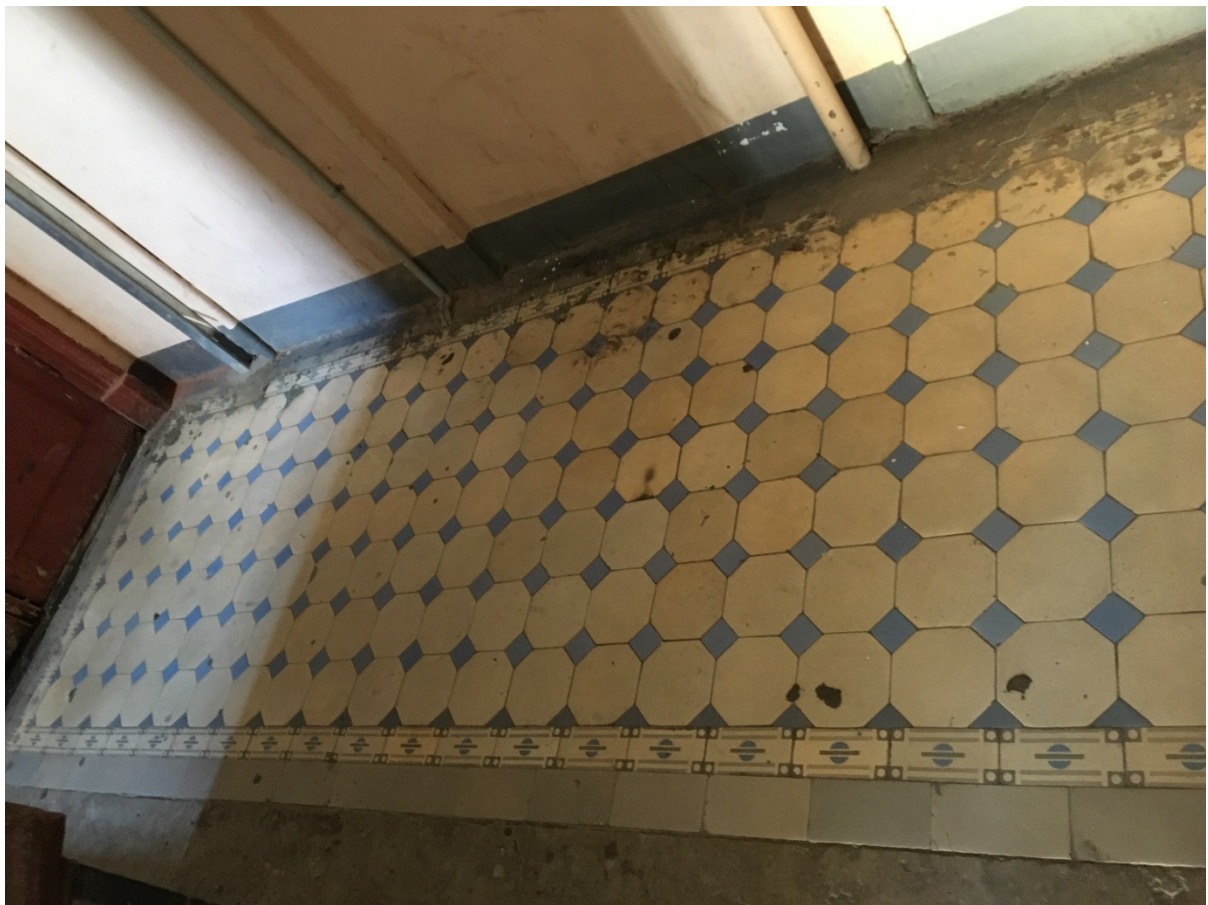
25. Парадная лестница Л-1. Покрытие пола площадки 3 этажа. 26.04.2021
