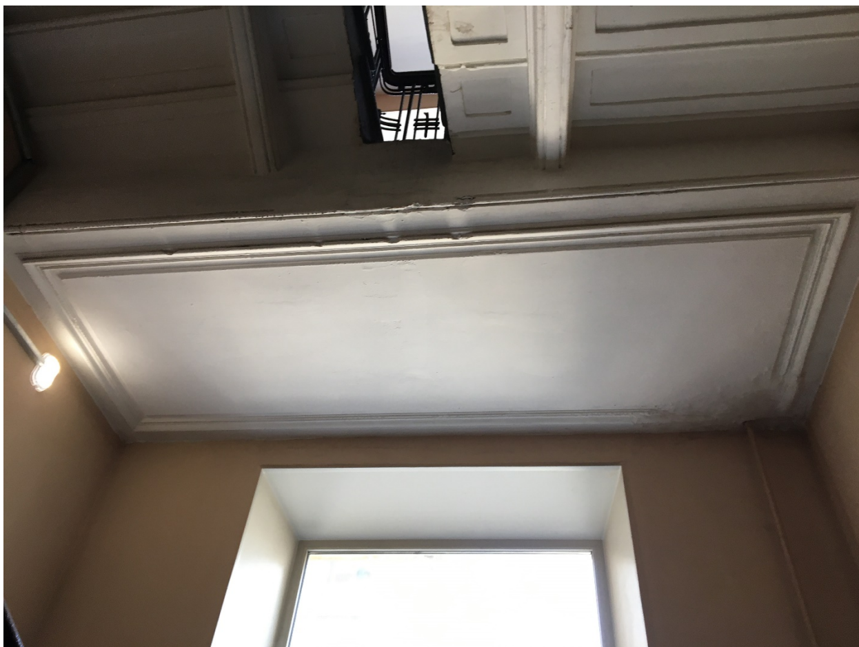
26. Парадная лестница Л-1. Оформление основания площадки между 5 и 6 этажами. 26.04.2021
