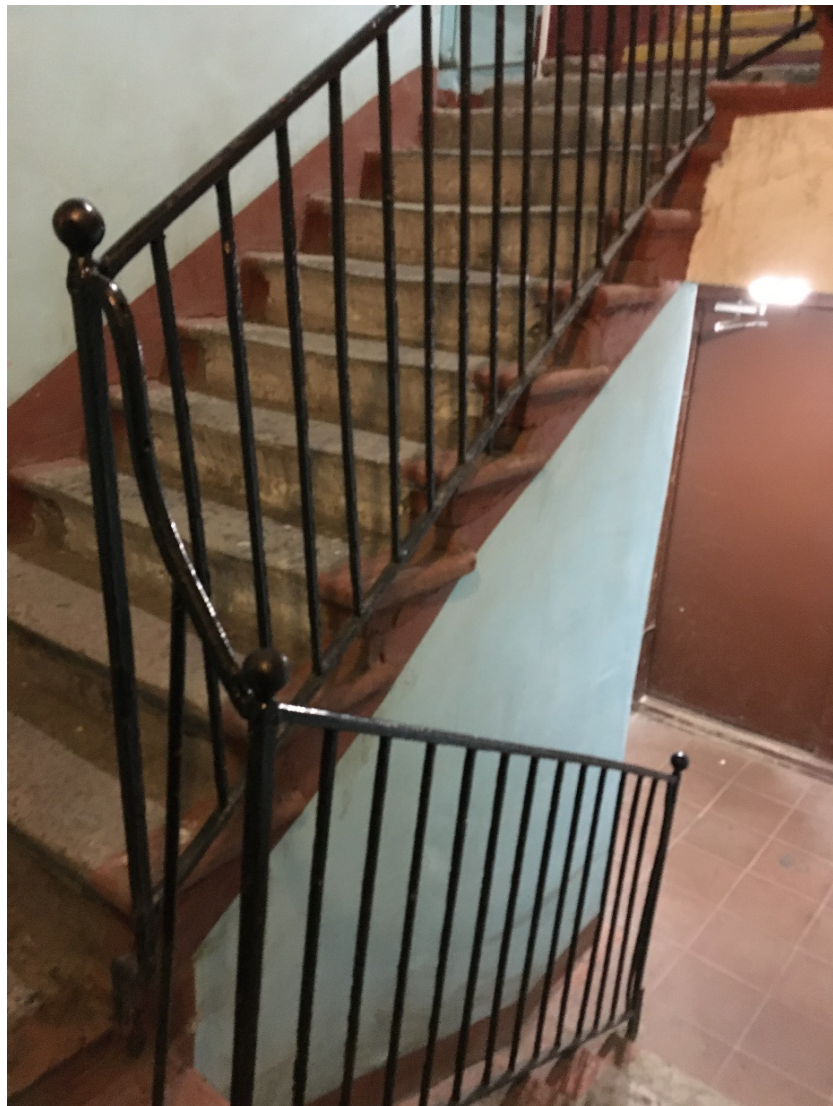
28. Лестница Л-2. Общий вид. 26.04.2021
