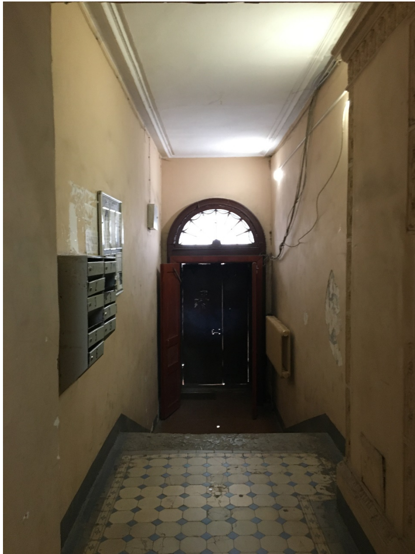
21. Парадная лестница Л-1. Парадный вестибюль. 26.04.2021
