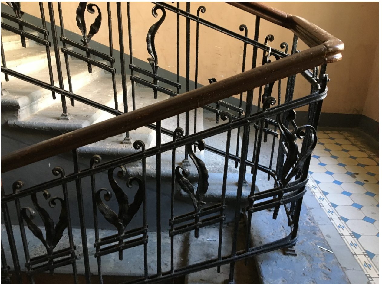
24. Парадная лестница Л-1. Ограждения лестницы. 26.04.2021
