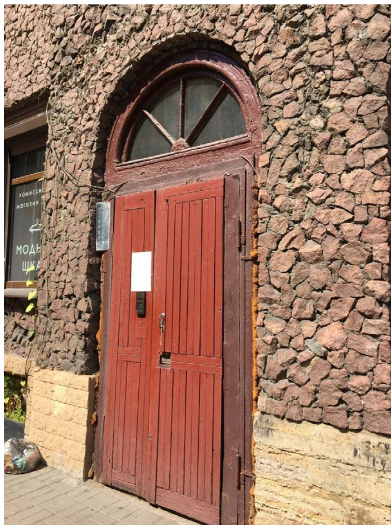
10. Лицевой фасад выявленного объекта культурного наследия «Дом Потаповой (Н.В. Иванова)», расположенного по адресу: г. Санкт-Петербург, Некрасова ул., д. 36. Фрагмент. Заполнение проема парадной лестницы Л-1. 26.04.2021
