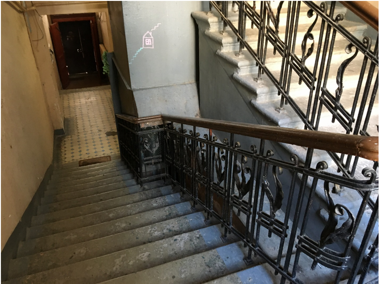
22. Парадная лестница Л-1. Ограждение лестницы. 26.04.2021
