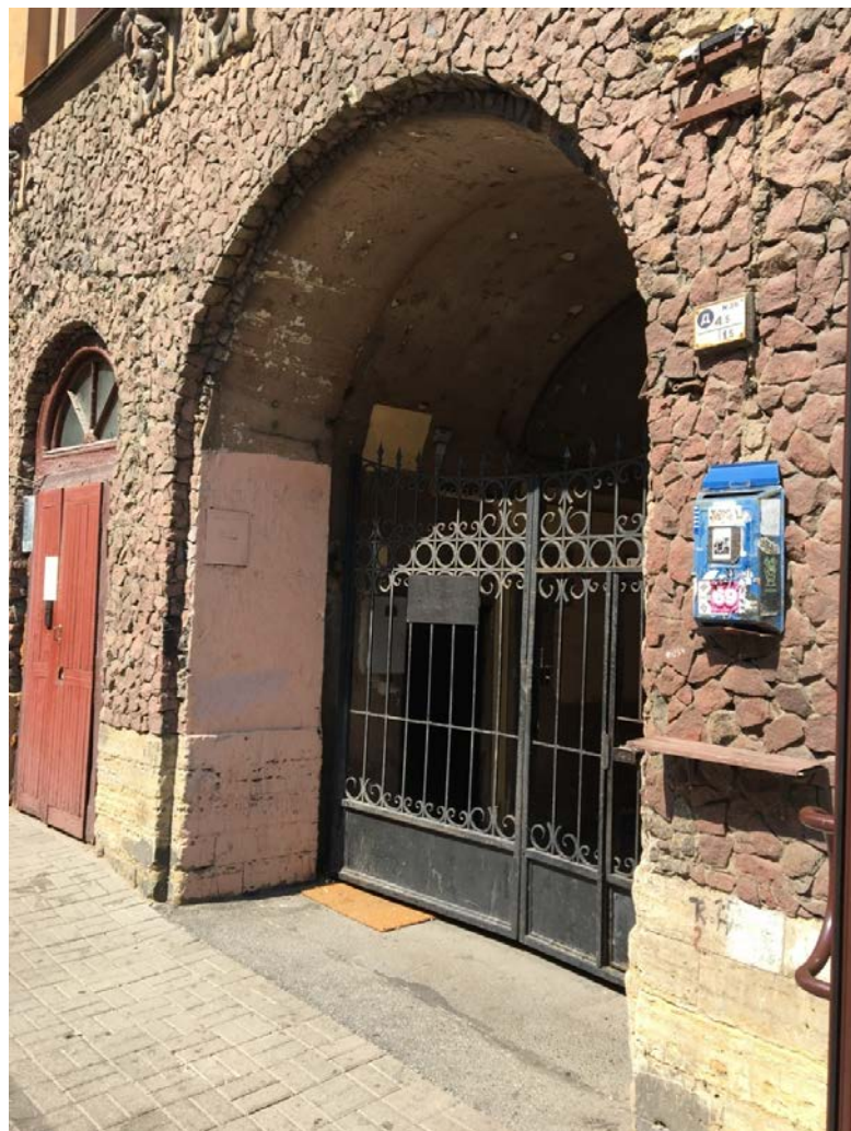
9. Лицевой фасад выявленного объекта культурного наследия «Дом Потаповой (Н.В. Иванова)», расположенного по адресу: г. Санкт-Петербург, Некрасова ул., д. 36. Фрагмент. Проем проездной арки. 26.04.2021
