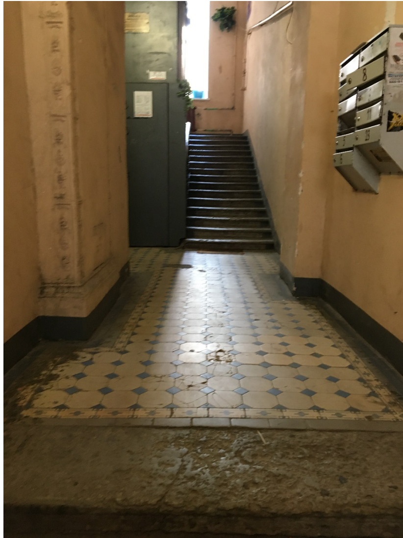
20. Парадная лестница Л-1. Парадный вестибюль. 26.04.2021
