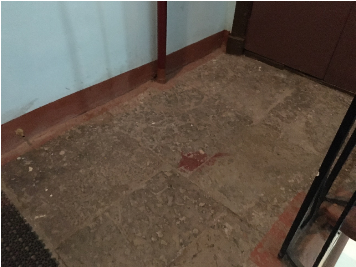
30. Лестница Л-2. Площадка третьего этажа. 26.04.2021
