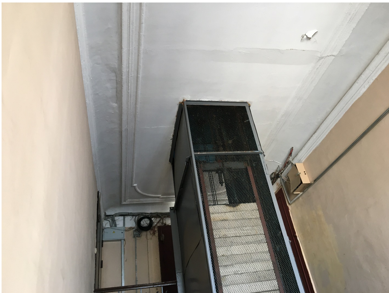
27. Парадная лестница Л-1. Оформление перекрытия лестничного объема. 26.04.2021
