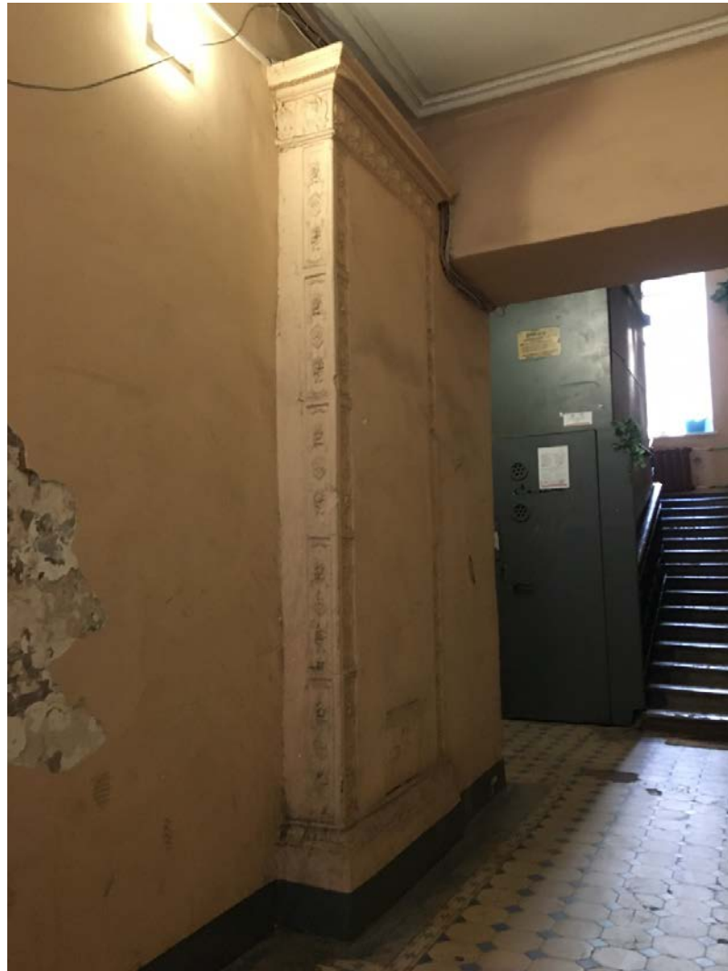
19. Парадная лестница Л-1. Парадный вестибюль. Камин. 26.04.2021
