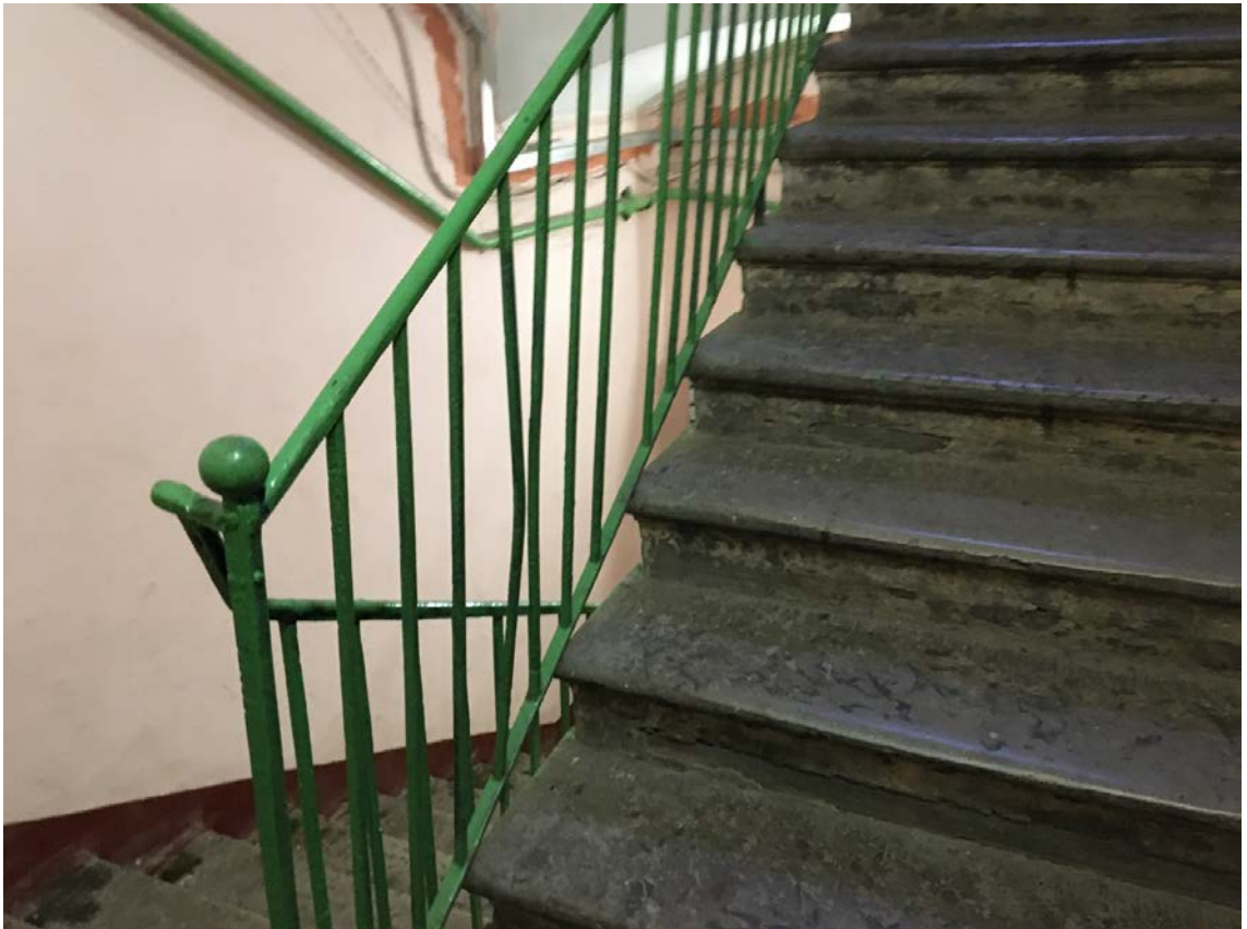
31. Лестница Л-3. Ограждение. 26.04.2021
