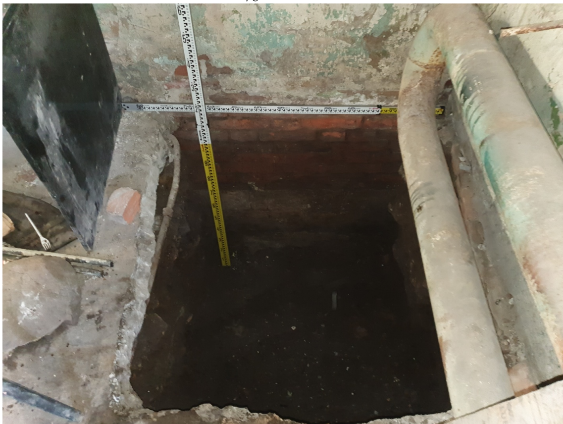
Рис. 18. Мойка, 60-2021. Шурф 1, фиксация по уровню окончания работ, вид на вид на юго-восток.
