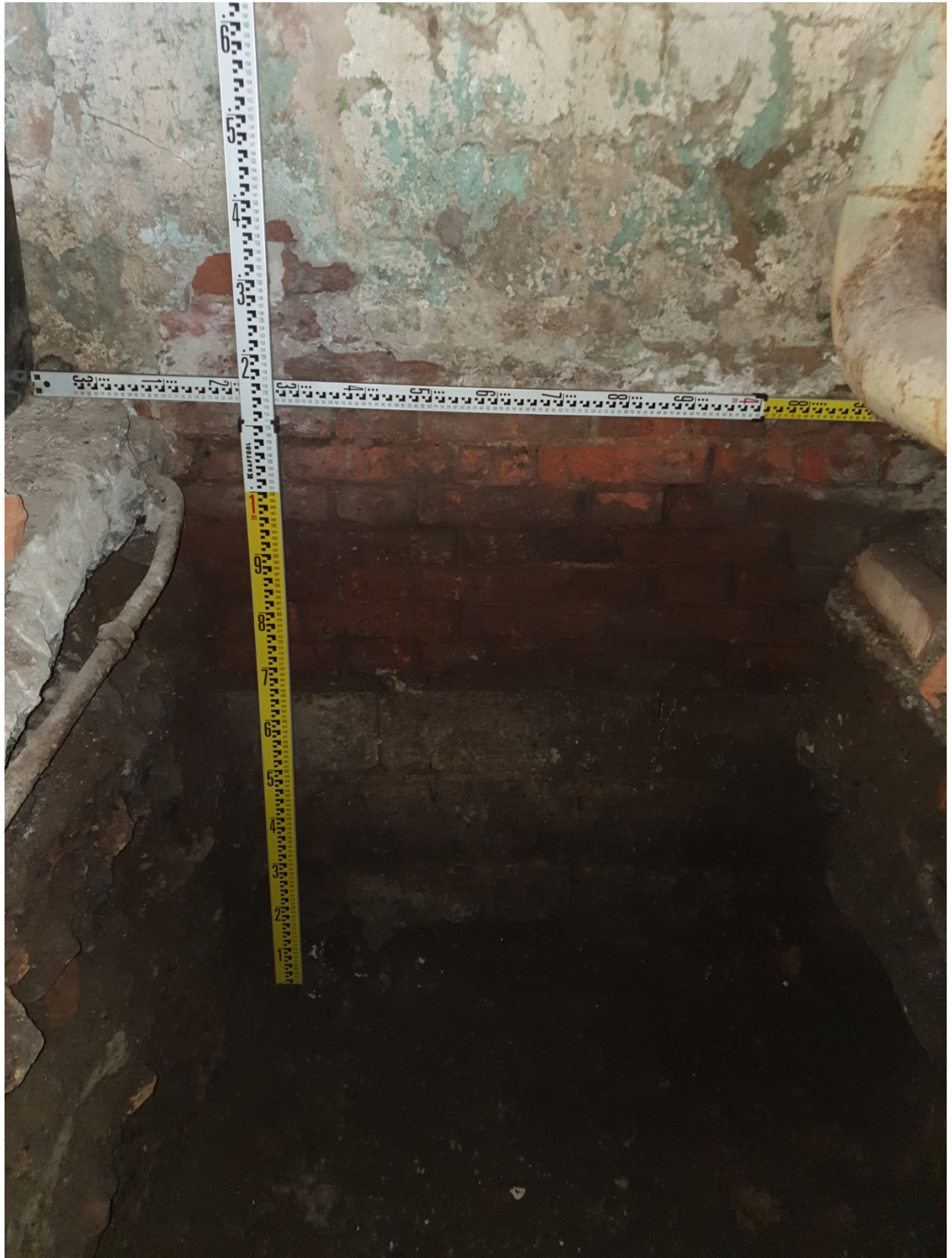
Рис. 20. Мойка, 60-2021. Шурф 1, юго-восточная стенка.
