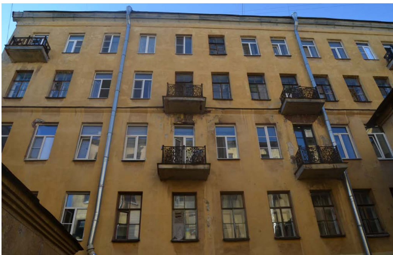
19. Выявленный объект культурного наследия «Дом Сироткиных». Юго-восточный фасад юго-восточного дворового флигеля. Вид с юго-востока. Съемка 26.04.2021
