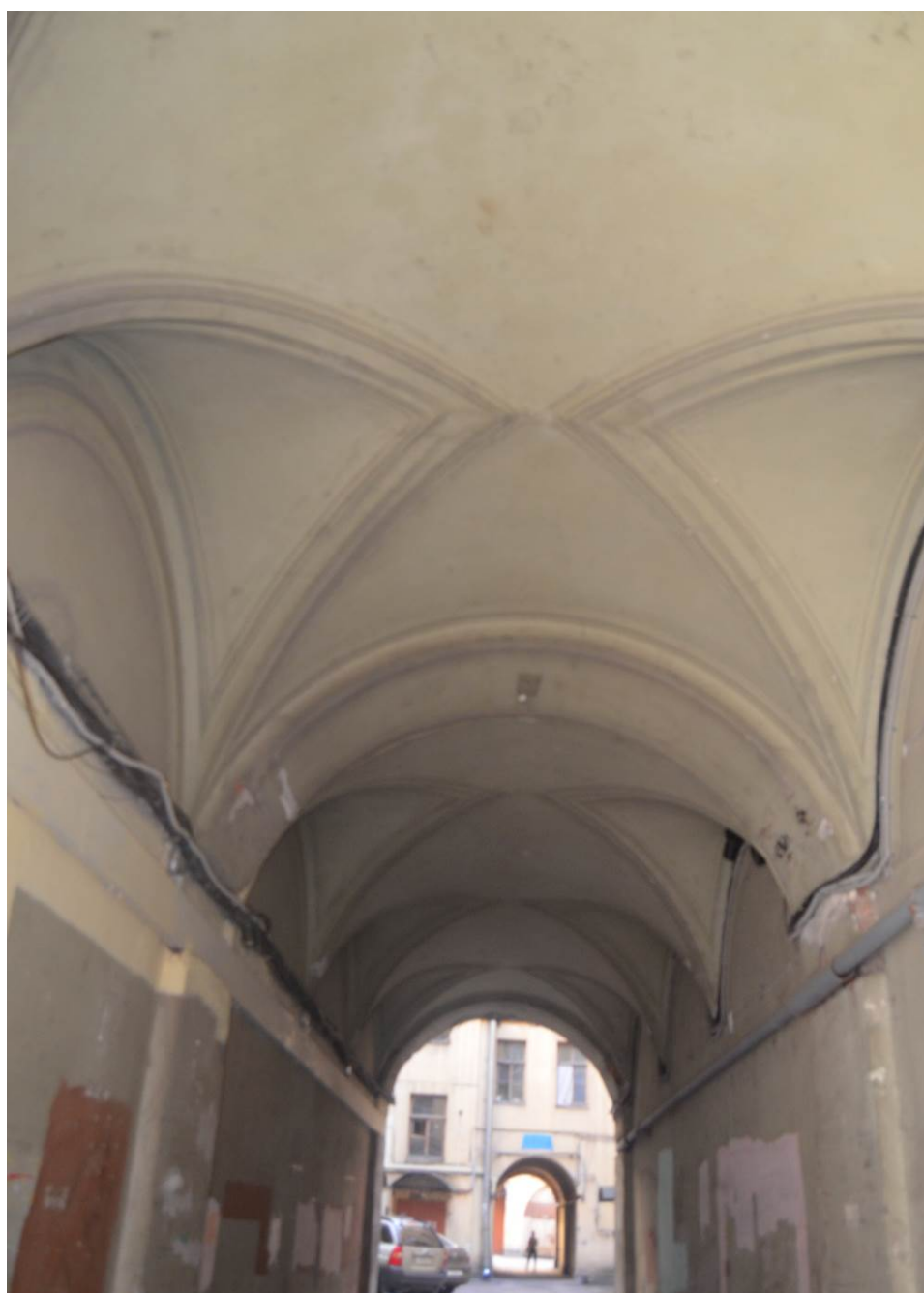
10. Выявленный объект культурного наследия «Дом Сироткиных». Конструкция и оформление первого воротного проезда Вид с запада. Съемка 26.04.2021
