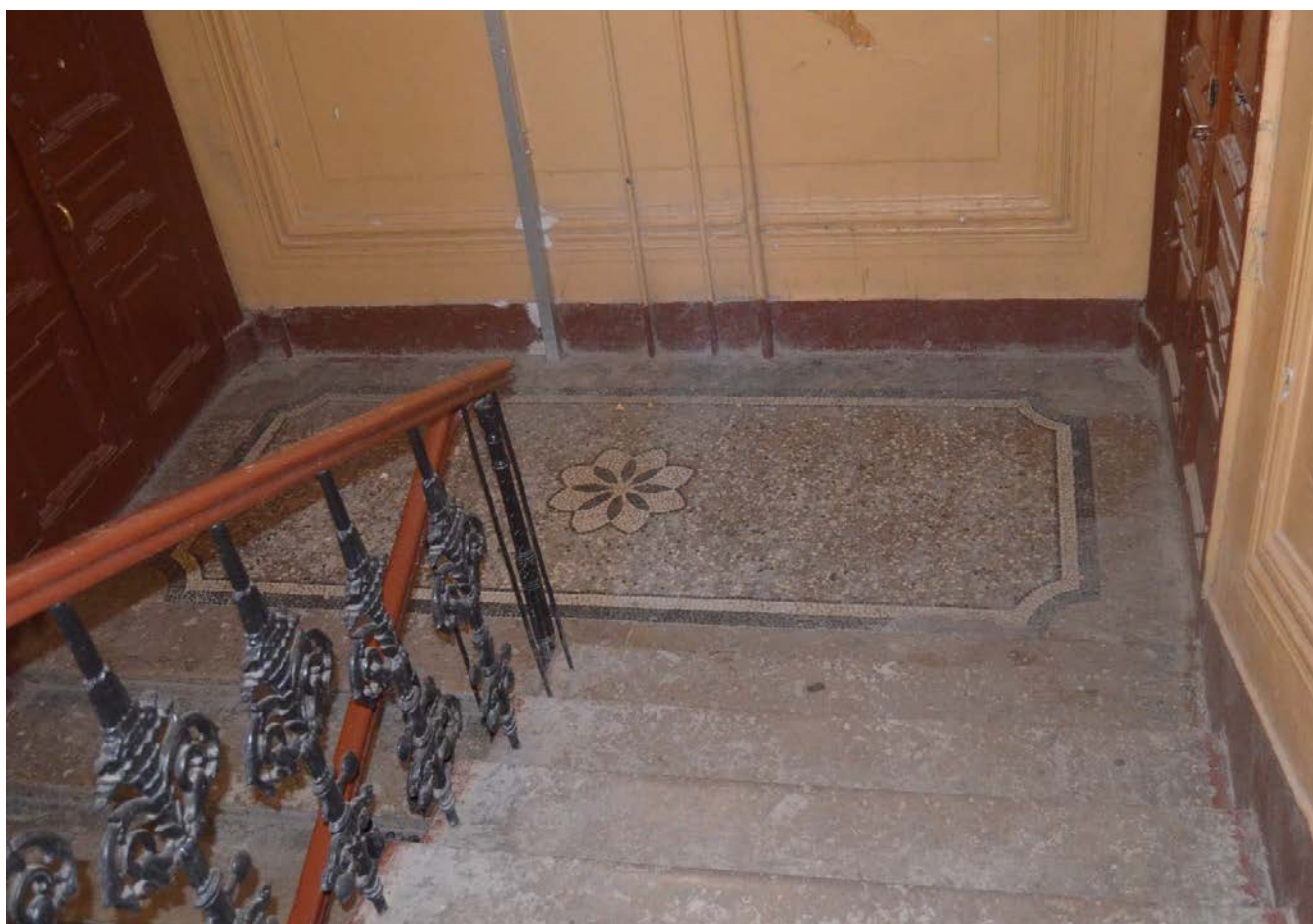
32. Выявленный объект культурного наследия «Дом Сироткиных». Парадная лестница (Л1). Мозаичная отделка пола этажной площадки третьего этажа. Вид с юга. Съемка 26.04.2021
