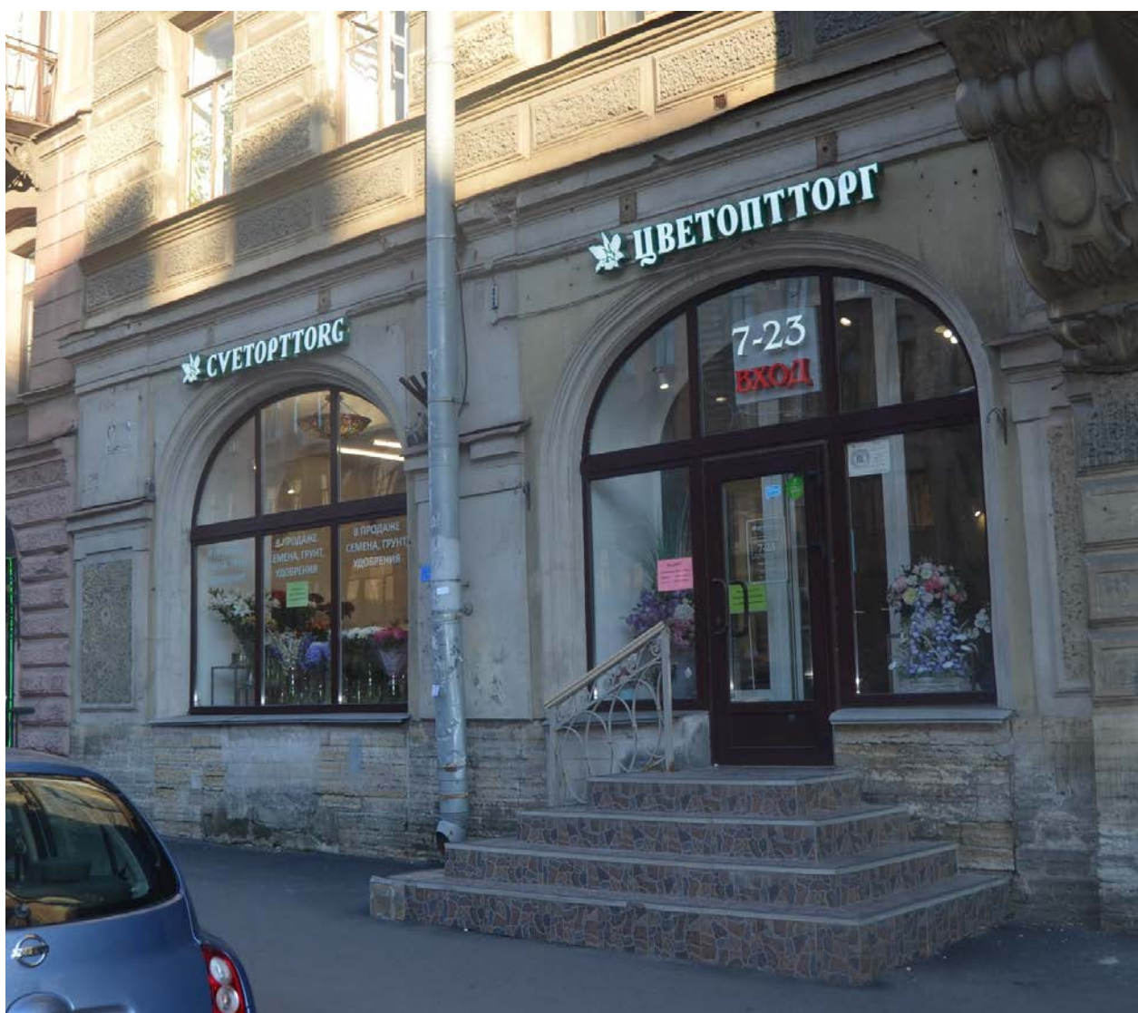
4. Выявленный объект культурного наследия «Дом Сироткиных». Оформление витринных проемов первого этажа лицевого фасада. Вид с северо-запада. Съемка 26.04.2021
