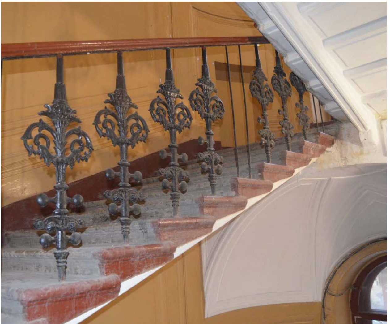
31. Выявленный объект культурного наследия «Дом Сироткиных». Парадная лестница (Л1). Сохранившиеся элементы исторического лестничного ограждения. Вид с запада. Съемка 26.04.2021
