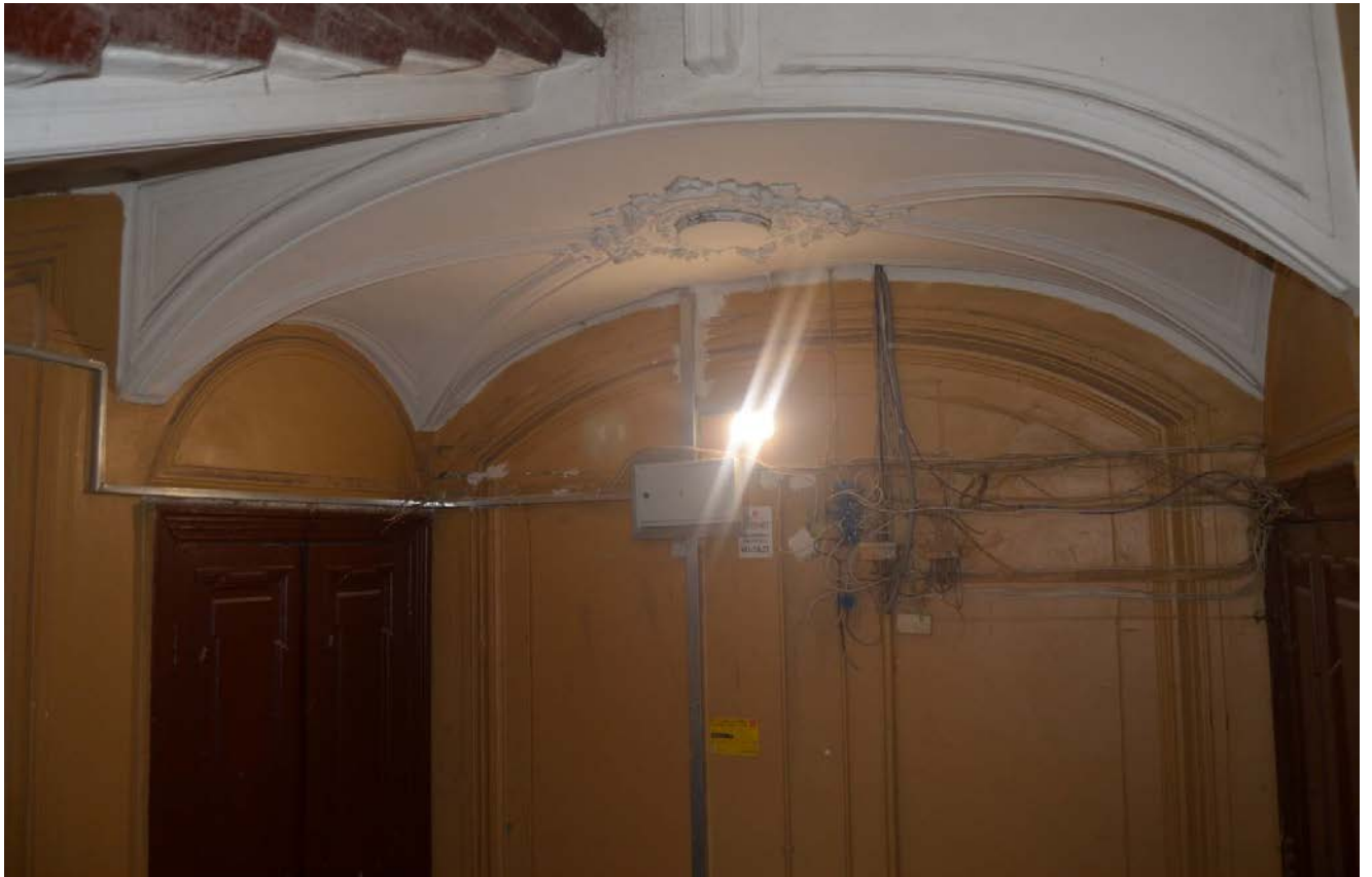
33. Выявленный объект культурного наследия «Дом Сироткиных». Парадная лестница (Л1). Оформление потолка и стен этажной площадки третьего этажа. Вид с юга. Съемка 26.04.2021
