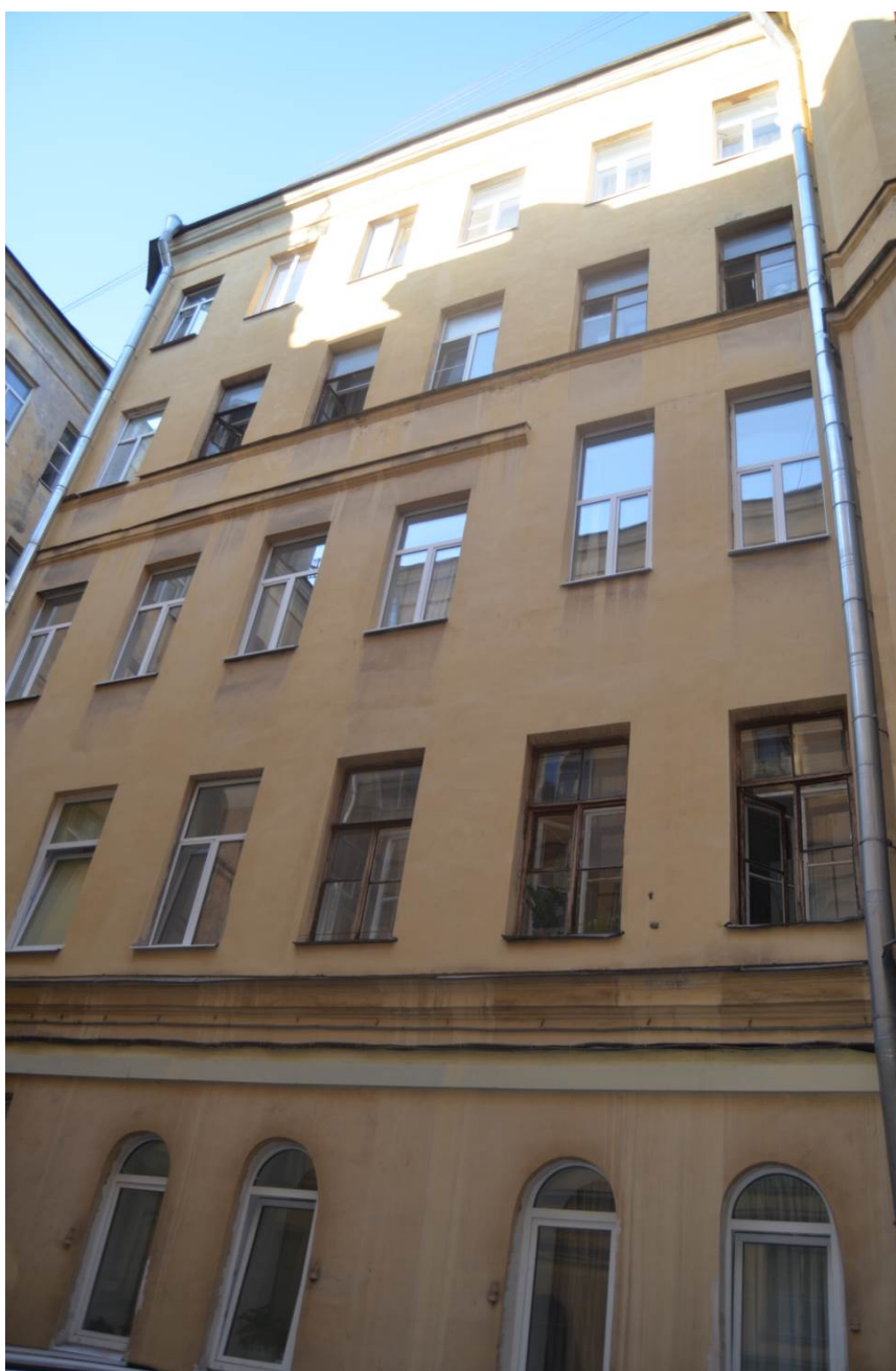
15. Выявленный объект культурного наследия «Дом Сироткиных». Северо-восточный дворовый флигель. Вид с юга. Съемка 26.04.2021
