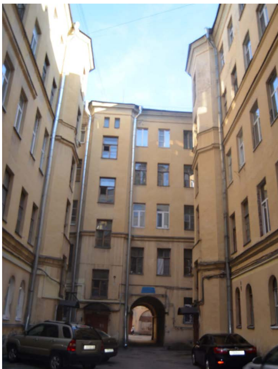
11. Выявленный объект культурного наследия «Дом Сироткиных». Внешний вид фасадов дворовых флигелей. Вид с северо-запада. Съемка 26.04.2021
