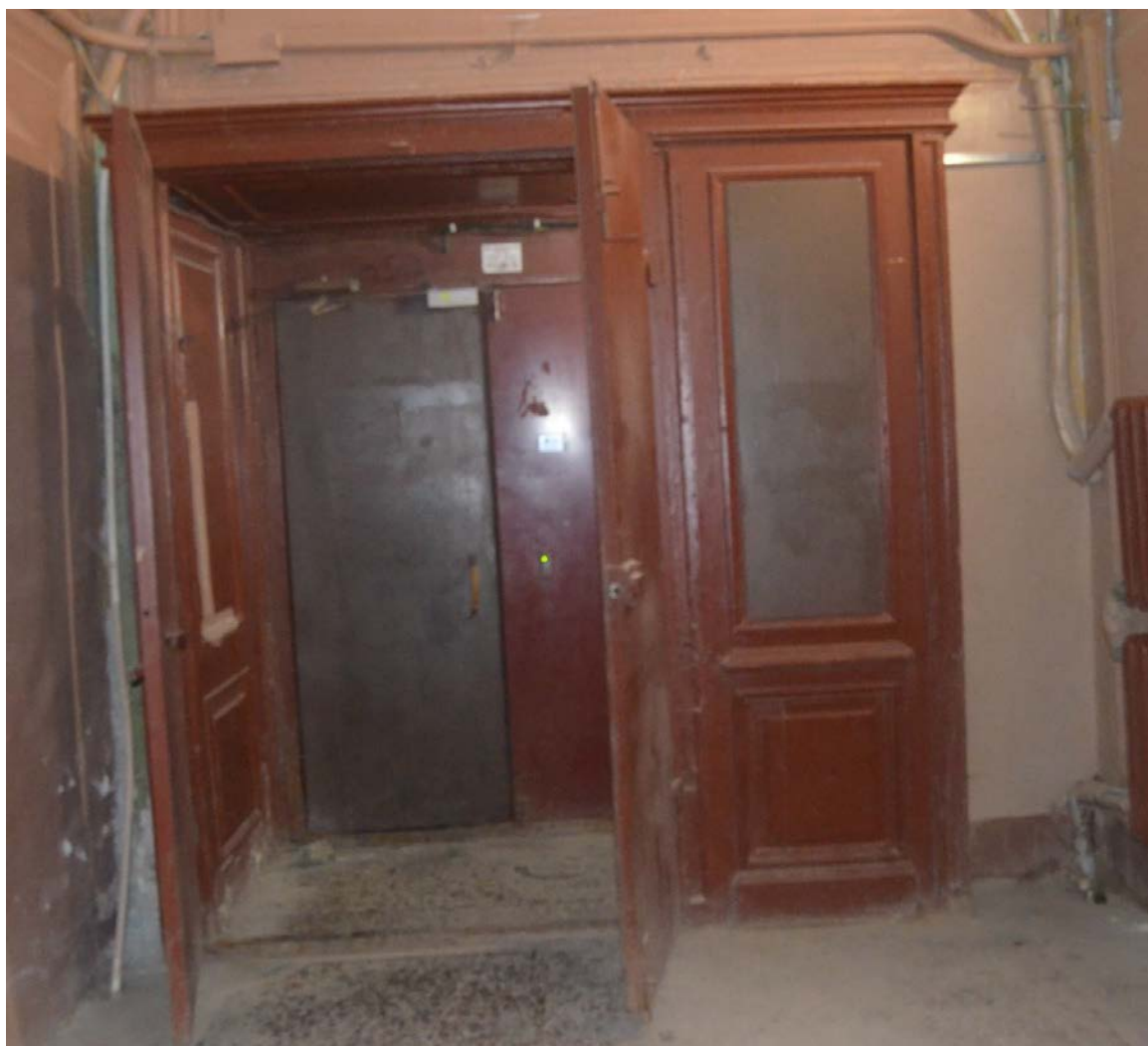
23. Выявленный объект культурного наследия «Дом Сироткиных». Парадная лестница (Л1). Исторический деревянный тамбур. Вид с юго-востока. Съемка 26.04.2021
