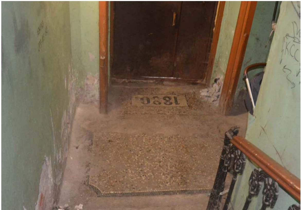
40. Выявленный объект культурного наследия «Дом Сироткиных». Лестница юго-восточного дворового флигеля (Л3). Мозаичное оформление тамбура и вестибюля лестницы. Вид с юго-востока. Съемка 26.04.2021.
