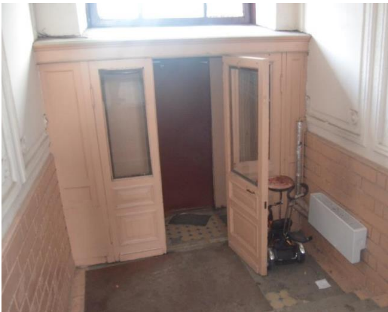
36. Выявленный объект культурного наследия «Дом П. Ф. Дыренкова». Исторический тамбур вестибюля северной парадной лестницы (Л 2).
