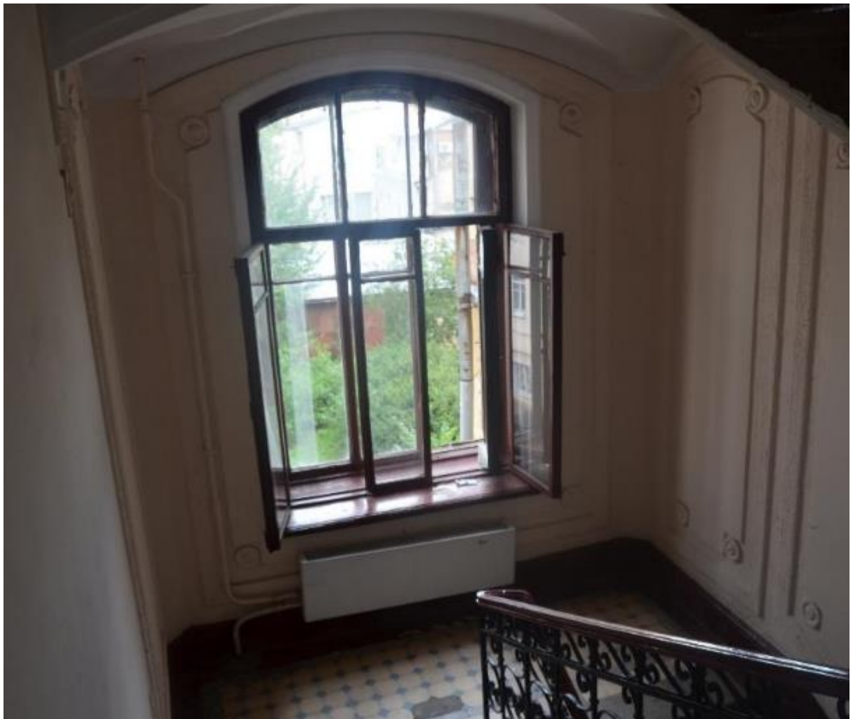
45. Выявленный объект культурного наследия «Дом П. Ф. Дыренкова». Северная парадная лестница (Л 2). Оформление стен межэтажных площадок. Вид с юго-востока. Съемка 26.04.2021.
