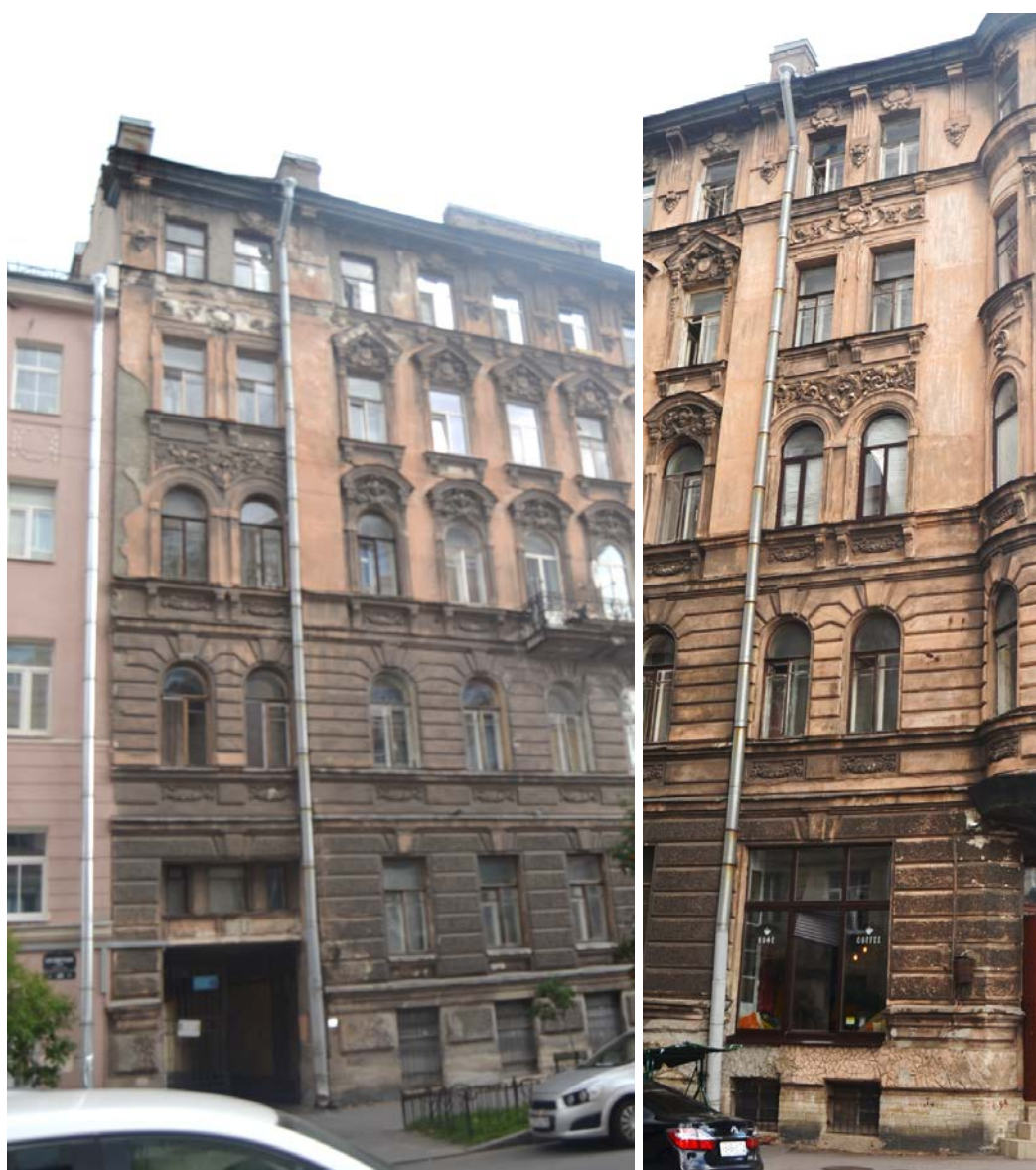
6. Выявленный объект культурного наследия «Дом П. Ф. Дыренкова». Оформление крайних осей южного лицевого фасада. Вид с юга. Съемка 26.04.2021.
