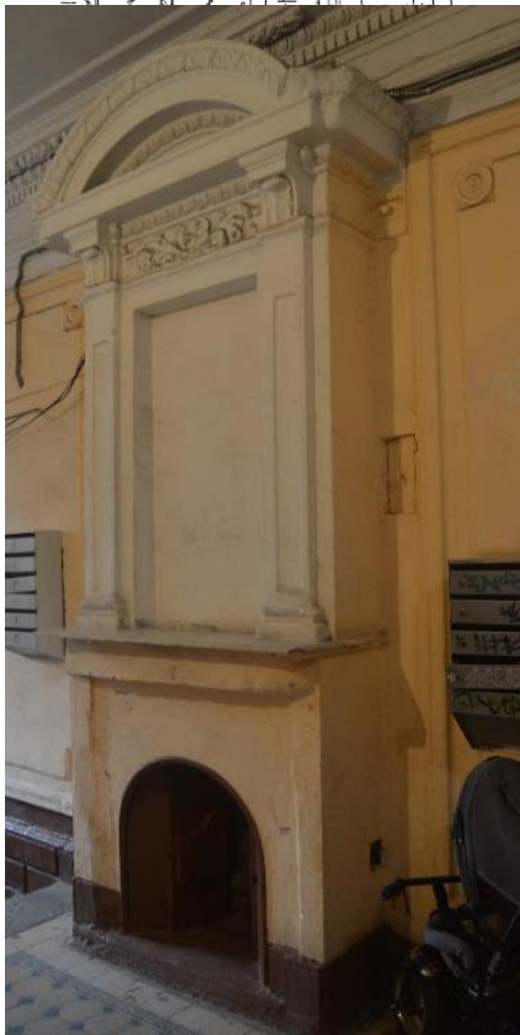
61. Выявленный объект культурного наследия «Дом П. Ф. Дыренкова». Средистенная печь вестибюля южной парадной лестницы (Л 1). Вид с севера. Съемка 26.04.2021.
