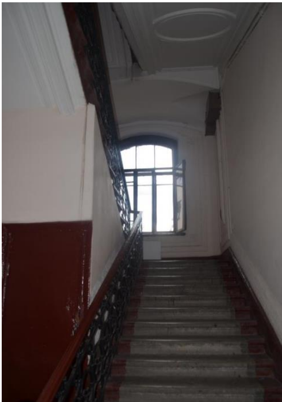
42. Выявленный объект культурного наследия «Дом П. Ф. Дыренкова». Северная парадная лестница (Л 2) в уровне первого этажа. Съемка 26.04.2021.
