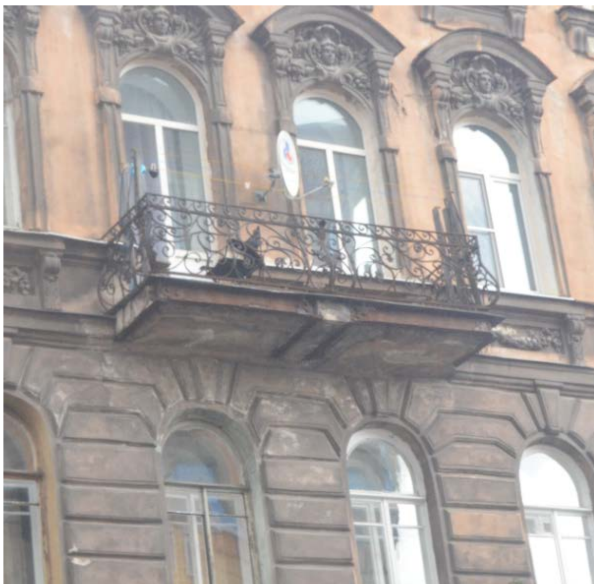
13. Выявленный объект культурного «Дом П. Ф. Дыренкова». Балкон по центральным осям в уровне третьего этажа и южного лицевого фасада. Вид с запада. Съемка 26.04.2021.
