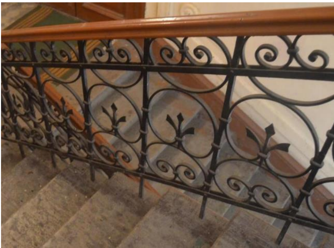
71. Выявленный объект культурного наследия «Дом П. Ф. Дыренкова». Южная парадная лестница (Л 1). Историческое лестничное ограждение. Вид с северо-востока. Съемка 26.04.2021.
