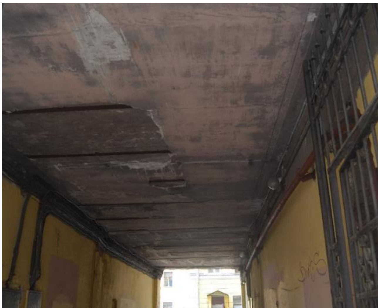
29. Выявленный объект культурного наследия «Дом П. Ф. Дыренкова». Конструкция воротного проезда. Вид с юго-запада. Съемка 26.04.2021.
