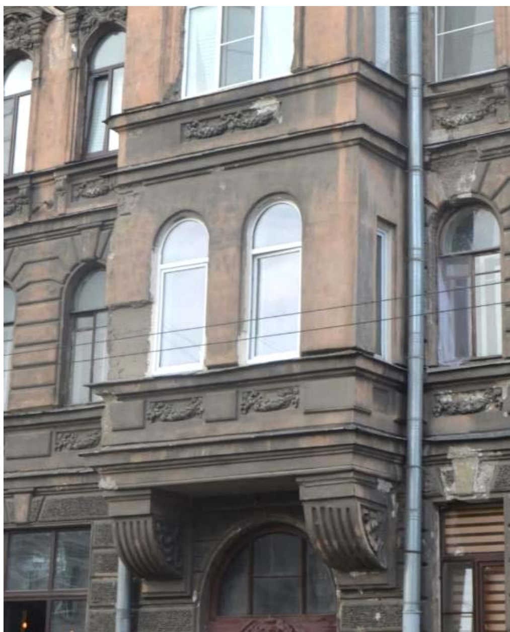
24. Выявленный объект культурного наследия «Дом П. Ф. Дыренкова». Оформление нижней части эркеров восточного лицевого фасада. Вид с востока. Съемка 26.04.2021.
