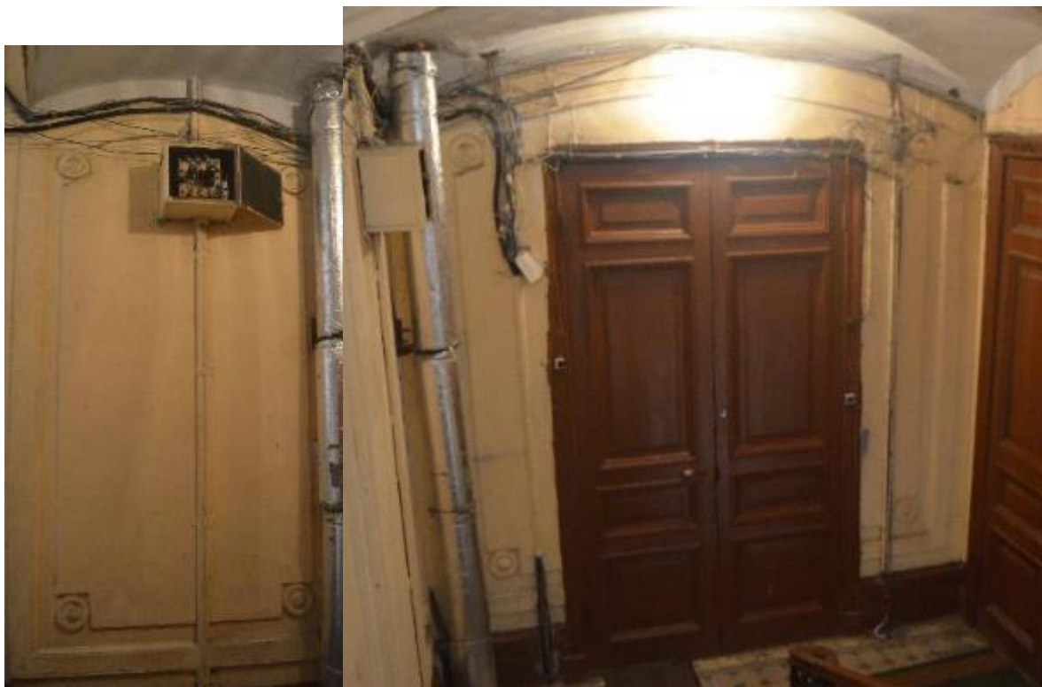
68. Выявленный объект культурного наследия «Дом П. Ф. Дыренкова». Южная парадная лестница (Л 1). Оформление стен этажных площадок. Вид с северо-запада и запада. Съемка 26.04.2021.
