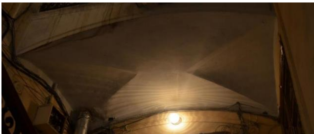
70. Выявленный объект культурного наследия «Дом П. Ф. Дыренкова». Южная парадная лестница (Л 1). Конструкция этажных и межэтажных площадок. Вид с запада и востока. Съемка 26.04.2021.
