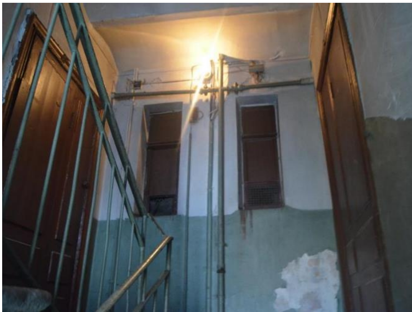
79. Выявленный объект культурного наследия «Дом П. Ф. Дыренкова». Черная лестница по западному дворовому фасаду Л 4). Площадка черной лестницы. Вид с северо-запада. Съемка 26.04.2021.
