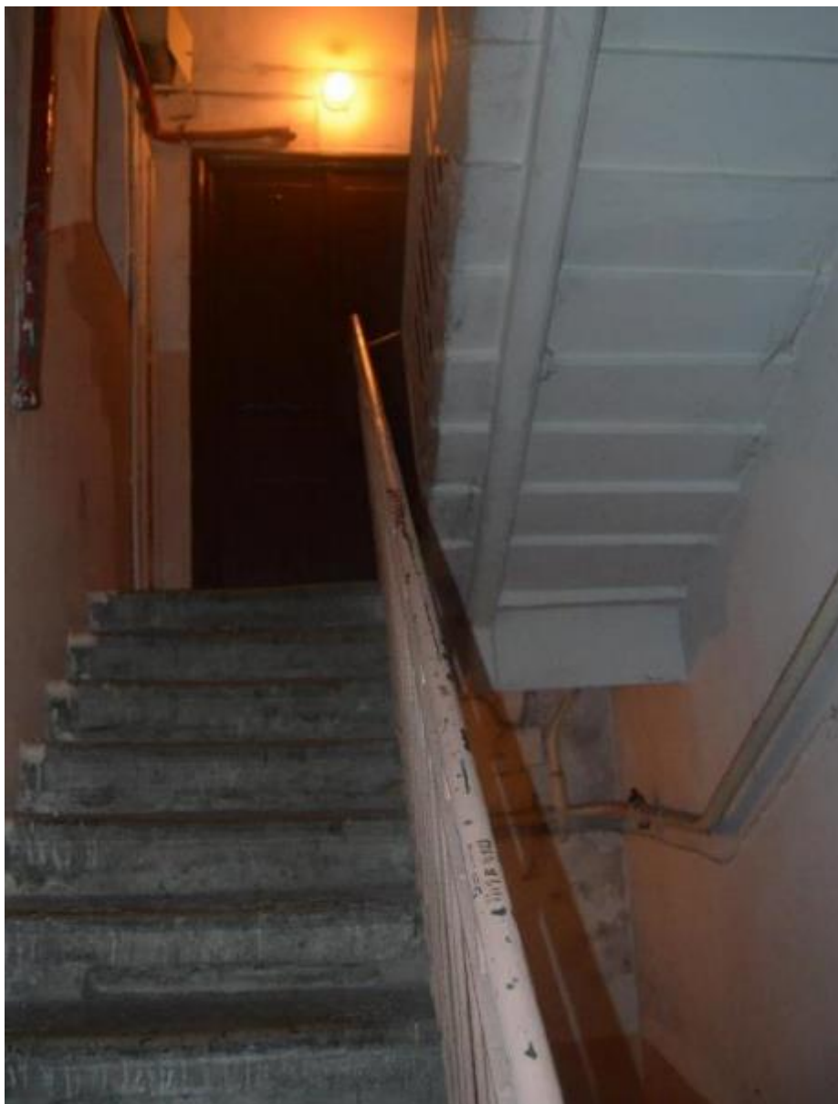
85. Выявленный объект культурного наследия «Дом П. Ф. Дыренкова». Черная лестница по южному дворовому фасаду (Л 5). Марши в уровне 1-го этажа. Вид северо-запада. Съемка 26.04.2021.
