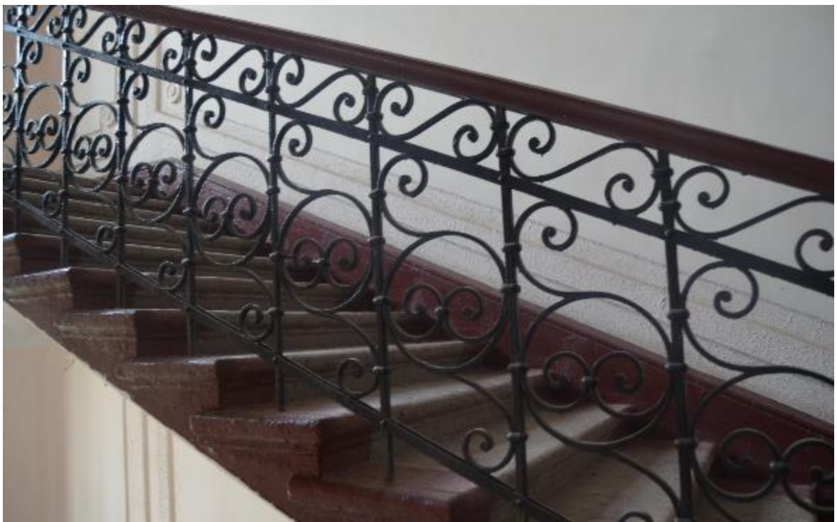
50. Выявленный объект культурного наследия «Дом П. Ф. Дыренкова». Северная парадная лестница (Л 2). Историческое ограждение лестницы. Вид с юга. Съемка 26.04.2021.
