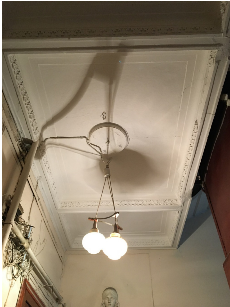
47. Лестница ЗЛК. Площадка 2 этажа. Оформление основания площадки 3 этажа.
