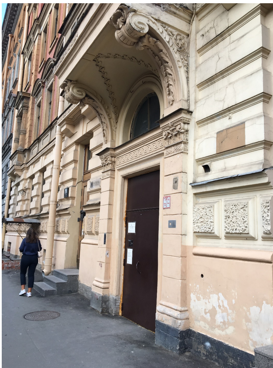
11. Лицевой фасад выявленного объекта культурного наследия «Дом А.И. Резанова», расположенного по адресу: г. Санкт-Петербург, Моховая ул., д. 28. Фрагмент.
