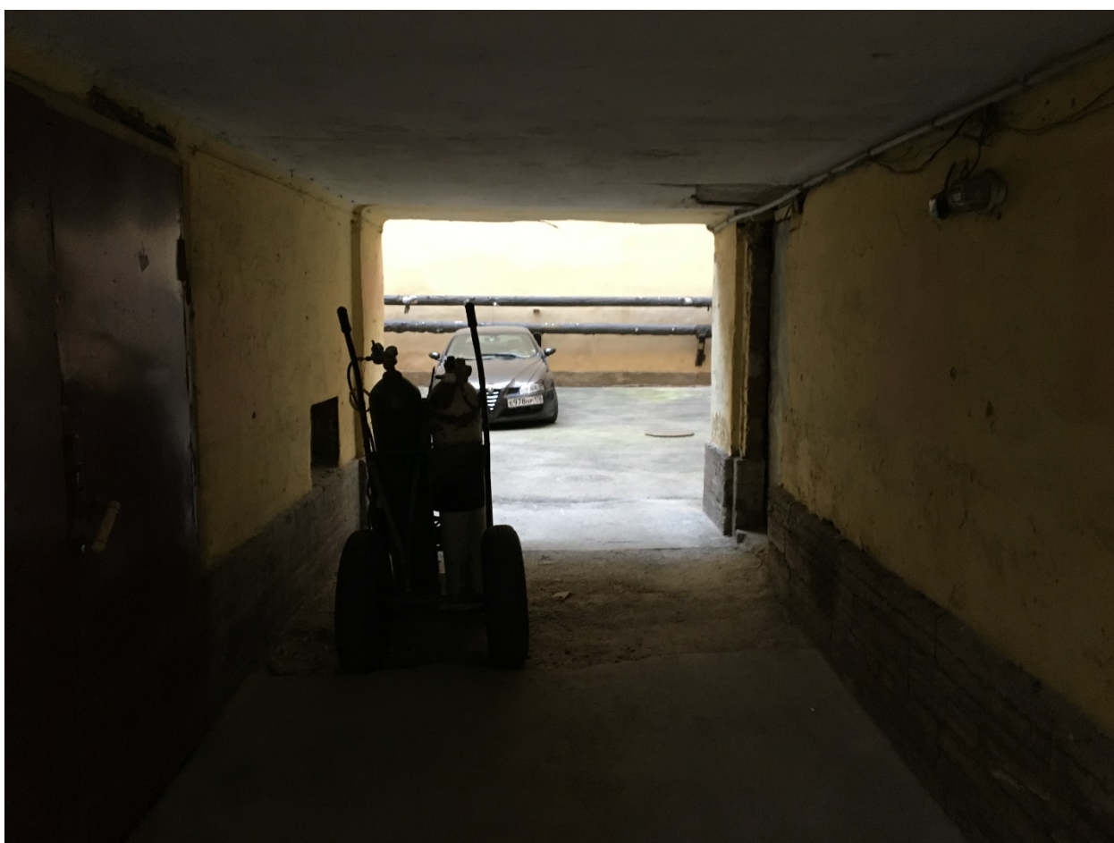
22. Проездная арка между южным и северным дворами.
