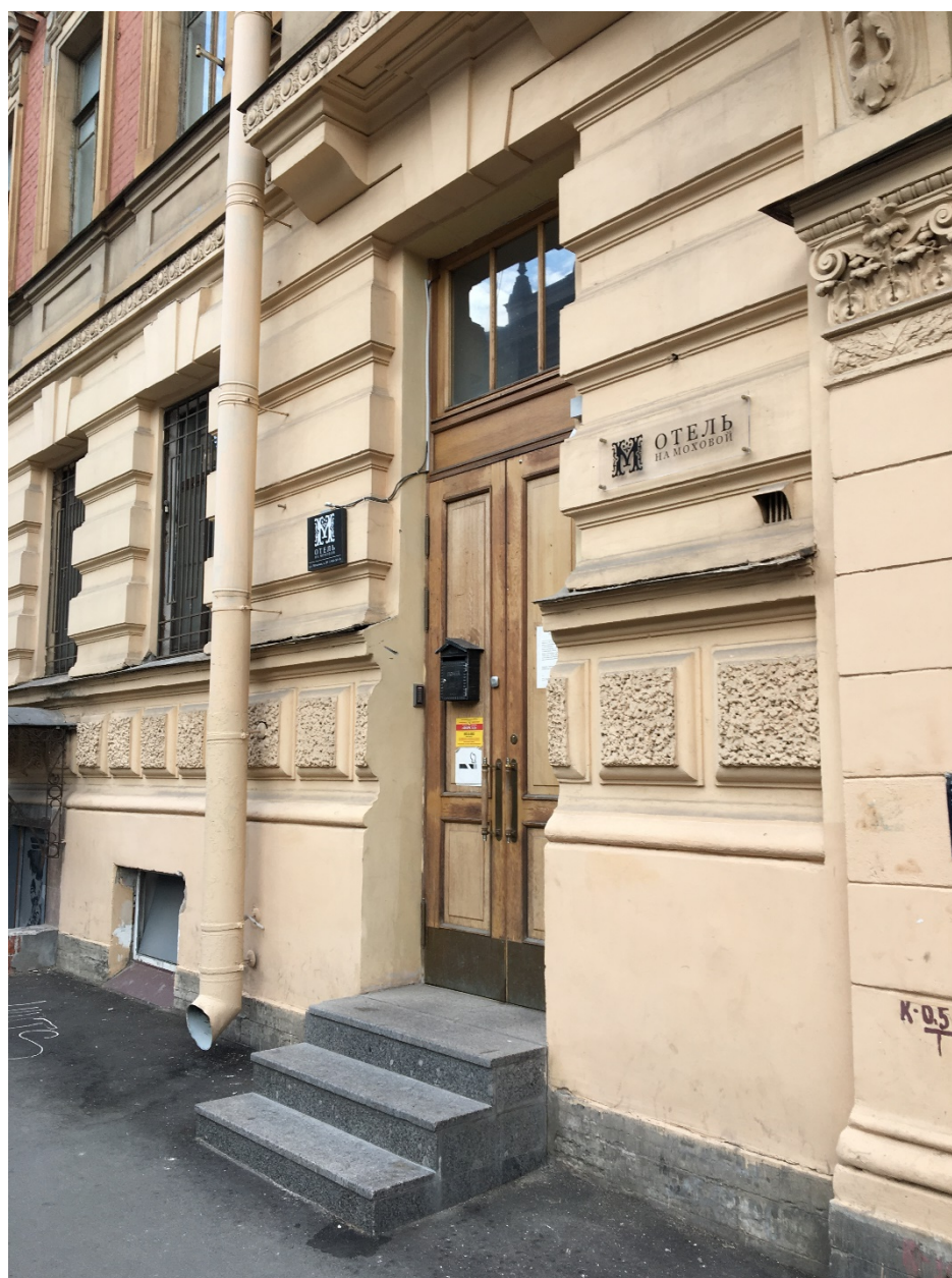
12. Лицевой фасад выявленного объекта культурного наследия «Дом А.И. Резанова», расположенного по адресу: г. Санкт-Петербург, Моховая ул., д. 28. Вход.
