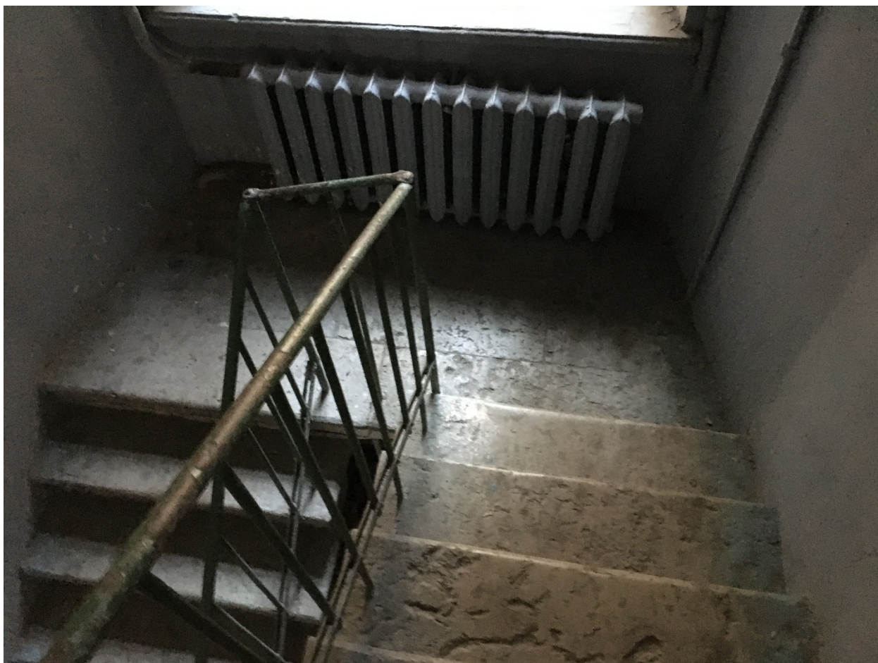
66. Лестница 8ЛК. Площадка между 1 и 2 этажами.
