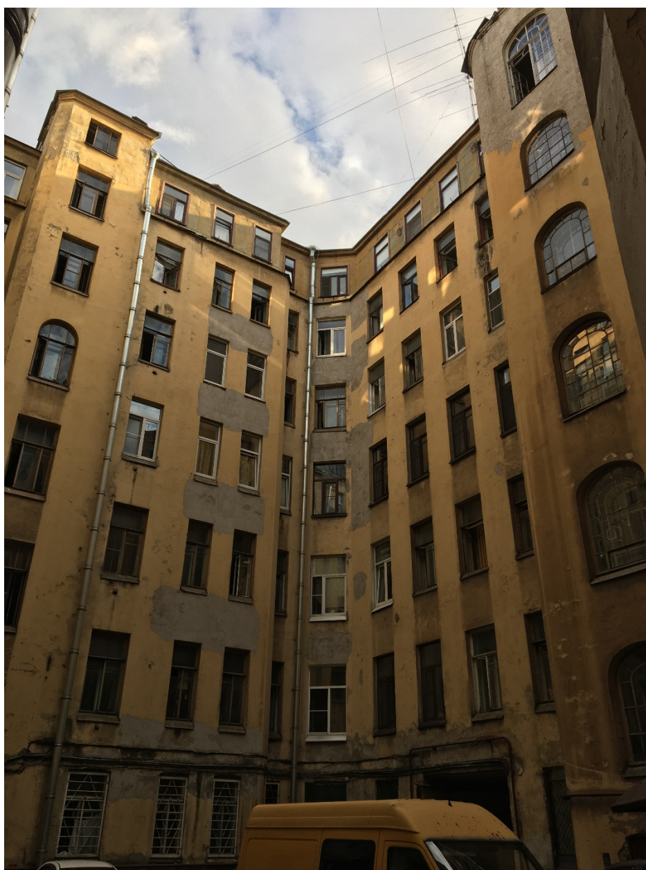
27. Фасады среднего двора. Общий вид.
