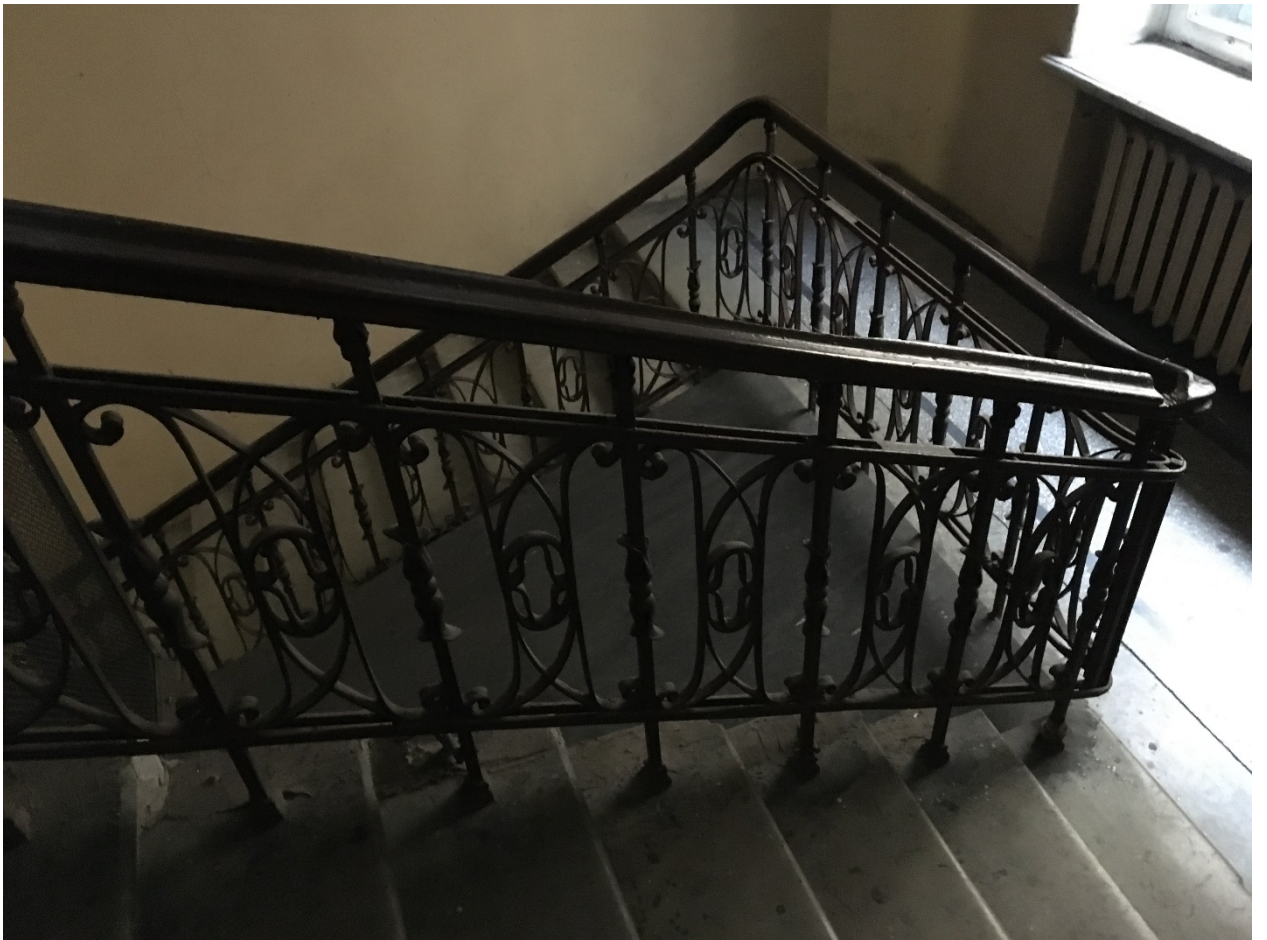
60. Лестница 5ЛК. Общий вид.
