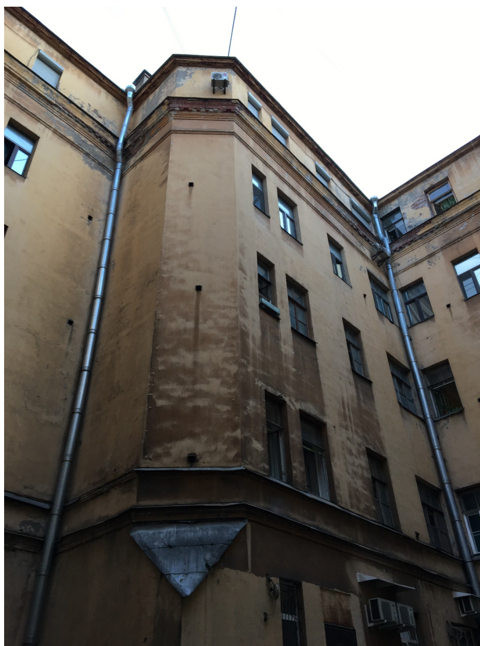
23. Фасад выявленного объекта культурного наследия «Дом А.И. Резанова», расположенного по адресу: г. Санкт-Петербург, Моховая ул., д. 28ы северного двора. Общий вид.
