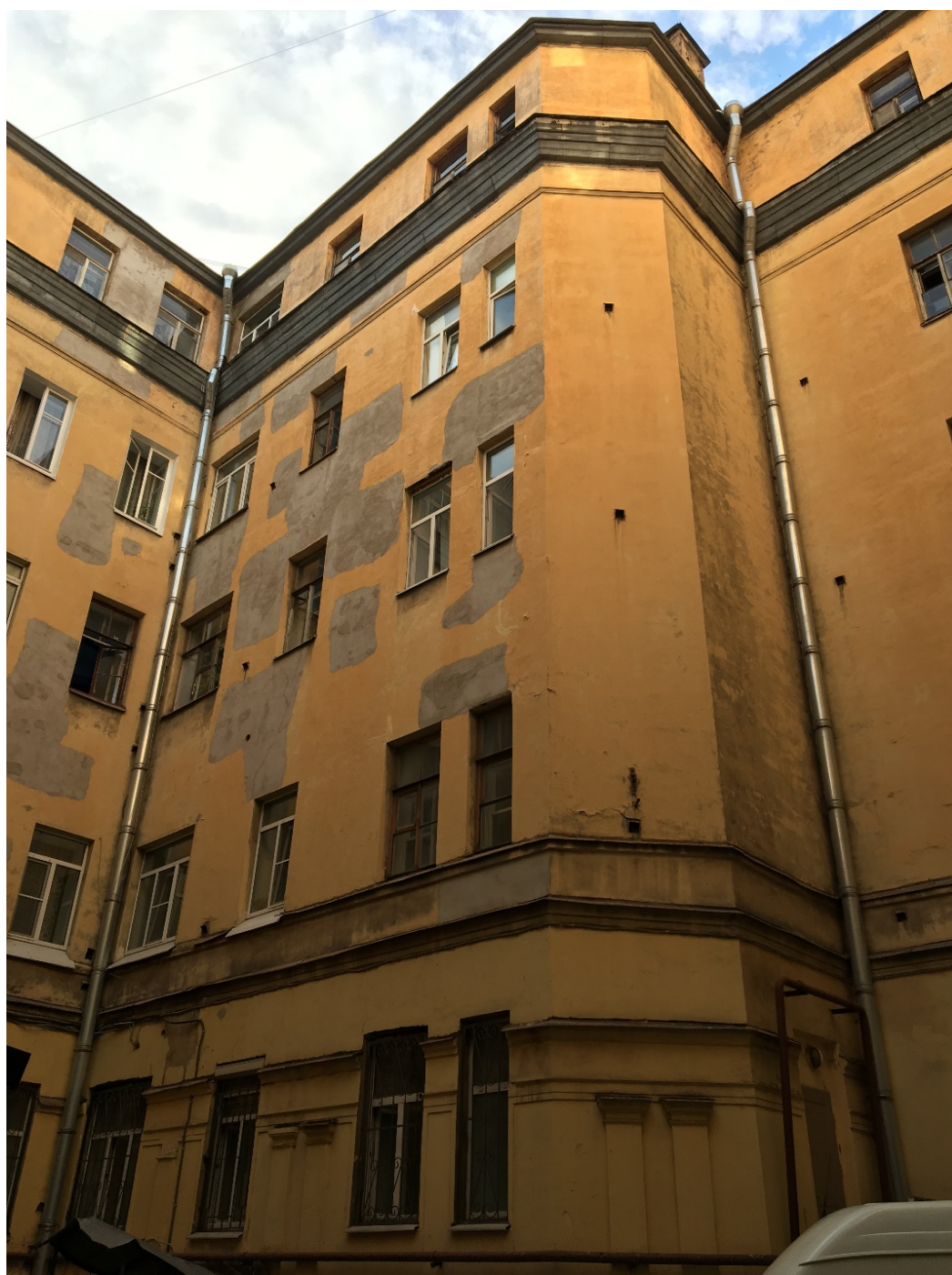
17. Фасады южного двора. Общий вид.
