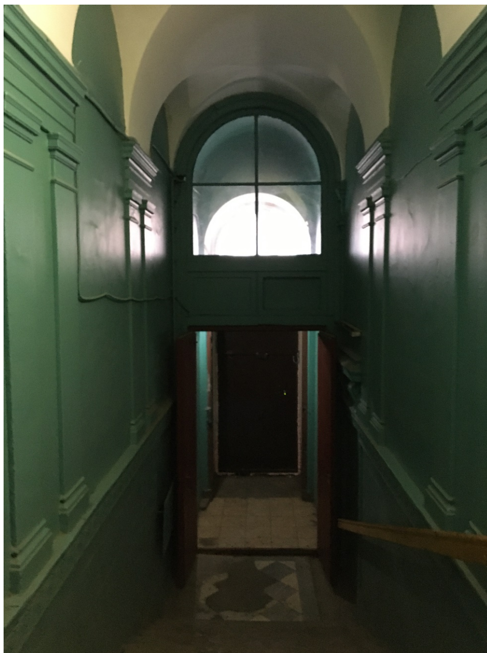
31. Парадная лестница 1ЛК. Парадный вестибюль. Общий вид.
