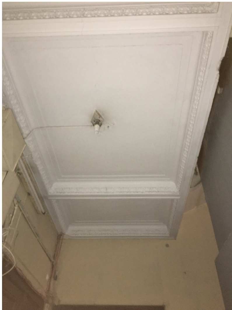
61. Лестница 5ЛК. Оформление основания площадки 3 этажа.
