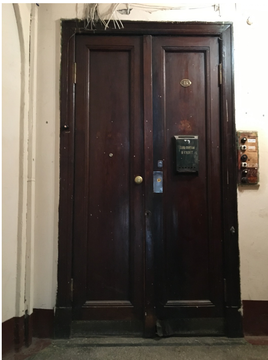
48. Лестница ЗЛК. Площадка 3 этажа. Дверное заполнение квартиры 18.
