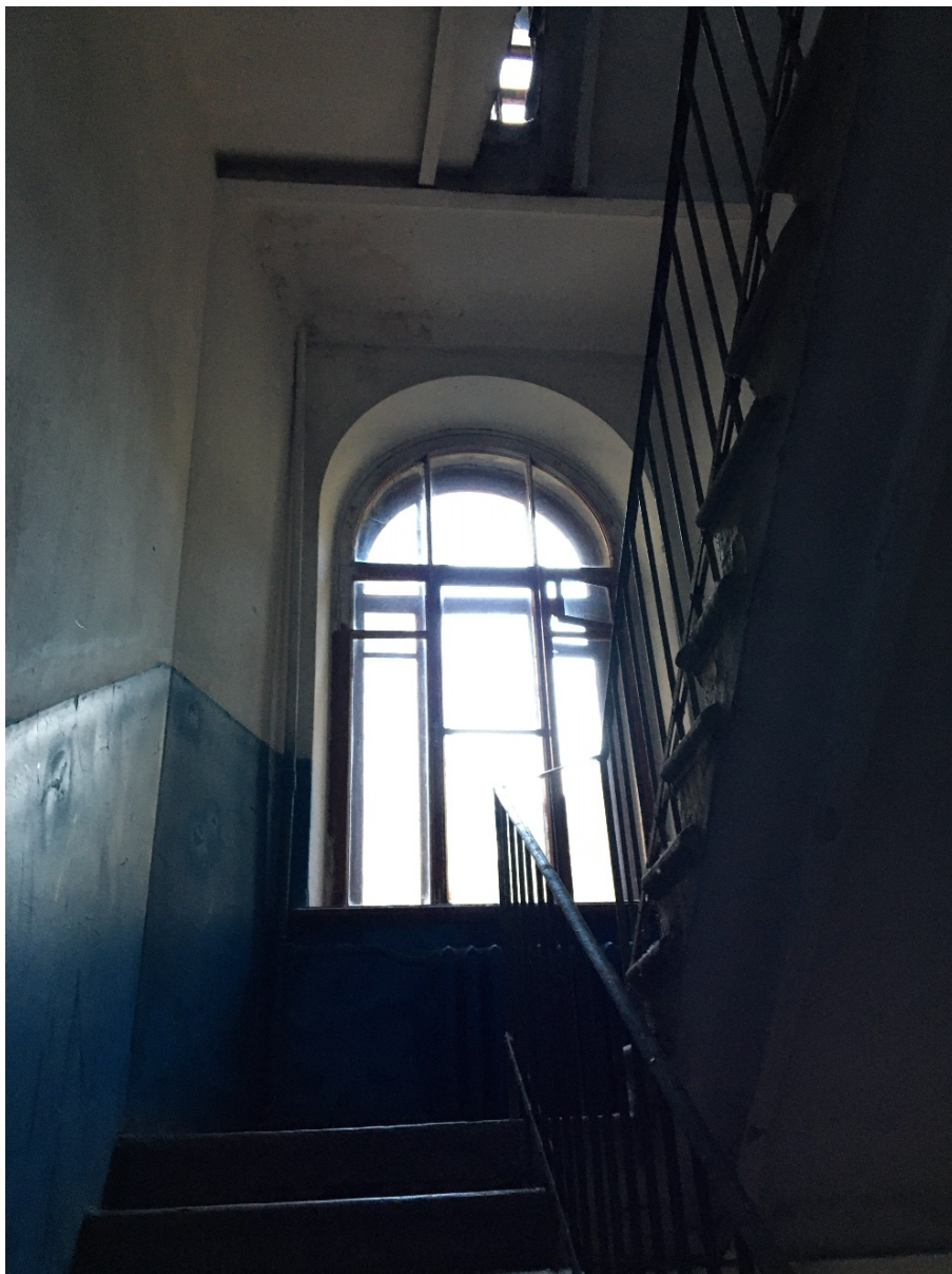
67. Лестница БЛК. Общий вид.
