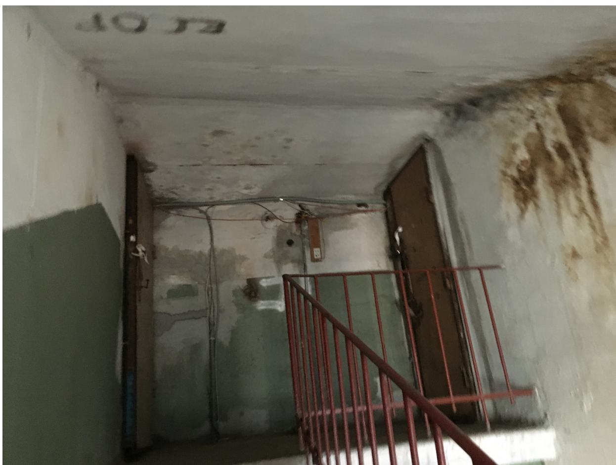
64. Лестница 9ЛК. Перекрытие объема лестницы.
