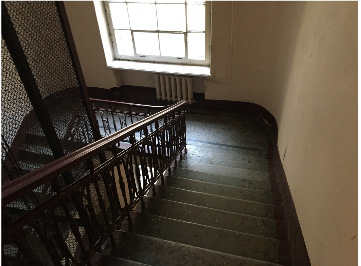
51. Лестница 3ЛК. Общий вид.
