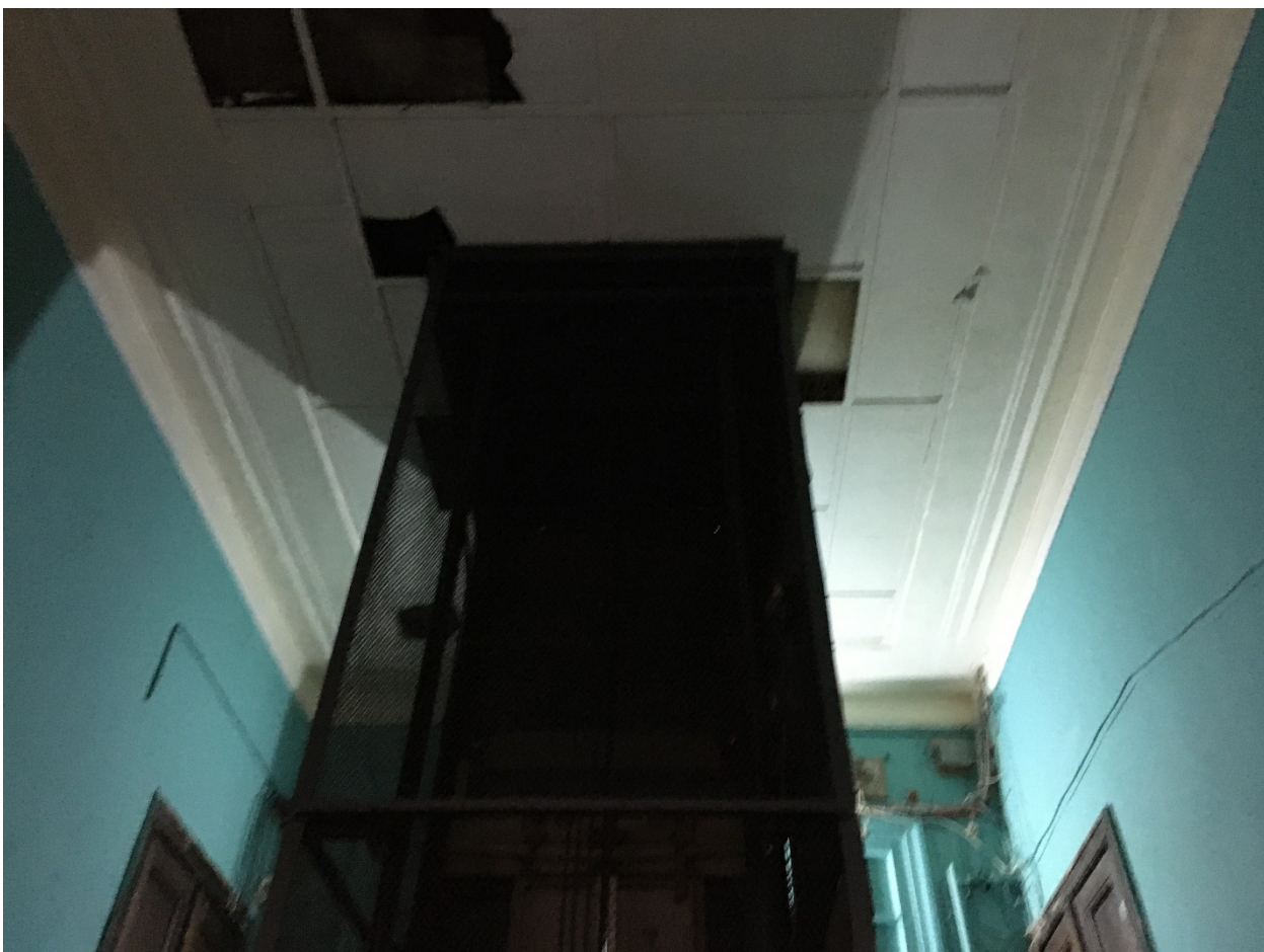
36. Парадная лестница 1ЛК. Перекрытие объема лестницы.
