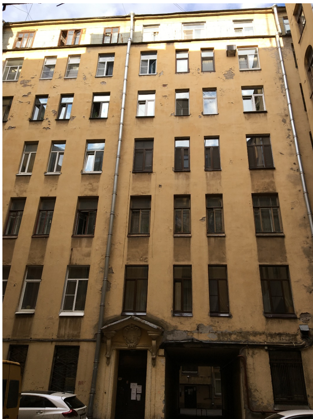
26. Фасады среднего двора. Общий вид.
