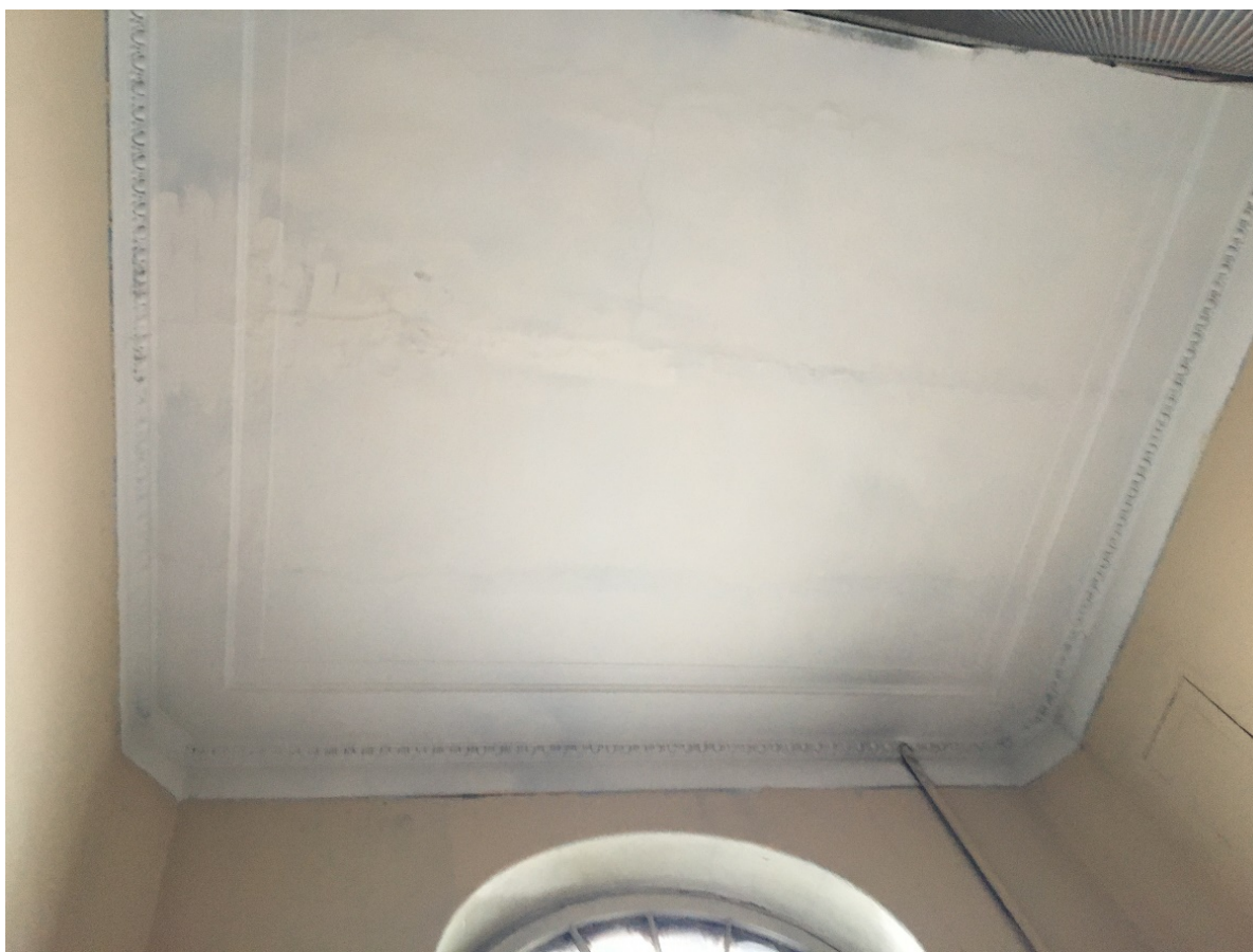
63. Лестница 5ЛК. Перекрытие объема лестницы.
