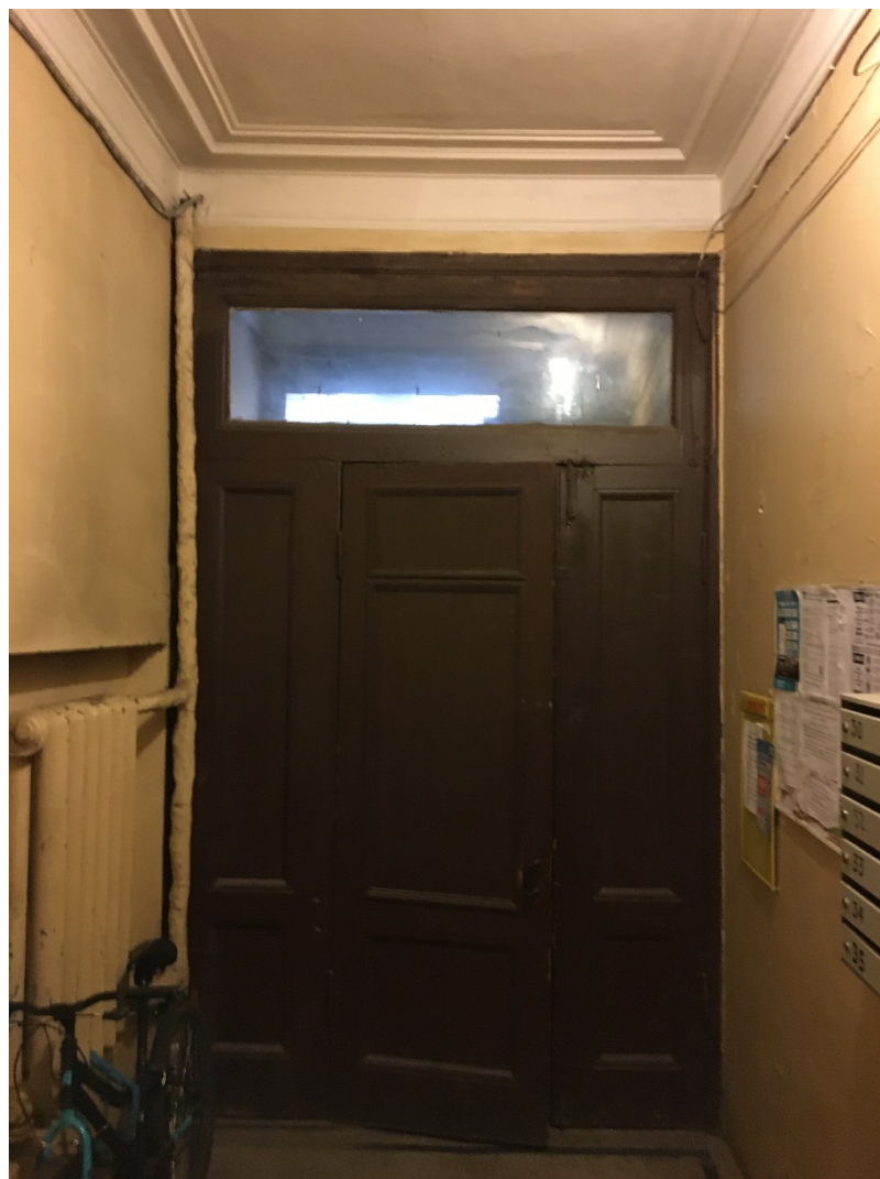
57. Лестница 5ЛК. Вестибюль. Общий вид.
