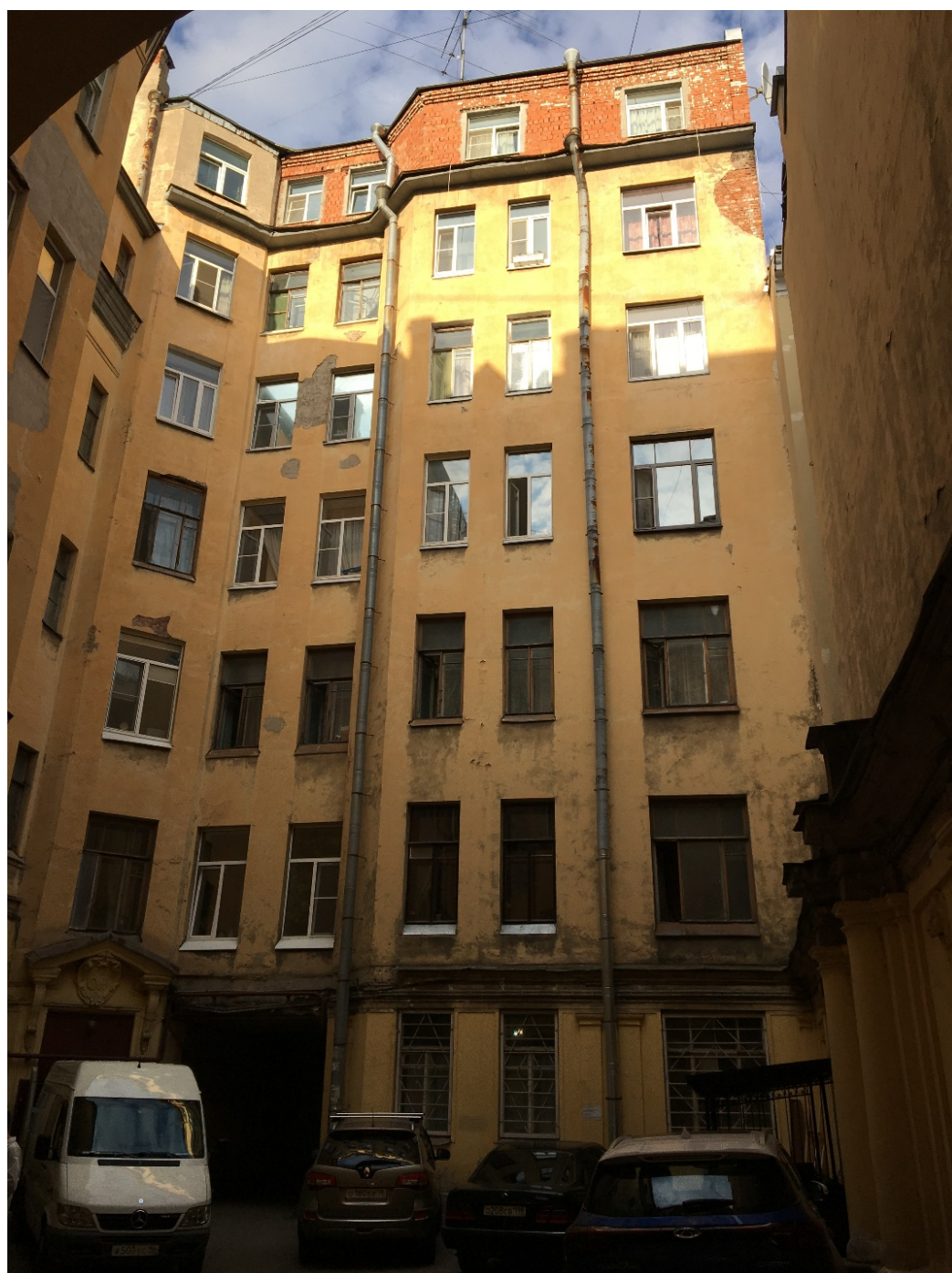
19. Фасад ы южного двора. Общий вид.
