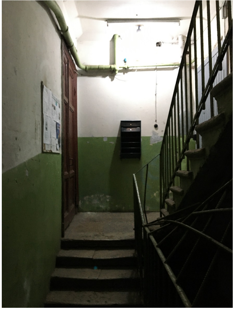
53. Лестница 4ЛК. Площадка 1 этажа.
