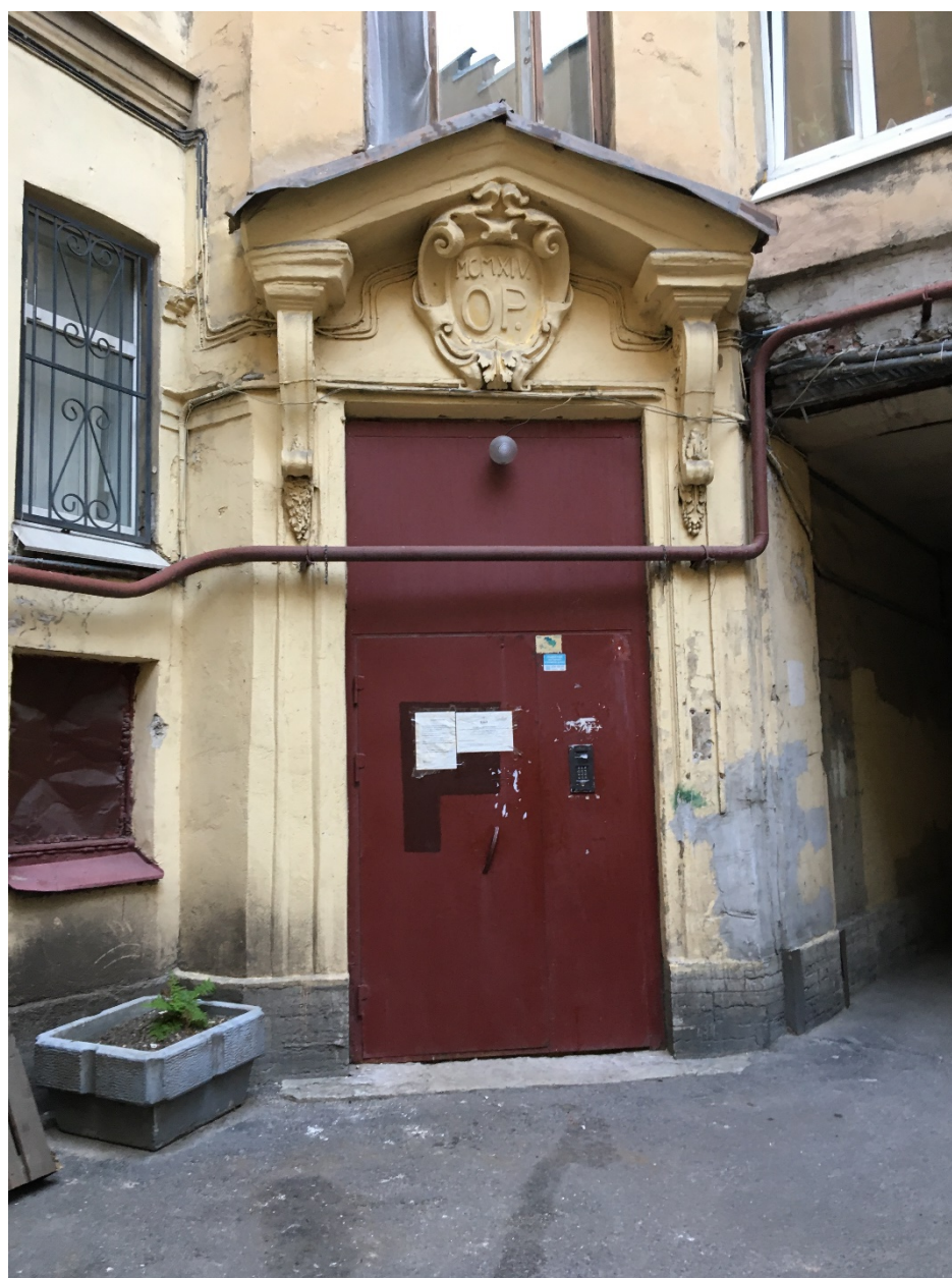
20. Фасады южного двора. Оформление дверного проема лестницы ЗЛК.
