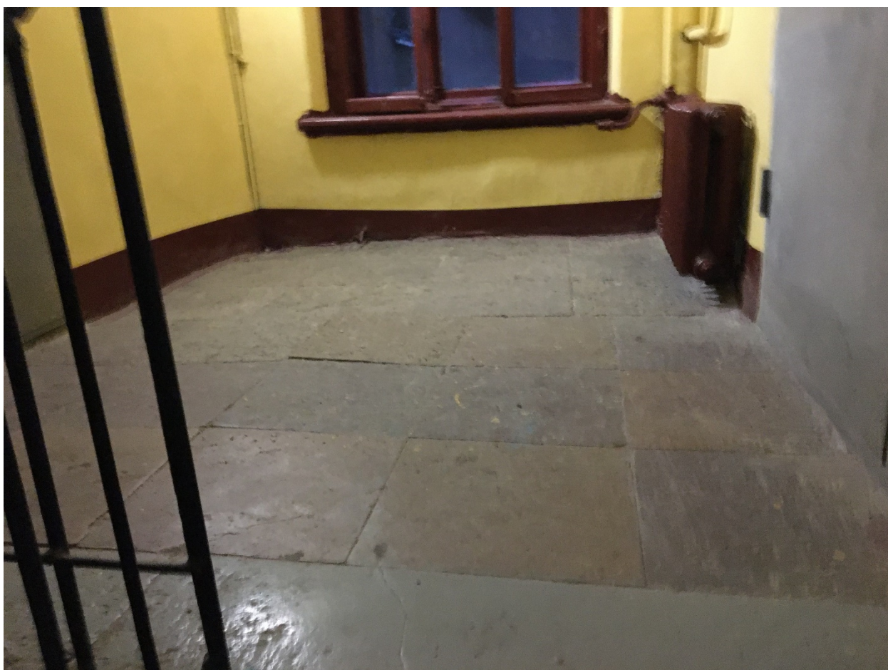
39. Лестница 2ЛК. Площадка 3 этажа.
