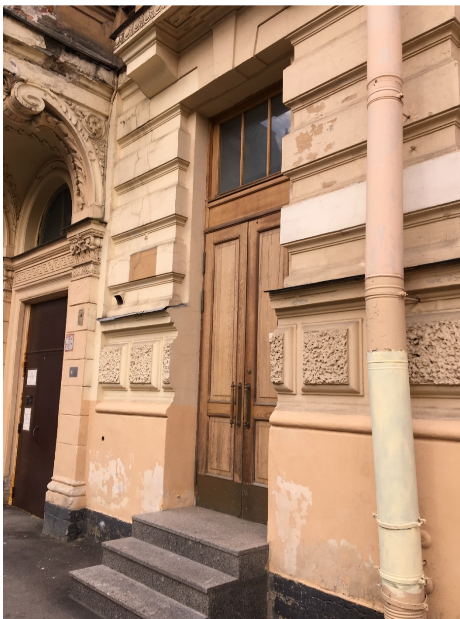
10. Лицевой фасад выявленного объекта культурного наследия «Дом А.И. Резанова», расположенного по адресу: г. Санкт-Петербург, Моховая ул., д. 28. Вход.
