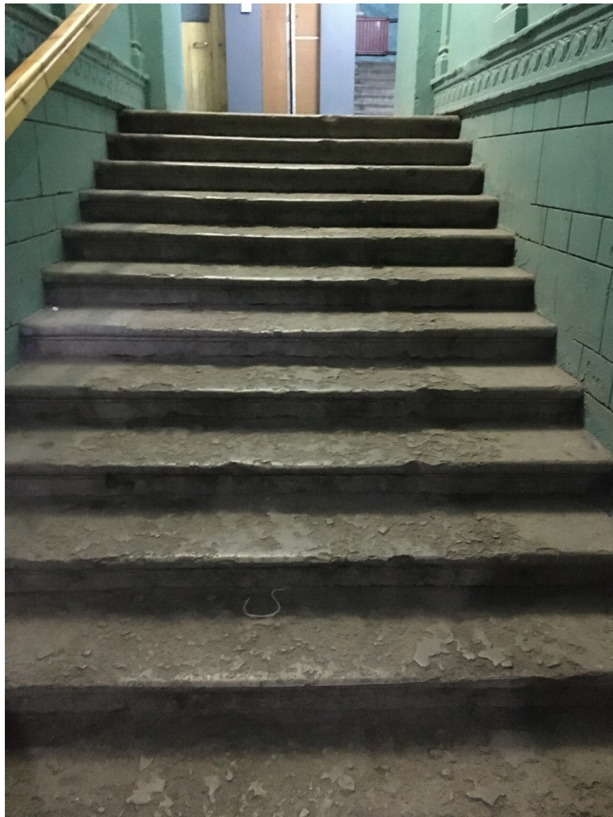
30. Парадная лестница 1ЛК. Парадный вестибюль. Общий вид.
