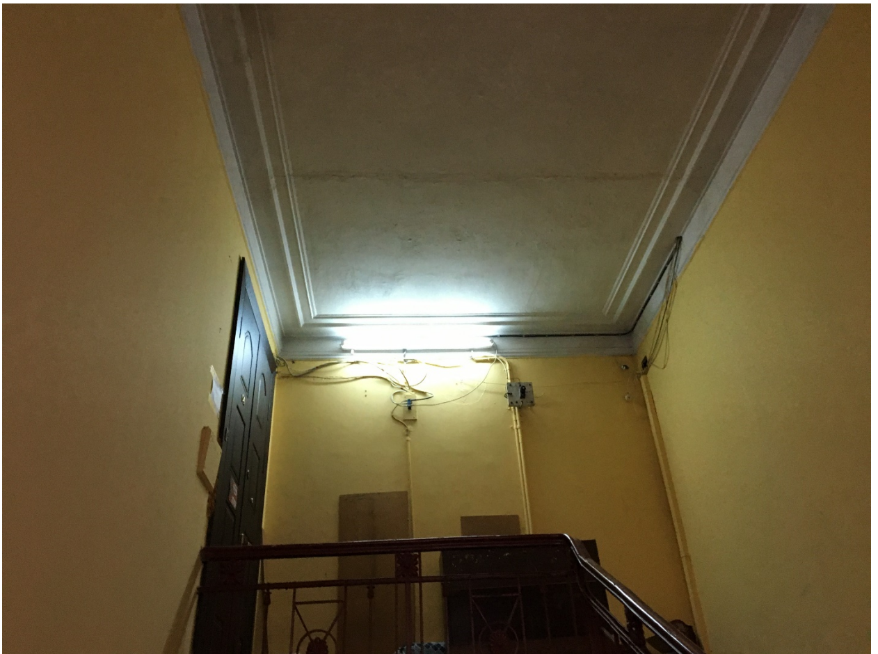
71. Лестница 7ЛК. Перекрытие объема лестницы.
