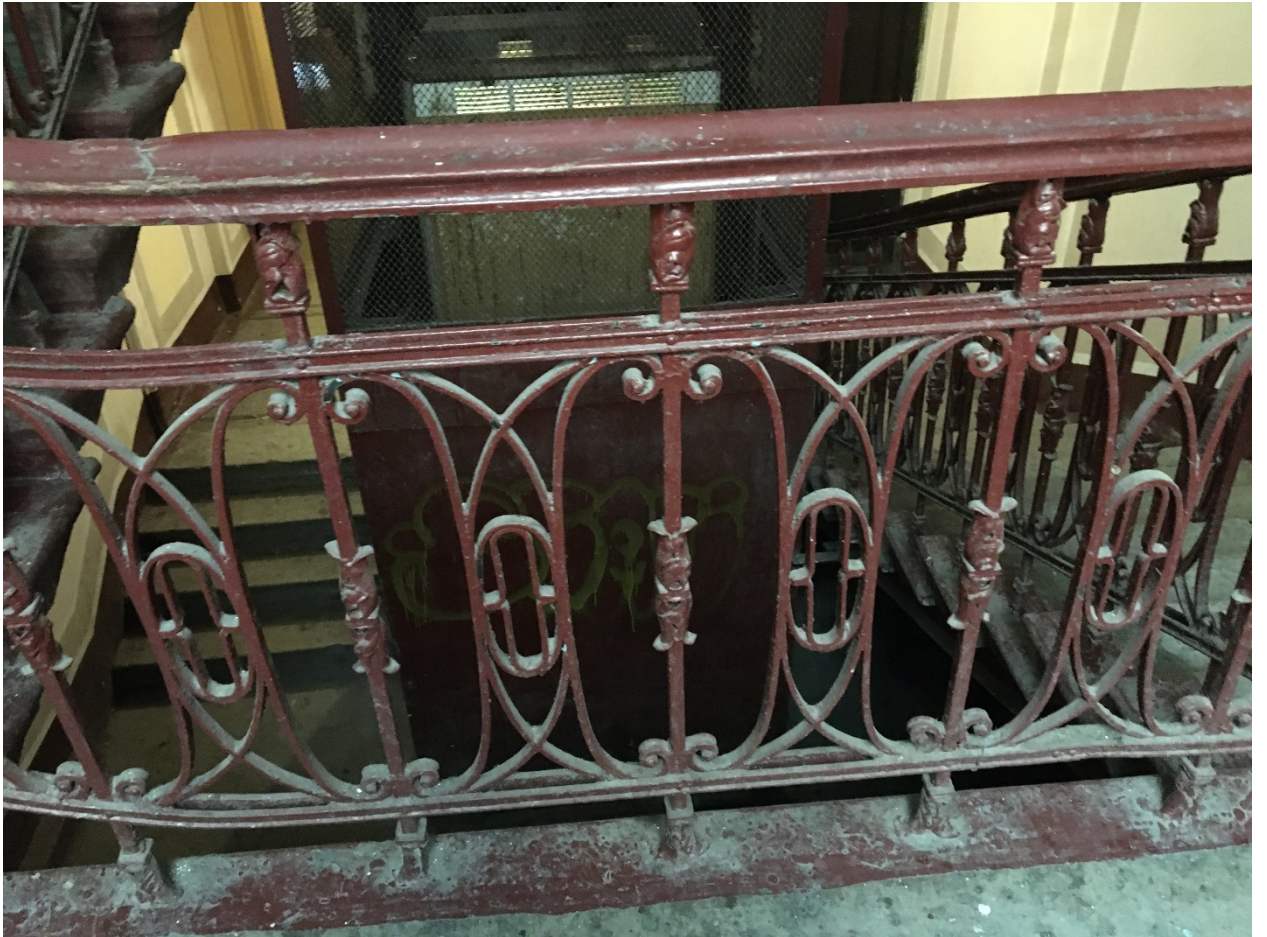
45. Лестница ЗЛК. Ограждения лестницы.
