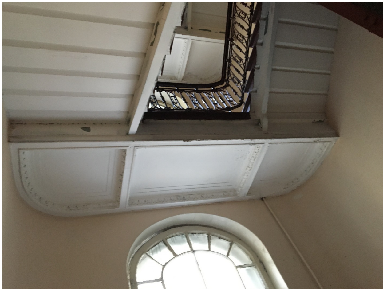
49. Лестница ЗЛК. Оформление основания площадки между 4 и 5 этажами.
