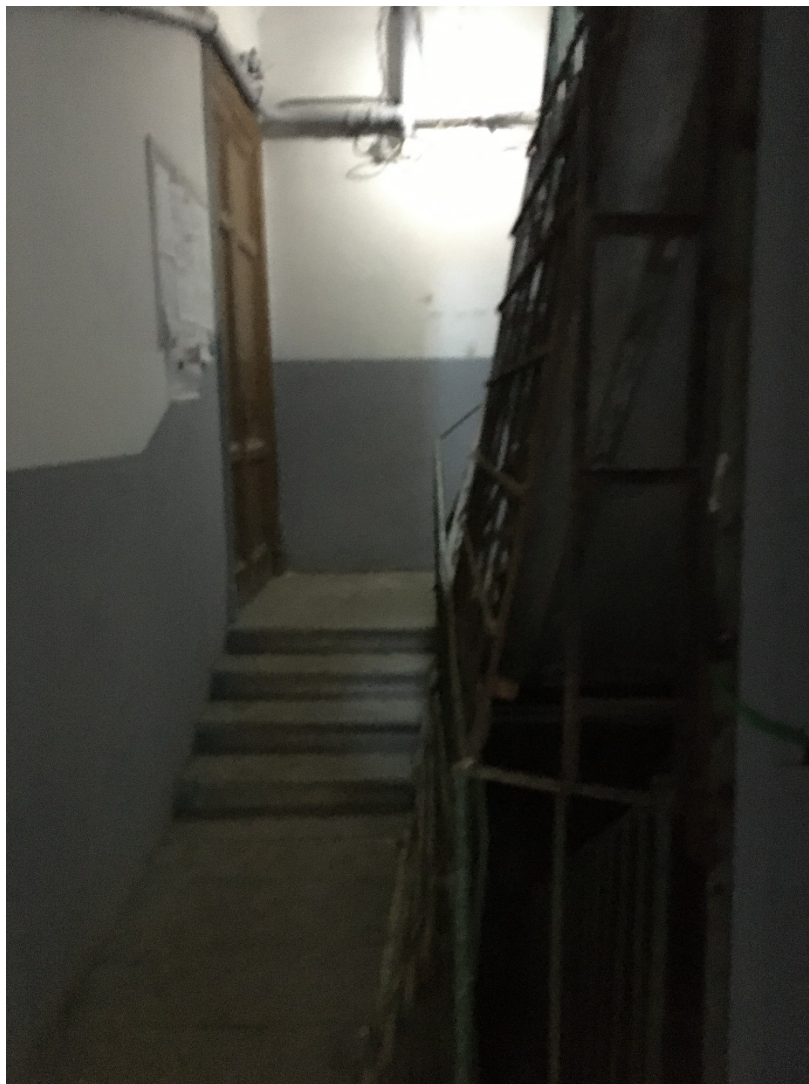
65. Лестница 8 ЛК. Площадка 1 этажа. Общий вид.
