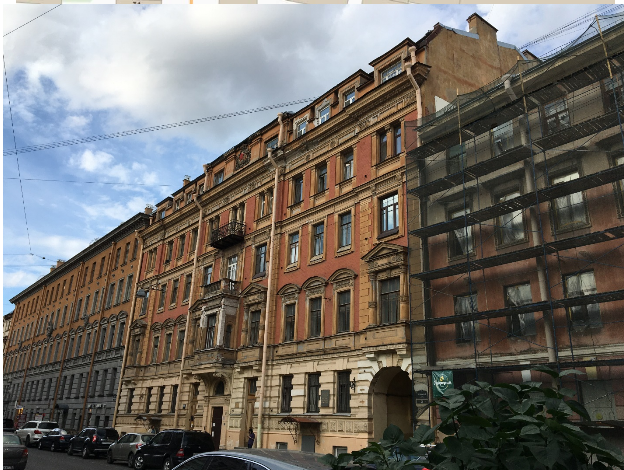
1. Лицевой фасад выявленного объекта культурного наследия «Дом А.И. Резанова», расположенного по адресу: г. Санкт-Петербург, Можовая ул., д. 28.
