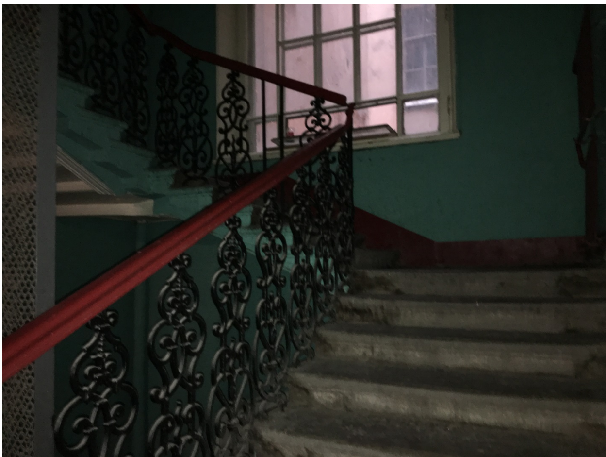
35. Парадная лестница 1ЛК. Ограждения лестницы.
