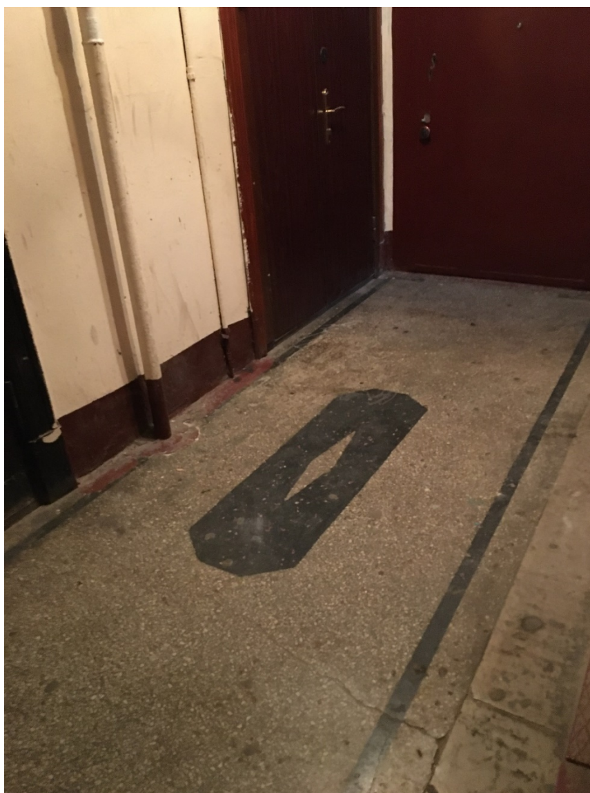
46. Лестница ЗЛК. Площадка 2 этажа.
