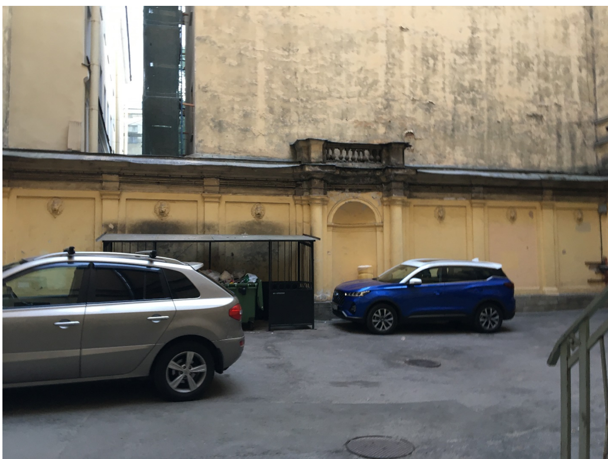
21. Фасады южного двора. Ограда на границе участка с д. 30 по Моховой улице.
