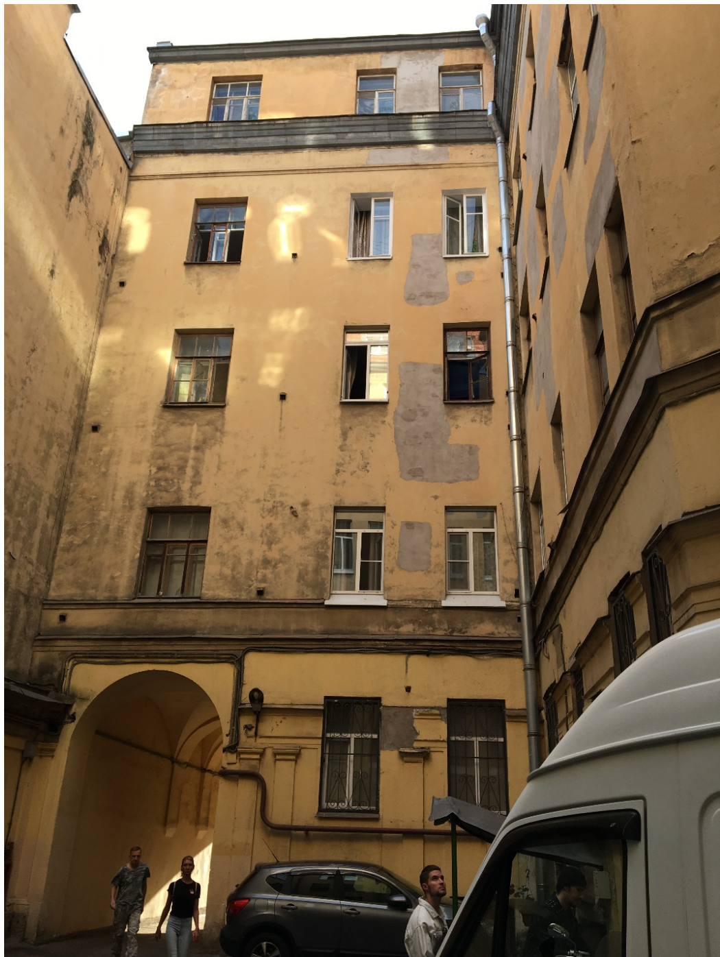
16. Фасады южного двора. Общий вид.
