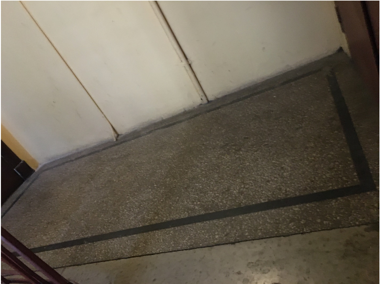
70. Лестница 7ЛК. Площадка 5 этажа.
