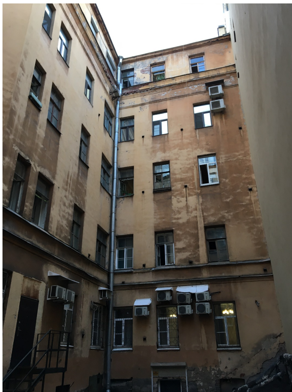
24. Фасады северного двора. Общий вид.
