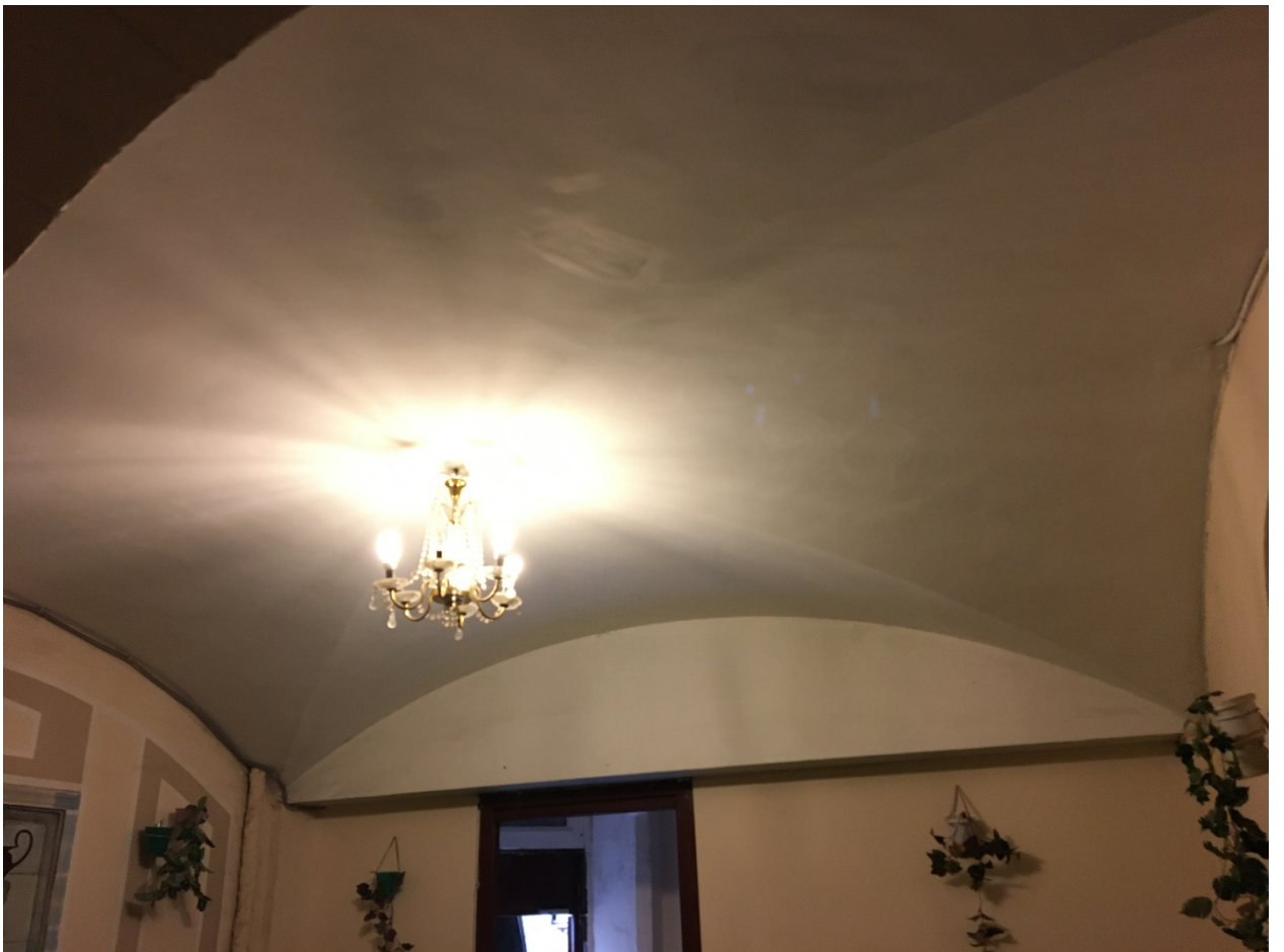
42. Лестница 3ЛК. Парадный вестибюль. Сводчатое перекрытие.
