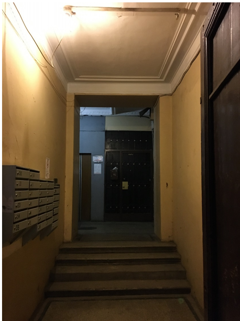
55. Лестница 5ЛК. Вестибюль. Общий вид.
