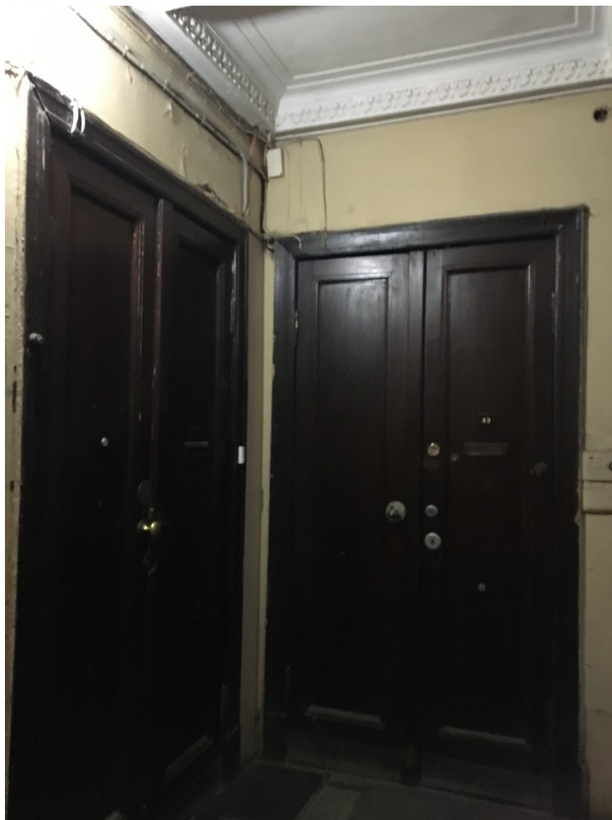
58. Лестница 5ЛК. Площадка 1 этажа. Общий вид.
